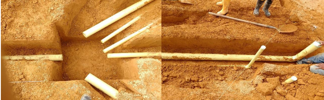
Figura 24. Instalación tubería sanitaria, caja de inspección.
