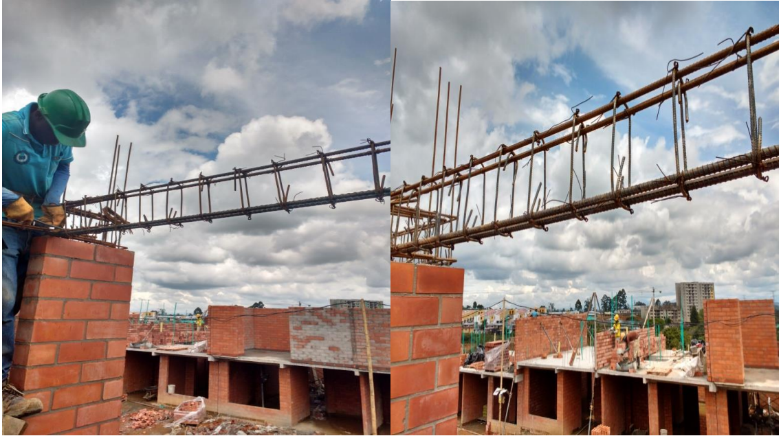
Figura 71. Corrección acero viga de amarre
