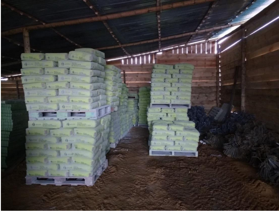
Figura 12. Almacenamiento del cemento
