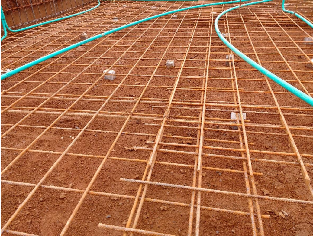
Figura 30. Reubicación aceros de refuerzo losa de cimentación
