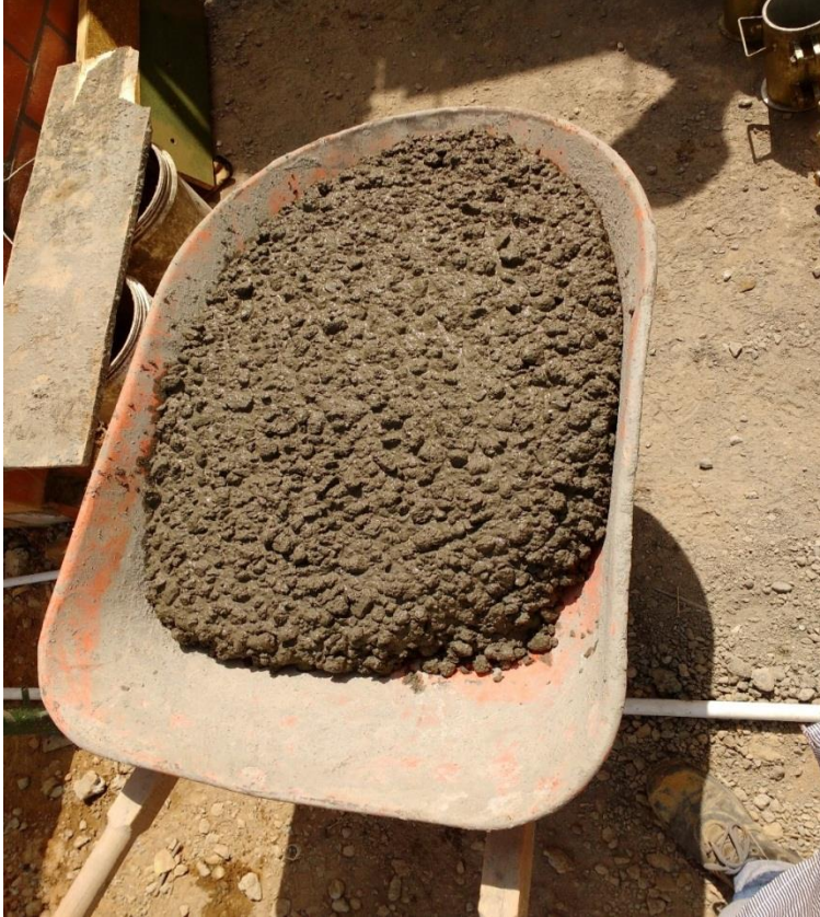
Figura 36. Concreto con agregado grueso de 3/4"
