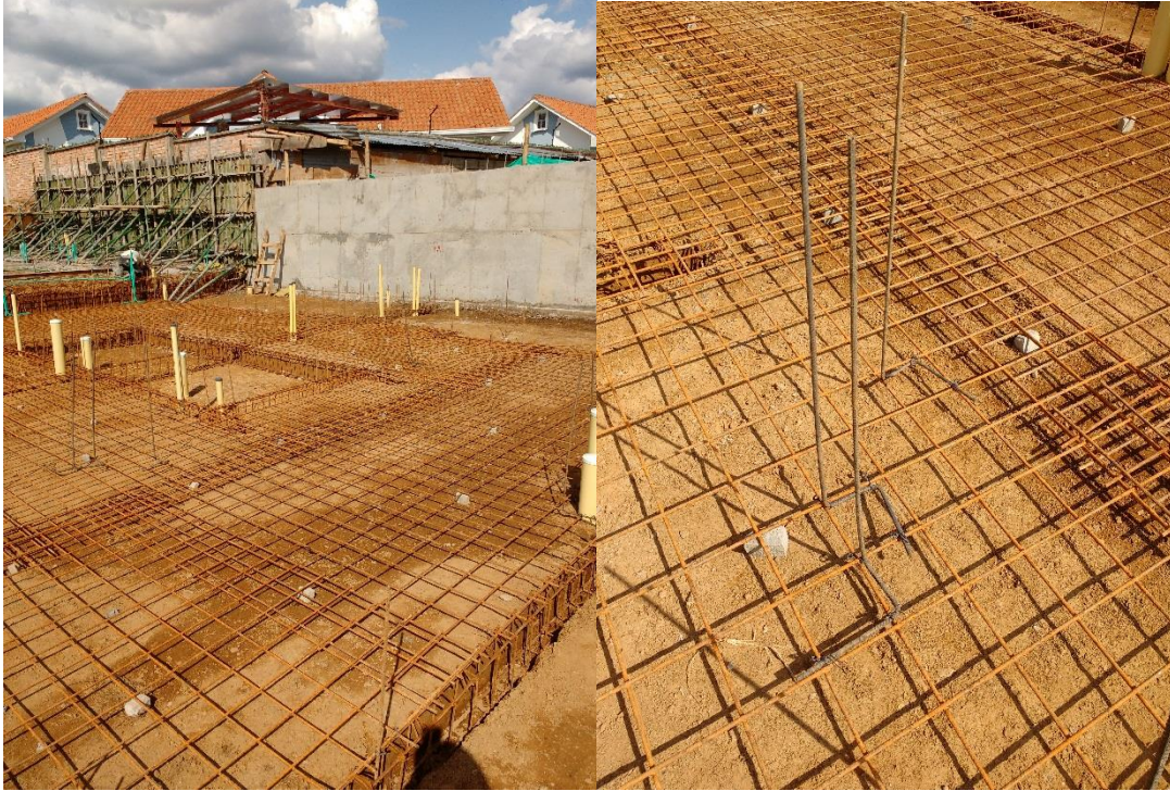
Figura 31. Chequeo de ubicación de acero de dovelas 3/8"
