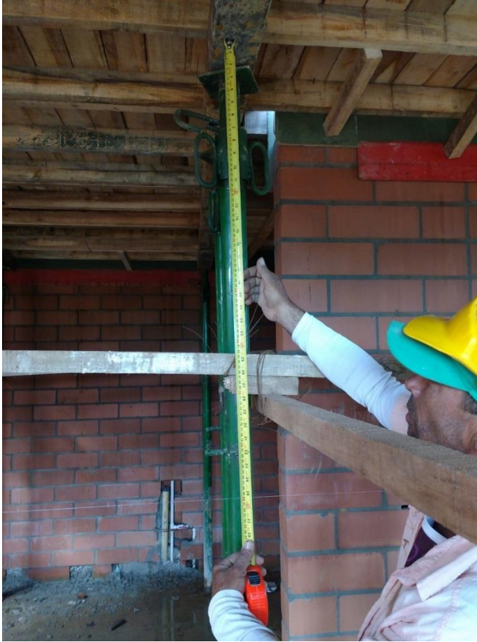
Figura 62. Nivelación en losa de entrepiso para su posterior fundición
