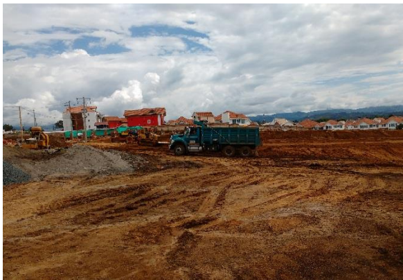
Figura 9. Movimiento de tierra
