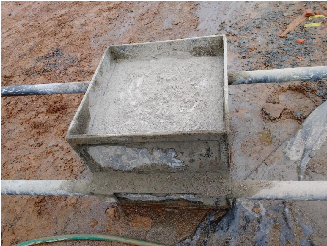
Figura 13. Volumen saco de cemento de 42,5kg en cajón de 0,35 3
