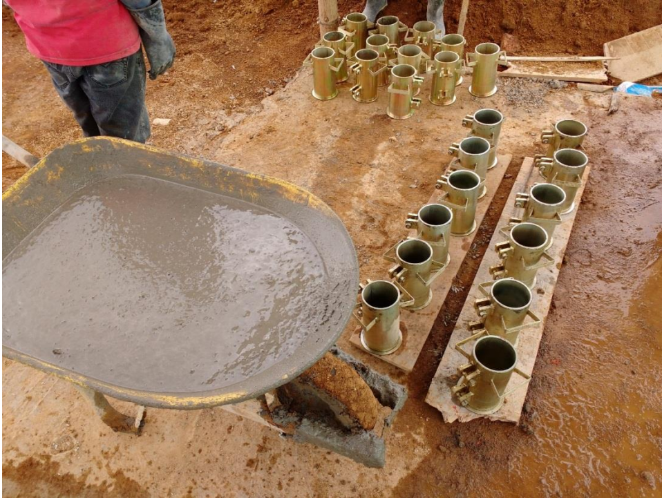
Figura 37. Concreto con agregado grueso 3/8" ( Grouting )
