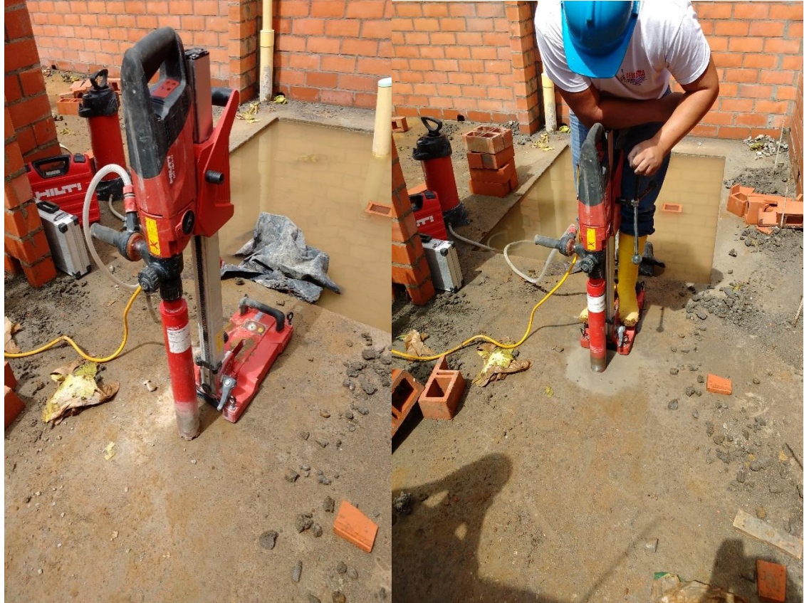
Figura 43. Equipo y extracción de núcleos
