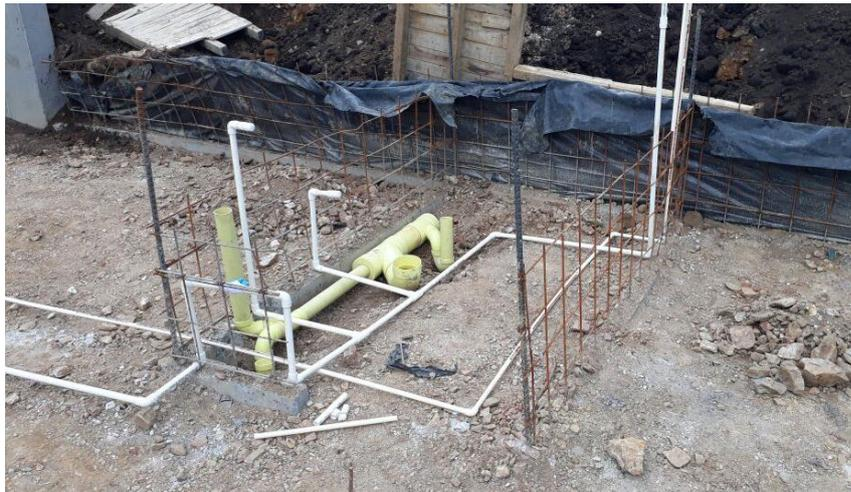
Figura 15: Instalación red hidráulica y sanitaria para baño de Torre I. Fuente: Elaboración propia
