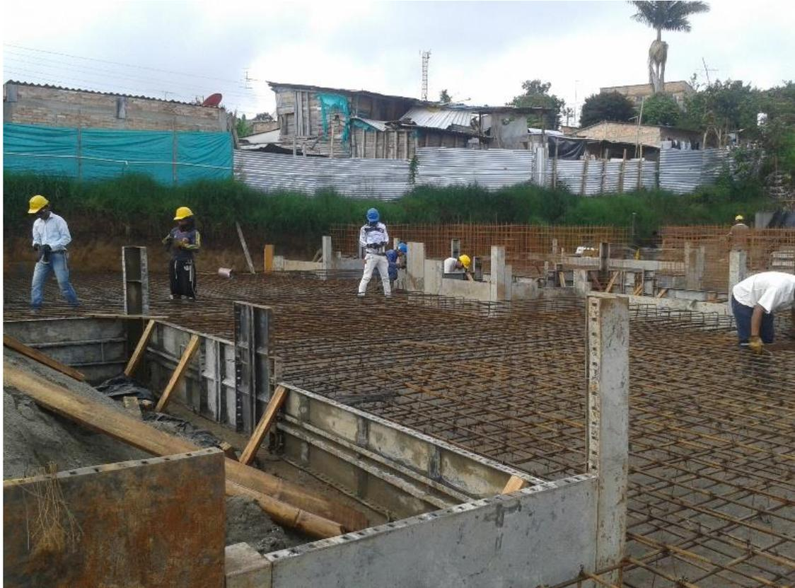
Figura 13: Refuerzo de losa de cimentación Torre 2. Fuente: Elaboración propia
