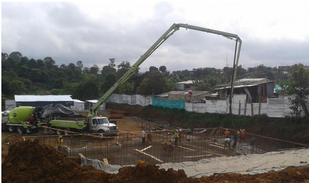
*Figura 20: Colocación de concreto con máquina autobomba: Elaboración propia.*
