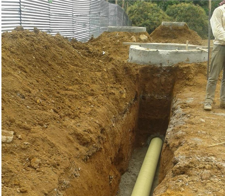
Figura 24: Cámara de inspección sanitaria y tubería de conexión 10". Fuente *Elaboración propia*.
