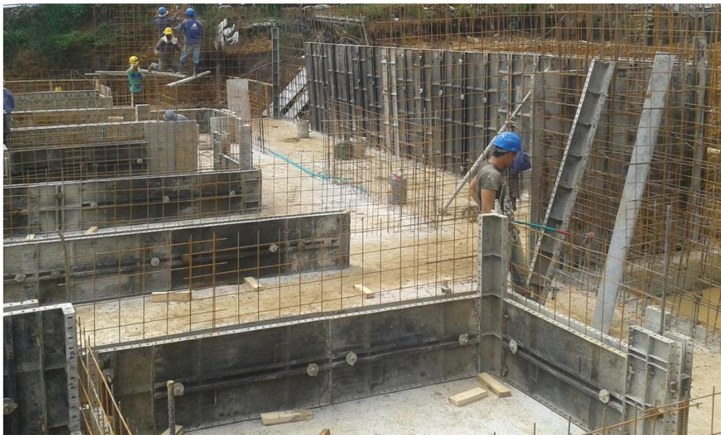
*Figura 18: Colocación formaleta metálica. Fuente: Elaboración propia*
