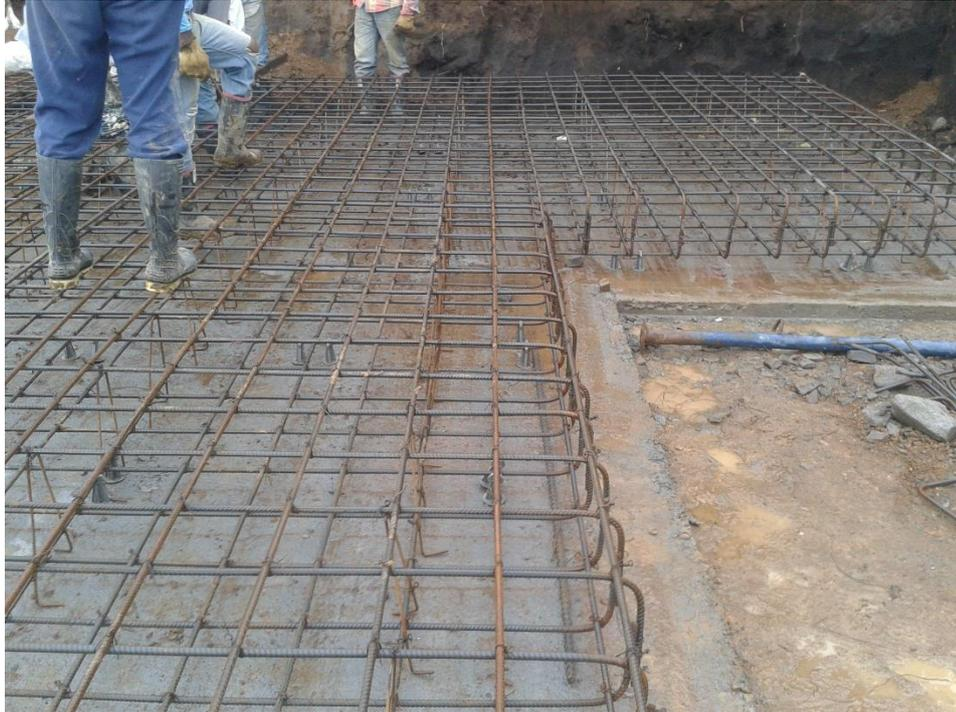
*Figura 12: Parrillas superior e inferior de losa de cimentación. Fuente: Elaboración propia*
