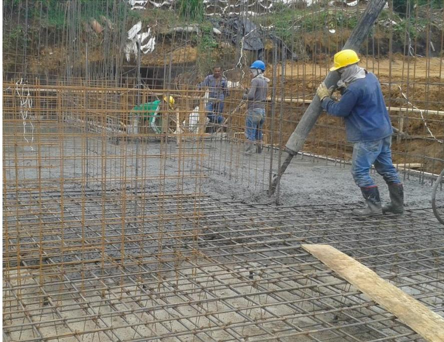
*Figura 22: Vaciado del concreto con el “moco” o “trompa de elefante”. Fuente: Elaboración propia.*
