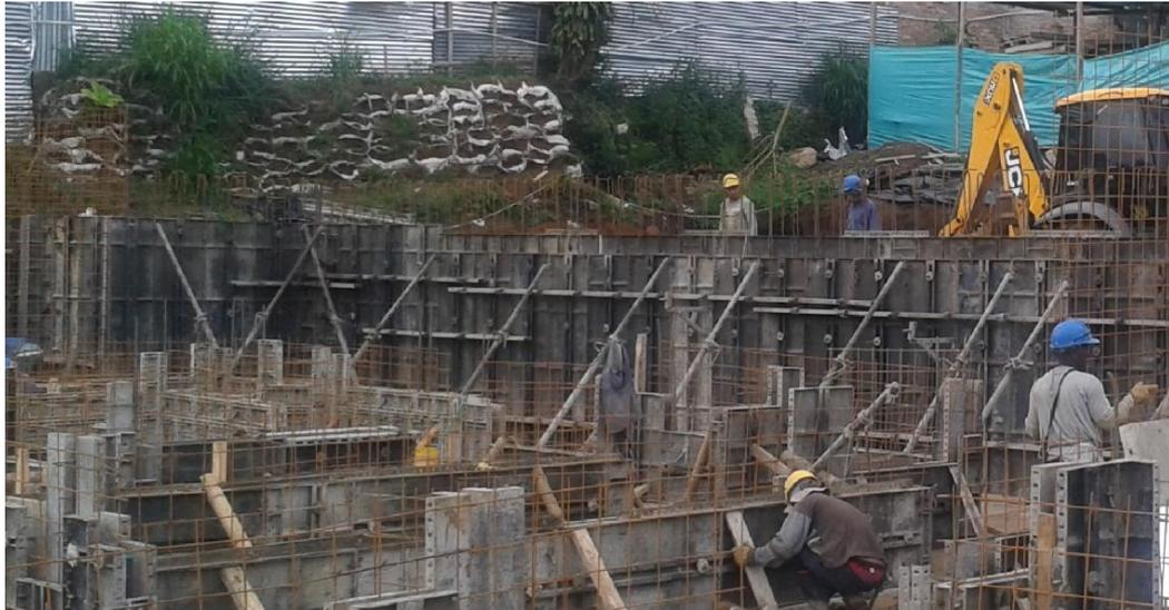
*Figura 19: Formaleta con colocación de tensores. Fuente Propia*
