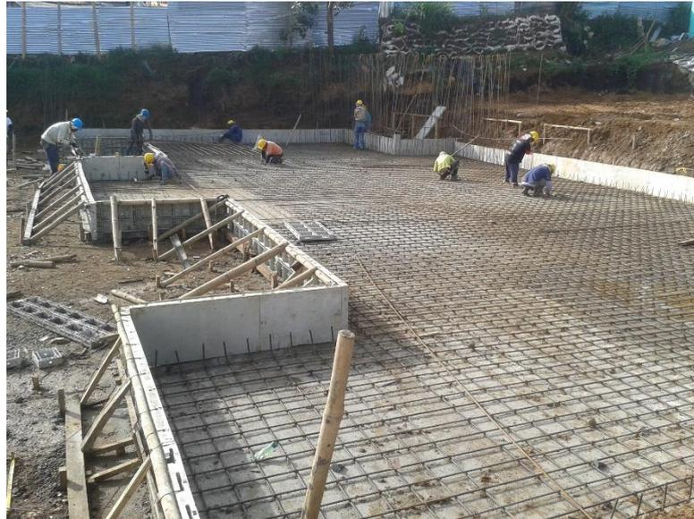
*Figura 11. Parrilla de refuerzo inferior, losa de cimentación Torre 1. Fuente Elaboración propia*
