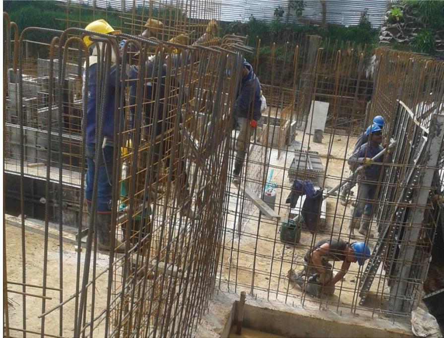
Figura 14: Refuerzo muro de contención Torre 1. Fuente: Elaboración propia
