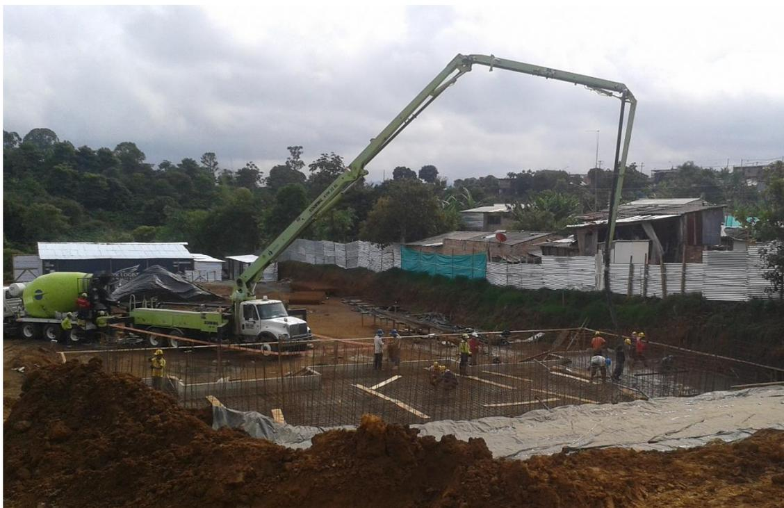
Figura 4: Cimentación de la torre 1 (Losa flotante). Fuente Elaboración Propia
