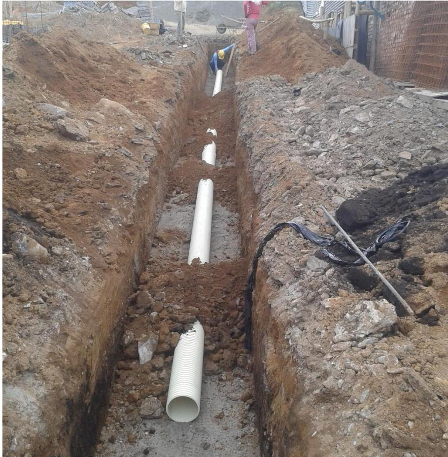
Figura 25: Excavación tramo de alcantarillado pluvial y tubería de conexión 10”.
