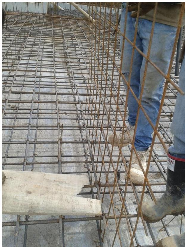
*Figura 14: Intersección del refuerzo de muro estructural con losa de cimentación. Fuente: Elaboración propia*
