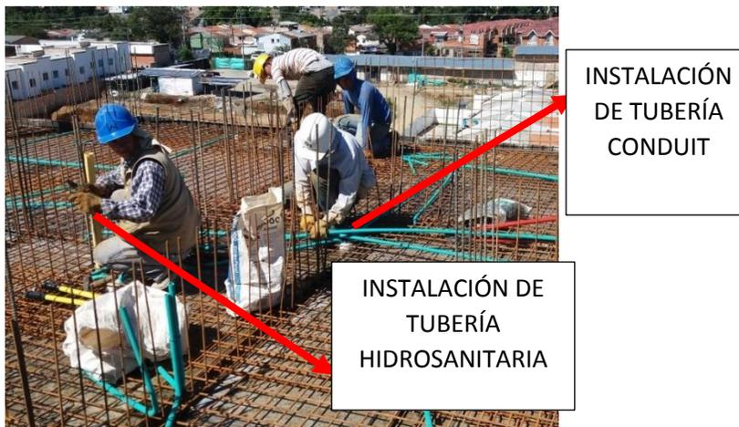
*Figura N° 6a: Instalación de tubería Conduit e Hidrosanitaria para su posterior conexión en losa*
