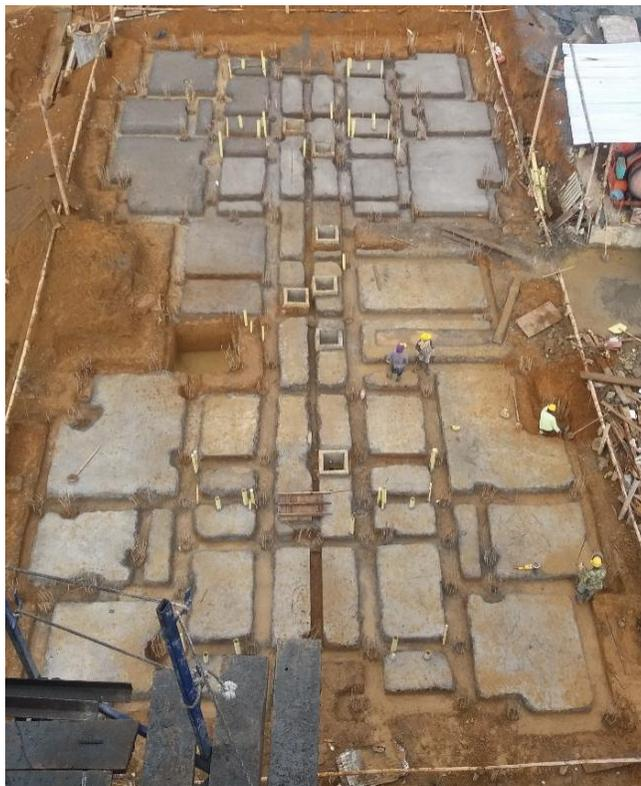
*Figura N° 13d: Aplicación de solado de limpieza*
