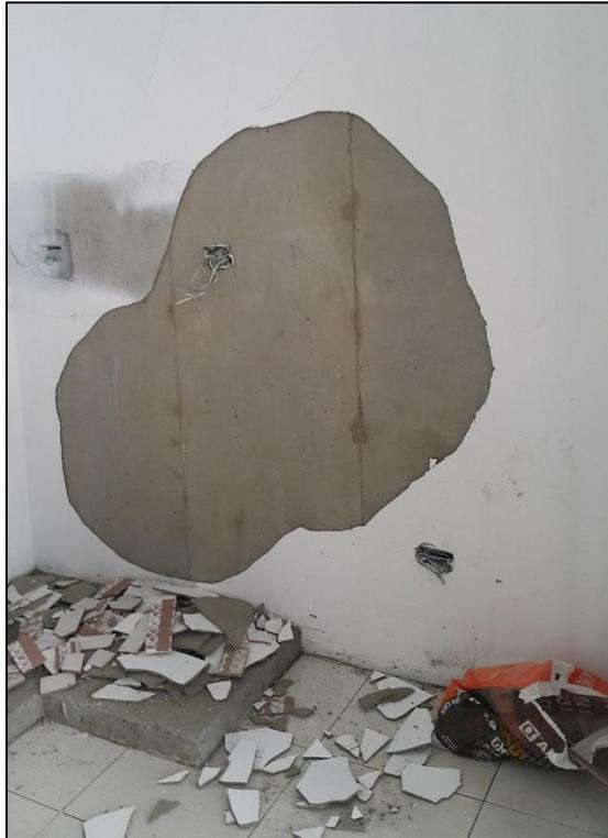
*Figura N° 11a: Repello en muro que debe cambiarse*
