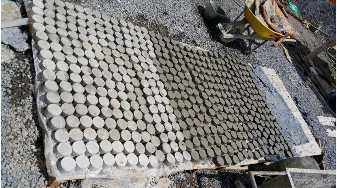
*Figura N° 13g: Creación separadores para acero (Panelitas)*
