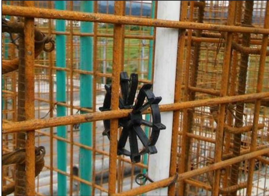
*Figura N° 5c: Separador para garantizar recubrimiento del acero en el muro*
