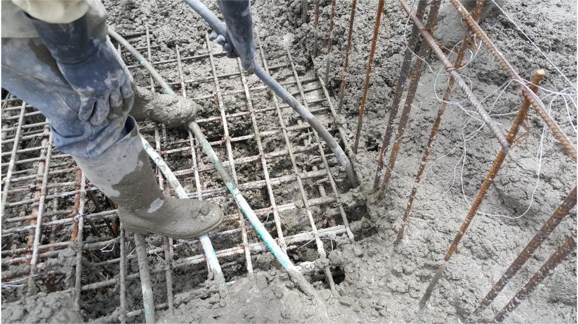
*Figura N° 13i: Fundición de cimentación*
