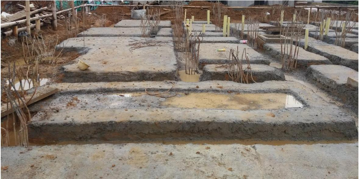
*Figura N° 13e: Aplicación de solado de limpieza*
