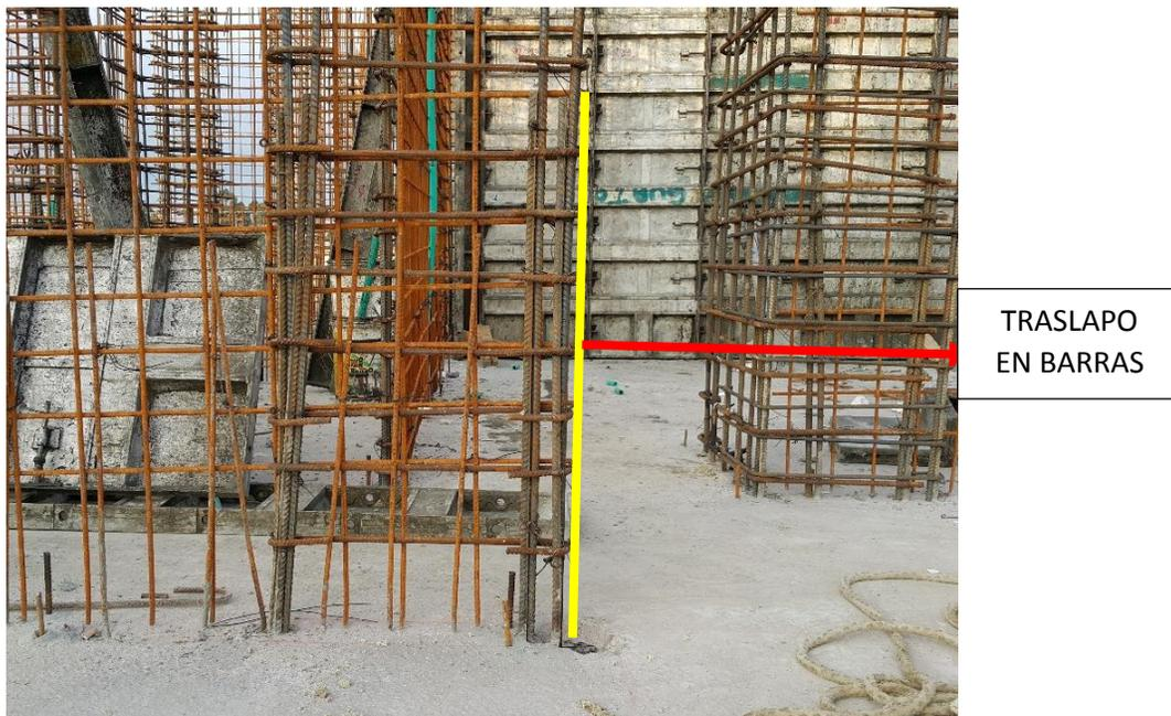
Figura N° 4b: Traslazos de barras en muros
