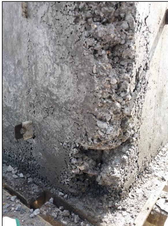
*Figura N° 10a: Hormiguero - Corbatas aún en el muro*
