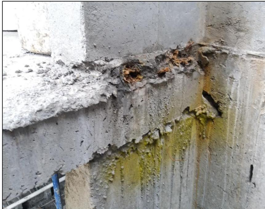
*Figura N° 10c: Detección de una junta para realizar el resane*
