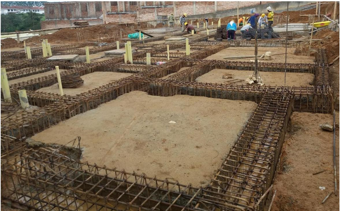
*Figura N° 13f: Amarre de acero de vigas*
