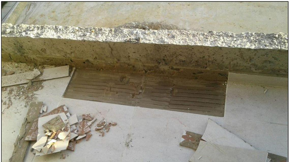
*Figura N° 11b: Cambio de ficha en enchape de piso*
