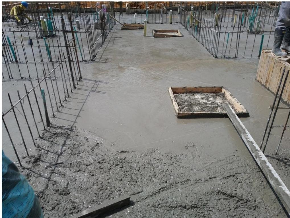
*Figura N° 13j: Fundición de cimentación (Nivelación)*
