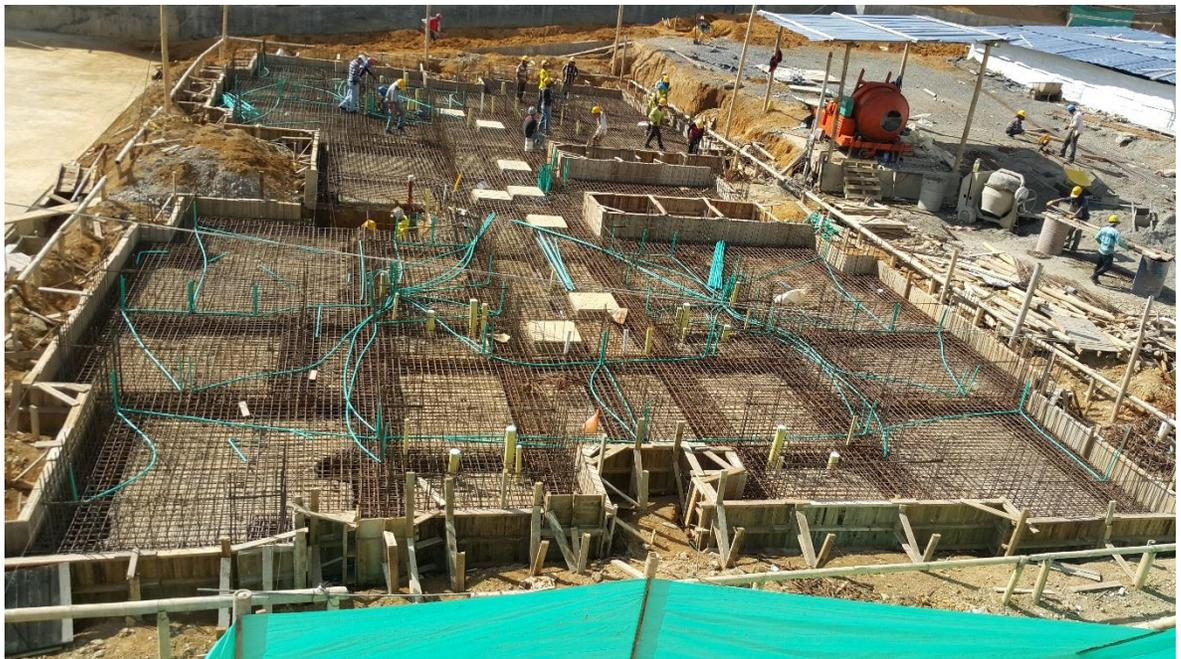
*Figura N° 13h: Formaleta para la losa (Tableros de madera)*
