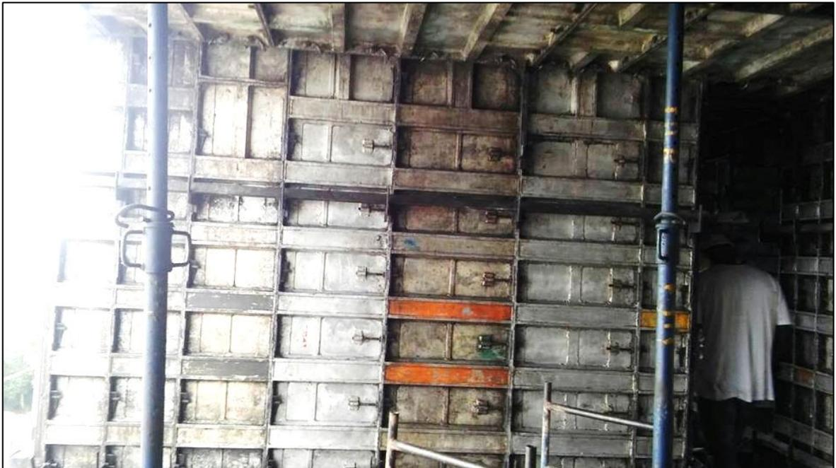
*Figura N° 8c: Losa puntal*
