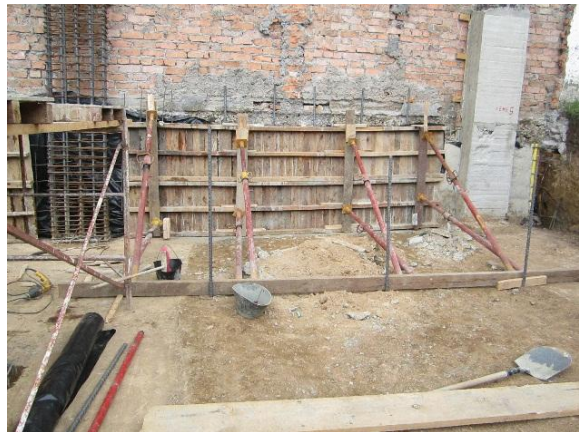
Foto 10: Formaleta y refuerzo de muro de contención
