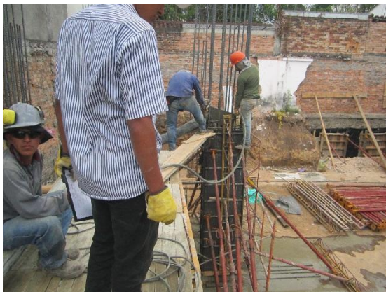
Foto 44: Fundición de columna.
