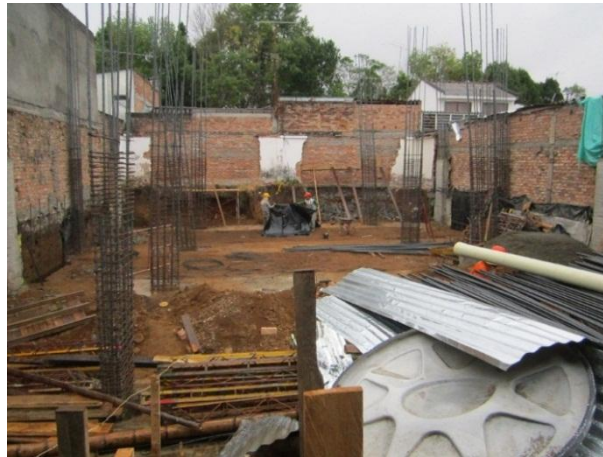
Foto 1: Estado de la obra al momento de iniciar la pasantía
