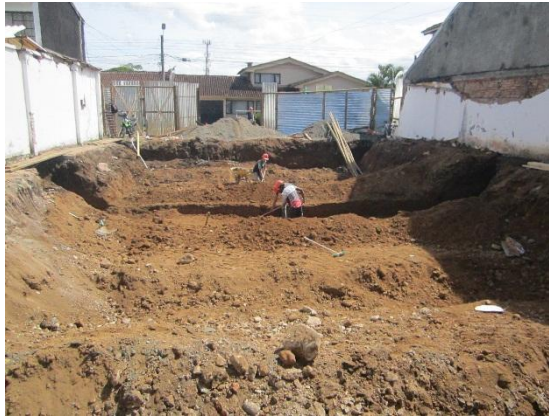
Foto 2: Excavación manual.
