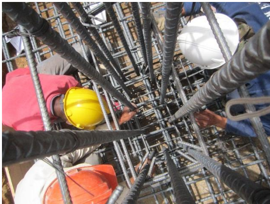
Foto 26: Inicio refuerzo para columnas.
