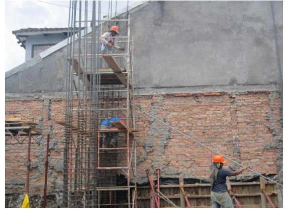
Foto 37: Traslapo acero para columna
