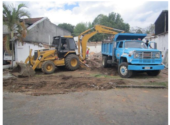
Foto 21: Retiro de escombros.
