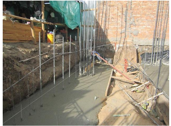
Foto 31: Acero para muro de contención
