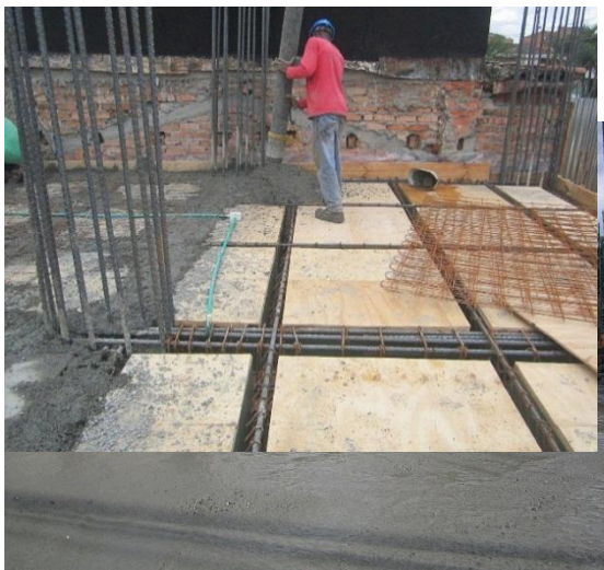
Foto 52: Inicio de fundición.
