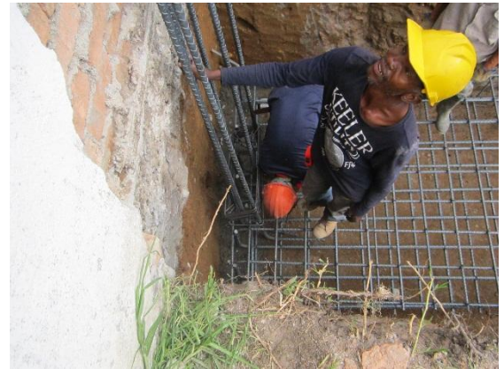
Foto 27: Refuerzo para columnas.
