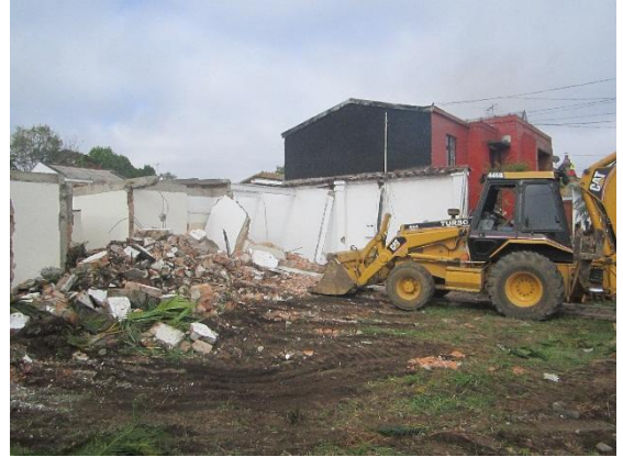
Foto 19: Demolición mecánica.
