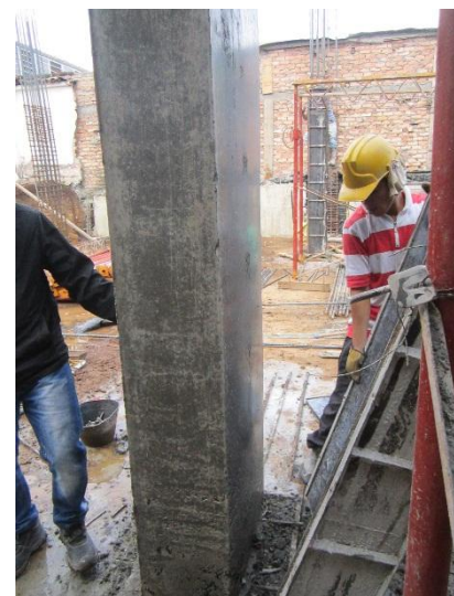
Foto 41: Desencofrado de columna.
