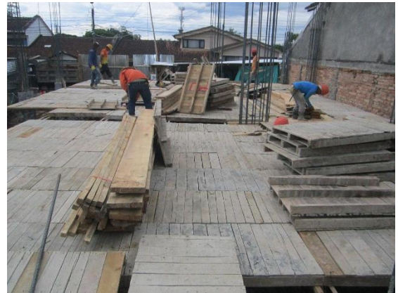
Foto 43: Armado de tarima para la losa.
