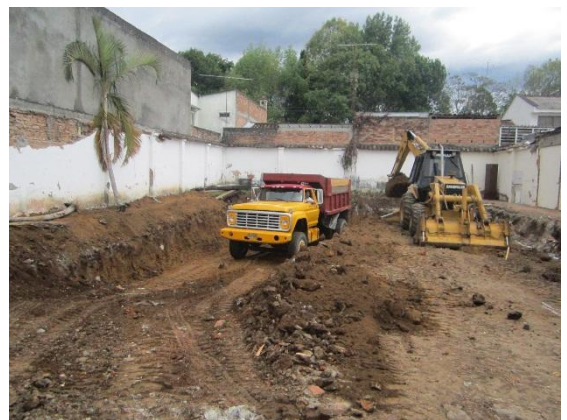
Foto 23: Retiro de material excavado.
