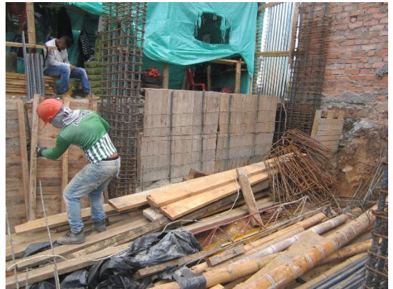
Foto 33: Formaleta para muro de contención
