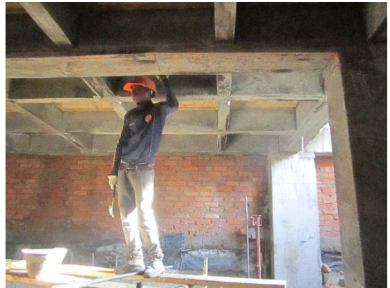
Foto 51: Desencofrado de losa.
