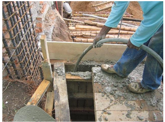
Foto 35: Vibrado muro de contención
