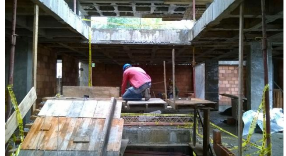
Foto 55: Formaleta escalera nivel 1
