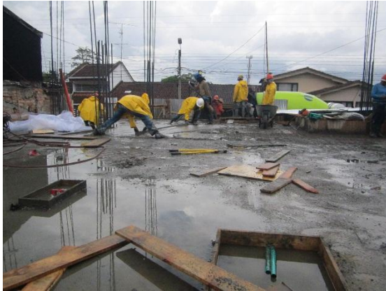
Foto 50: Tallado de la losa.
