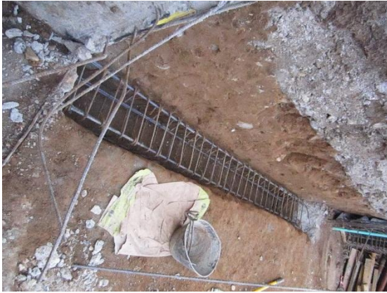
Foto 36: Acero viga de cimentación
