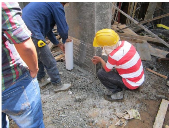
Foto 46: Vinipel para el curado del concreto.
