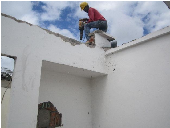
Foto 20: Demolición manual.
