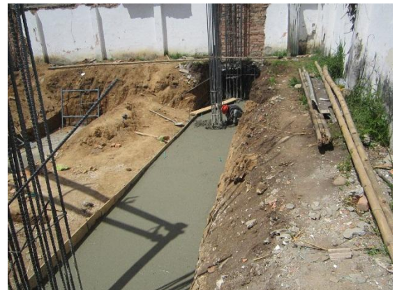
Foto 29: Zapata fundida.
