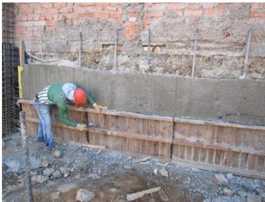
Foto 38: Desencofrado muro de contención.
