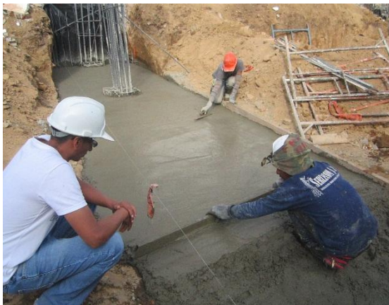
Foto 34: Tallado de la zapata.
