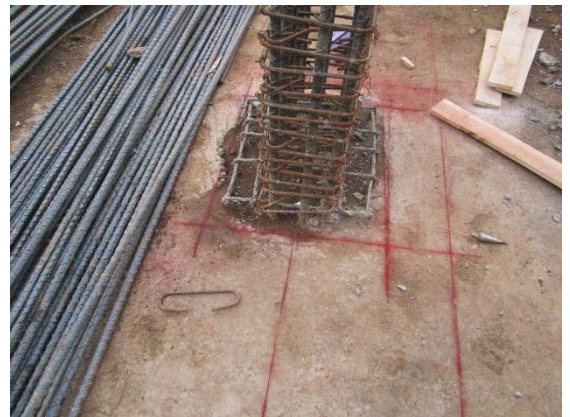
Foto 39: Cimbra para columna.
