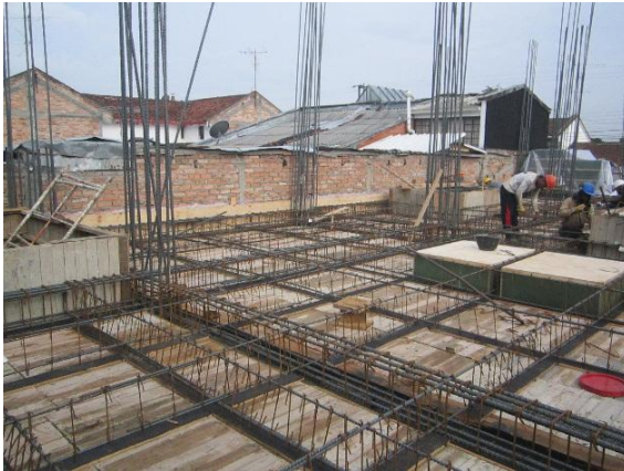
Foto 13: Amarre de vigas y nervios
