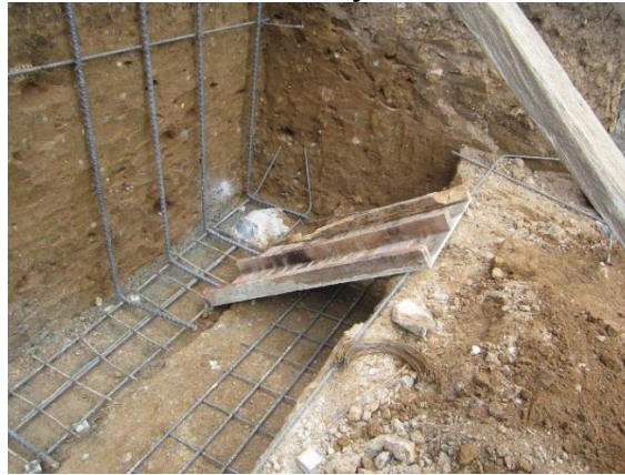
Foto 3: Anclaje a roca
