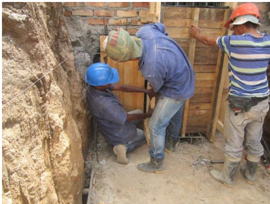
Foto 32: Colocación formaleta de madera.
