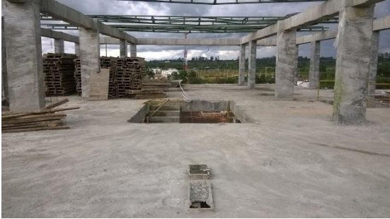
Foto 54: Piso nivel 3 y cubierta
