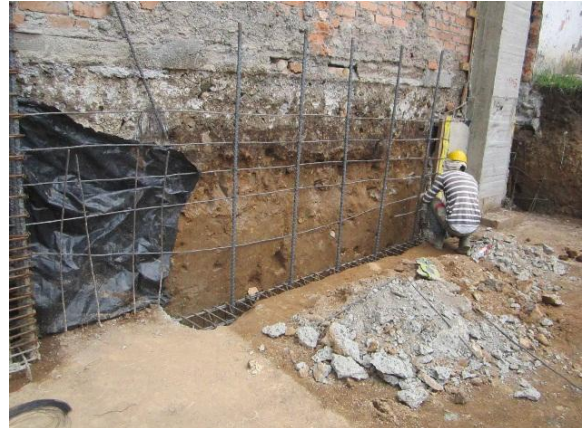
Foto 6: Acero para viga de cimentación y muro de contención.
