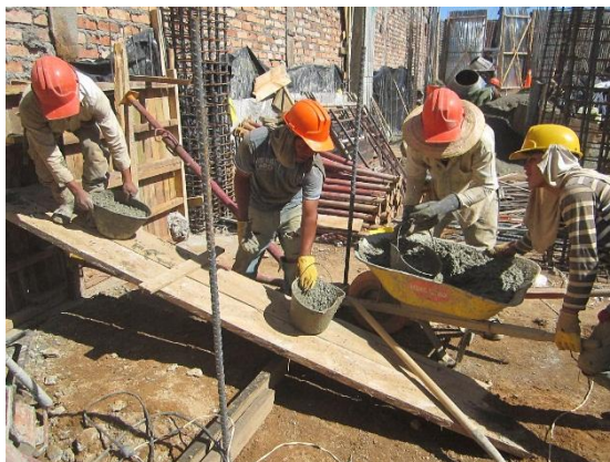
Foto 40: Fundición muro de contención.
