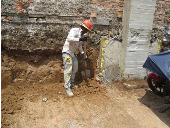
Foto 5: Excavación viga de cimentación
