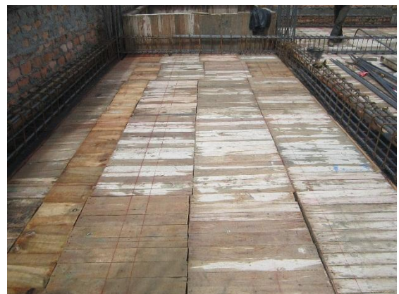
Foto 47: Cimbrado de vigas y nervios.
