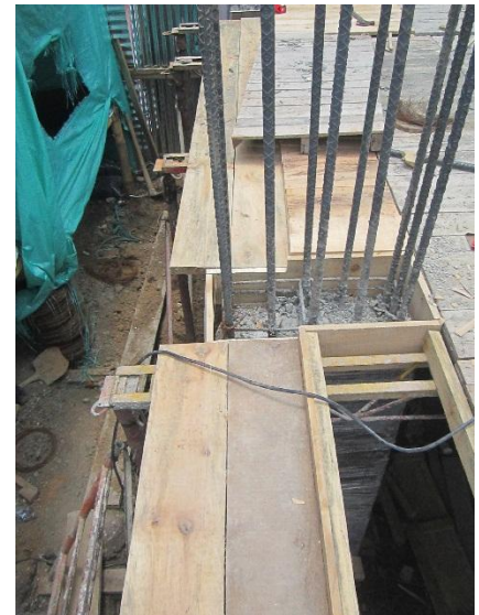
Foto 45: Completar vacíos de la tarima.
