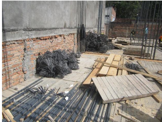
Foto 15: Disposición del acero de refuerzo de la losa
