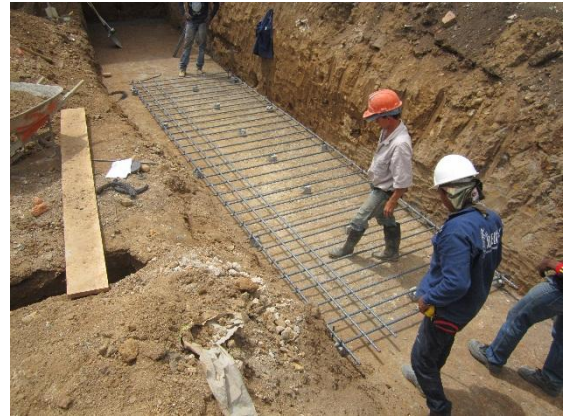
Foto 25: Armado del acero para zapata.
