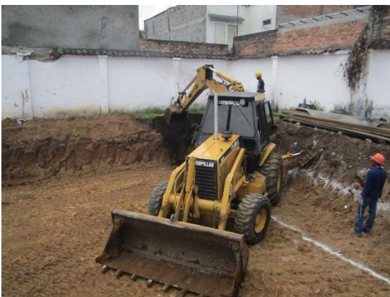
Foto 22: Excavación mecánica.
