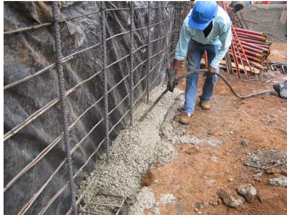
Foto 7: Fundición vibrado de viga de cimentación.
