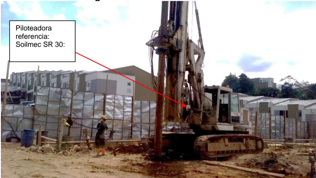
Piloteadora referencia: Soilmec SR 30:
