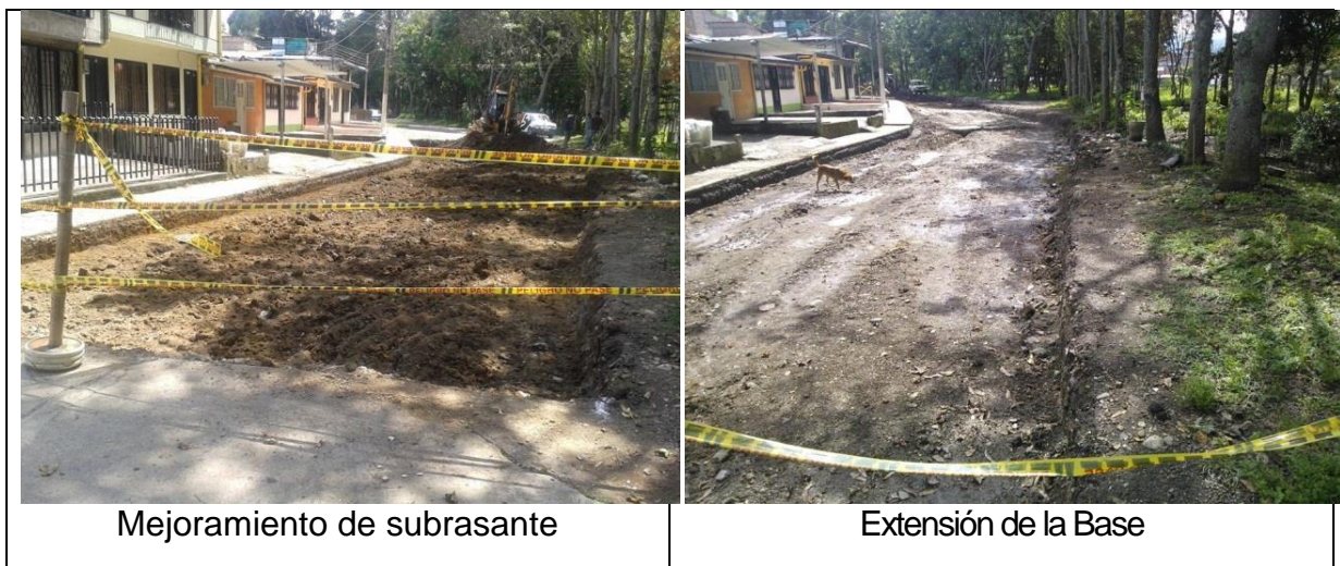
Figura 6.7 Registro fotográfico de la obra
