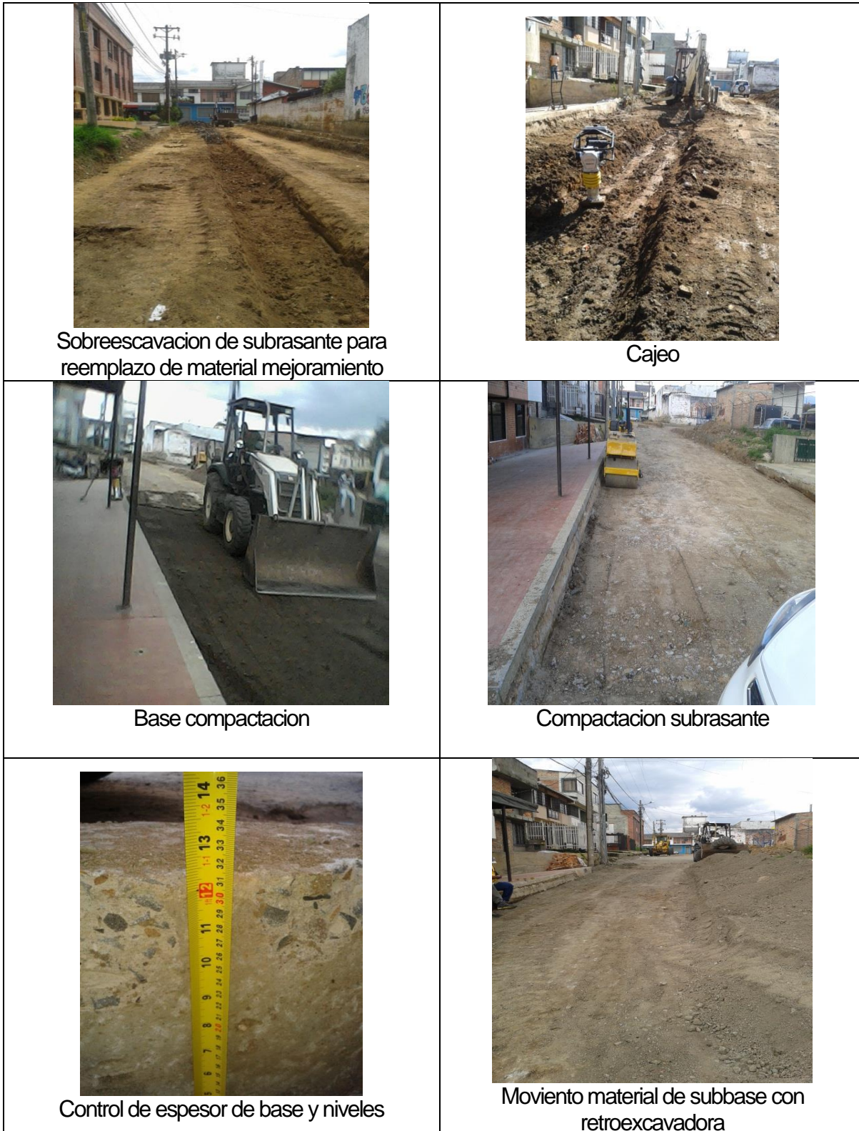
Figura 6.13 Registro fotográfico de la obra
