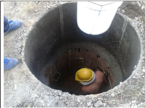
Excavación para pila
