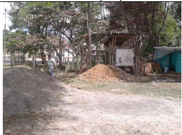
Excavación para pila
