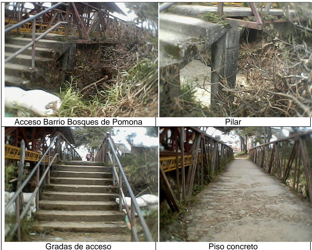
Figura 6.5 Registro fotográfico puente alterno la estancia.
