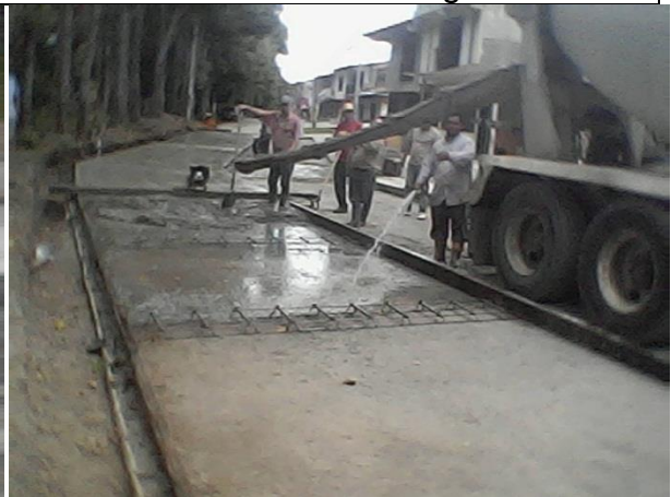
Descarga del concreto desde una mixer
