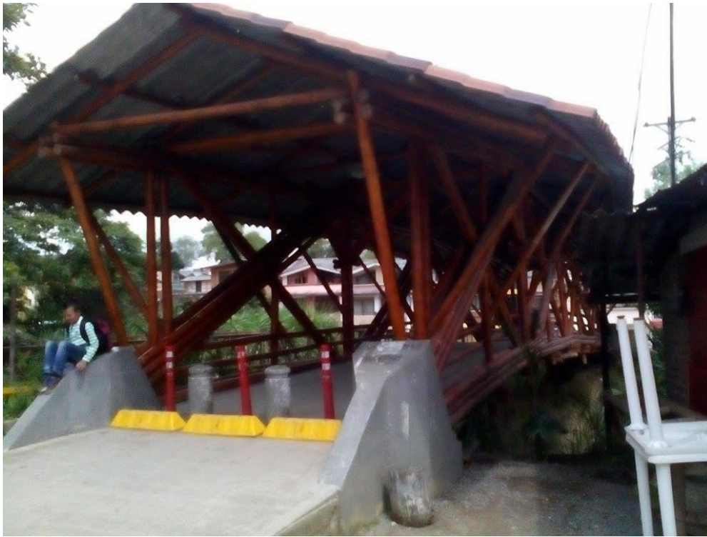
Figura 6.3 Puente peatonal de guadua del Barrio La Estancia.
