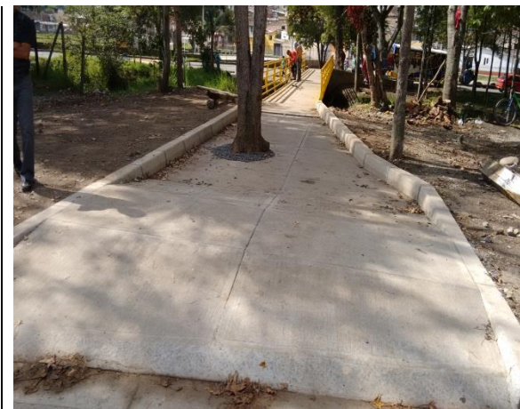
Estado fina de la obra
