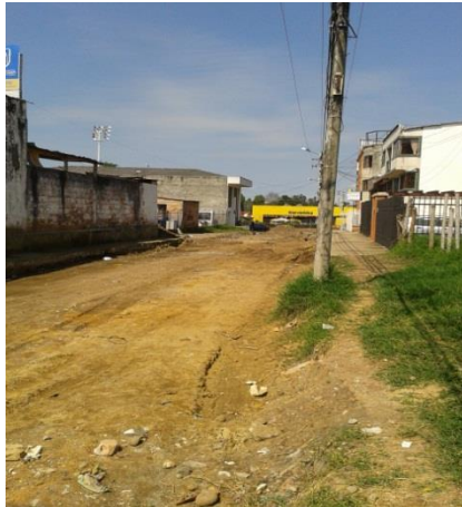
Cajeo de vía
