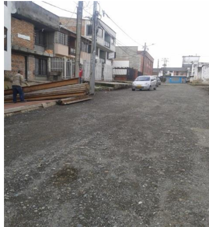
Subbase antes del nuevo diseño y alistamienjto de formaletas sardineles
