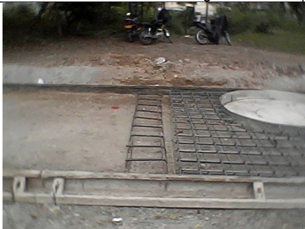
Instalacion de canasta con varillas de transferencia de carga
