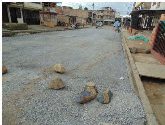
Figura 6.18 Vía lista para imprimación
