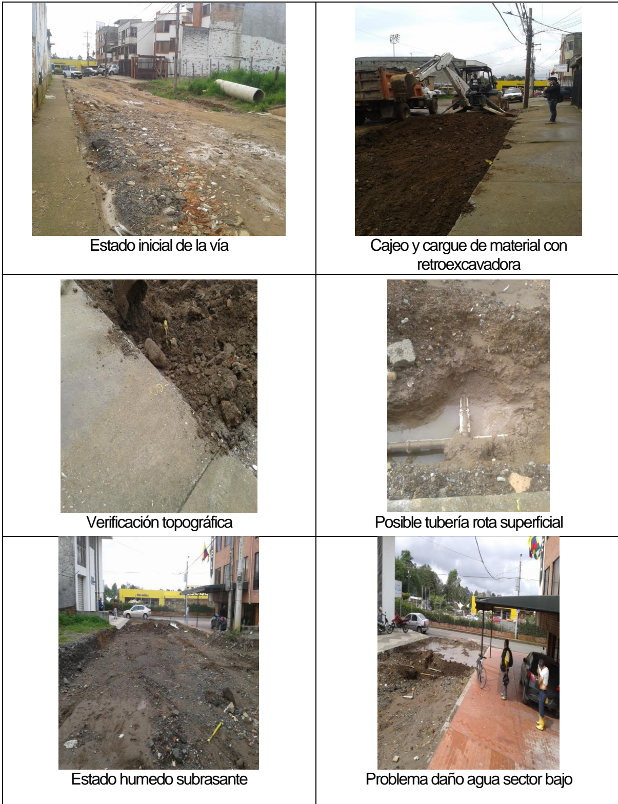
Figura 6.11 Registro fotográfico de la obra
