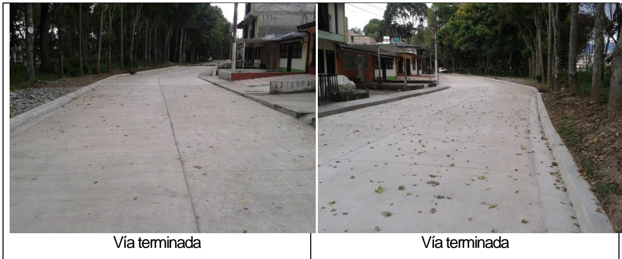
Figura 6.10 Registro fotográfico de la obra
