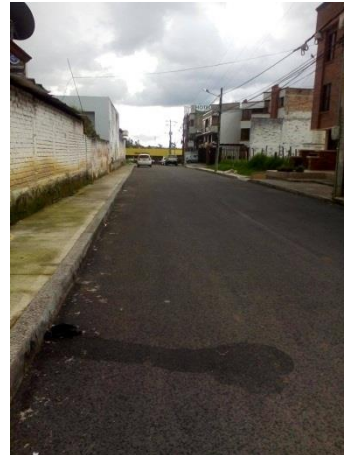
Estado final de la obra.
