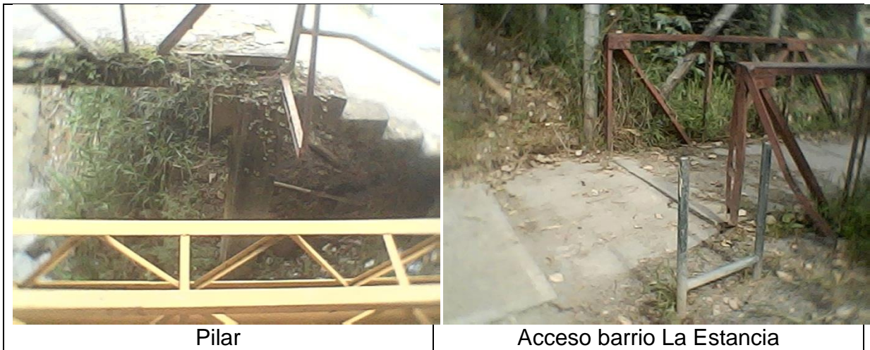
Figura 6.6 Registro fotográfico puente alterno la estancia.
