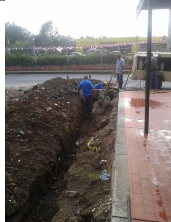
Excavación cambio de tubería hidráulica personal de acueducto
