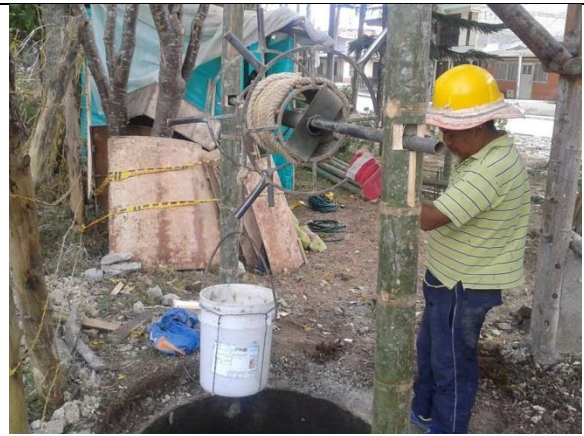
Excavación para pila
