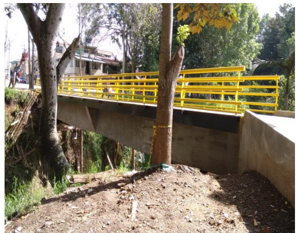
Estado fina de la obra
