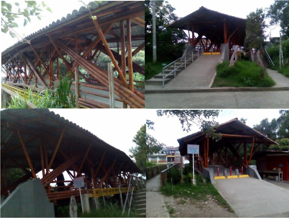
Figura 6.4 Vista del puente peatonal del Barrio La Estancia.
