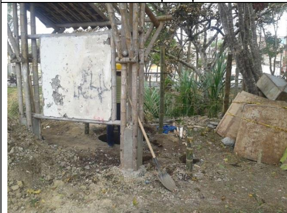
Excavación para pila
