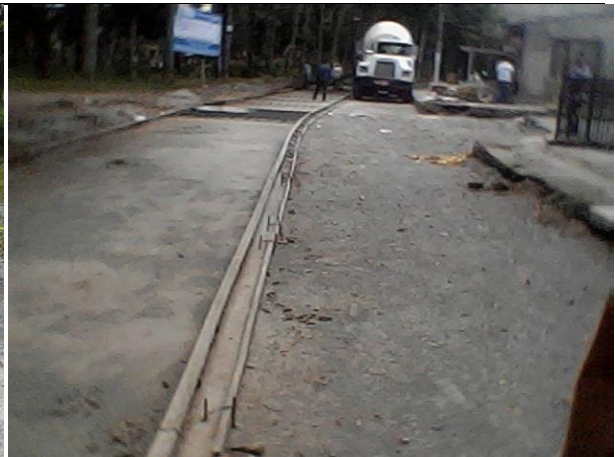
Proceso de Pavimentacion
