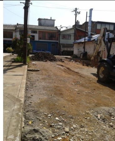
Cajeo y acumulación material de mejoramiento
