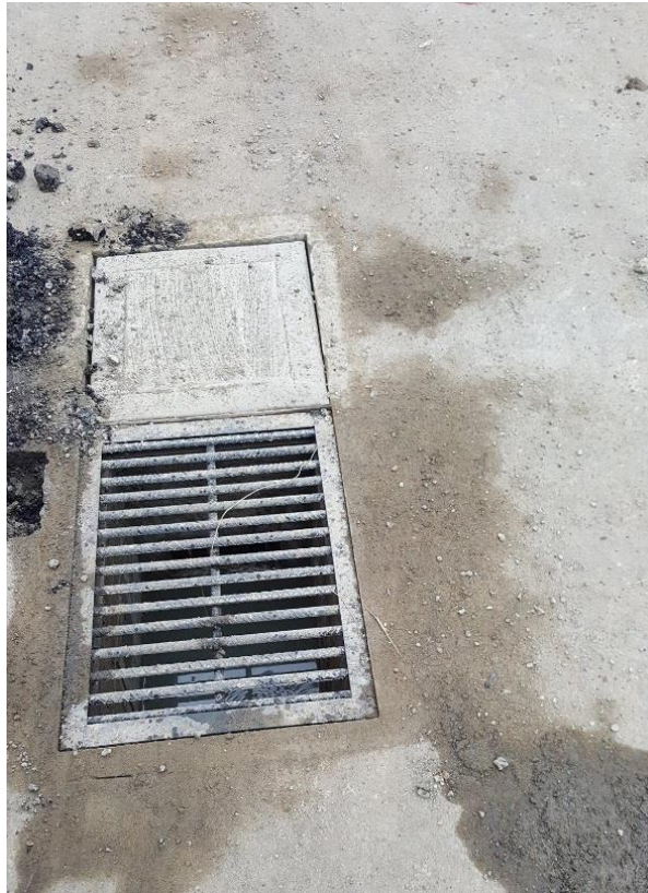
Figura 42. Sumidero. (Fuente: Propia)
