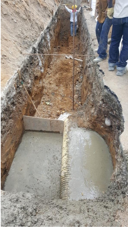
Figura 43. Fundición solado de cámara. (Fuente: Propia)
