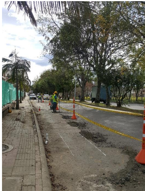
Figura 27. Señalización y demarcación de la vía. (Fuente: Propia)
