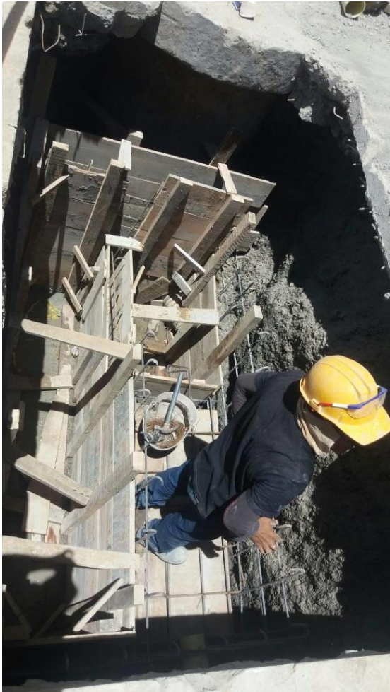
Figura 77. Instalación formaleta caja de aforo. (Fuente: Propia)
