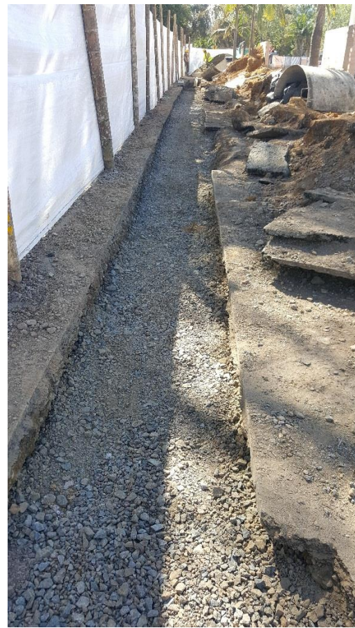
Figura 39. Colocación capa de base granular. (Fuente: Propia)
