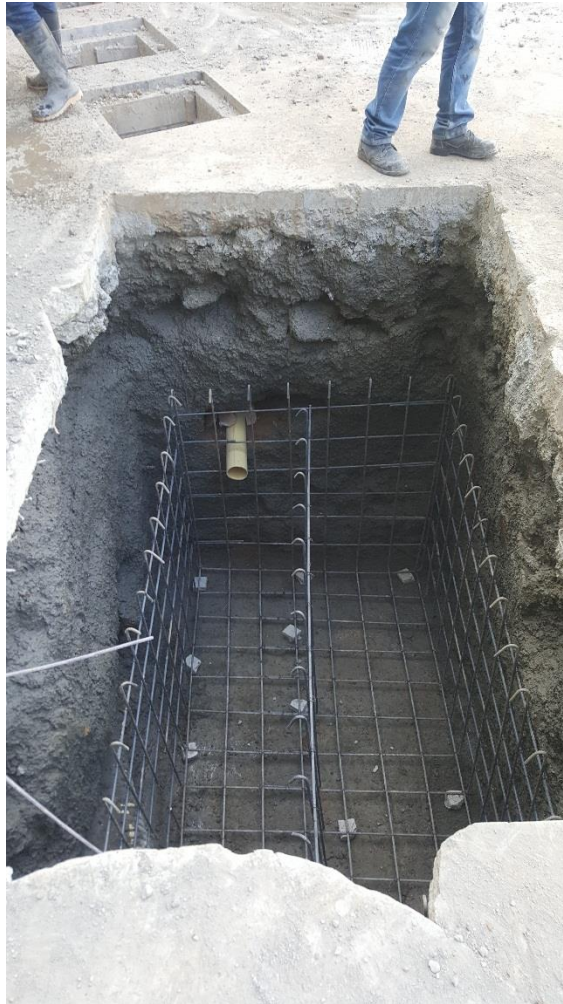
Figura 76. Fundición de losa e instalación de refuerzo. (Fuente: Propia)
