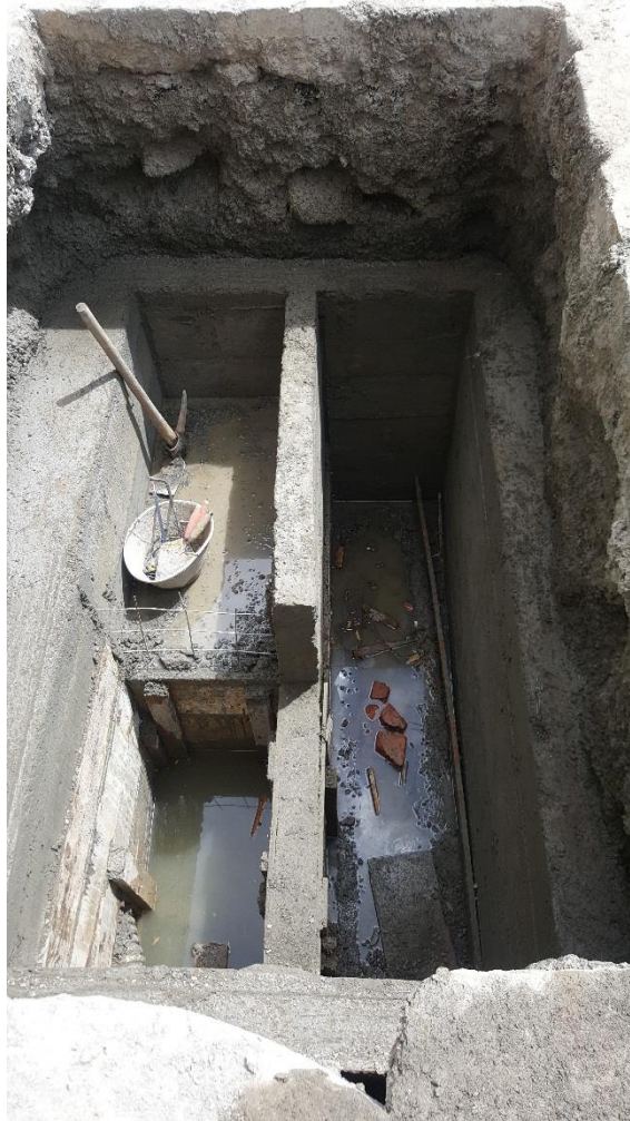
Figura 79. Desencofrado de caja de aforo. (Fuente: Propia)
