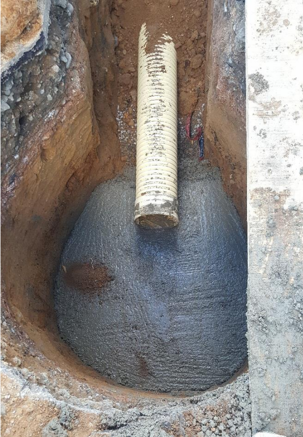
Figura 34. Solado de cámara inspeccionable. (Fuente: Propia)
