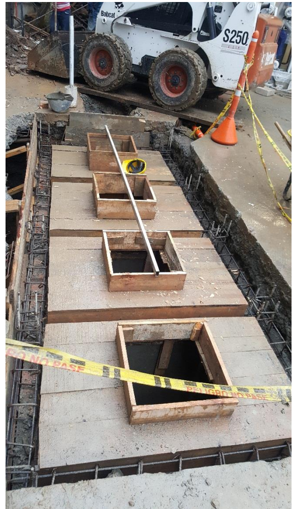
Figura 69. Construcción de cajones trampa de grasas. (Fuente: Propia)
