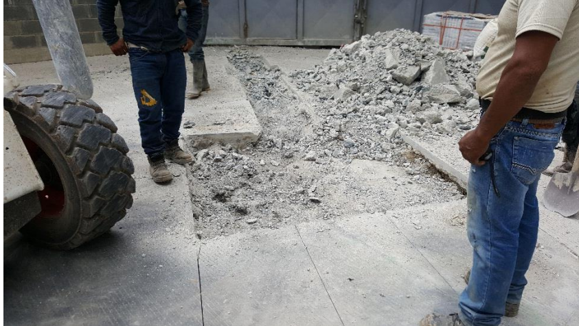
Figura 47. Demolición, trampa de grasas. (Fuente: Propia)
