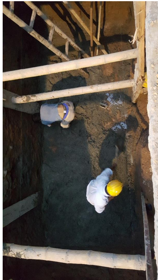
Figura 56. Construcción solado de limpieza. (Fuente: Propia)
