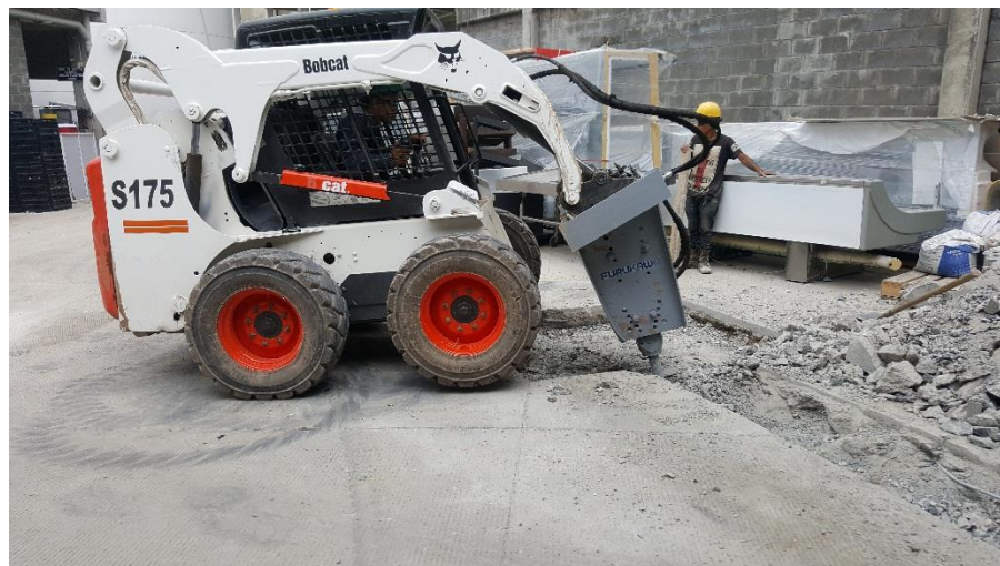
Figura 48. Demolición con bobcat trampa de grasas. (Fuente: Propia)
