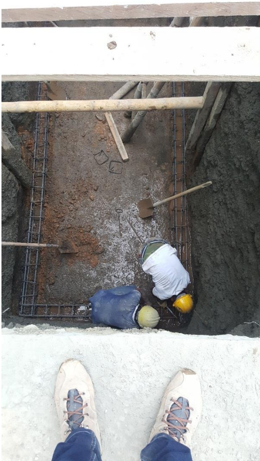
Figura 57. Instalación vigas perimetrales. (Fuente: Propia)
