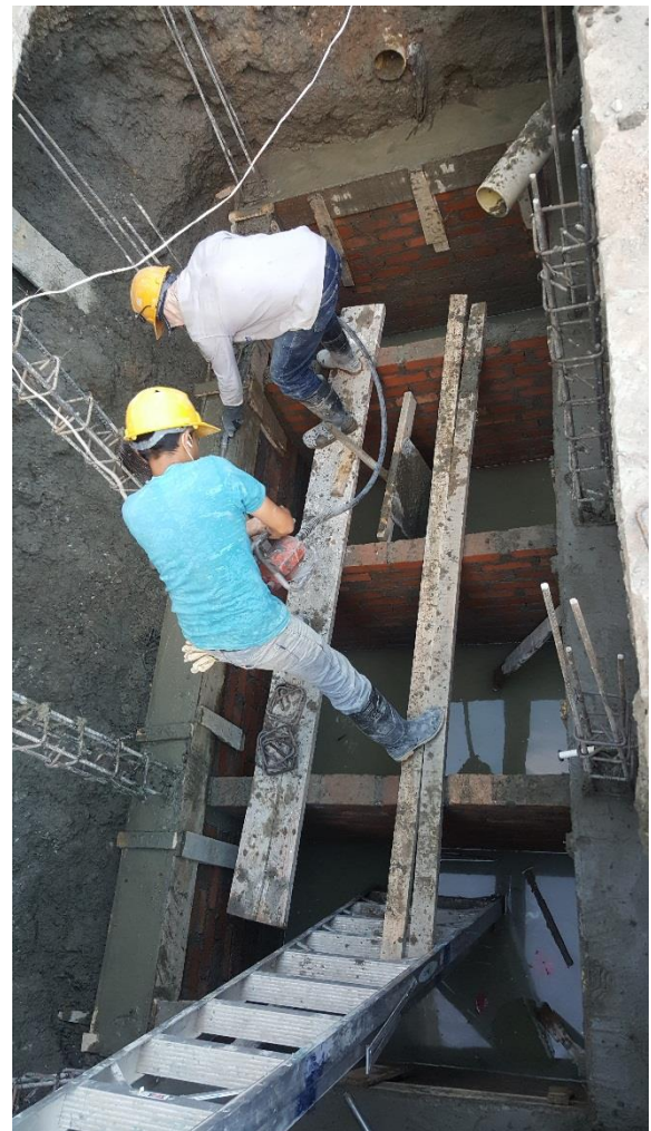
Figura 64. Vibrado vigas de amarre. (Fuente: Propia)
