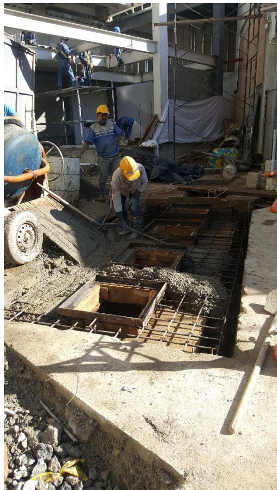
Figura 71. Fundición losa trampa de grasas. (Fuente: Propia)
