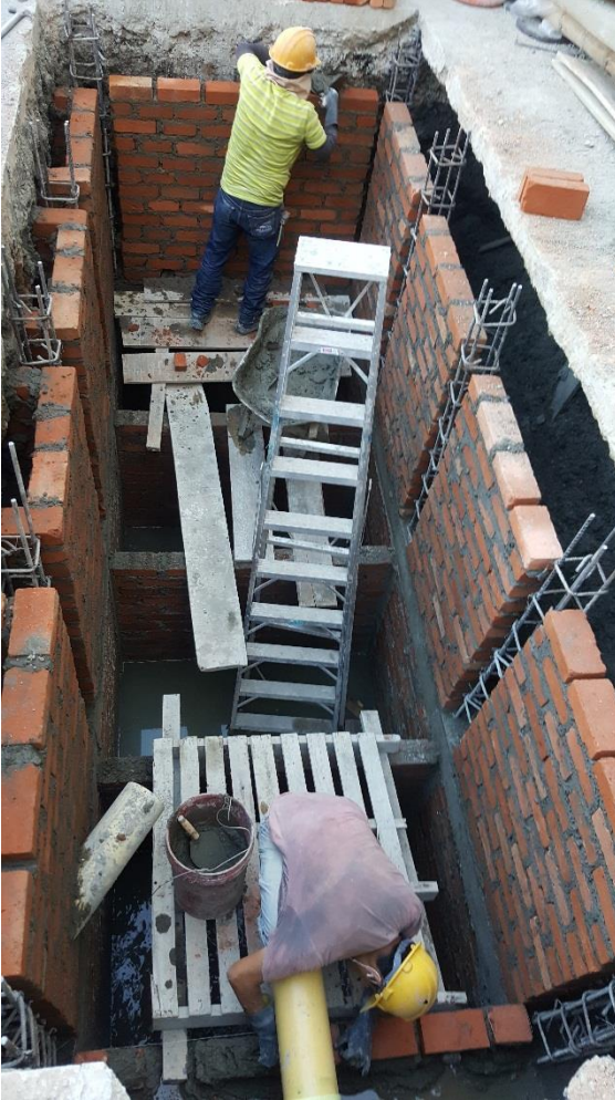
Figura 65. Muros, Pega de ladrillo. (Fuente: Propia)
