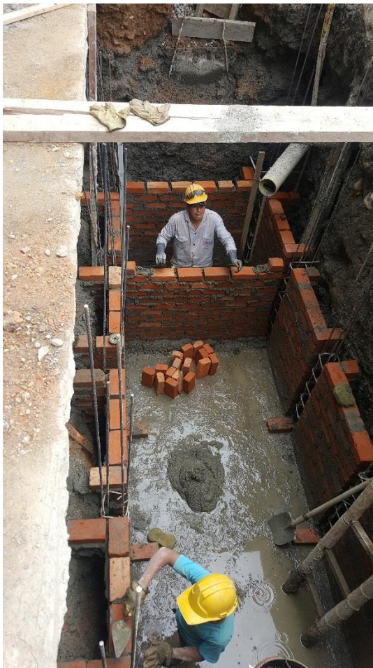
Figura 61. Pega de ladrillo. (Fuente: Propia)
