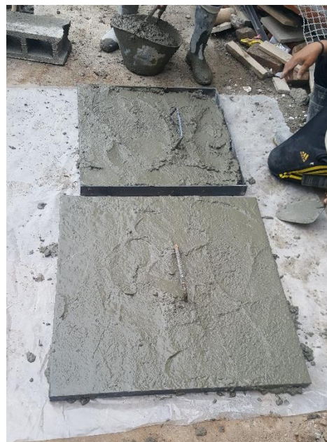
Figura 54. Fundición tapa de inspección. (Fuente: Propia)
