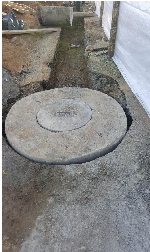
Figura 37. Instalación de brocal. (Fuente: Propia)
