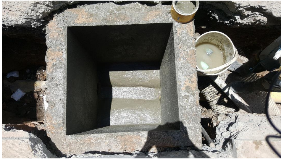
Figura 52. Acabado final caja de inspección. (Fuente: Propia)
