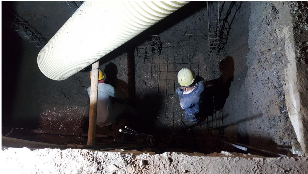
Figura 60. Colocación de la mezcla. (Fuente: Propia)
