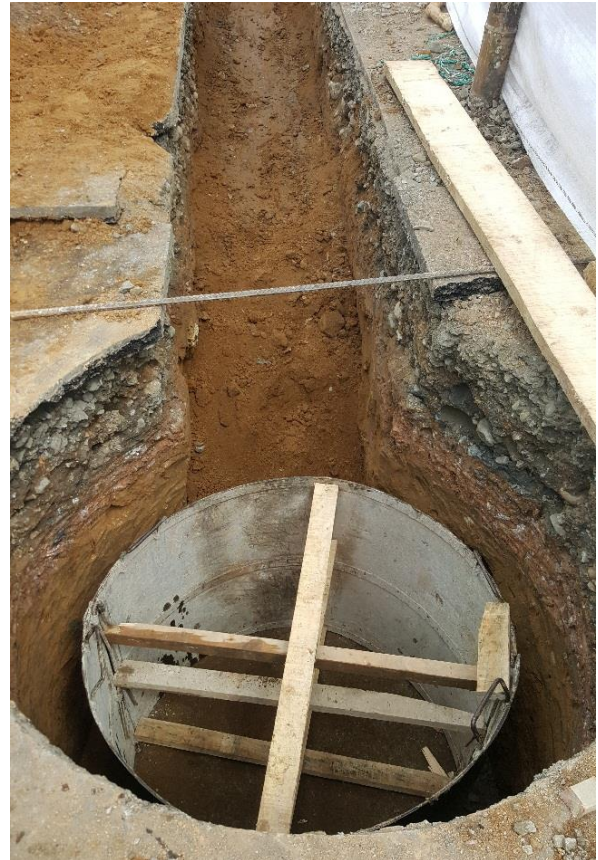
Figura 35. Formaleta cámara de inspección. (Fuente: Propia)
