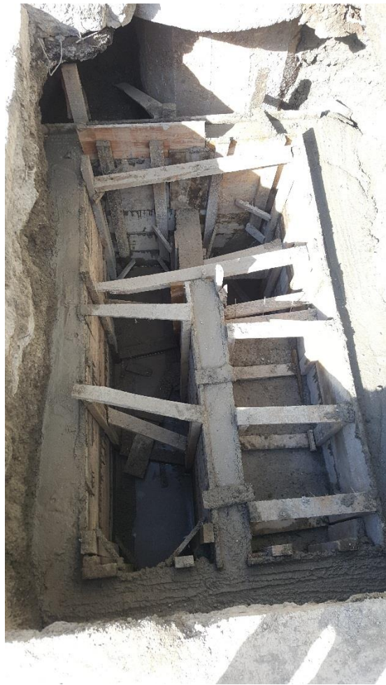
Figura 78. Fundición caja de aforo. (Fuente: Propia)
