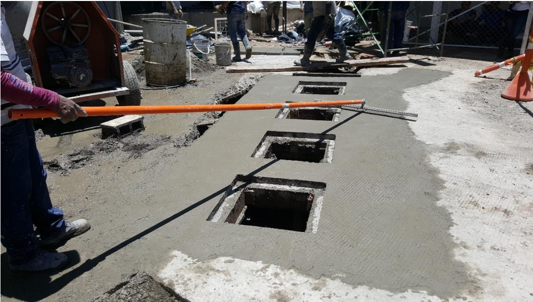
Figura 74. Terminado rugoso en losa. (Fuente: Propia)
