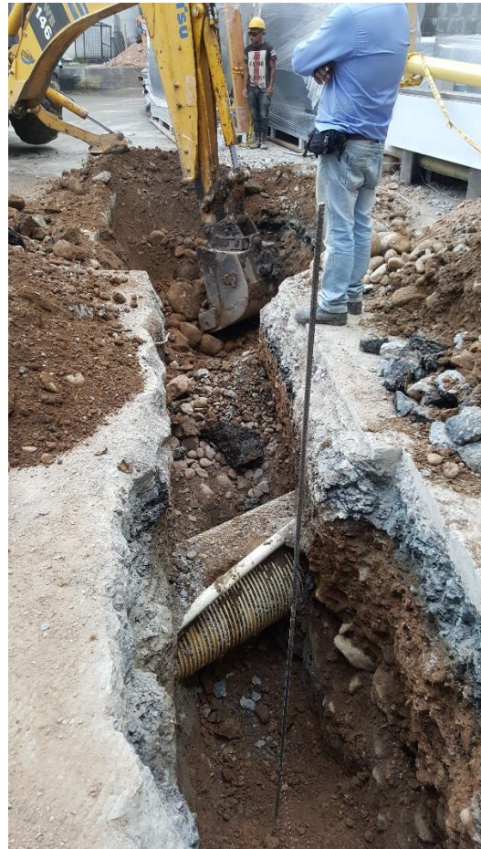
Figura 50. Excavación trampa de grasas. (Fuente: Propia)
