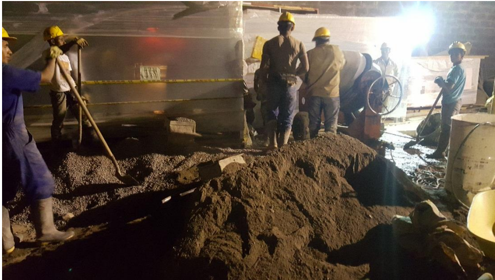
Figura 59. Fundición trampa de grasas. (Fuente: Propia)
