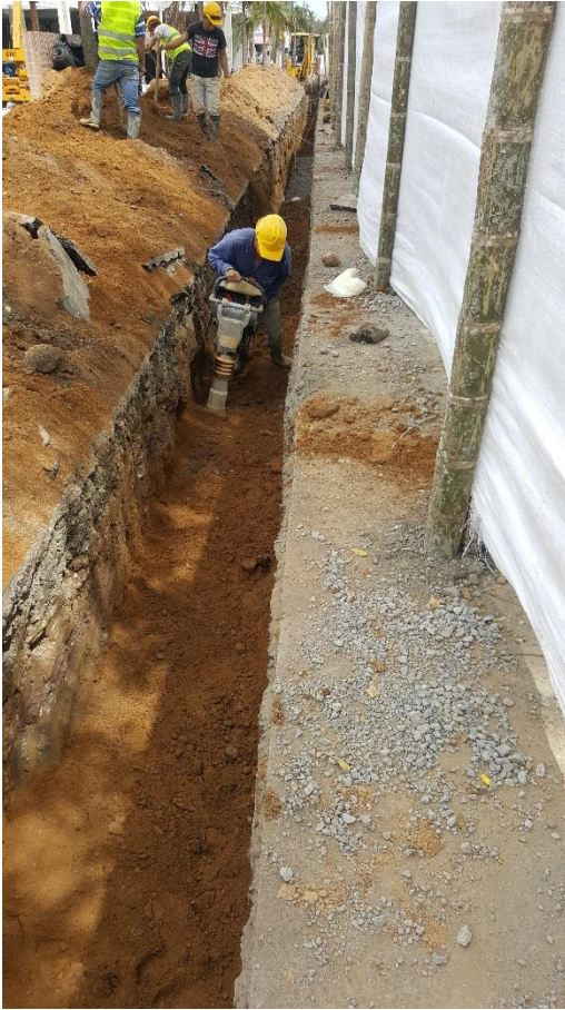
Figura 38. Compactación de la sub rasante. (Fuente: Propia)
