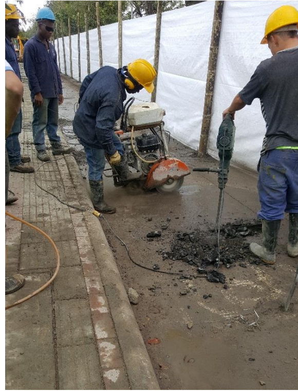
Figura 31. Corte de pavimento flexible. (Fuente: Propia)
