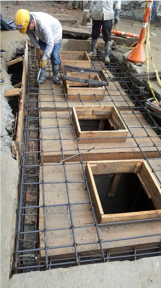
Figura 70. Construcción parrilla de ½". (Fuente: Propia)
