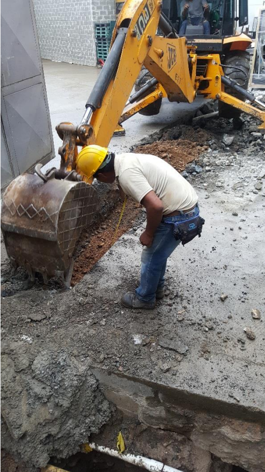
Figura 49. Excavación, tubería trampa de grasas. (Fuente: Propia)
