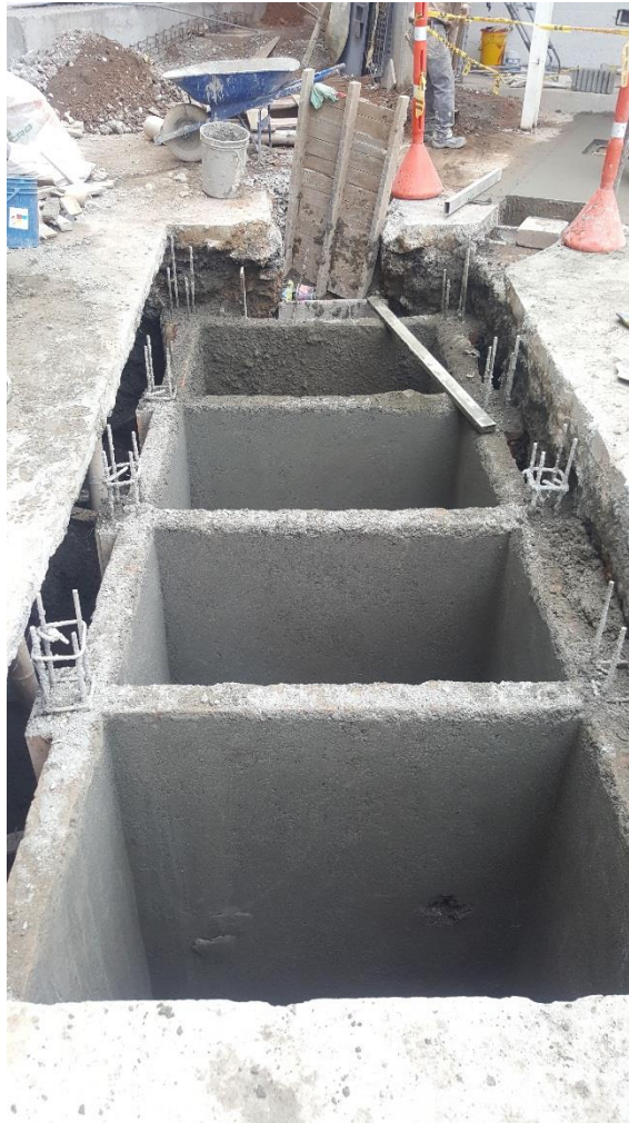
Figura 67. Terminación de aplicación de repello impermeabilizado. (Fuente: Propia)
