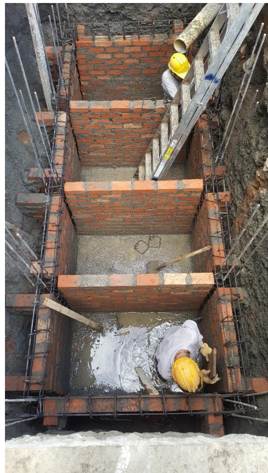
Figura 62. Instalación vigas de amarre. (Fuente: Propia)
