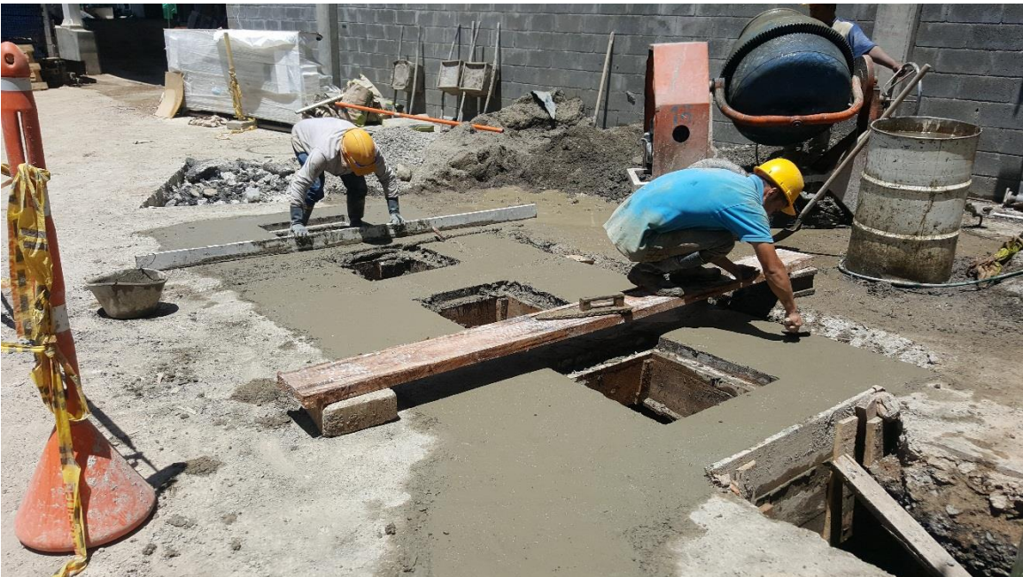
Figura 73. Terminado liso en losa. (Fuente: Propia)
