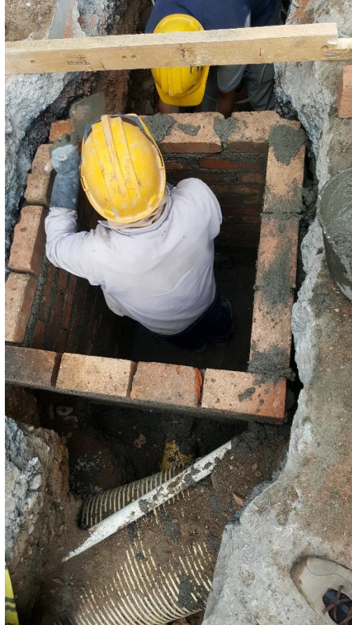
Figura 51. Construcción caja de inspección. (Fuente: Propia)
