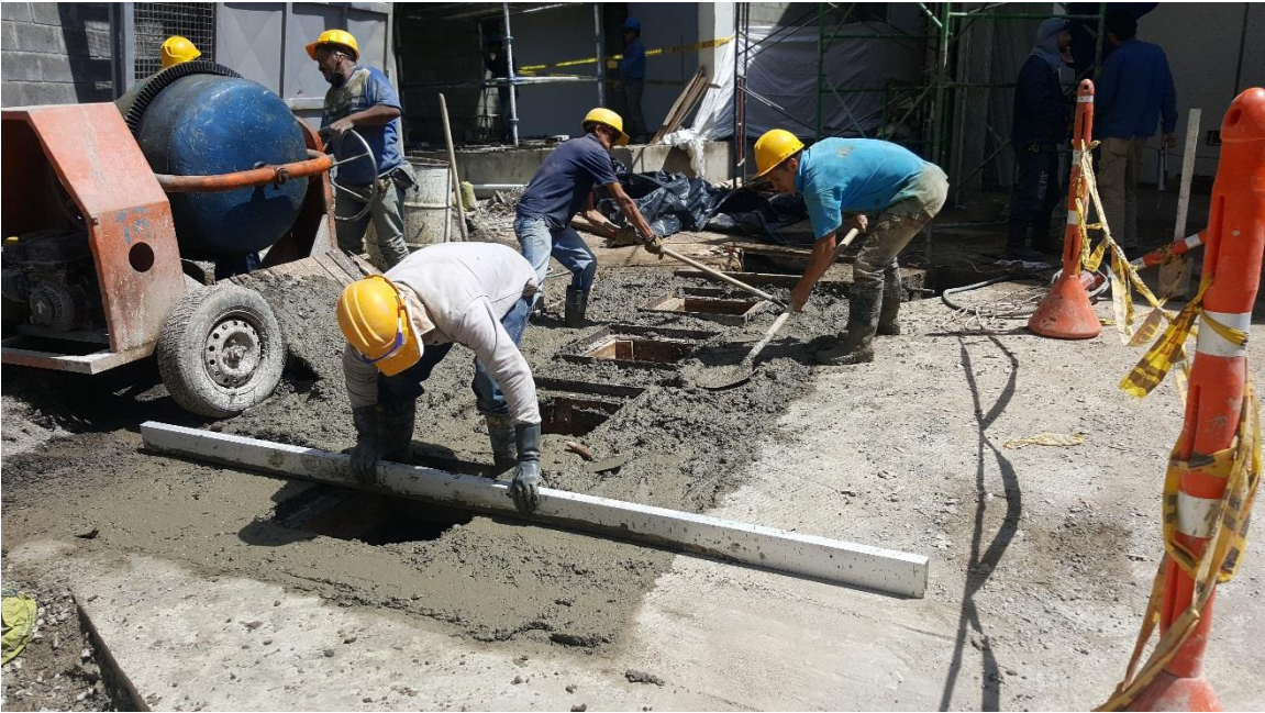
Figura 72. Terminado liso en losa. (Fuente: Propia)
