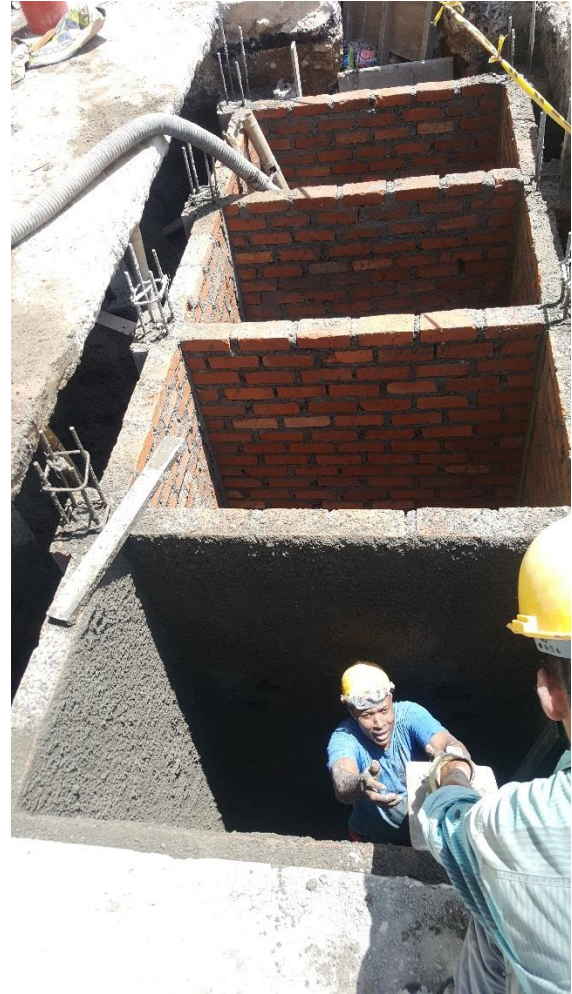
Figura 66. Aplicación de repello impermeabilizado. (Fuente: Propia)
