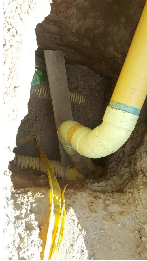
Figura 41. Conexión bajante – alcantarillado pluvial. (Fuente: Propia)
