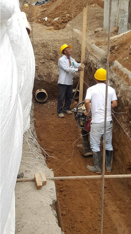
Figura 45. Chequeo de niveles, alcantarillados. (Fuente: Propia)
