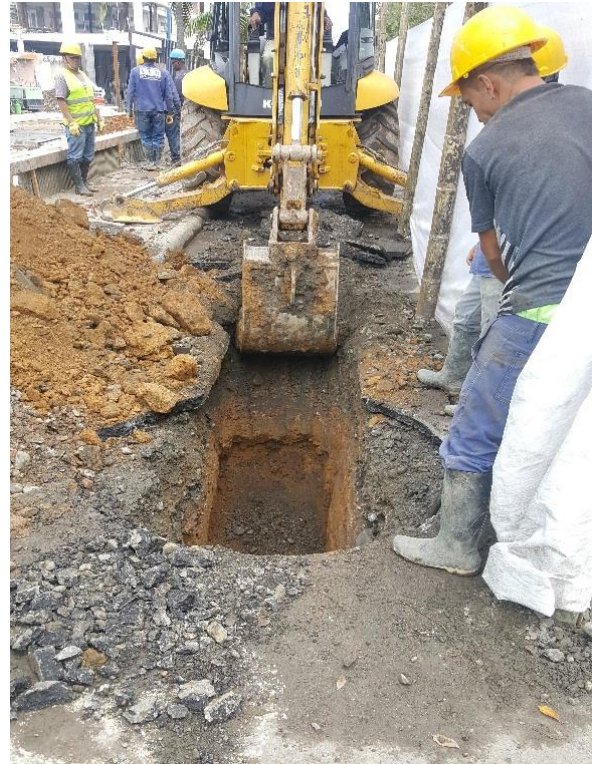
Figura 33. Excavación, alcantarillado sanitario (Fuente: Propia)
