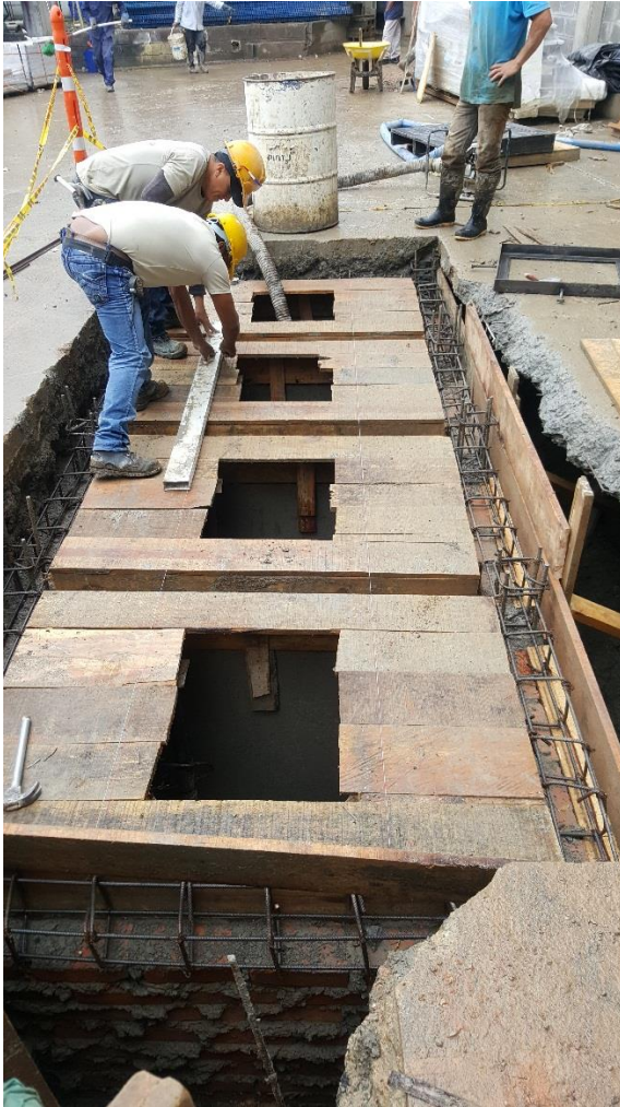
Figura 68. Construcción formaleta de apoyo para losa. (Fuente: Propia)
