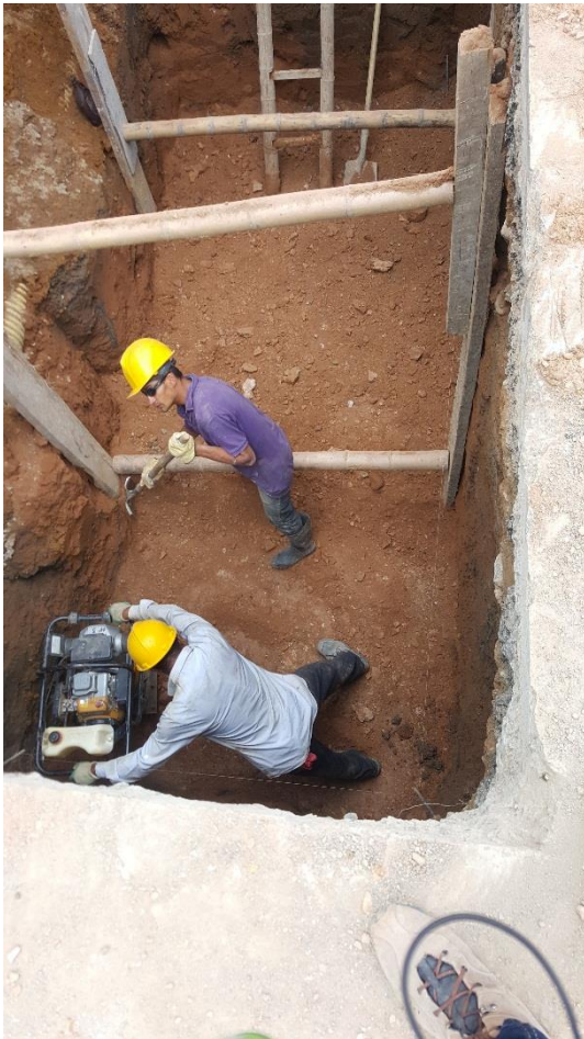
Figura 55. Compactación fondo trampa de grasas. (Fuente: Propia)
