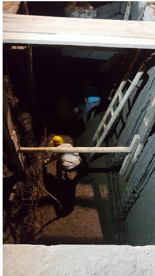
Figura 58. Instalación de columnetas. (Fuente: Propia)
