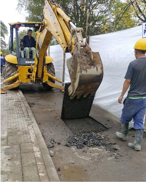
Figura 32. Corte y levantamiento de pavimento (Fuente: Propia)
