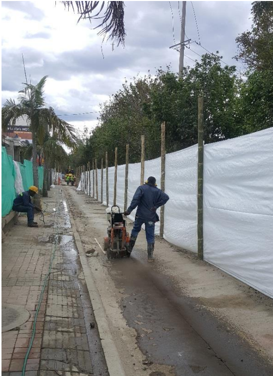
Figura 30. Corte de pavimento flexible. (Fuente: Propia)
