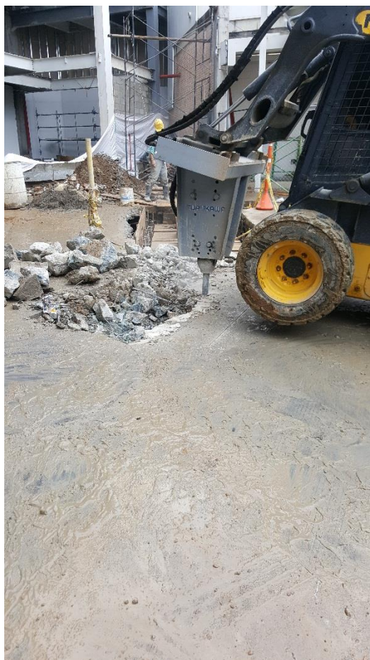
Figura 75. Demolición caja de aforo. (Fuente: Propia)
