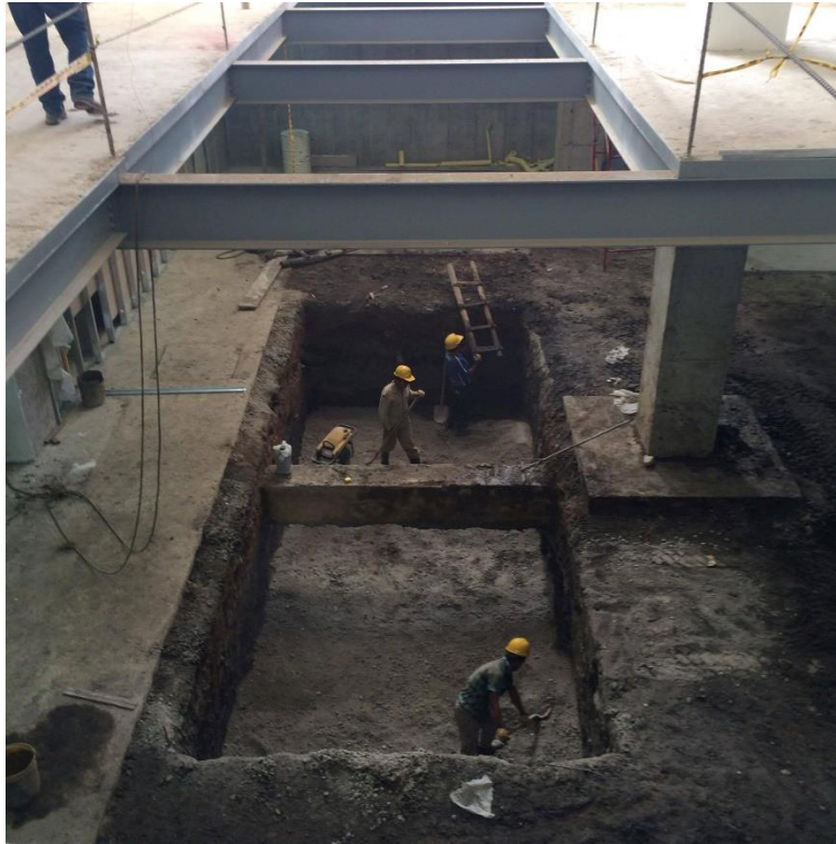
Figura 33. fundición losa de ascensores
