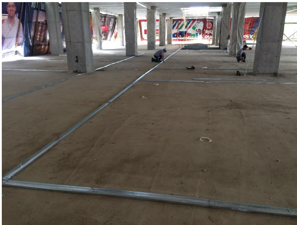
Figura 29. Replanteo disposición de áreas-primer piso
