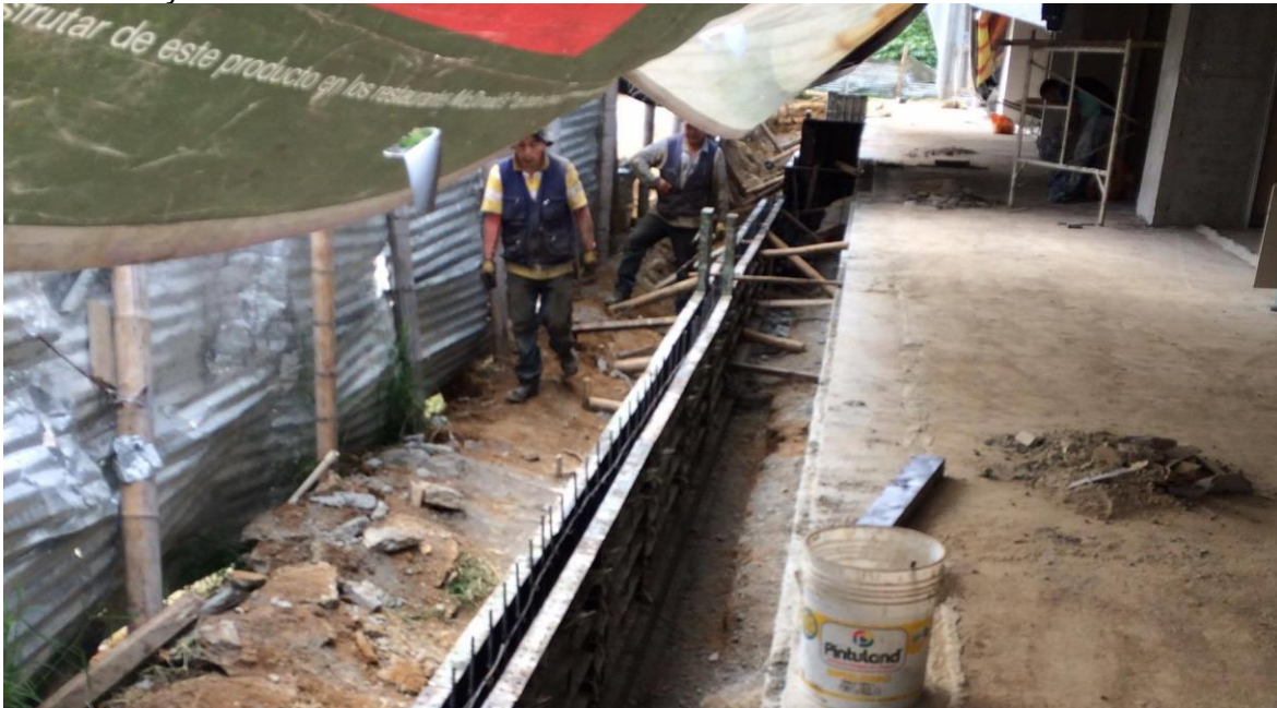
Figura 38-39. Detalles cimentacion accesos principales – instalacion refuerzo para los muros y formaleteo .
