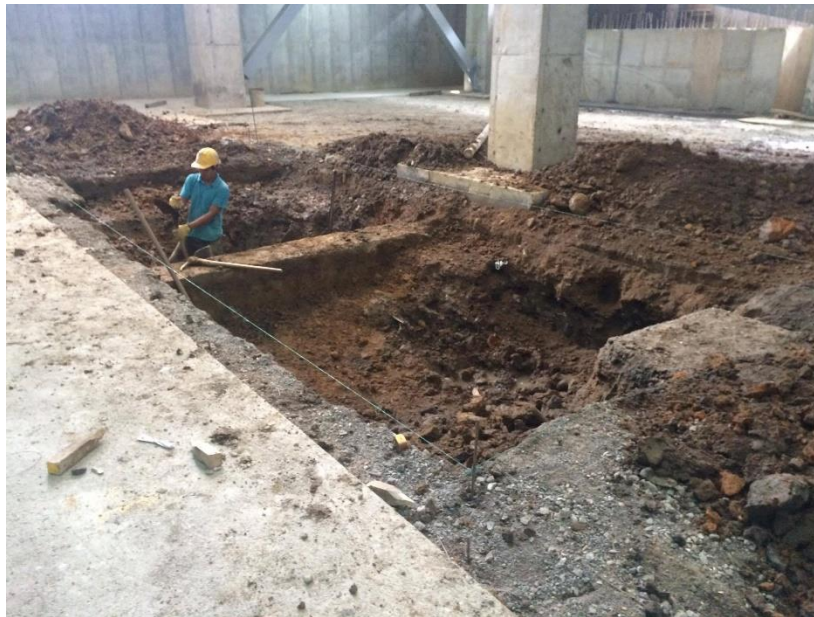
Figura 31. inicio excavación fosos de ascensores
