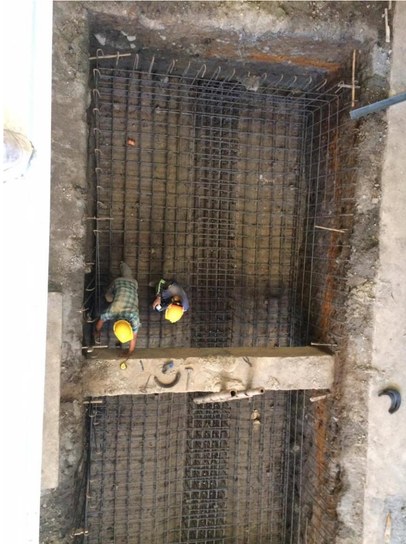
Figura 32. Instalación acero para la cimentación de la losa
