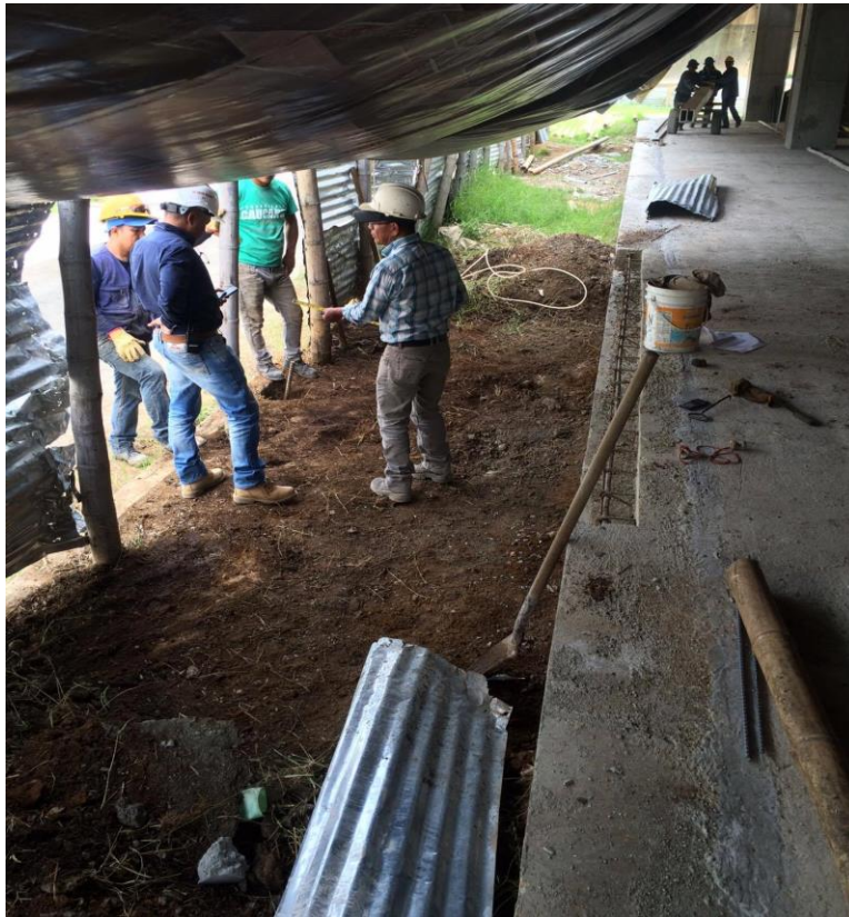
Figura 36-37. inicio labores accesos principales
