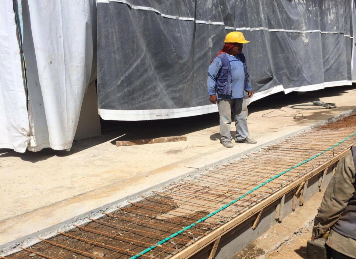
figura 40. Instalacion malla electrosoldada sobre la losa del corredor de acceso
