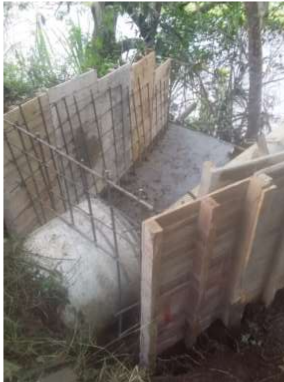
Figura N° 29: Colocación de la formaleta
