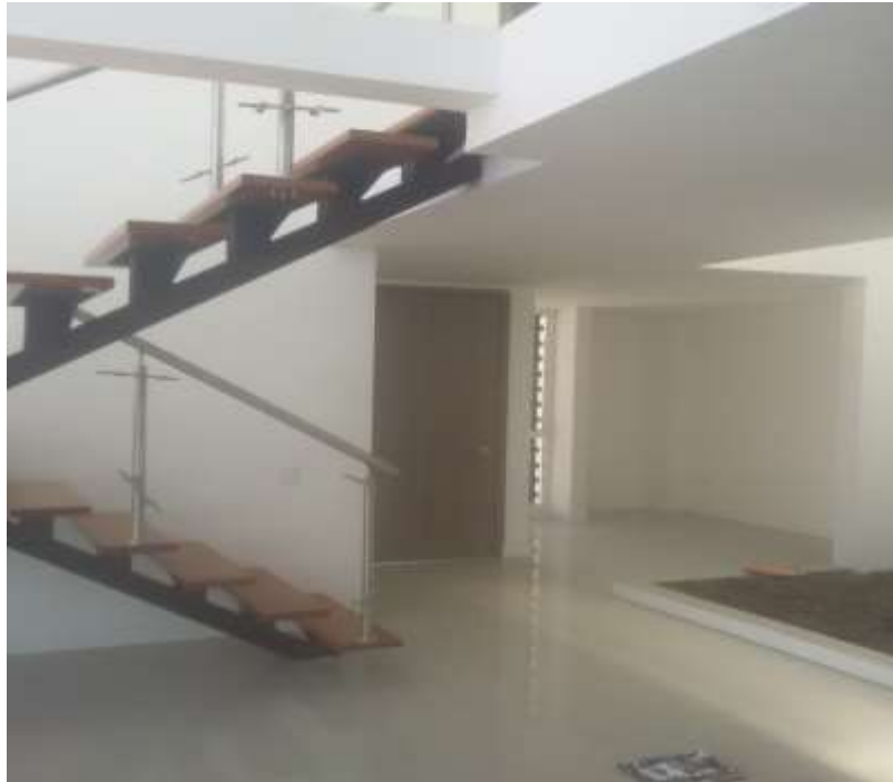
Figura N° 8: Piso en porcelanato del módulo 2 casa 1
