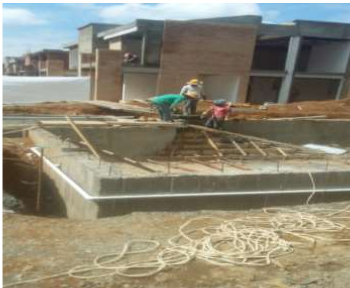
Figura N° 18: Construcción de las gradas
