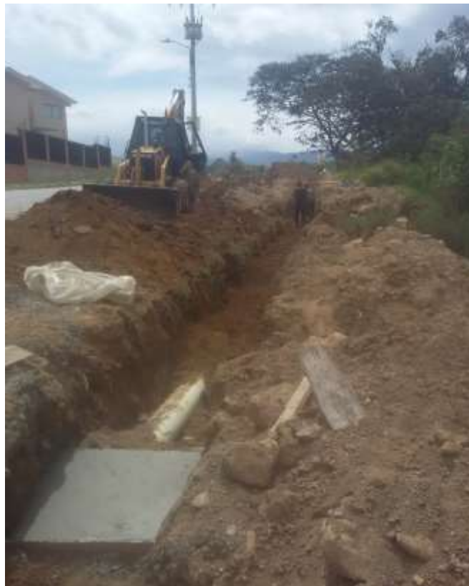
Figura N° 27: Rellenos de la vía con retroexcavadora Caterpillar
