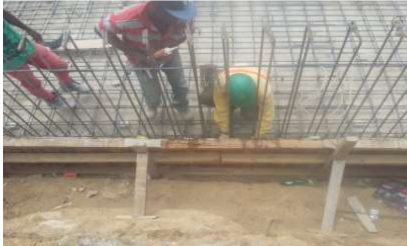
Figura N° 13: Colocación formaleta para losa piscina
