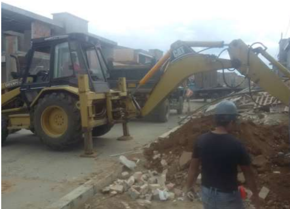
Figura N° 19: Movimiento de tierra con retroexcavadora Caterpillar entrada parqueadero
