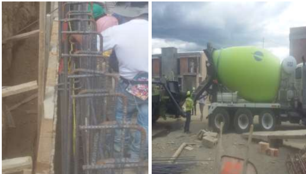
Figura N° 17: Fundición de los muros piscina
