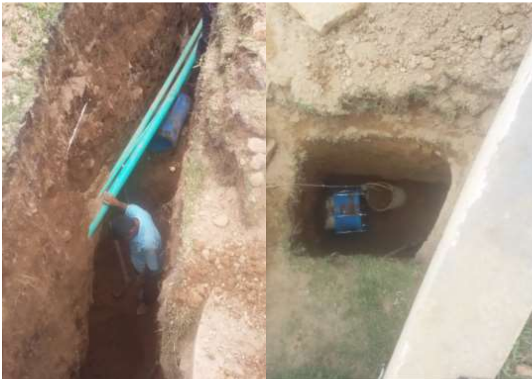
Figura N° 27: Accesorios para el acueducto
