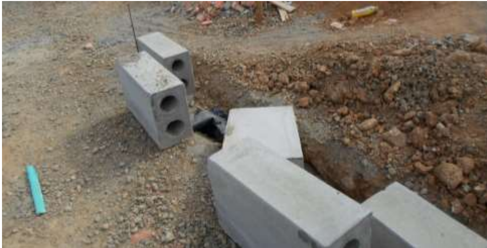
Figura N° 20: Colocación bordillos tipo a 80
