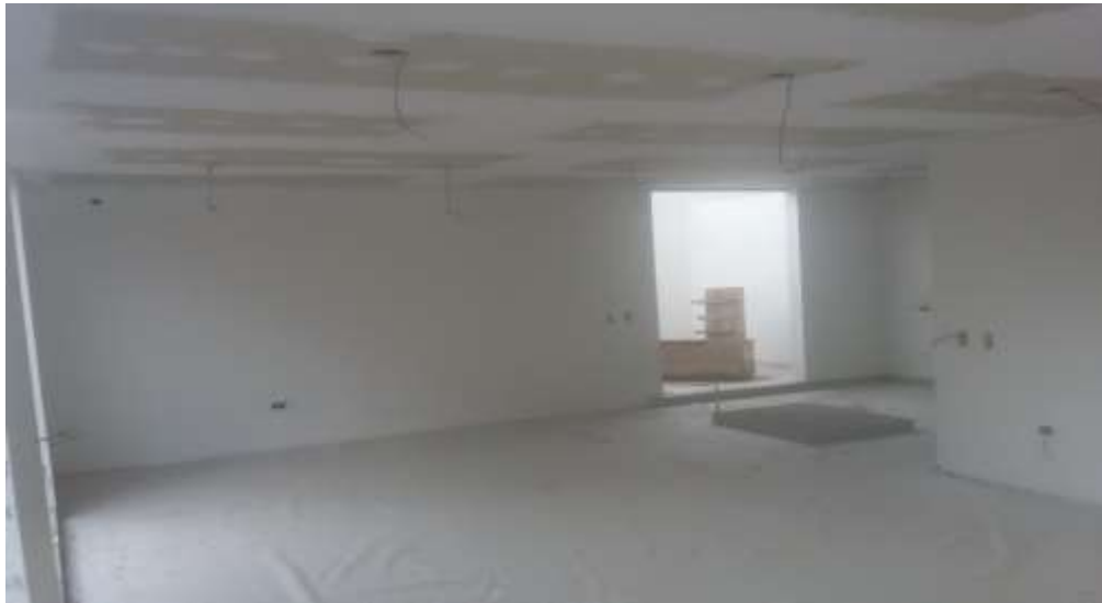
Figura N° 7: Muros y techo estucados cocinan módulo 20 casa 1
