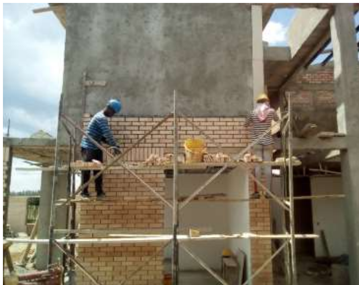
Figura N° 5: Colocación de la fachaleta para módulo 12 casa 2
