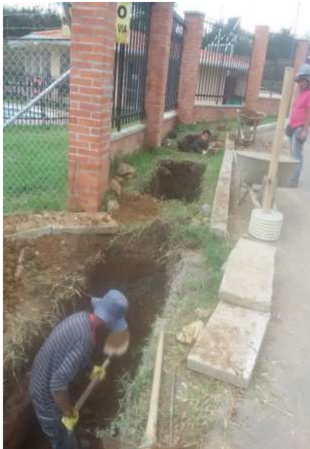
Figura N° 24: Excavación manual conjunto Valle Robledo
