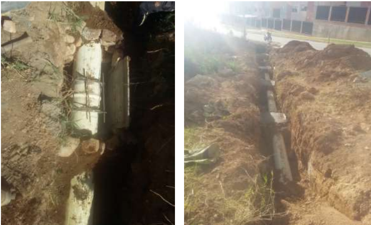
Figura N° 26: anclajes para acueducto
