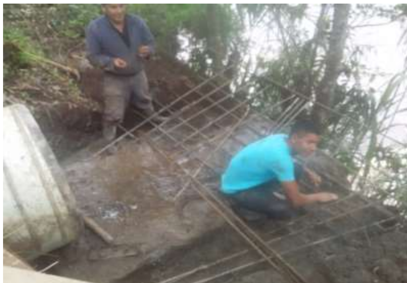
Figura N° 28: Colocación del acero de refuerzo
