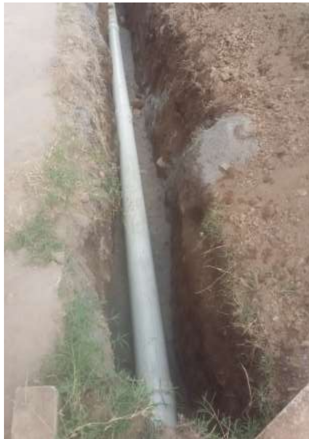
Figura N° 25: Instalación del acueducto 14 pulgadas
