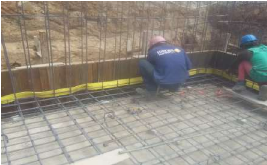
Figura Nº 12: Colocación Cinta Sika PVC V-10
