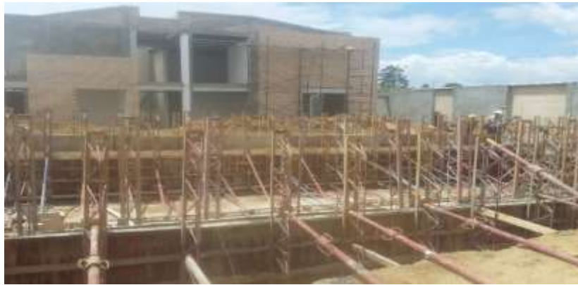
Figura N° 16: Colocación formaleta para muros piscina
