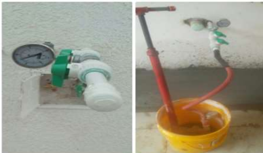
Figura N° 10: Ejecución prueba hidráulica
