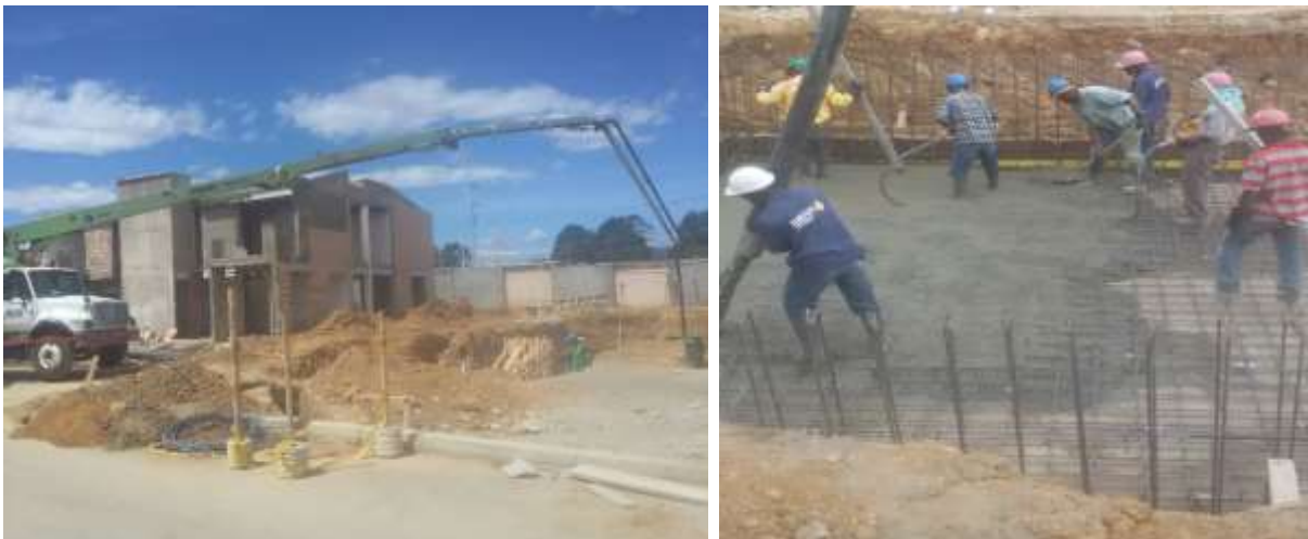
Figura N° 14: Fundición de losa
