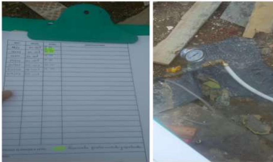
Figura N° 9: Formato y ejecución de la prueba de gas
