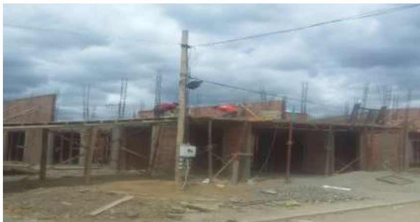
Figura N° 3: construcción de muros segundo piso para módulo 14 casa 1
