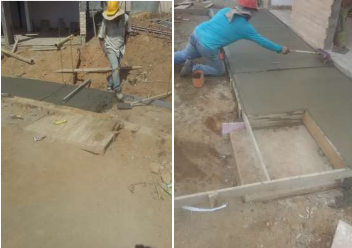
Figura N° 21: Construcción y barrido de andén
