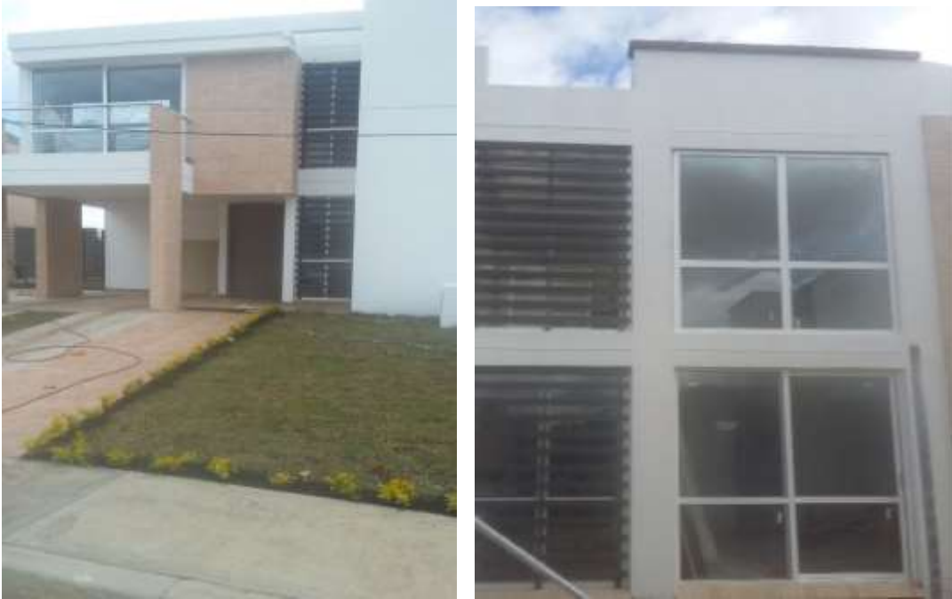
Figura N° 30: Casa terminada módulo 18 casa 1
