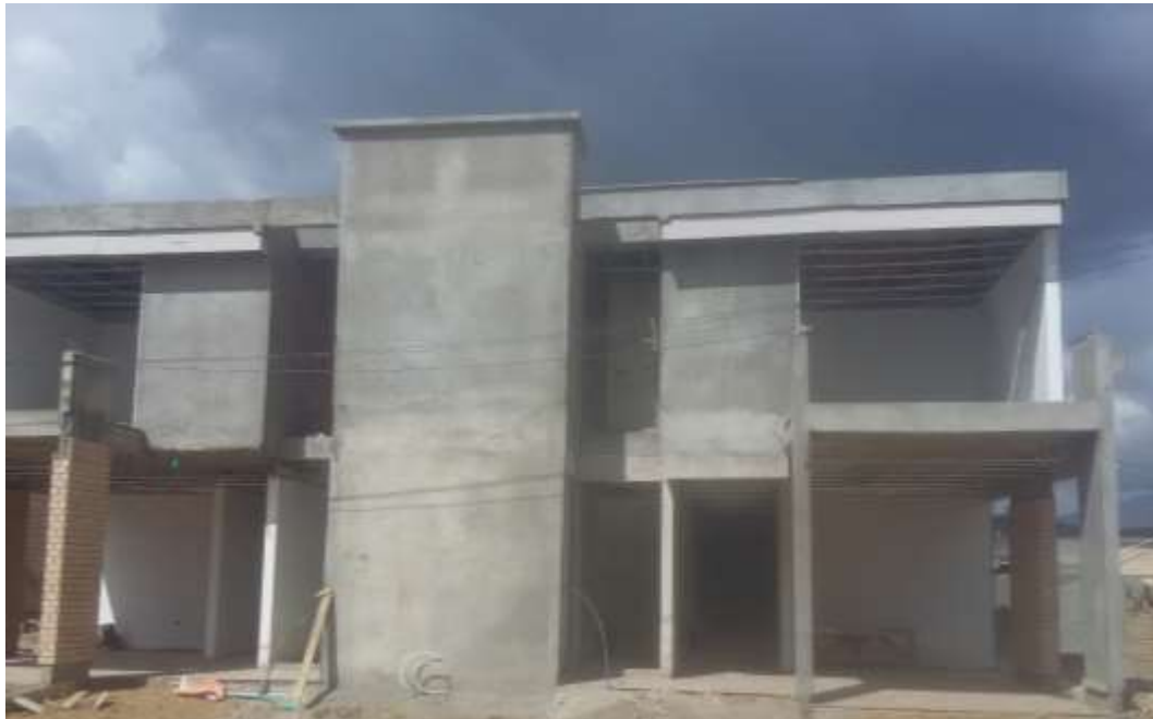
Figura N° 6: Pañetes sobre muro y fachada módulo 12 casa 2
