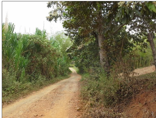
Fotografía 1. Vía Ardobelas - santa lucia
