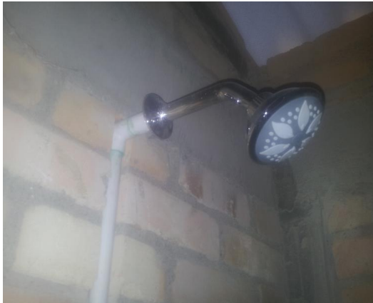
Foto 59. Regadera instalada. Fuente Construcción propia.
