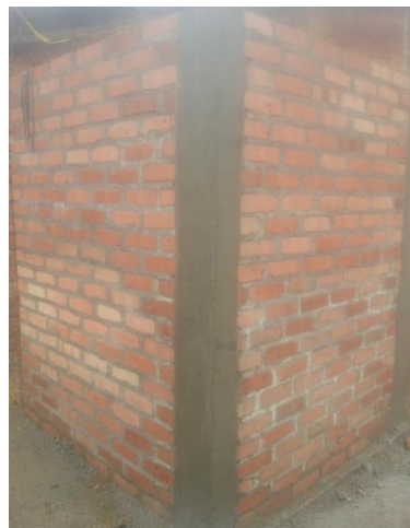
Foto 32. Columnetas. Fuente Construcción propia
