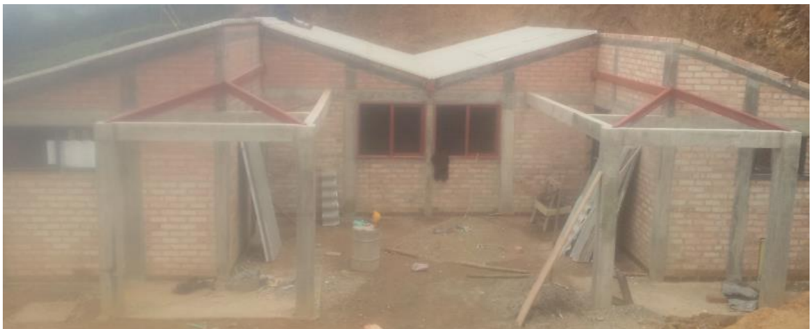
Foto 47. Estructura de cubierta con perlines en Porshe. Fuente Construcción propia.
