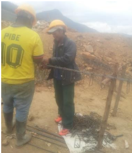
Foto 6. Armado de acero de refuerzo Fuente Construcción propia
