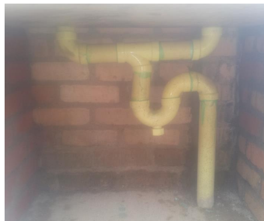
Foto 56. Adecuación de sifones para lavaderos. Fuente Construcción propia Fuente
