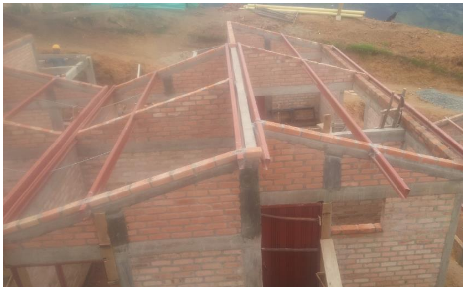
Foto 44. Localización de perlines. Fuente Construcción propia
