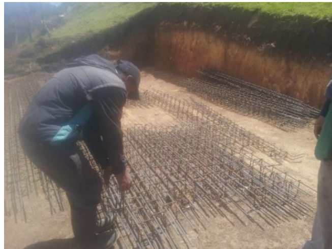
Foto 7. Acero de refuerzo armado. Fuente Construcción propia
