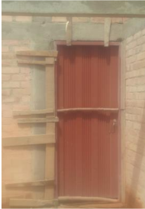
Foto 62. Apuntalamiento para marco de puertas. Fuente Construcción propia.
