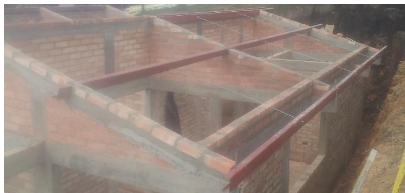
Foto 45. Perlinoes unidos con templetes. Fuente Construcción propia
