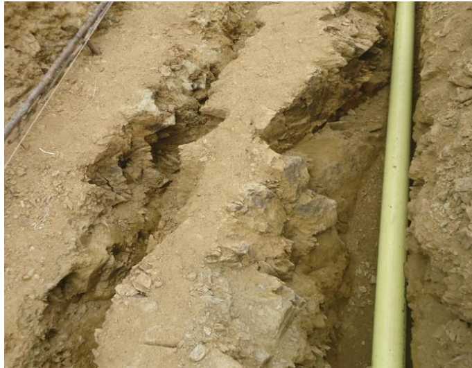
Foto 15. Suelo con presencia de roca partida. Fuente Construcción propia
