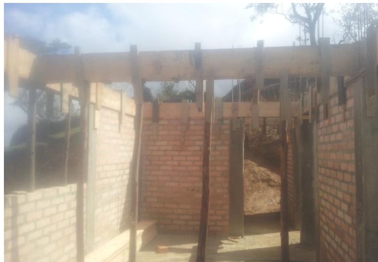
Foto 38. Viga simplemente apoyada en cocina. Fuente Construcción propia
