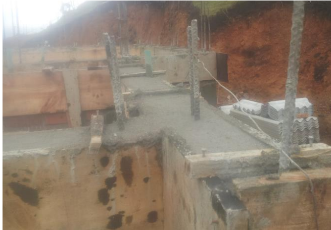
Foto 35. Viga fundida. Fuente Construcción propia.
