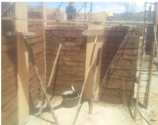
Foto 24. Puntales con varas y tablas. Fuente Construcción propia
