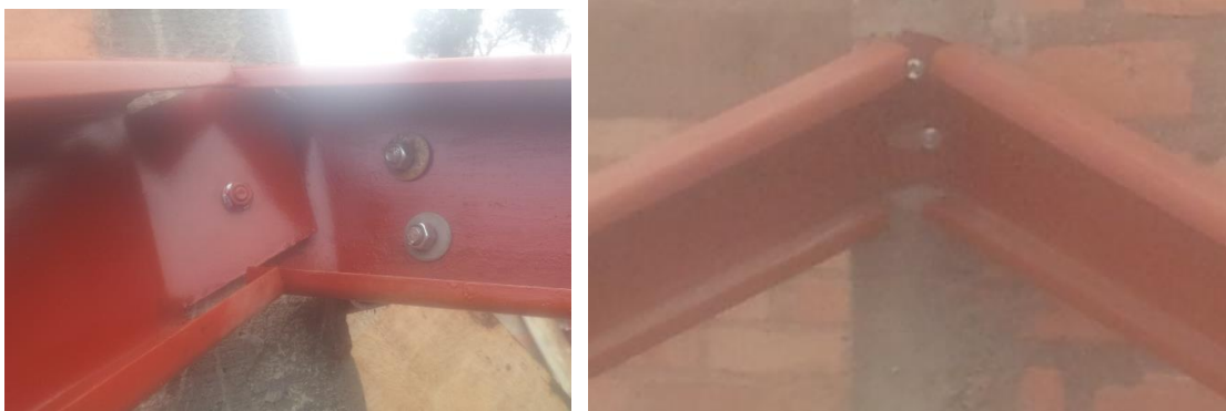
Foto 46. Uniones y apoyo de perlines sobre cubierta Porshe. Fuente Construcción propia
