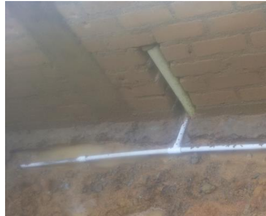
Foto 60. Entrada de punto hidráulico lavamanos. Fuente Construcción propia.
