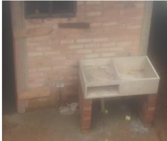
Foto 57. Lavadero instalado. Fuente Construcción propia.
