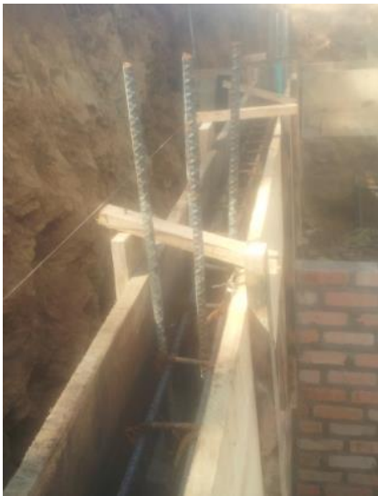
Foto 34. Formaleta. Fuente Construcción propia.
