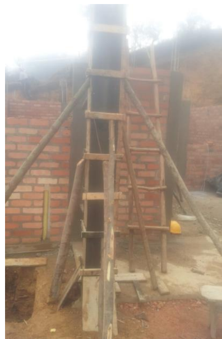
Foto 28. Formaleta para vigas porche. Fuente Construcción propia
