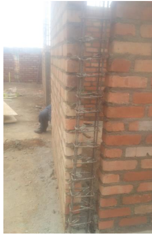
Foto 30. Detalle acero de columnetas. Fuente Construcción propia
