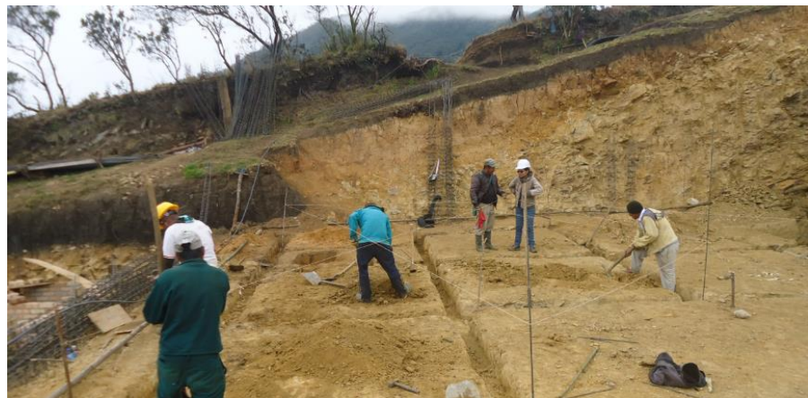
Foto 14. Cuadrilla trabajando en excavación de vigas cemento. Fuente Construcción propia.
