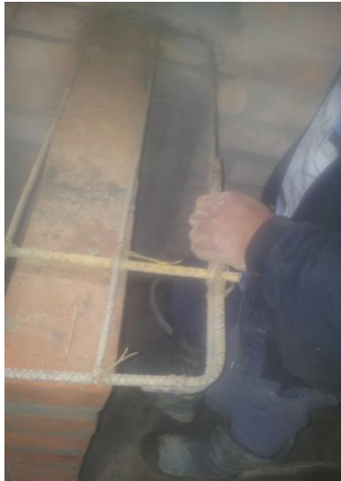
Foto 54. Refuerzo para mesón de cocina. Fuente Construcción propia.
