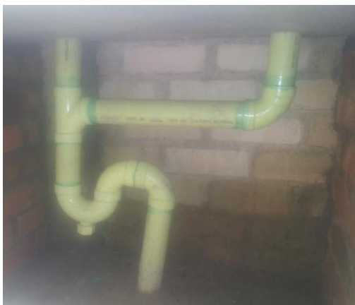
Foto 56. Adecuación de sifones para lavaderos. Fuente Construcción propia Fuente
