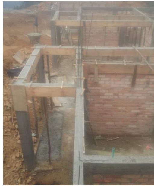
Foto 37. Vigas simplemente apoyadas en porche. Fuente Construcción propia.
