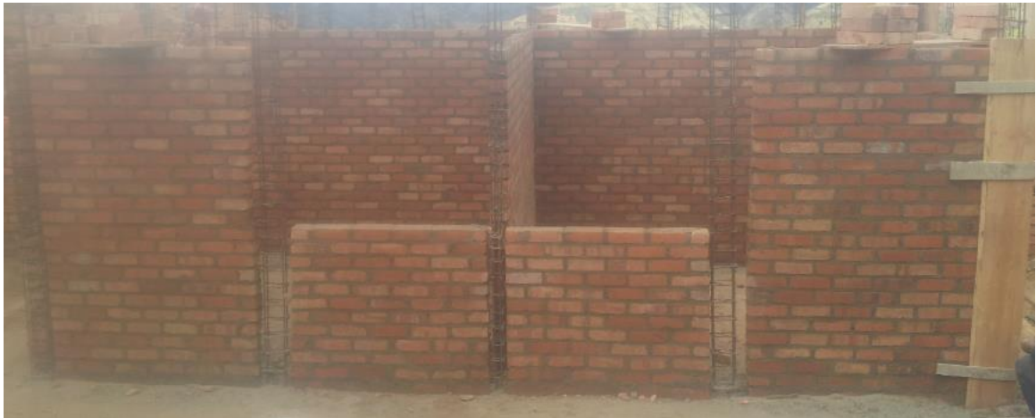
Foto 26. Muros fachada trasera. Fuente Construcción propia
