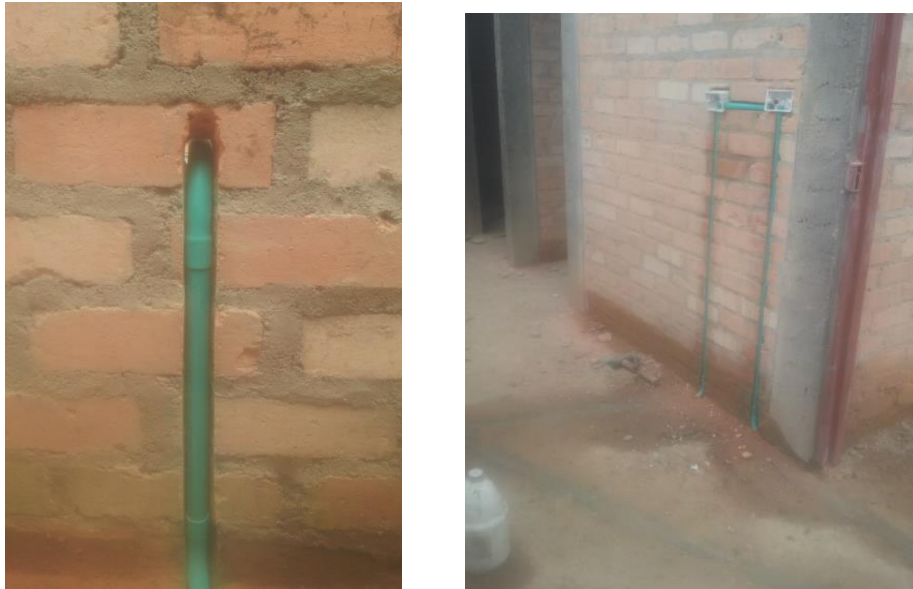
Foto 68. Instalaciones eléctricas. Fuente Construcción propia.
