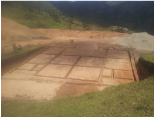
Foto 12. Detalle de excavación. Fuente Construcción propia
