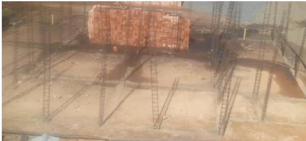
Foto 22. Cimentación. Fuente Construcción propia
