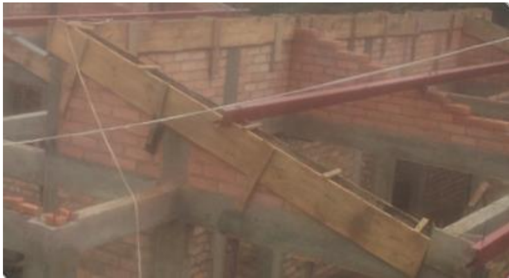
Foto 43. Perlin apoyado sobre formaleta de cinta de amarre. Fuente Construcción propia
