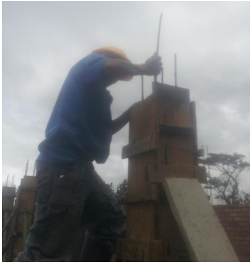
Foto 29. Compactando concreto en columna Porsche. Fuente Construcción propia
