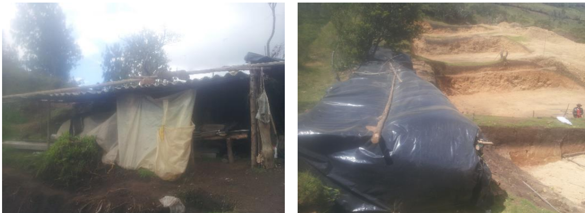
Foto 2. Almacén construido por la comunidad beneficiaria.
