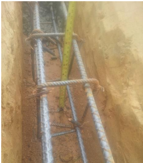
Foto 16. Sección viga de cimentación. Fuente Construcción propia
