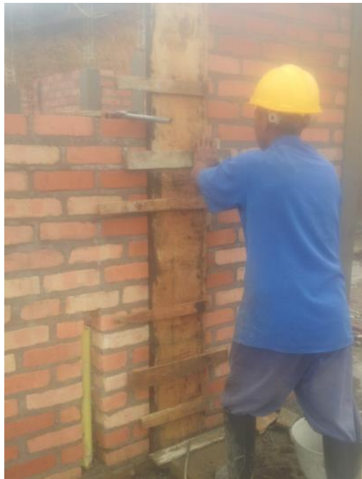
Foto 27. Instalación de formaleta Fuente Construcción propia
