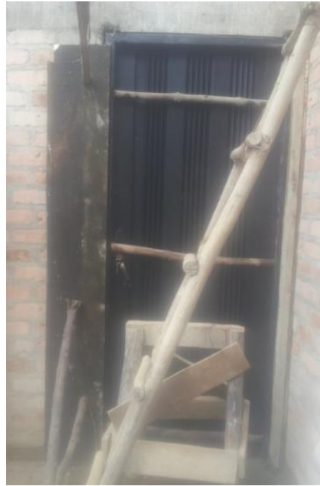
Foto 62. Apuntalamiento para marco de puertas. Fuente Construcción propia.
