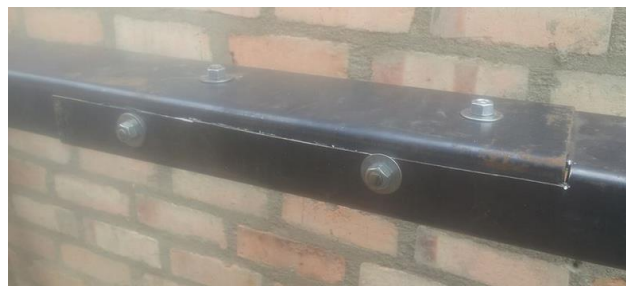
Foto 40. Empalme de perlines. Fuente Construcción propia.
