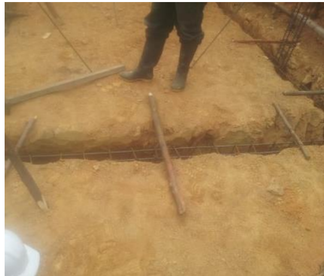
Foto 17. Varas de madera para garantizar recubrimientos. Fuente Construcción propia
