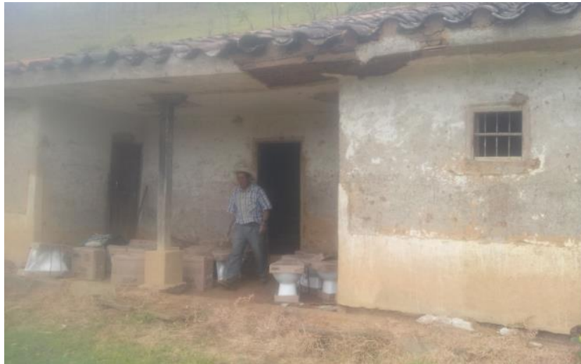
Foto 3. Almacén provisto por la comunidad beneficiaria. Fuente. Construcción propia
