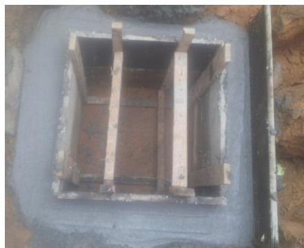
Foto 51. Formaleta y fundición de recamara.
