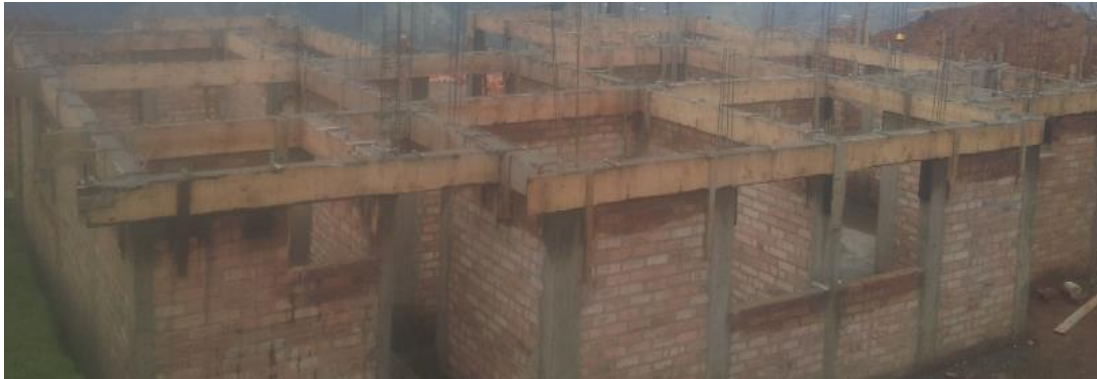
Foto 39. Vigas de amarre. Fuente Construcción propia.
