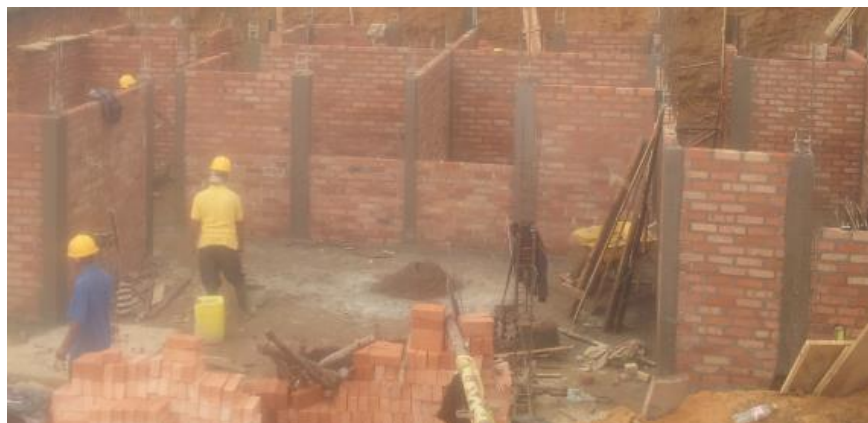
Foto 33. Columnetas fundidas. Fuente Construcción propia
