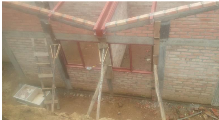
Foto 66. Marco de ventanas apuntaladas. Fuente Construcción propia.
