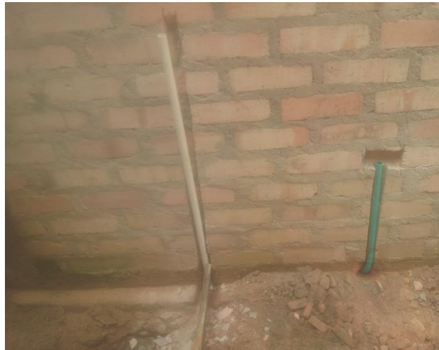
Foto 61. Tubería para punto hidráulico de lavadero. Fuente Construcción propia.
