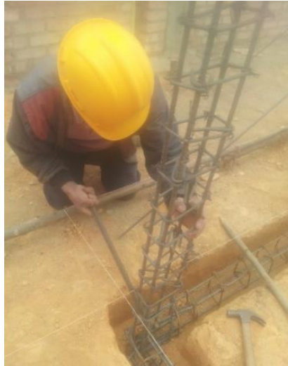
Foto 18. Localización de acero de columnetas. Fuente Construcción propia
