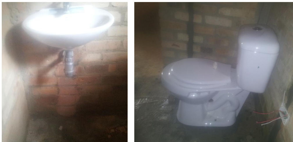
Foto 58. Lavamanos y sanitario instalados. Fuente Construcción propia.
