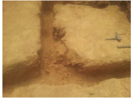
Foto 13. Excavación general de vigas cemento. Fuente Construcción propia
