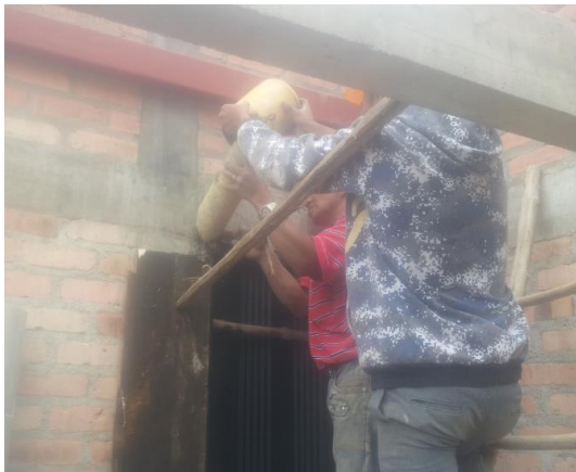
Foto 63. Aplicación de mortero en marco. Fuente Construcción propia.
