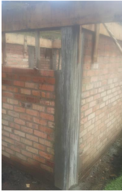
Foto 36. Resto de fundición de vigas. Fuente Construcción propia.
