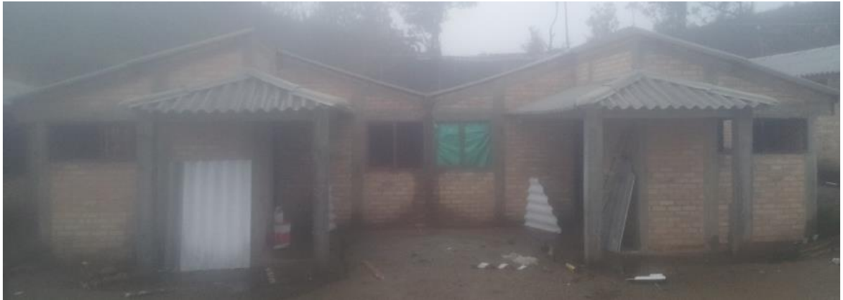
Foto 48. Pacha de viviendas con cubierta instalada. Fuente Construcción propia.
