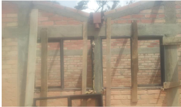
Foto 65. Marco de ventanas apuntaladas. Fuente Construcción propia.
