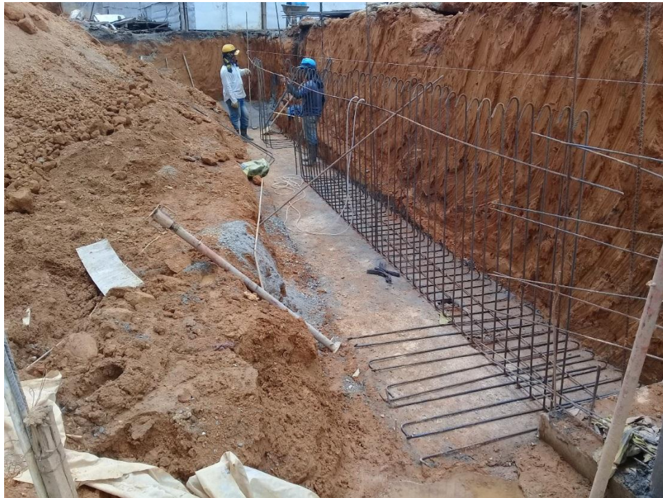
Figura N° 19d: Vista de muro de contención de la torre C.
