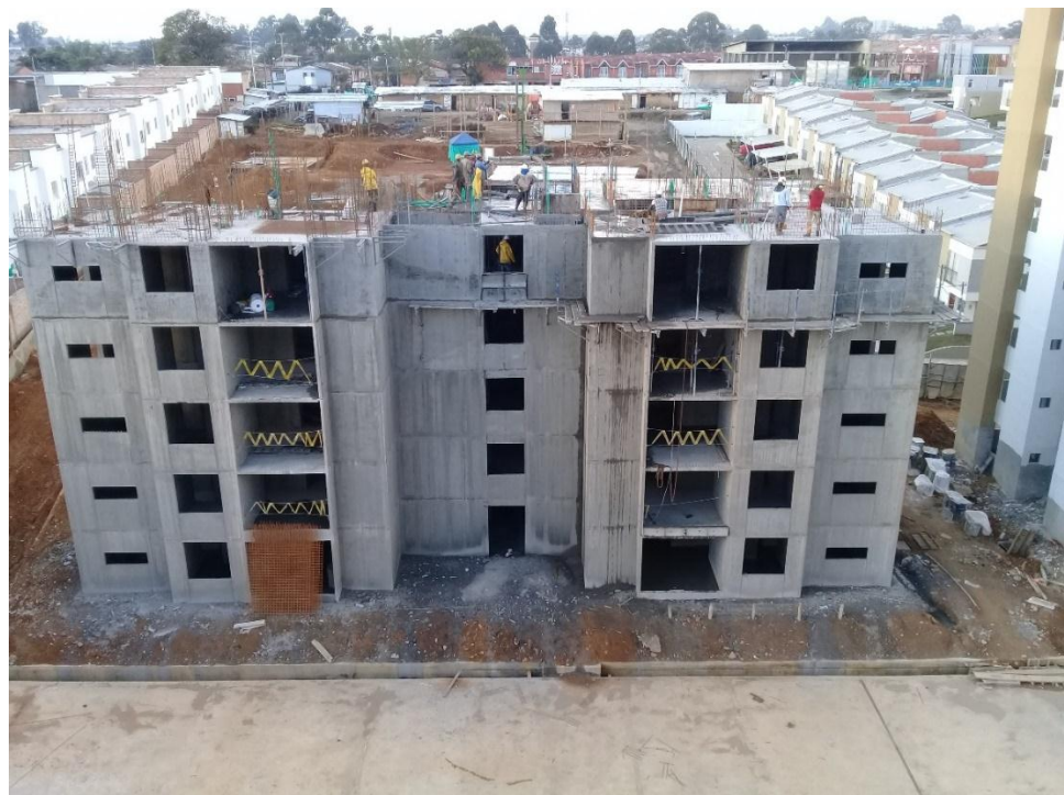
Figura N° 18d: vista de fundición del piso 5 torre C.
