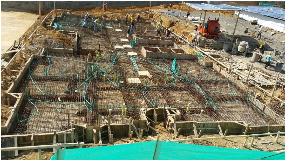
Figura N° 17g: Formaleta para la losa (Tableros de madera)
