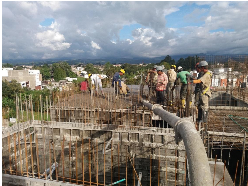
Figura N° 6: Vista fundición apartamento torre B. Fuente: Propia
