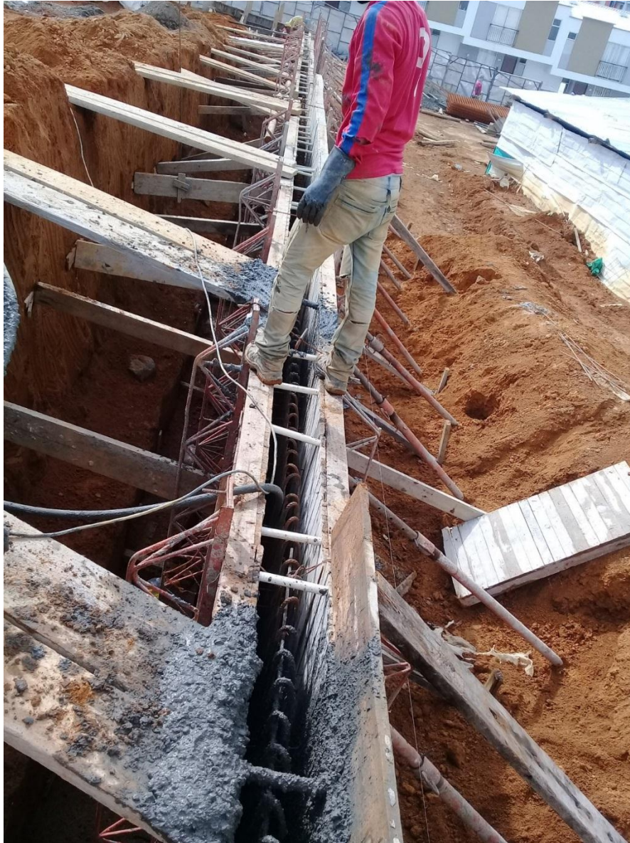
Figura N° 19i: Vista de muro de contención de la torre D.
