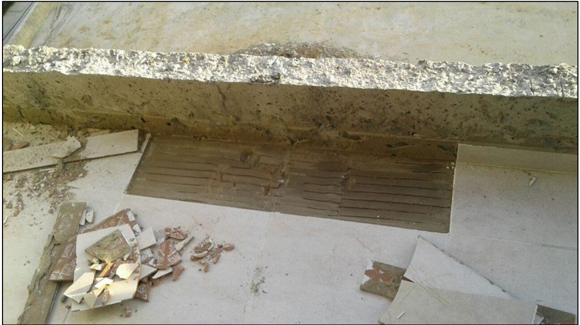
Figura N° 14b: Cambio de ficha en enchape de piso. Fuente: Propia
