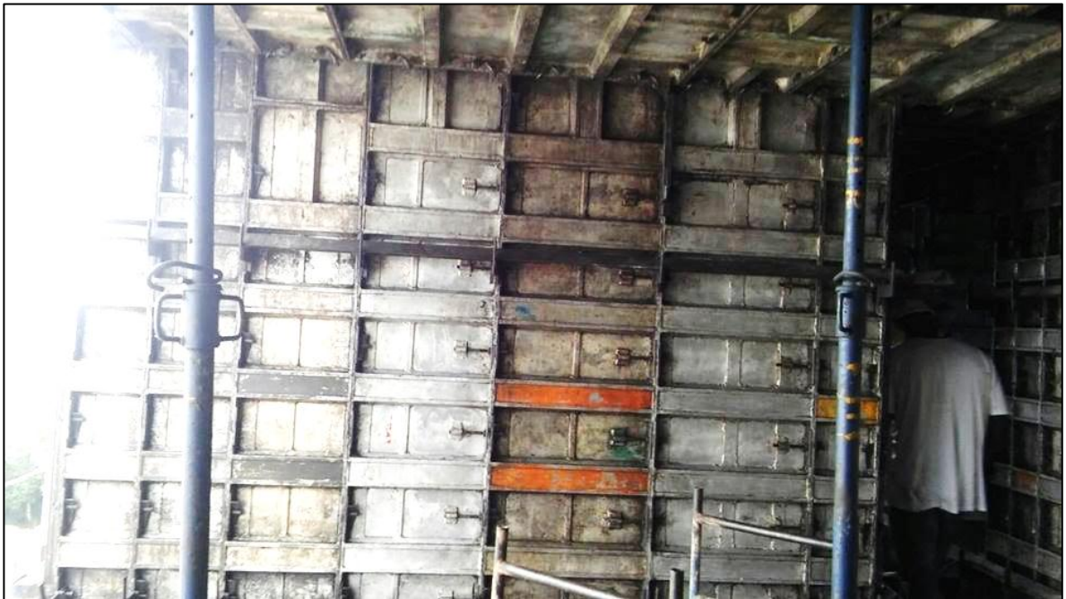
Figura N° 11d: Losa puntal. Fuente: Propia
