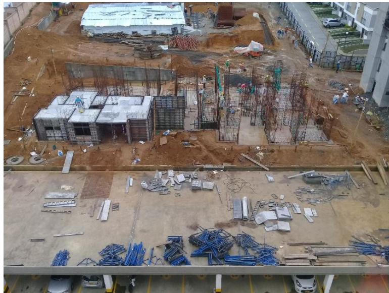
Figura N° 18b: Armado de formaleta apartamento 104 torre C.
