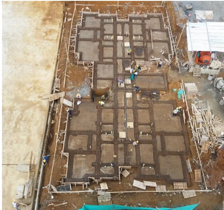
Figura N° 17d: Amarre de acero de vigas
