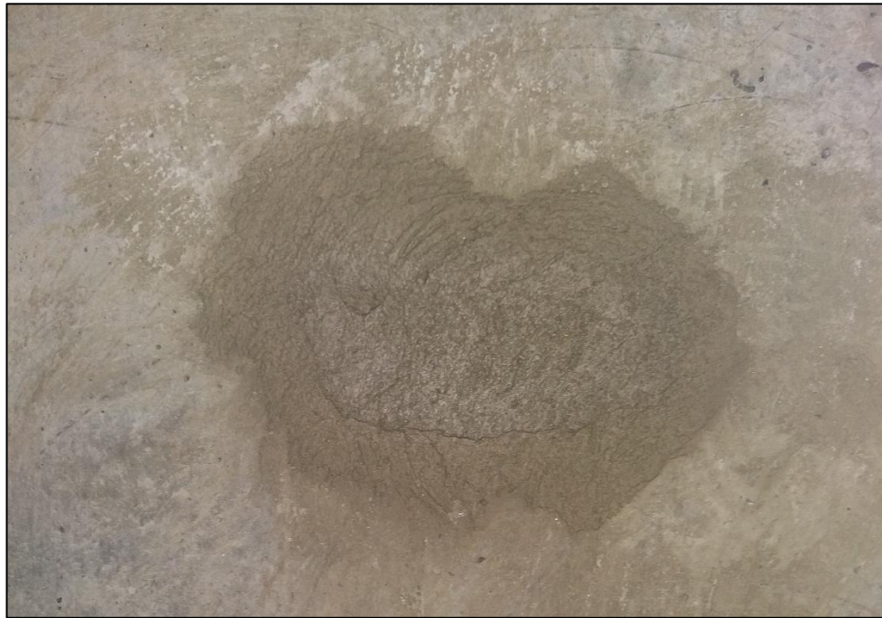
Figura N° 13b: Resane realizado con mortero estructural. Fuente: Propia
