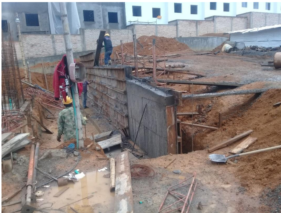
Figura N° 19e: Vista de muro de contención de la torre C.
