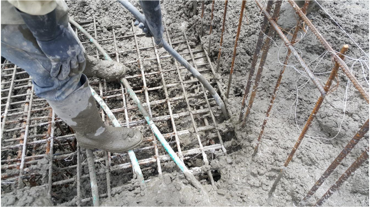
Figura N° 17h: Fundición de cimentación
