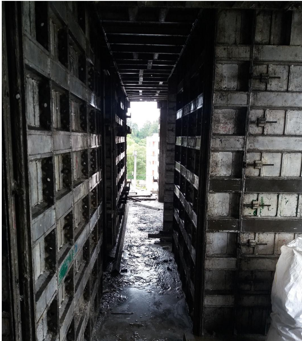
Figura N° 10m: Vista de armado completo de muros y losa. Fuente: Propia
