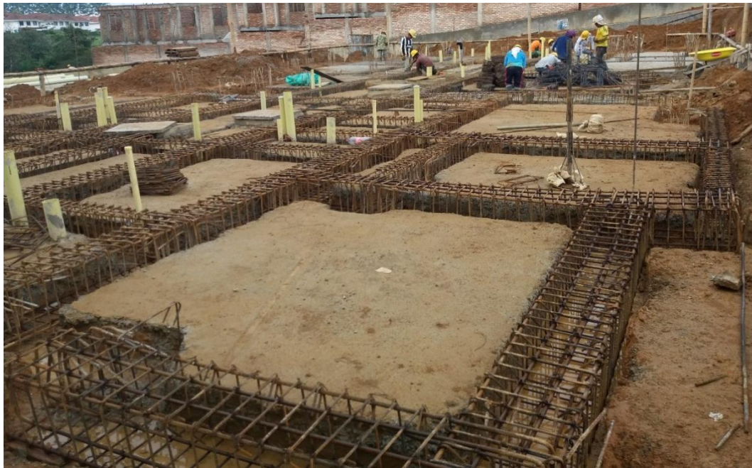
Figura N° 17c: Amarre de acero de vigas
