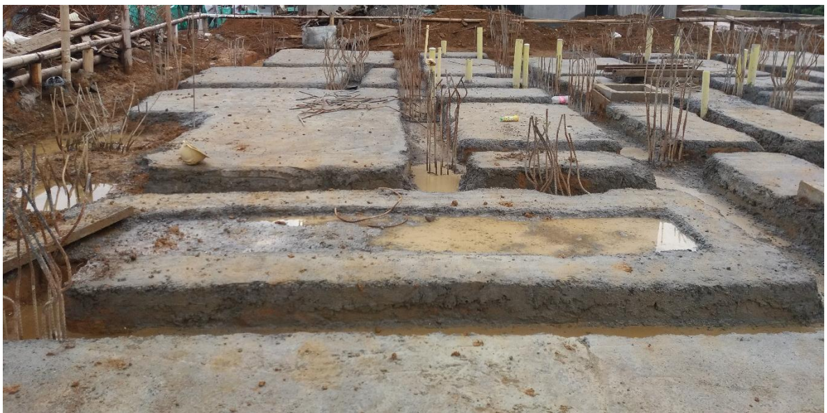
Figura N° 17a: Aplicación de solado de limpieza
