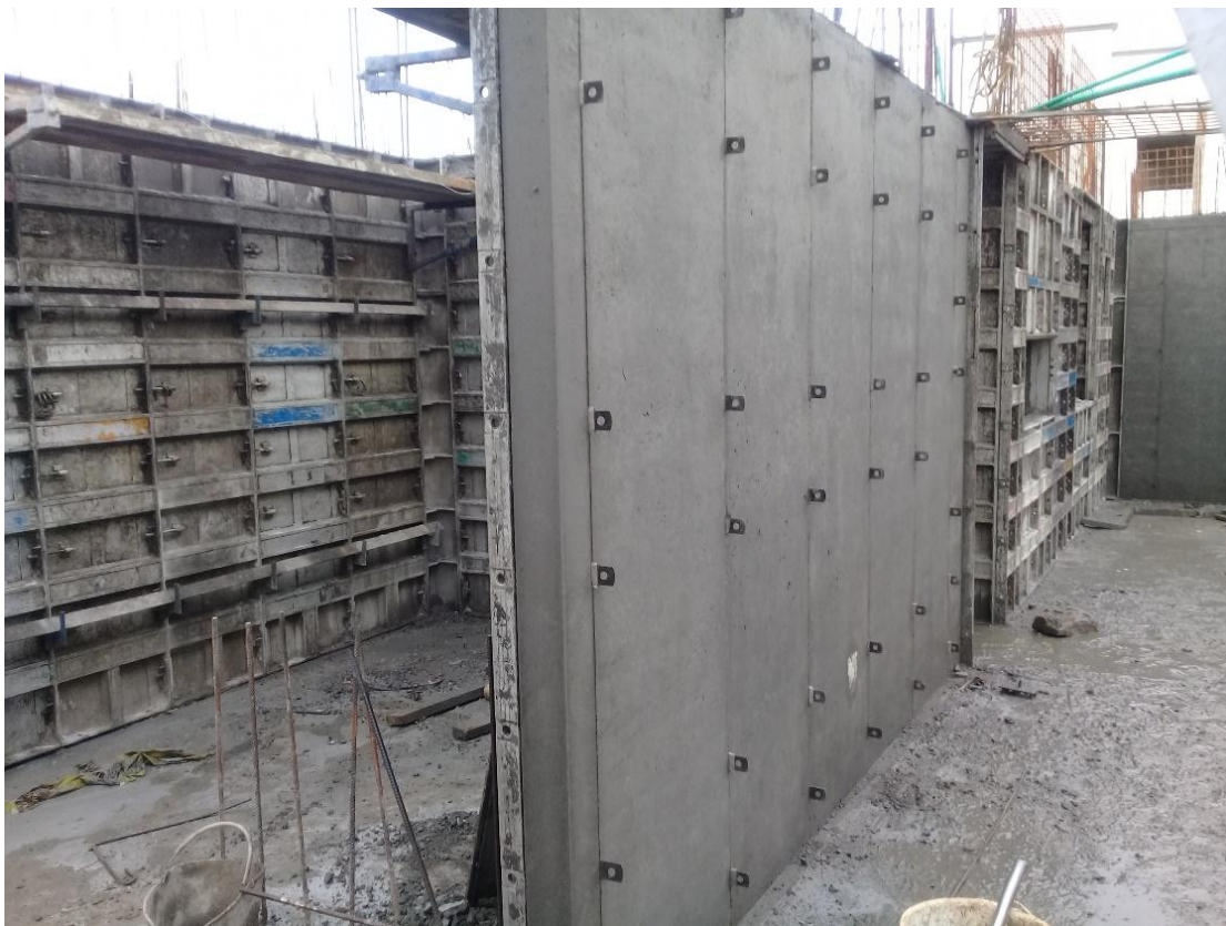
Figura N° 3: Vista de muro terminado con su respectiva corbata que garantiza el espesor Torre B. Fuente: Propia
