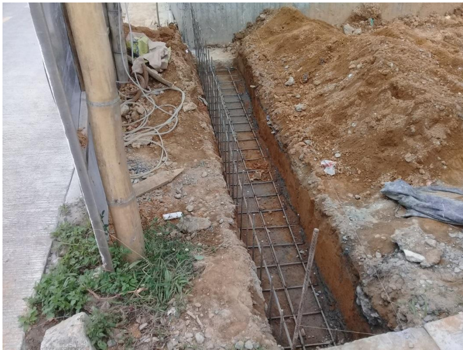
Figura N° 19c: Vista de muro de contención de la torre B.
