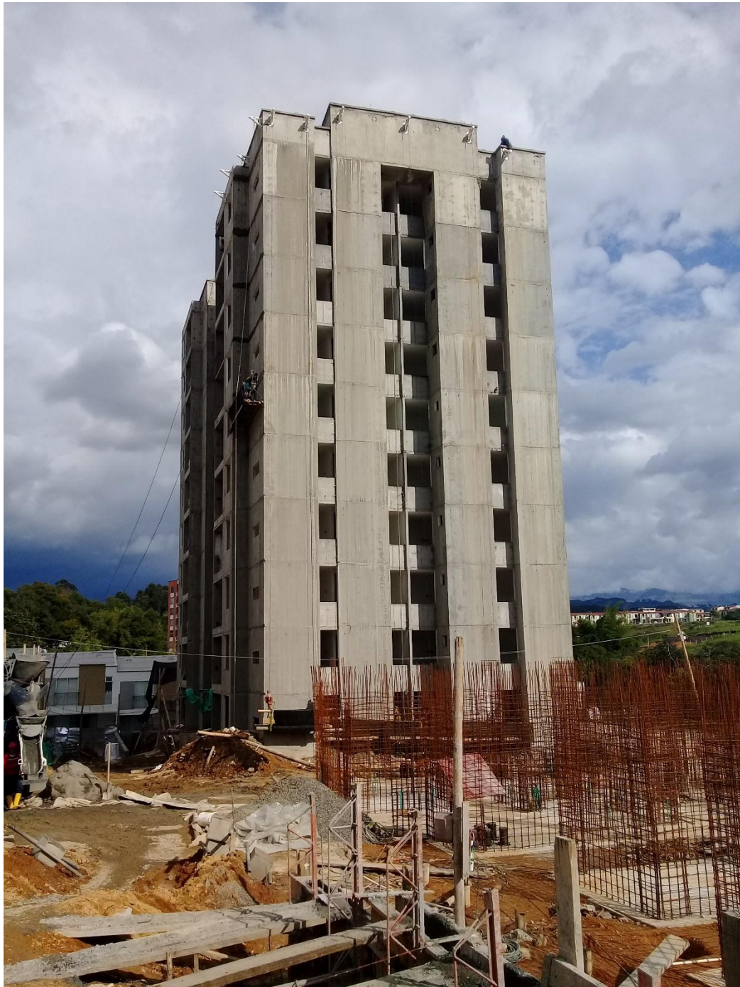
Figura N° 9b: vista de la torre B terminada obra negra. Fuente: Propia
