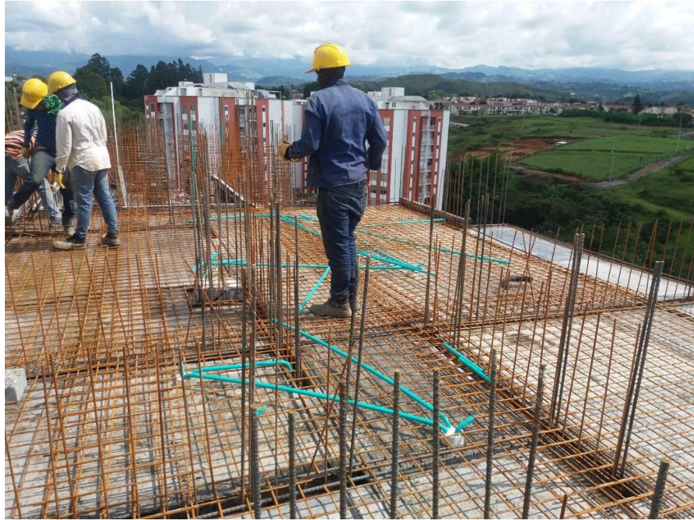
Figura N° 5: Disposición de aceros para la losa. Fuente: Propia
