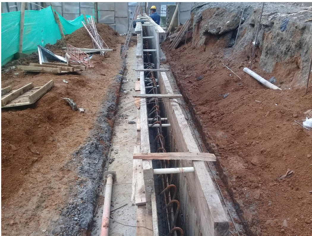
Figura N° 19a: Vista de muro de contención de la torre B.
