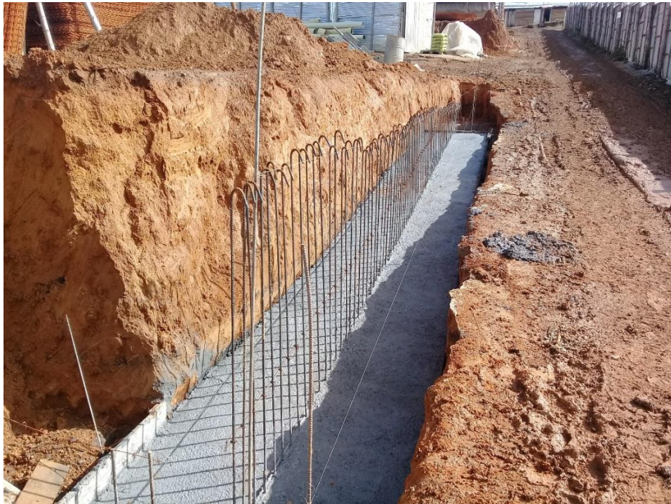
Figura N° 19f: Vista de muro de contención de la torre D.
