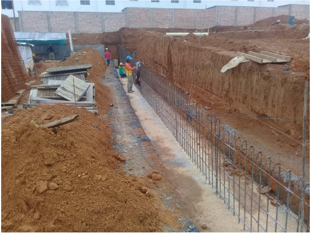
Figura N° 19h: Vista de muro de contención de la torre D.
