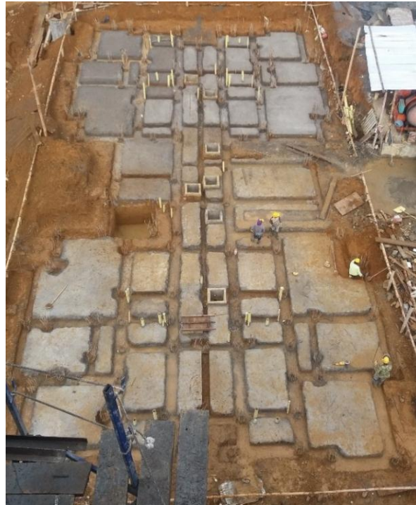
Figura N° 17a: Aplicación de solado de limpieza
