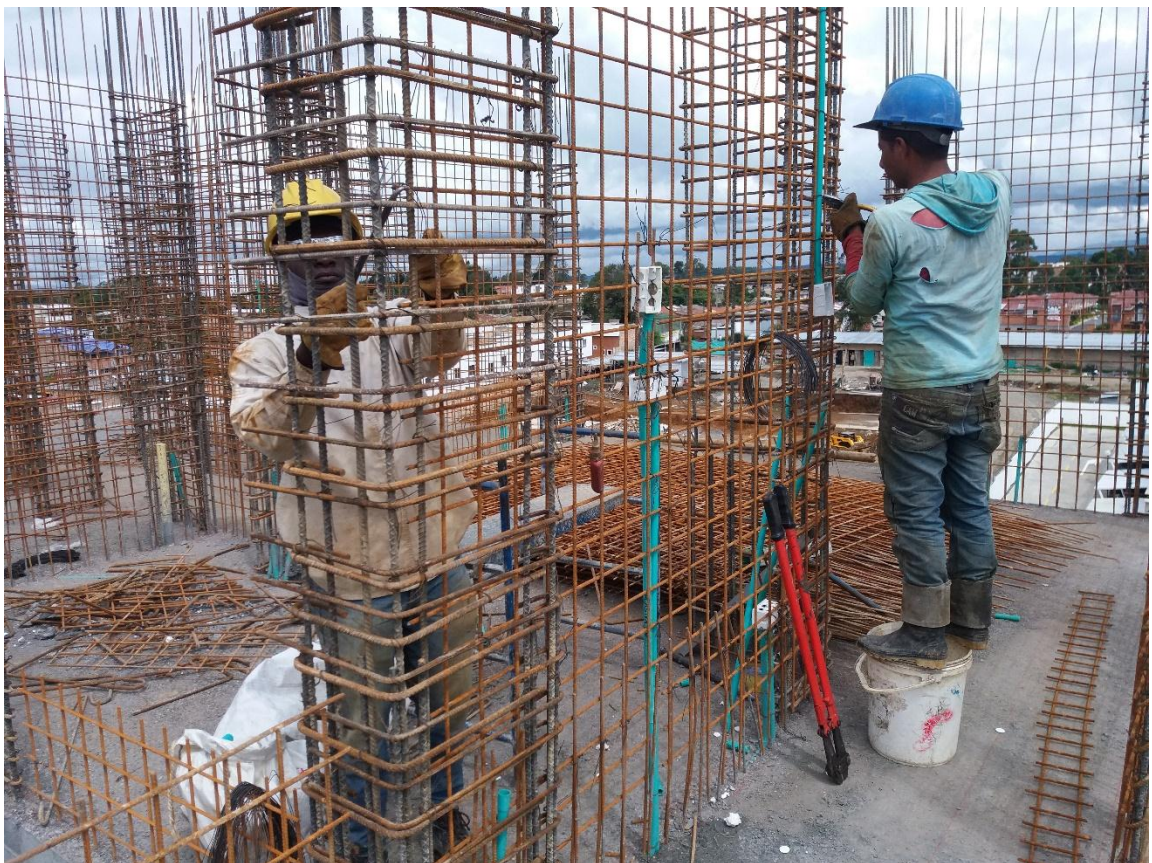
Figura N° 4: Vista de amarre del acero de un apartamento Torre B. Fuente: Propia
