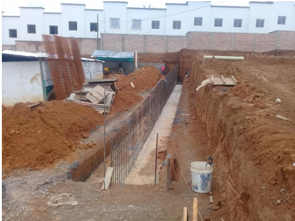
Figura N° 19g: Vista de muro de contención de la torre D.
