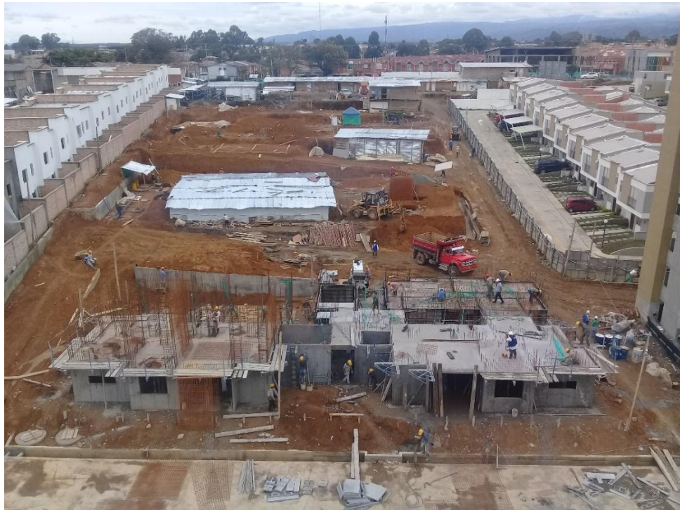
Figura N° 18c: vista de fundición del piso 1 torre C.
