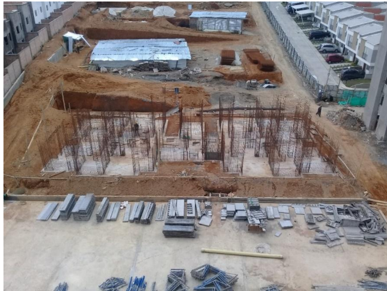
Figura N° 18a: Armado de aceros del primer piso torre C.
