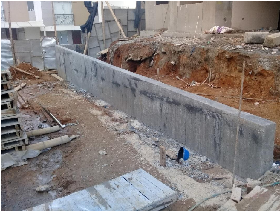
Figura N° 19b: Vista de muro de contención de la torre B.
