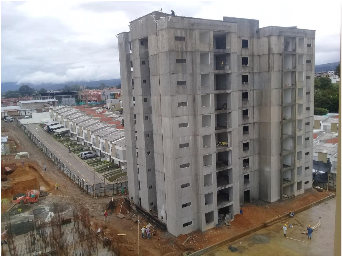
Figura N° 9a: vista de la torre B terminada obra negra. Fuente: Propia
