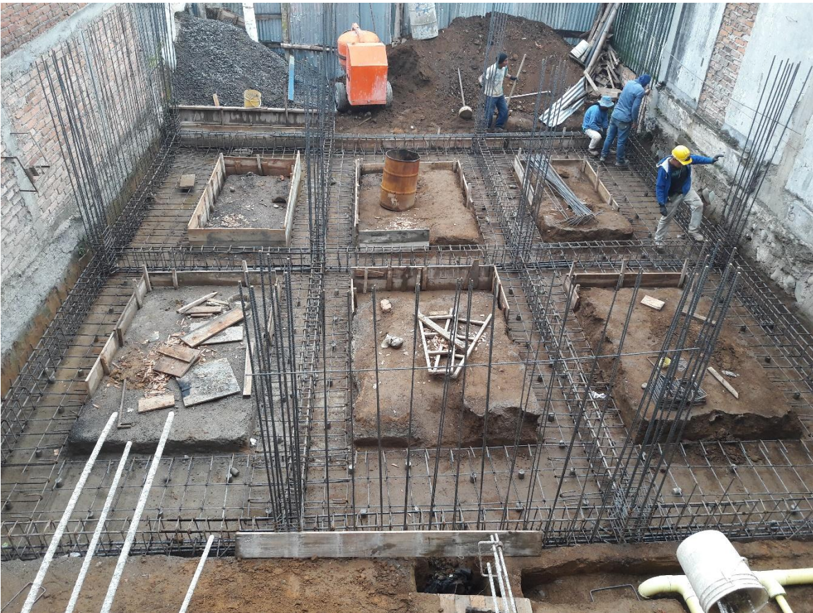
Figura XVII Formaleta de Cimentación. Fuente: Propia
