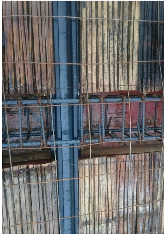
Figura XXXIII Detalle de Unión Perfil – Viga Fuente: Propia
