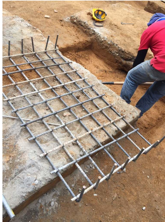
Figura VII Armado de refuerzo de Viga de apoyo de la cimentación. Fuente: Propia
