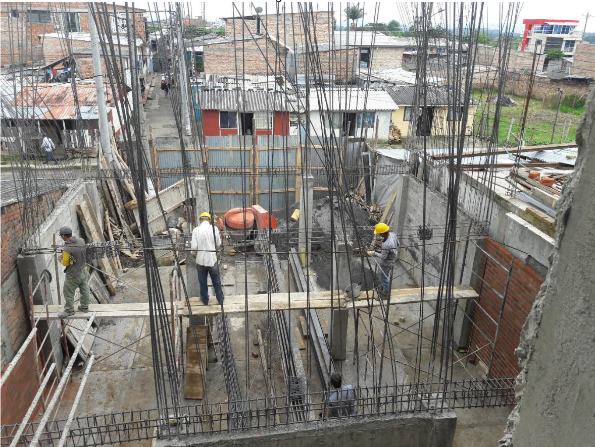
Figura XXIX Armado de acero de refuerzo en vigas. Fuente: Propia
