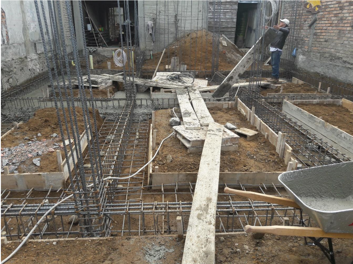
Figura XVIII Fundición de la Cimentación. Fuente: Propia
