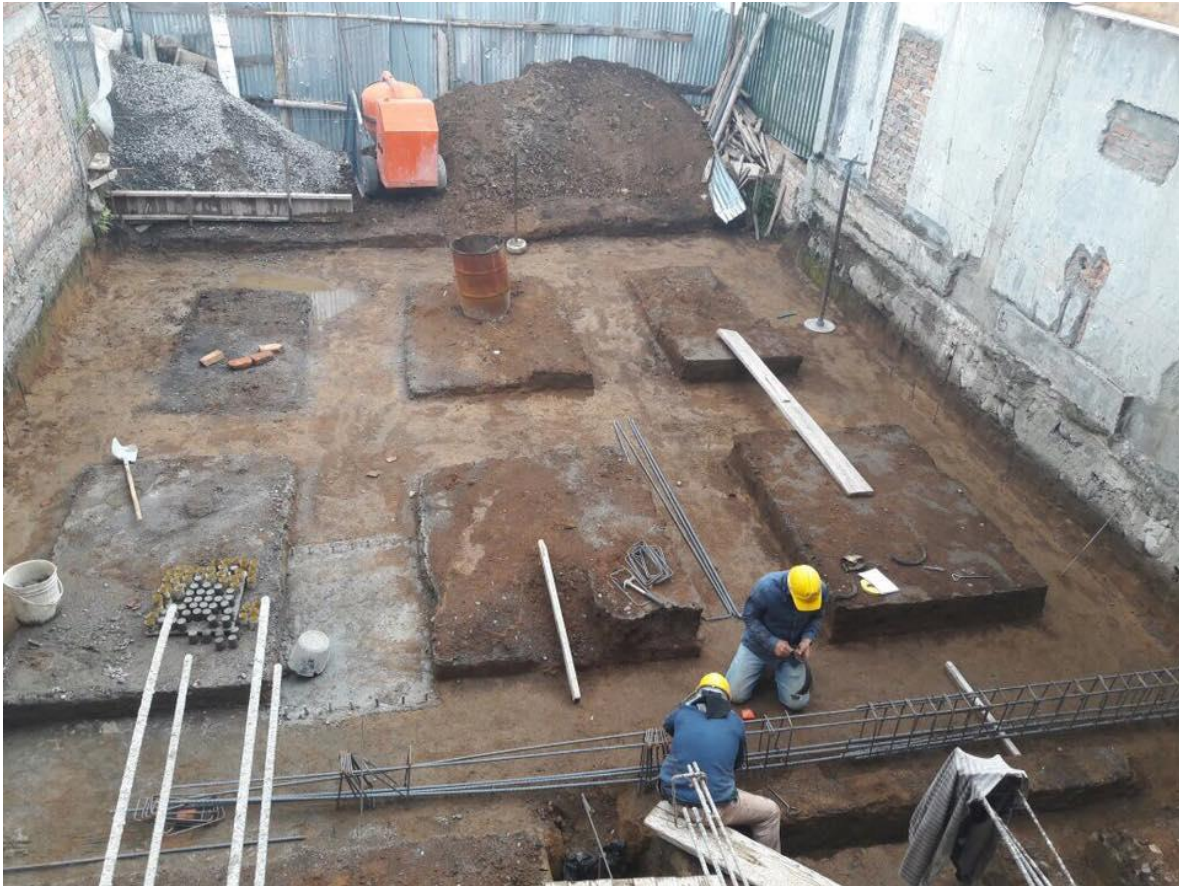
Figura IV Movimiento de Tierras. Fuente: Grupo ABVA S.A.S
