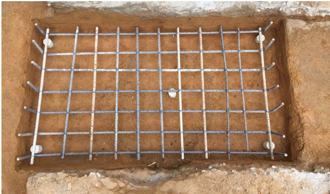
Figura VIII Armado de acero de Viga de apoyo de la cimentación. Fuente: Propia
