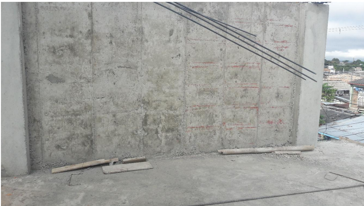
Figura XXVI Curado del concreto de pantallas. Fuente: Propia
