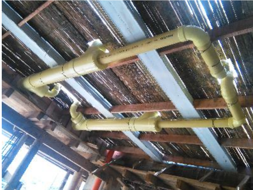
Figura XXXV Ubicación de tubería sanitaria.
