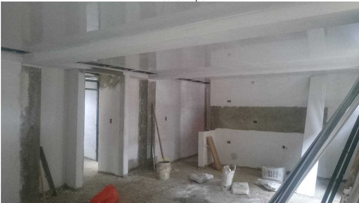
Figura XXXVII Detalle de obra blanca. Fuente: Propia
