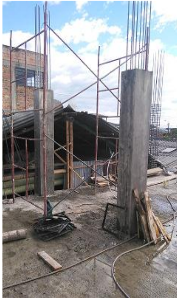
Figura XXI Columnas en proceso de curado Fuente: Ing. Diana Bravo.
