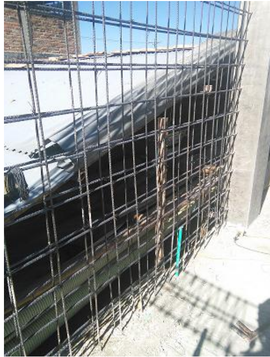
Figura XXIII Distribución de aceros en las pantallas. Fuente: Ing. Diana Bravo.
