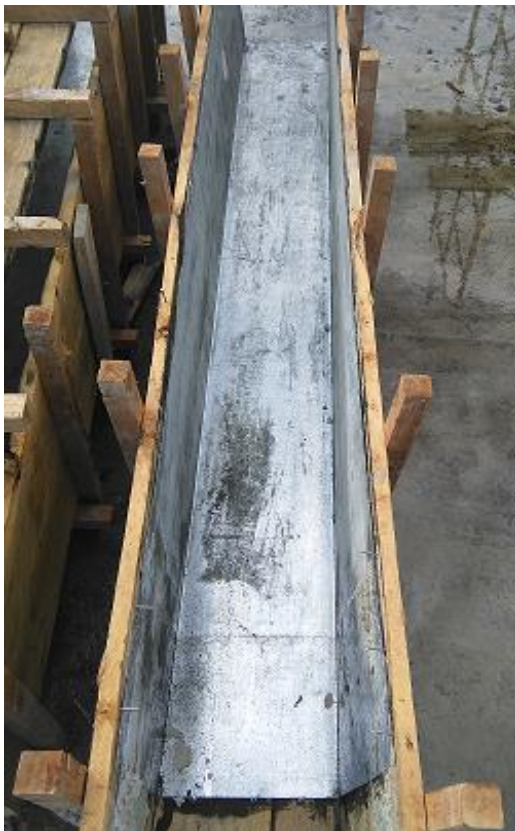
Figura XX Formaleta de las columnas. Fuente: Ing. Diana Bravo.
