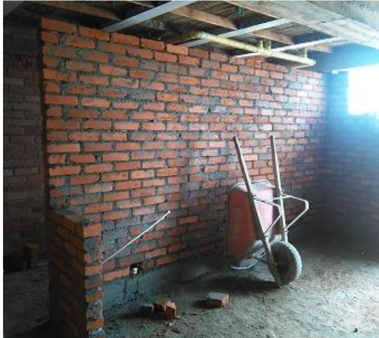
Figura XXXIV Muro divisorio Fuente: Ing. Diana Bravo.
