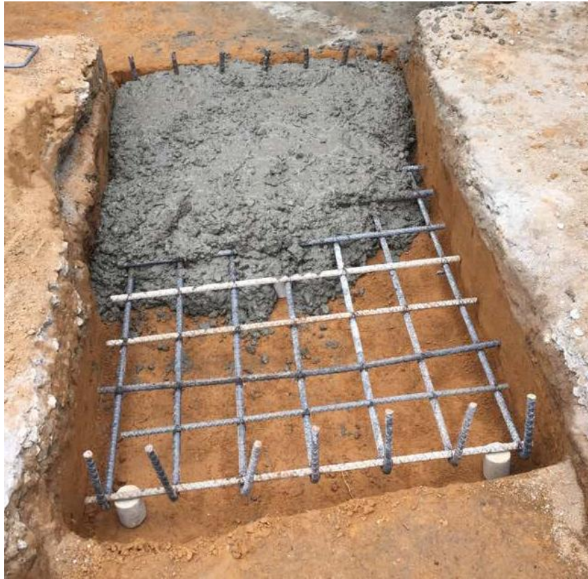
Figura IX Fundición de Viga de apoyo de cimentación. Fuente: Propia
