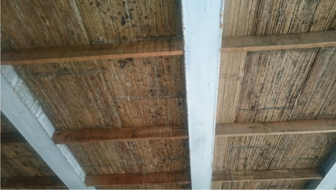
Figura XXX Vista inferior de la losa de entrepiso. Fuente: Propia
