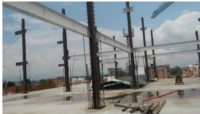
Figura N° 18. Conexión de vigas a columnas
