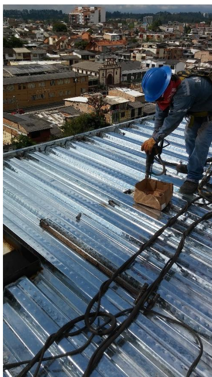
Figura N° 23. Instalación de studs
