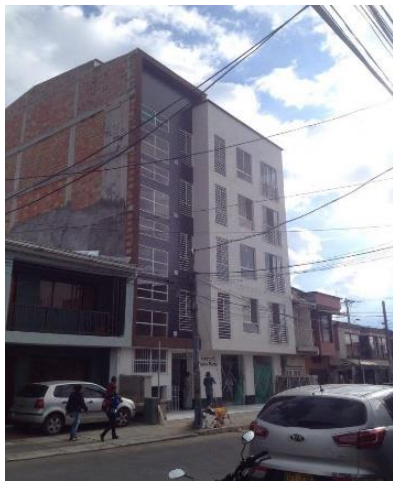
Fuente: Fotografía tomada en obra. (18 de mayo de 2017)
