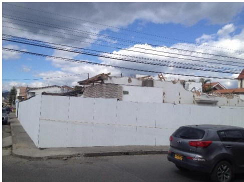
Imagen: 54. Obra 13, Cerramiento de obra en demolición.
