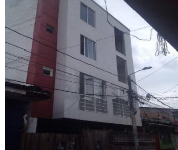
Fuente: Fotografía tomada en obra. (12 de mayo de 2017)
