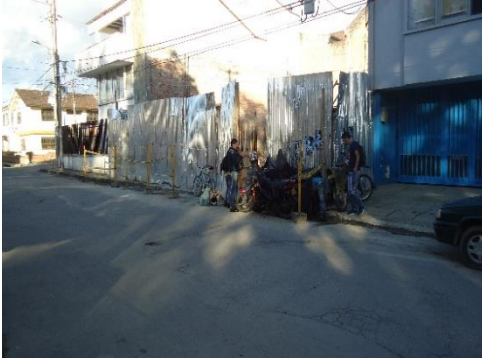
Imagen: 44. Obra 11, Cerramiento del lote.
