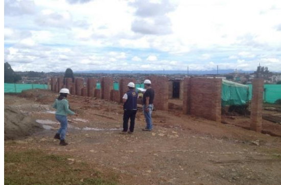
Imagen: 60. Obra 14, Muro de cerramiento.
