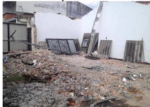
Imagen: 55. Obra 13, Demolición en proceso.
