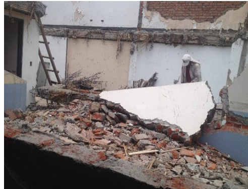
Fuente: Fotografía tomada en obra. (28 de abril de 2017)
