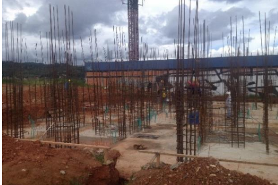
Imagen: 59. Obra 14, Losa y levantamiento de aceros de columna.
