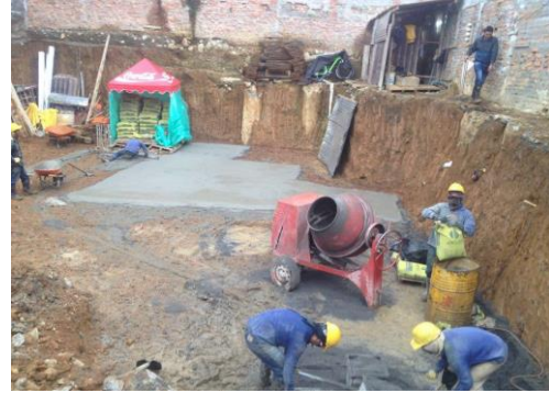
Imagen: 45. Obra 11, Excavación en el terreno.
