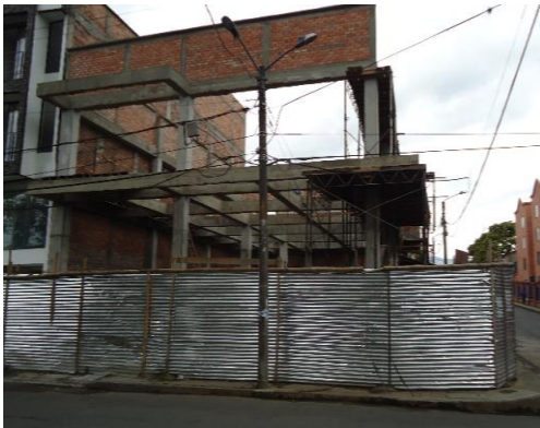
Imagen: 40. Obra 10, construcción vista desde la carrera 8.
