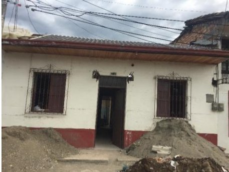
Fuente: Fotografía tomada en obra. (13 de julio de 2017)
