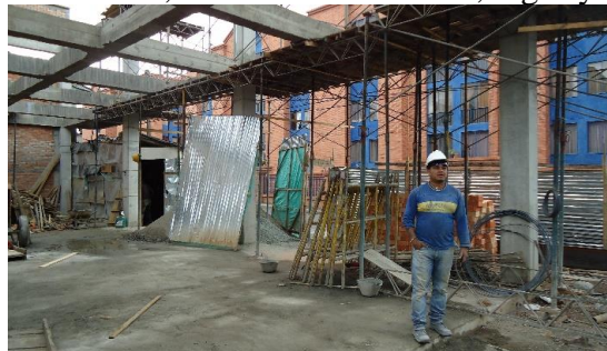
Imagen: 42. Obra10, Losa de cimentación, vigas y columnas.
