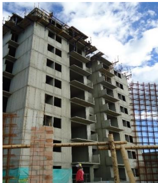
Imagen: 63. Obra 14, Fachada frontal
