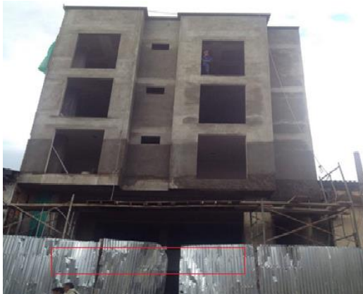
Fuente: Fotografía tomada en obra.. (26 de Abril de 2017).
