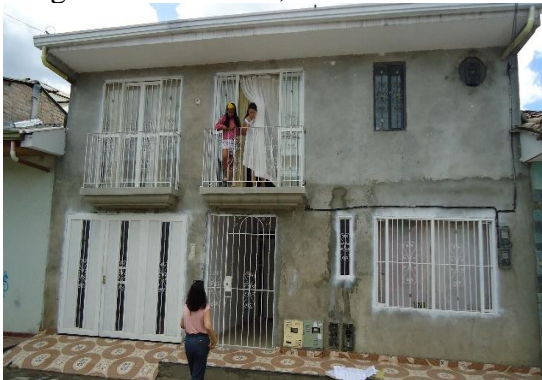
Fuente: Fotografía tomada en obra. (13 de julio de 2017)
