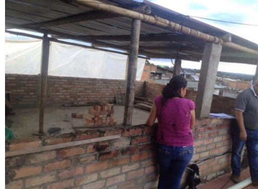
Fuente: Fotografía tomada en obra. (17 de mayo de 2017)
