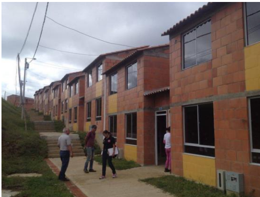
Fuente: Fotografía tomada en obra. (16 de junio de 2017)
