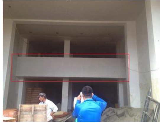
Fuente: Fotografía tomada en obra. (26 de Abril de 2017).
