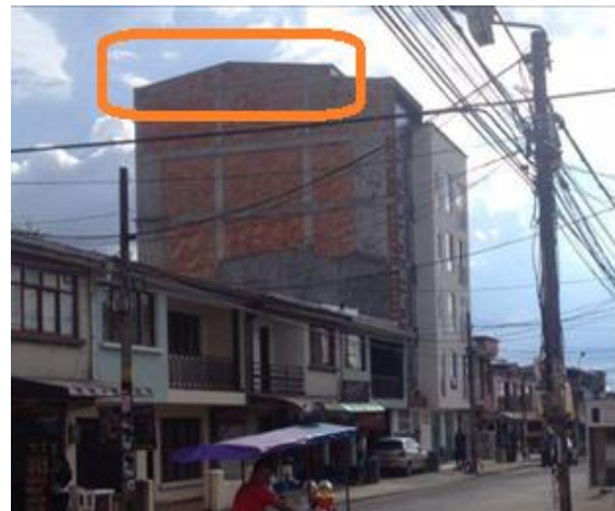
Fuente: Fotografía tomada en obra. (18 de mayo de 2017)
