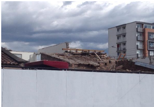
Imagen: 56. Obra 13, Demolición del techo.
