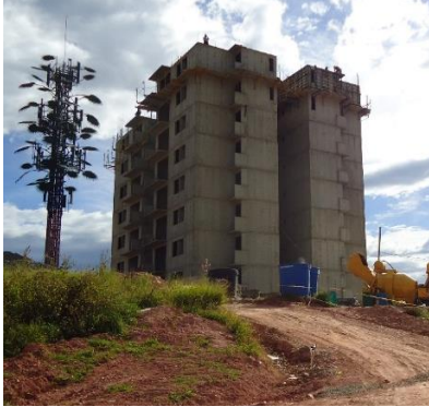
Imagen: 61. Obra 14, Fachada lateral.
