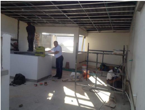
Fuente: Fotografía tomada en obra. (20 de mayo de 2017)
