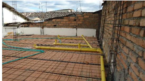
Fuente: Fotografía tomada en obra. (13 de julio de 2017)
