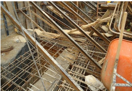
Imagen: 46. Obra 11, Cimentaciones.
