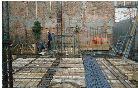
Imagen: 49. Obra 11, Levantamiento de aceros.
