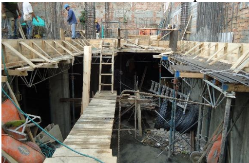
Imagen: 48. Obra 11, Semisótano y encofrado de losa de entrepiso.
