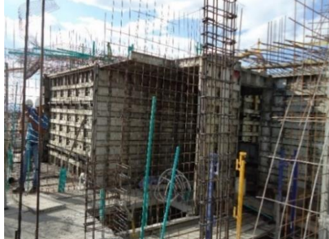
Fuente: Fotografía tomada en obra. (8 de agosto de 2017)
