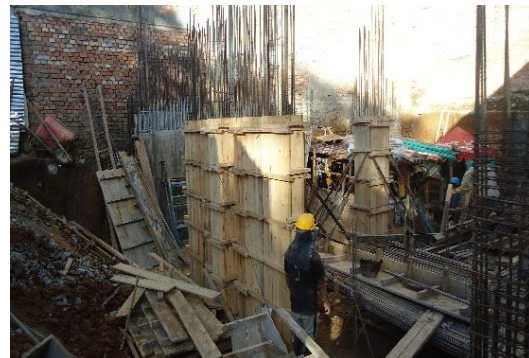
Imagen: 47. Obra 11, Columnas del semisótano.
