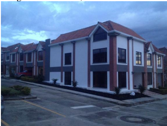
Fuente: Fotografía tomada en obra. (19 de mayo de 2017)
