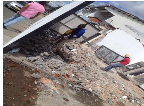
Imagen: 57. Obra 13, Obreros trabajando en los predios.
