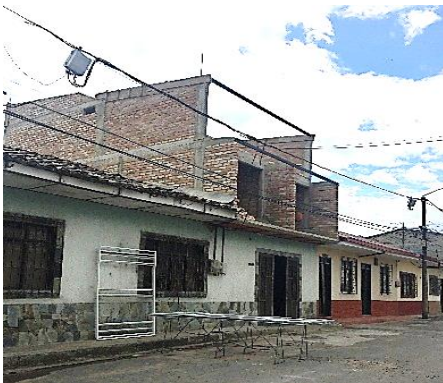
Fuente: Fotografía tomada en obra. (19 de julio de 2017)
