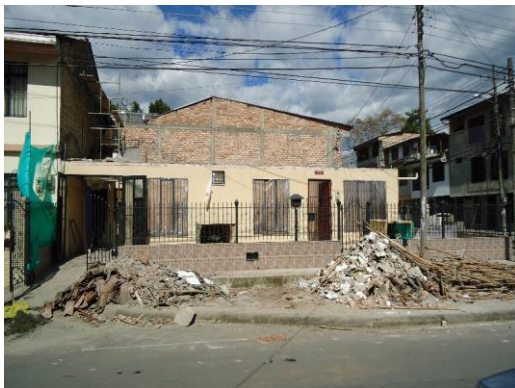
Fuente: Fotografía tomada en obra. (14 de julio de 2017)
