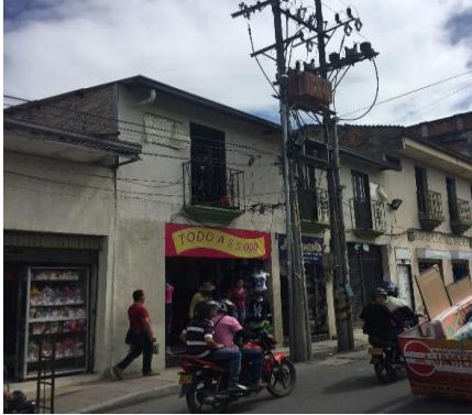
Fuente: Fotografía tomada en obra. (7 de julio de 2017)
