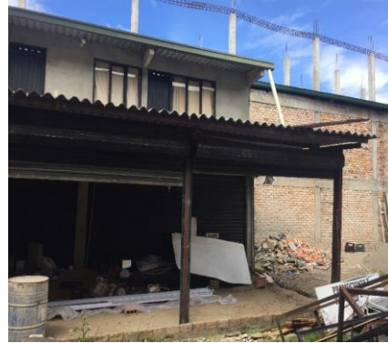
Fuente: Fotografía tomada en obra. (7 de julio de 2017)
