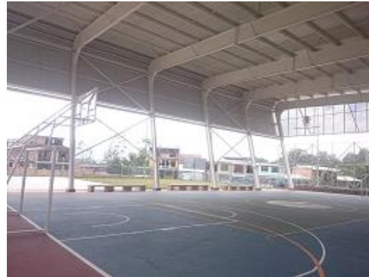
Figura 102 Cancha con recubrimiento tipo plexiflor /fuente: Propia.
