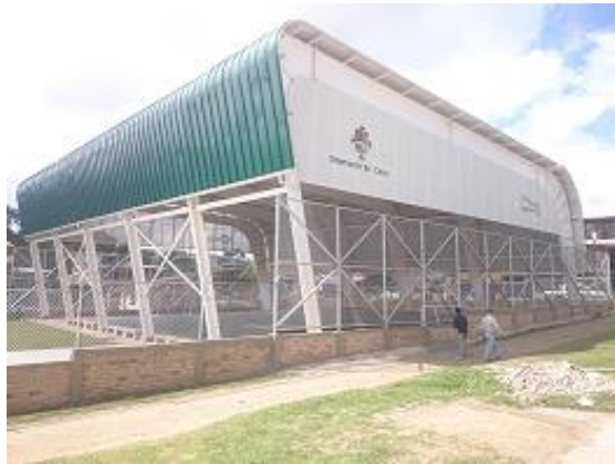
Figura 101 Estructura de cubierta /fuente: Propia.
