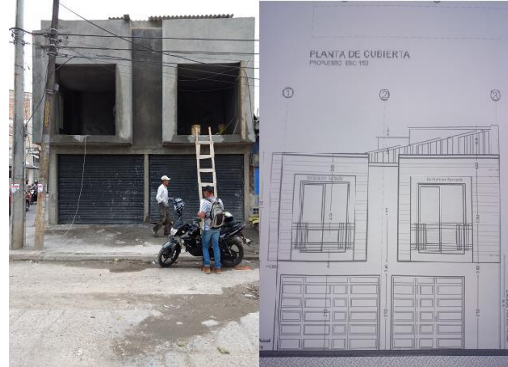
Figura 3 Fachada (calle 4) /fuente: Propia.
