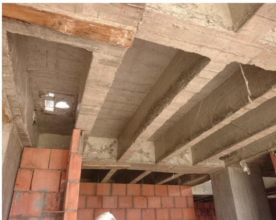
Figura 43 Muros no estructurales (divisórios) /fuente: Propia.
