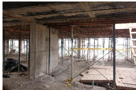
Figura 44 Apuntalamiento de losa aligerada de cubierta /fuente: Propia.
