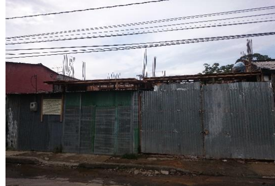
Figura 9 Cerramiento de obra /fuente: Propia.
