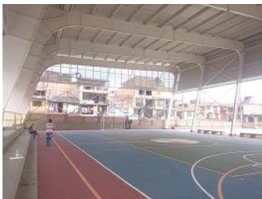
Figura 103 Canales de aguas lluvias /fuente: Propia.
