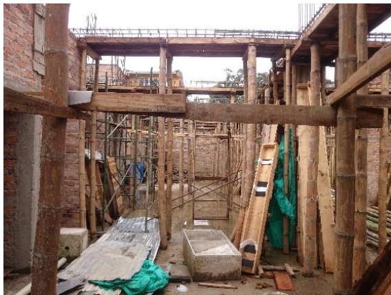
Figura 10 Amarre de acero vigas de entepiso /fuente: Propia.
