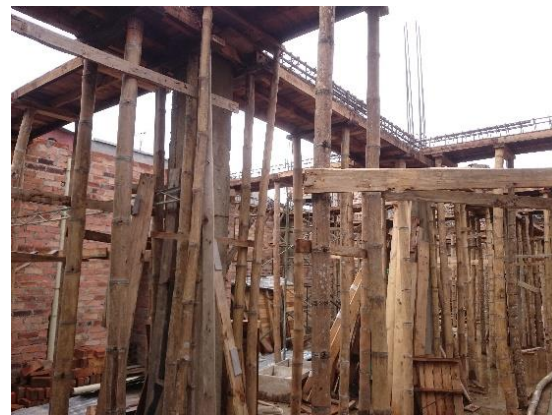
Figura 11 Apuntalamiento y encofrado de vigas /fuente: Propia.
