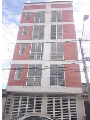
Figura 85 Fachada (carrera 3) con posibles muros en voladizo /fuente: Propia.
