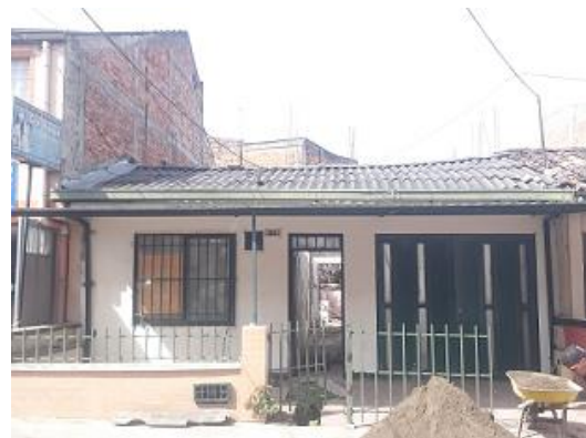
Figura 58 Fachada (carrera 8ª) 7fuente: Propia.
