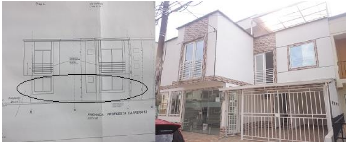
Figura 63 Fachada con modificación (carrera 12) /fuente: Propia.
