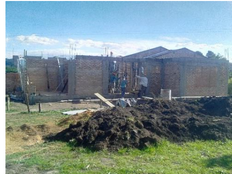
Figura 82 Movimiento de tierras y vivienda en mampostería confinada /fuente: Propia.
