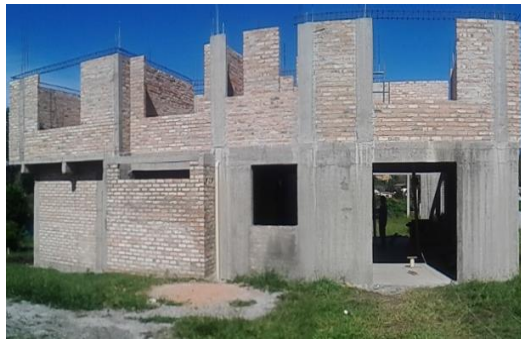
Figura 81 Vivienda en mampostería confinada /fuente: Propia.
