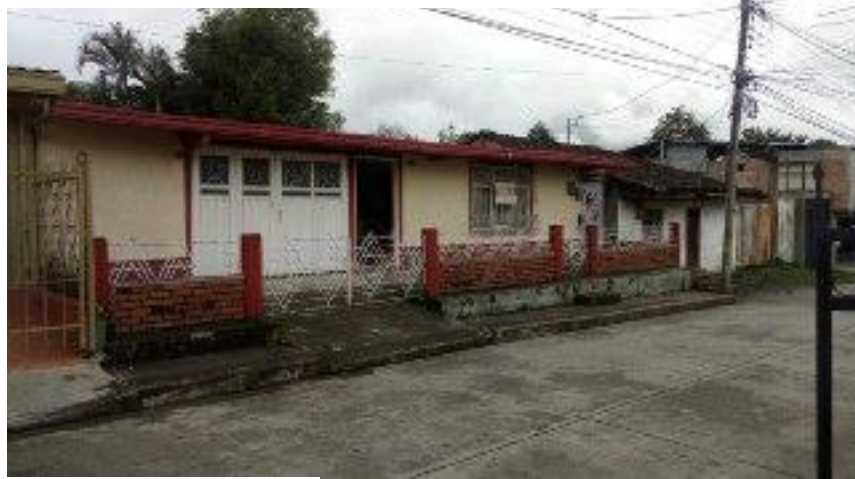
FIGURA N° 1 FACHADA CASA EXISTENTE
