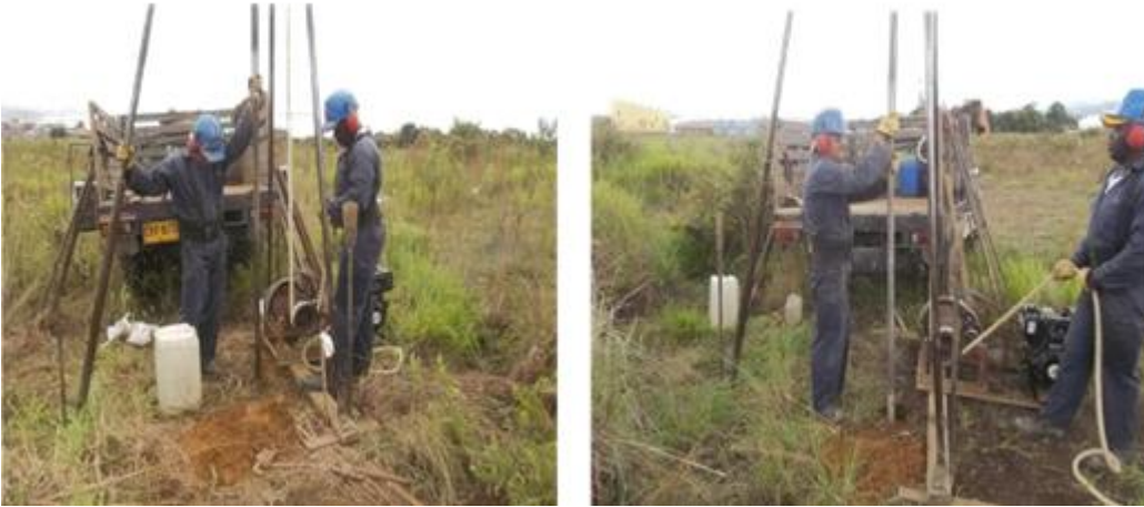
Fuente: Archivo fotográfico pasante de ingeniería.
