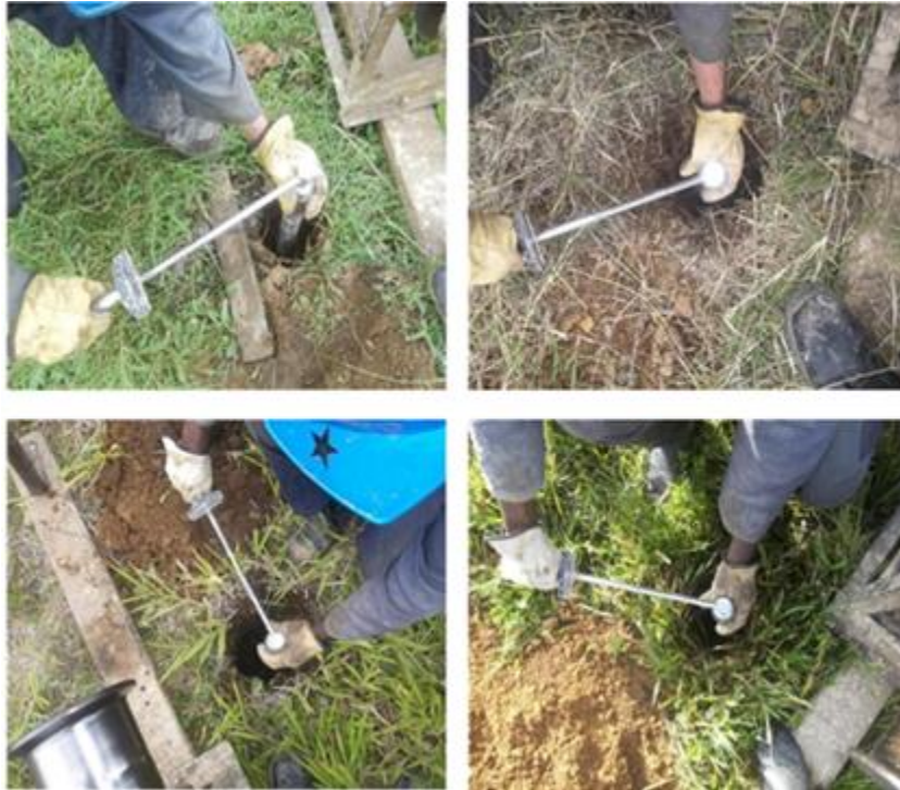
Fuente: Archivo fotográfico pasante de ingeniería
