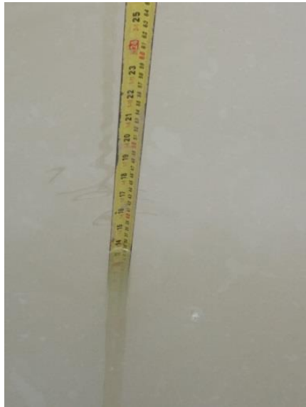
Fuente: Registro fotográfico de la obra.
