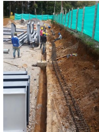
Foto 27: Control de elementos de seguridad dentro de la obra.
