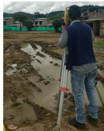
Fuente: Registro fotográfico de la obra.
