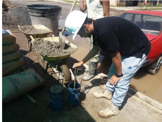
Foto 19: Toma de muestra de cilindros para la calidad del concreto.
