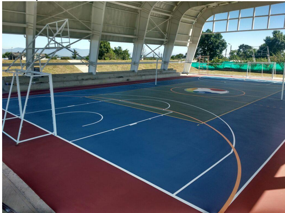
Foto 70: Cancha múltiple terminada.
