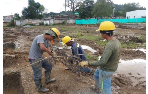
Foto 10: Control de elementos de seguridad dentro de la obra.
