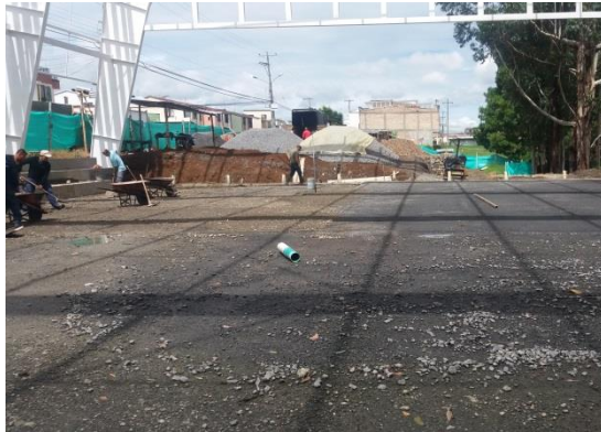
Foto 41: Nivelación y compactación de la base de la cancha múltiple.
