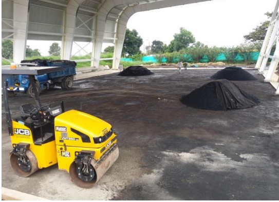
Foto 61: Mezcla asfáltica y compactador.
