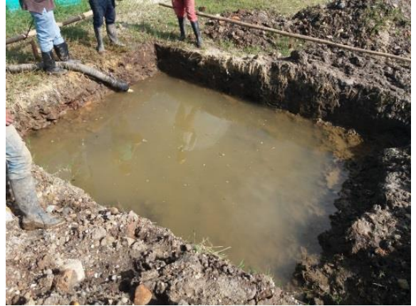
Fuente: Registro fotográfico de la obra.
