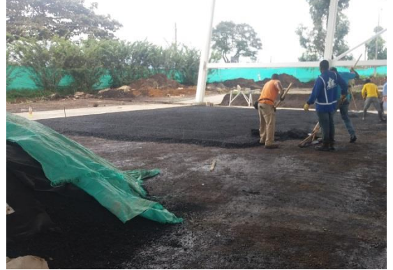
Foto 62: Riego de la mezcla asfáltica.
