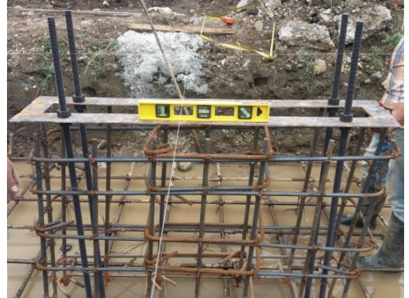
Foto 16: Adecuada nivelación de la platina guía.
