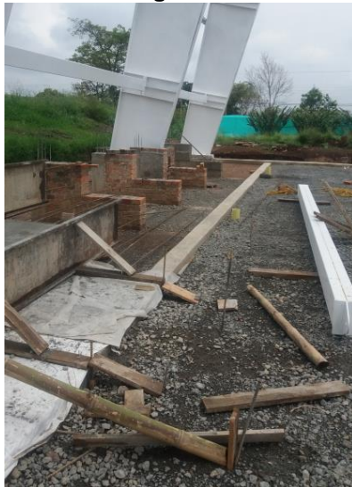
Fuente: Registro fotográfico de la obra.
