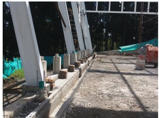
Fuente: Registro fotográfico de la obra.
