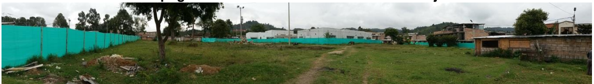
Fuente: Registro fotográfico de la obra.
