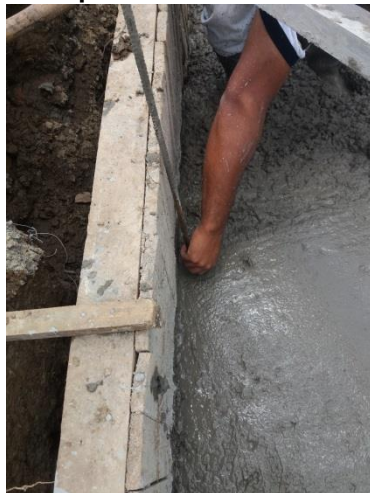
Foto 22: Fundición y toma de espesor de una de las zapatas.
