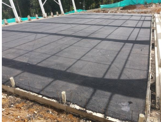
Foto 43: Carpeta asfáltica cancha múltiple.
