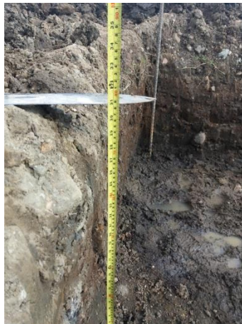
Foto 17: Control de excavaciones realizadas.
