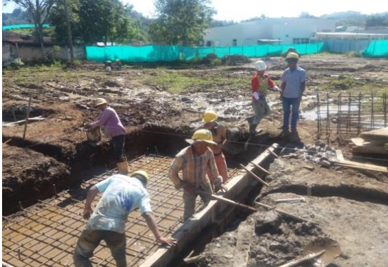
Foto 9: Control de elementos de seguridad dentro de la obra.
