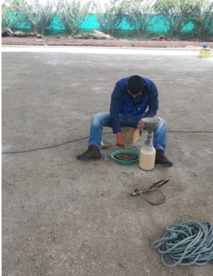
Fuente: Registro fotográfico de la obra.
