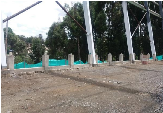
Fuente: Registro fotográfico de la obra.
