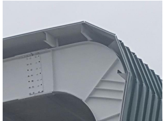
Foto 56: Cubierta vista de perfil.
