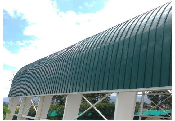
Fuente: Registro fotográfico de la obra.
