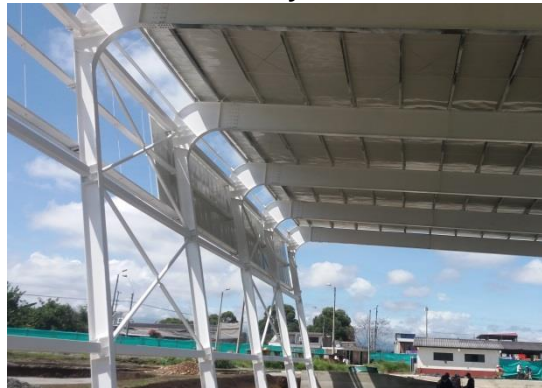
Foto 54: Instalación de la cubierta y los canales de desagüe.
