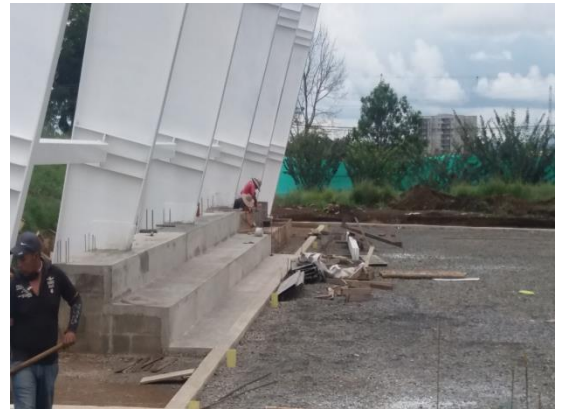
Fuente: Registro fotográfico de la obra.
