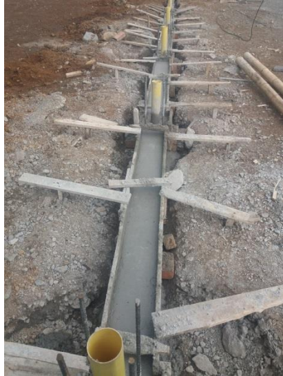
Fuente: Registro fotográfico de la obra.
