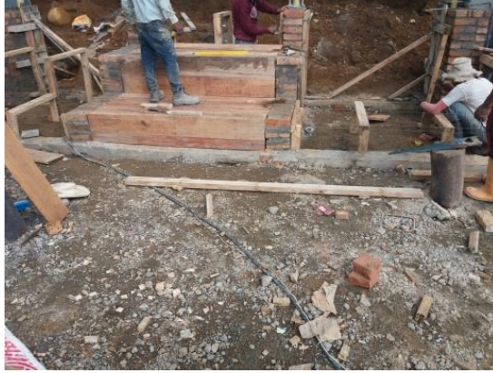
Fuente: Registro fotográfico de la obra.
