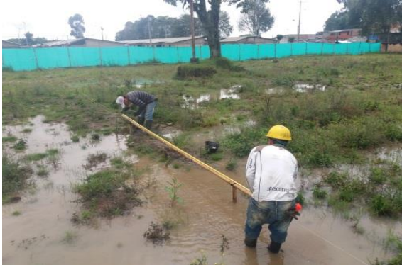
Fuente: Registro fotográfico de la obra.
