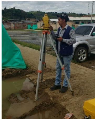
Fuente: Registro fotográfico de la obra.
