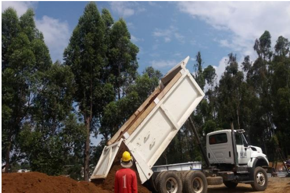
Foto 3: Tierra para relleno plazoleta de acceso.
