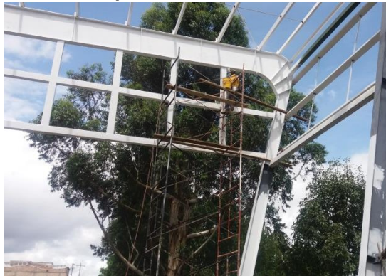
Fuente: Registro fotográfico de la obra.
