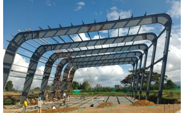
Fuente: Registro fotográfico de la obra.
