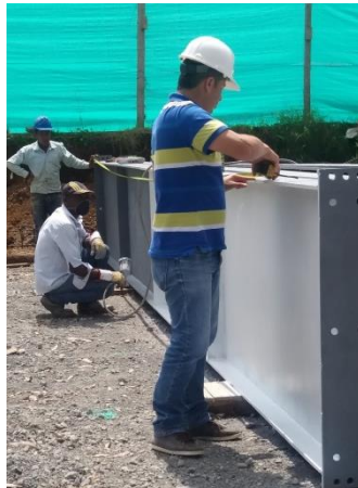
Foto 26: Control de medidas de las partes de la estructura metálica.
