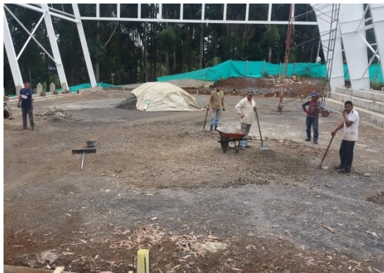
Fuente: Registro fotográfico de la obra.
