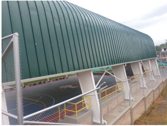
Fuente: Registro fotográfico de la obra.
