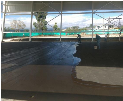
Fuente: Registro fotográfico de la obra.
