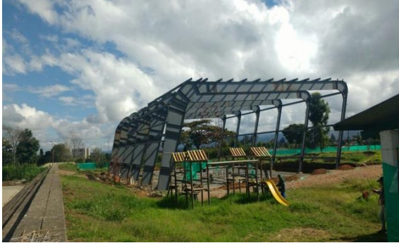
Fuente: Registro fotográfico de la obra.
