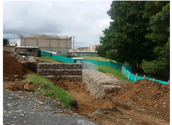
Foto 4: Muro en gaviones.
