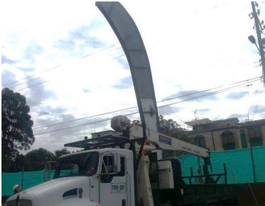
Fuente: Registro fotográfico de la obra.
