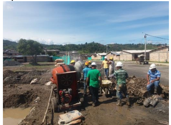
Foto 18: Cuadrilla para la fundición de las zapatas.
