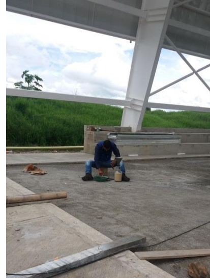
Fuente: Registro fotográfico de la obra.
