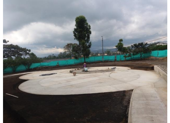
Fuente: Registro fotográfico de la obra.
