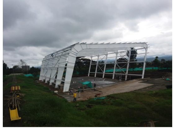
Fuente: Registro fotográfico de la obra.
