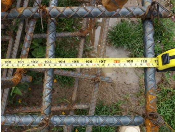
Foto 15: Control de cantidad de acero utilizado.
