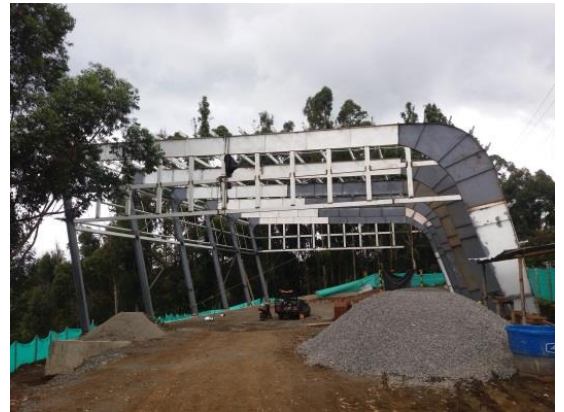
Fuente: Registro fotográfico de la obra.
