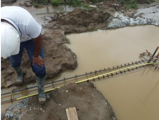
Fuente: Registro fotográfico de la obra.
