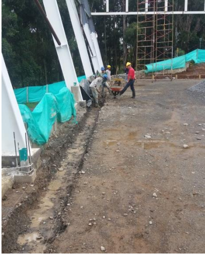
Fuente: Registro fotográfico de la obra.
