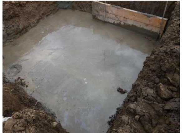
Fuente: Registro fotográfico de la obra.
