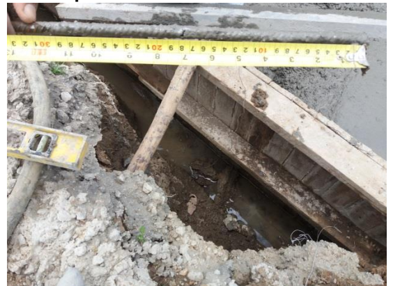
Foto 23: Toma de medida del espesor de la zapata en fundición.
