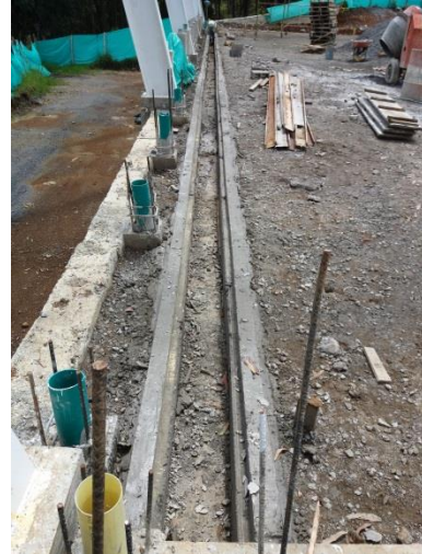
Fuente: Registro fotográfico de la obra.
