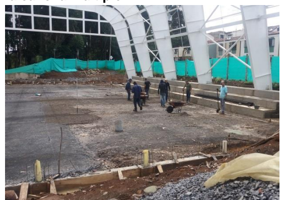
Fuente: Registro fotográfico de la obra.
