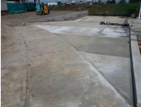
Fuente: Registro fotográfico de la obra.
