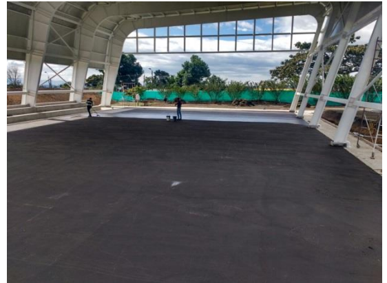
Fuente: Registro fotográfico de la obra.
