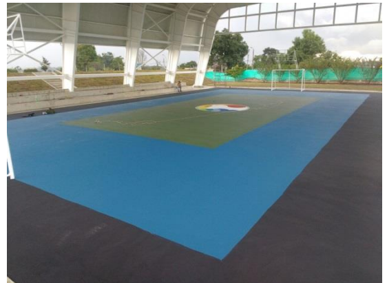
Fuente: Registro fotográfico de la obra.
