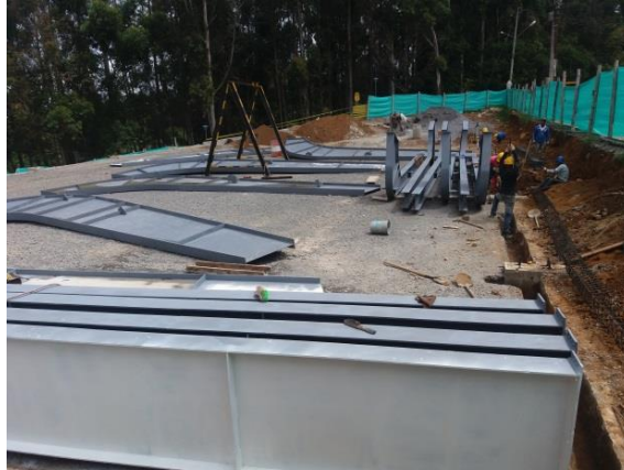
Fuente: Registro fotográfico de la obra.
