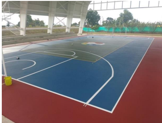
Foto 69: Pintura delimitación de las canchas.
