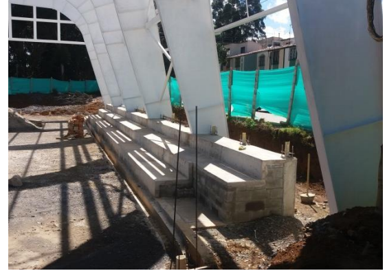
Fuente: Registro fotográfico de la obra.
