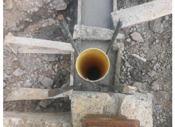
Fuente: Registro fotográfico de la obra.
