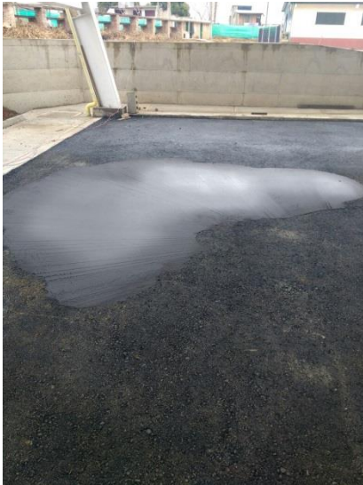
Fuente: Registro fotográfico de la obra.
