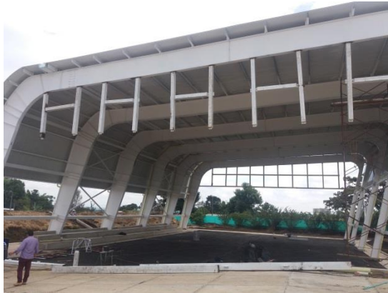
Foto 63: Soldadura en la estructura metálica.
