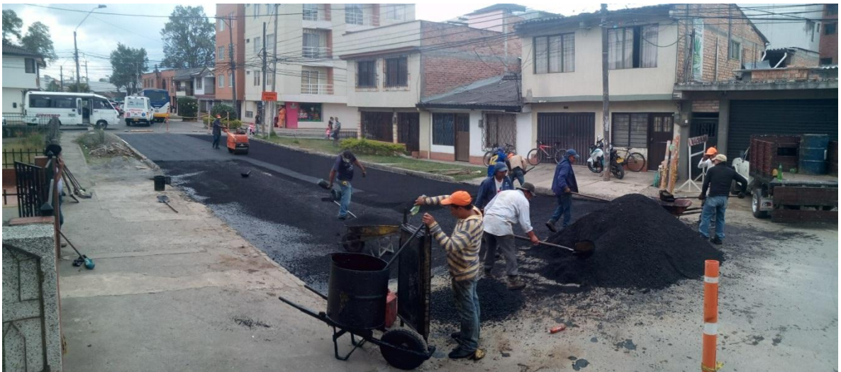
Figura 15. Rehabilitación y/o mantenimiento de la malla vial en la comuna 3 - Carrera 7 entre Calle 18AN Y Calle 19N
