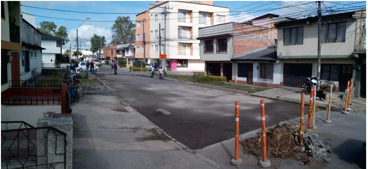
Figura 12. Rehabilitación y/o mantenimiento de la malla vial en la comuna 3 - Carrera 7 entre Calle 18AN Y Calle 19N
