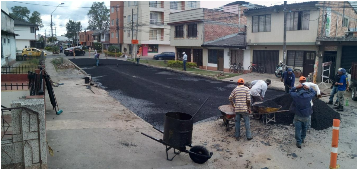
Figura 14. Rehabilitación y/o mantenimiento de la malla vial en la comuna 3 - Carrera 7 entre Calle 18AN Y Calle 19N
