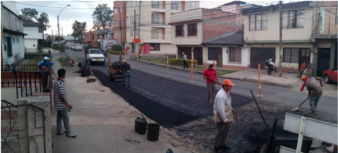
Figura 16. Rehabilitación y/o mantenimiento de la malla vial en la comuna 3 - Carrera 7 entre Calle 18AN Y Calle 19N
