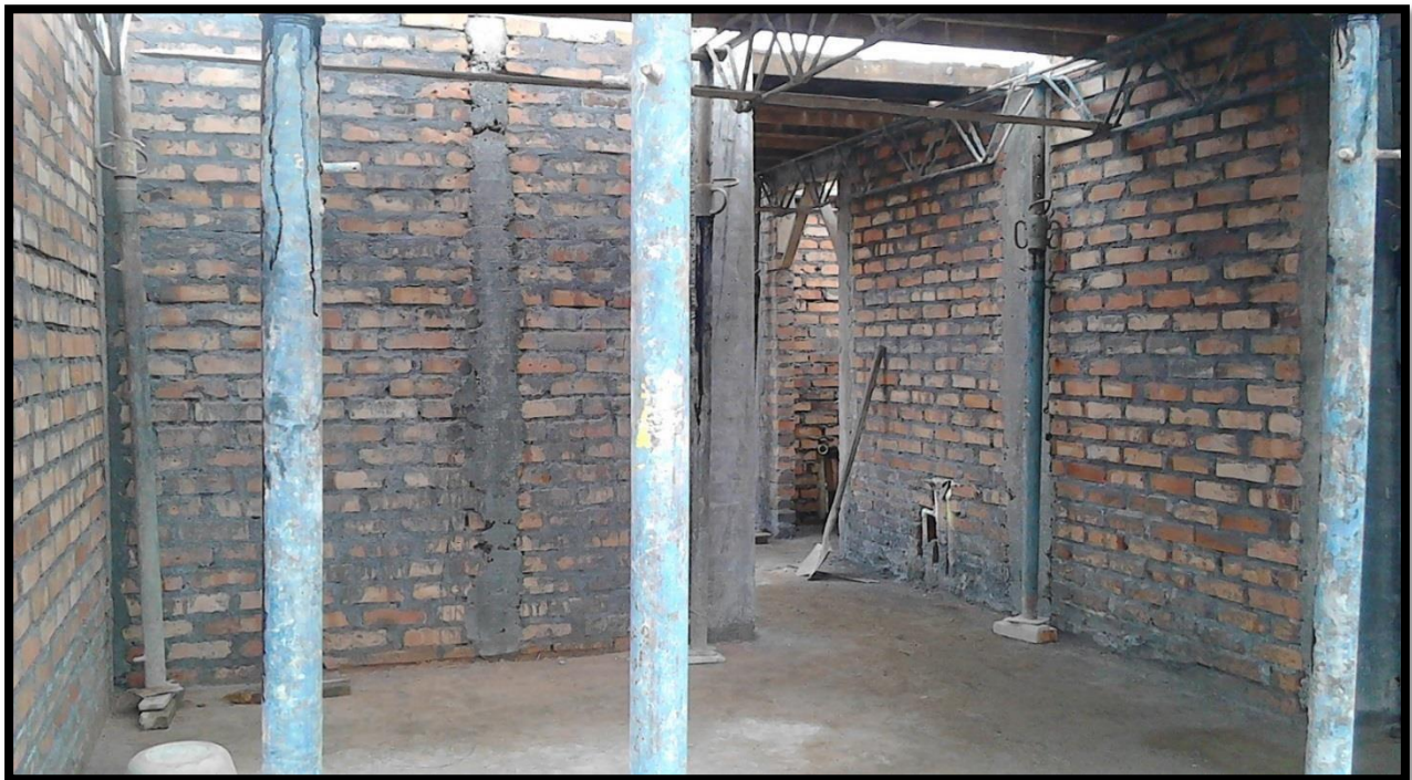
Foto 7. Muro en mampostería confinada “ladrillo común”, imagen de archivo de obra.
