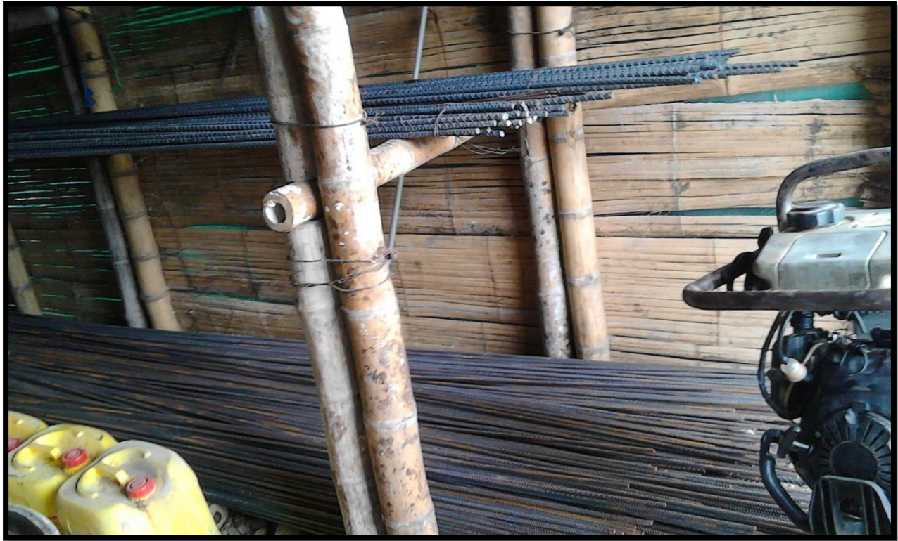
Foto 14. Almacenamiento del acero, casa zona social. imagen de archivo de obra
