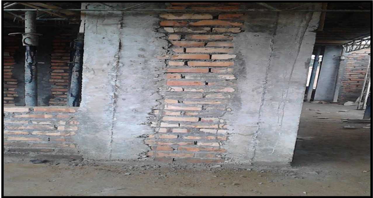
Foto 5. Columnetas, imagen de archivo de obra.
