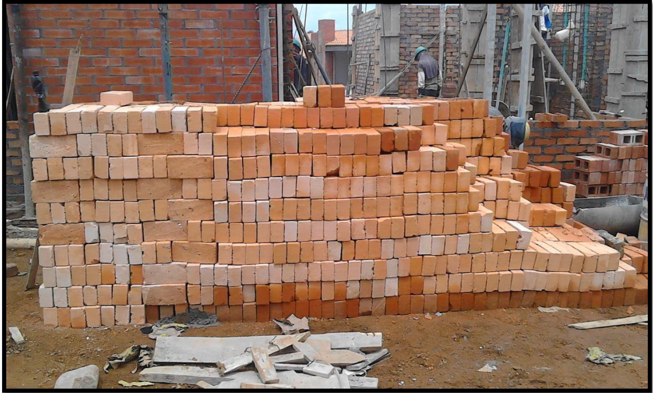
Foto 15. Almacenamiento de ladrillo. imagen de archivo de obra
