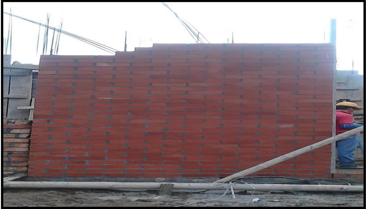
Foto 8. Muro en mampostería estructural “ladrillo limpio”, imagen de archivo de obra.
