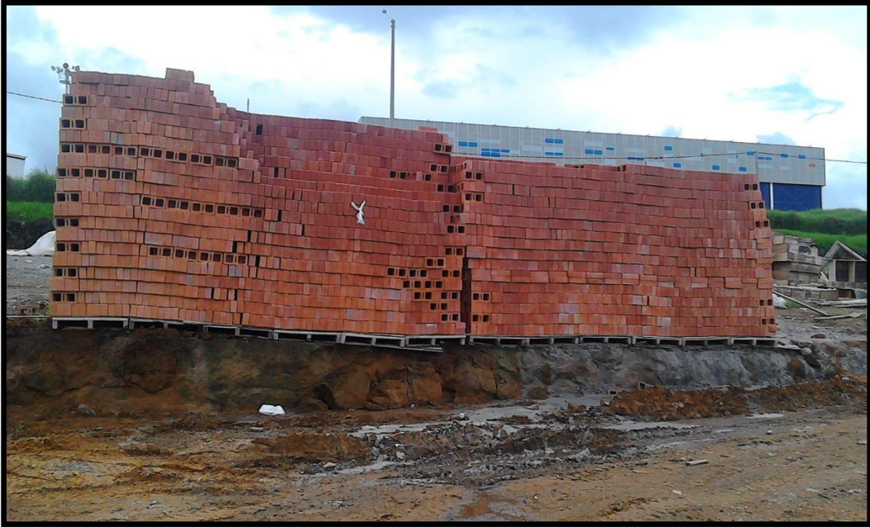
Foto 16. Almacenamiento ladrillo estructural. imagen de archivo de obra
