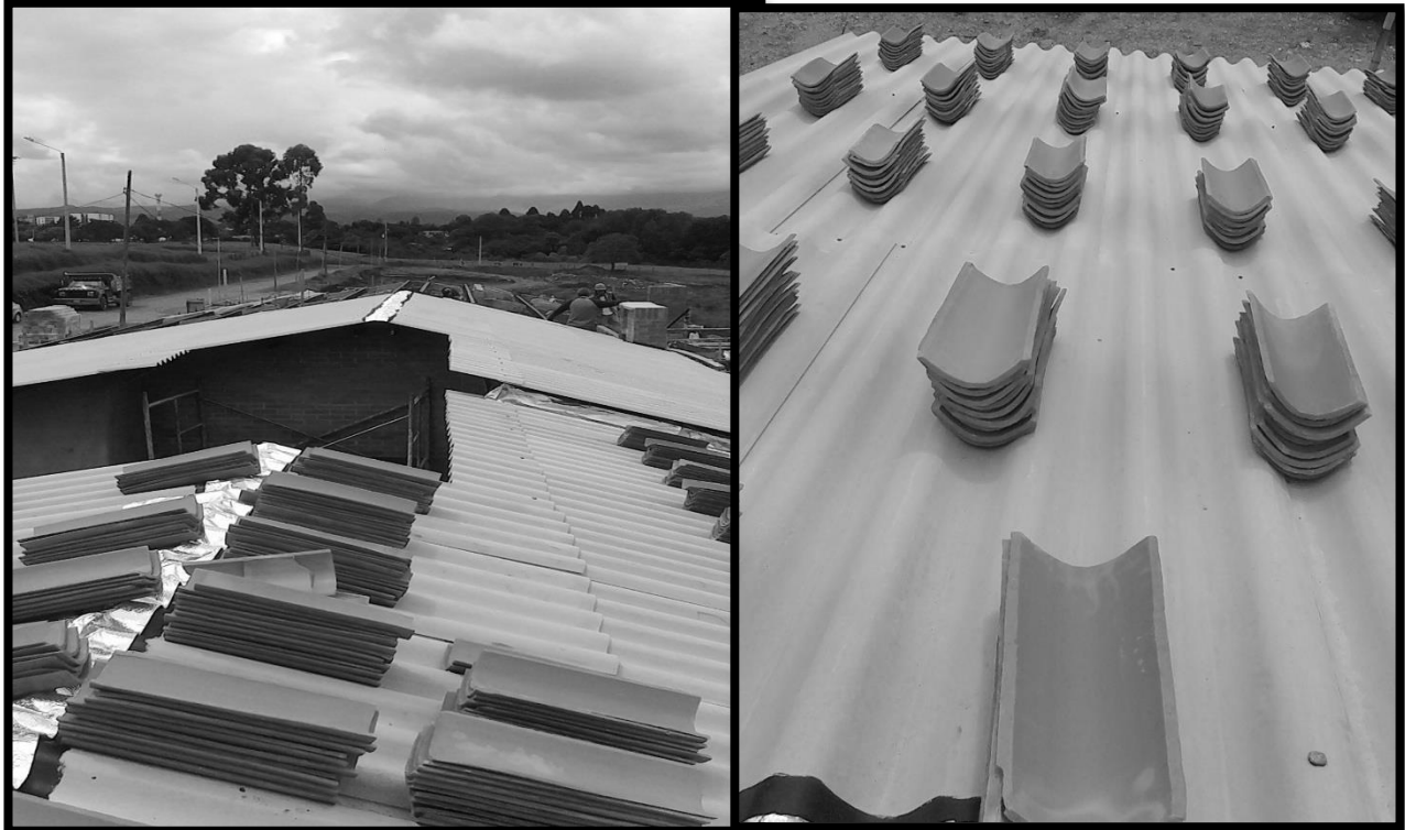
Foto 11. Hoja de asbesto cemento y teja de barro, imagen de archivo de obra
