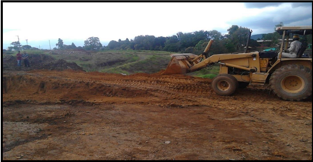
Foto 2. Nivelación y rellenos, imagen de archivo de obra.
