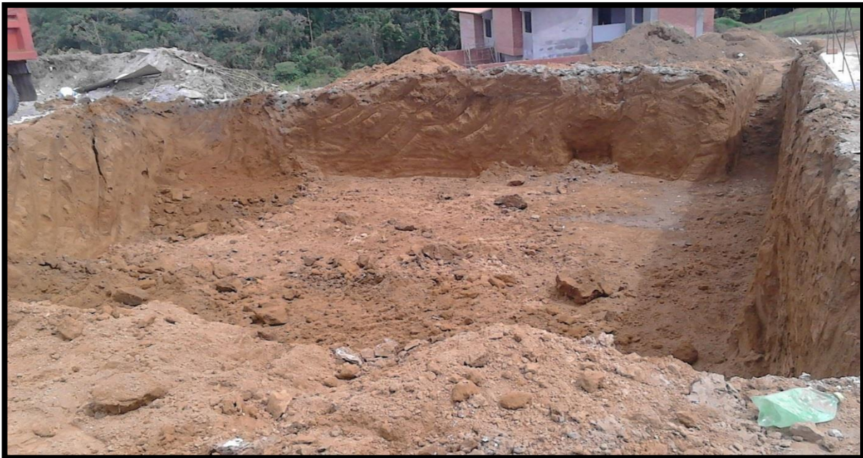
Foto 3. Excavaciones, imagen de archivo de obra.
