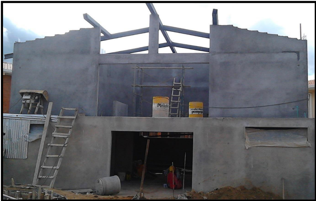
Foto 12. Acabado en obra negra, casa zona social. imagen de archivo de obra
