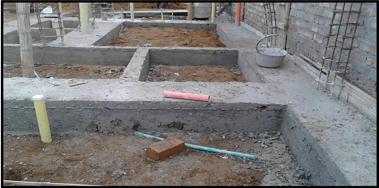
Foto 3. Cimentación, imagen de archivo de obra.
