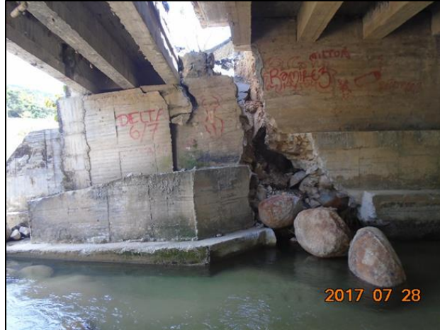
Ilustración 8. Foto estado real del puente.
