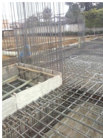
Figura 21B. Colocación de formaleta de madera tratada con ACPM y grasa en el foso del ascensor.
