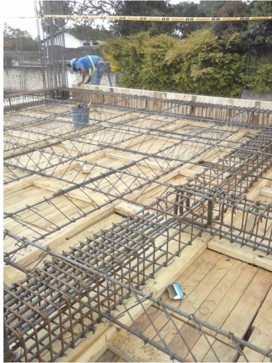
Figura 48. Colocación de ganchos de viguetas. Fuente: El autor.
