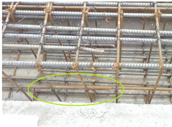
Figura 14. Traslapo de 25 cm en varilla 5/8". Fuente: El autor.
