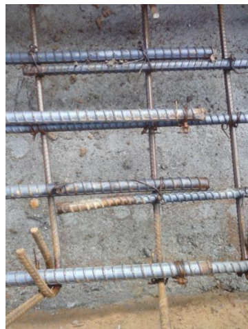
Figura 15. Traslapo de 15 cm en varilla 5/8". Fuente: El autor.
