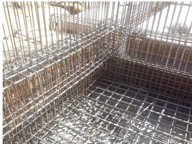
Figura 20. Armado de acero fosa ascensor según detalle corregido. Fuente: El autor.
