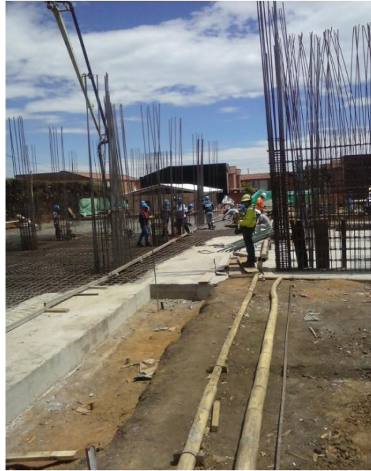
Figura 29. Tercera Fundición de cimentación.
