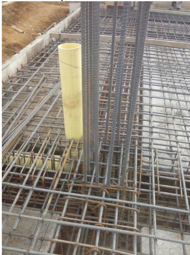
Figura 22. Colocación de pases sanitarios en la losa de cimentación.
