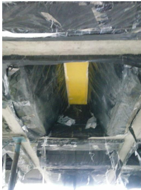
Figura 56. Triángulos que quedan en la losa cuando se retira el trapecio. Fuente: El autor.
