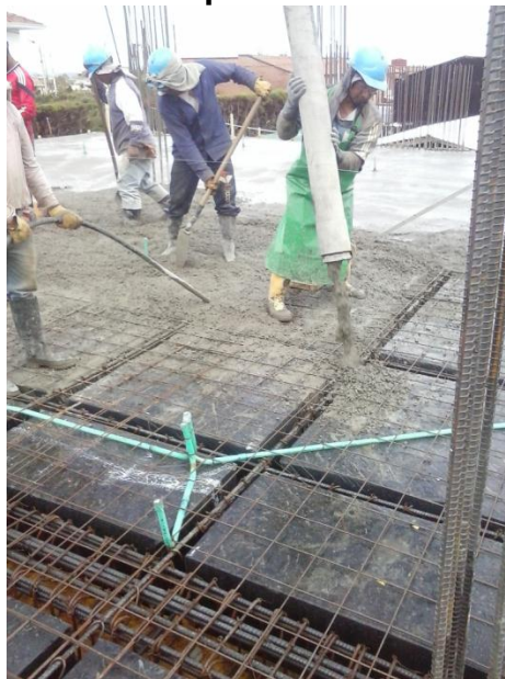
Figura 51. Fundición de losa de entrepiso. Fuente: El autor.
