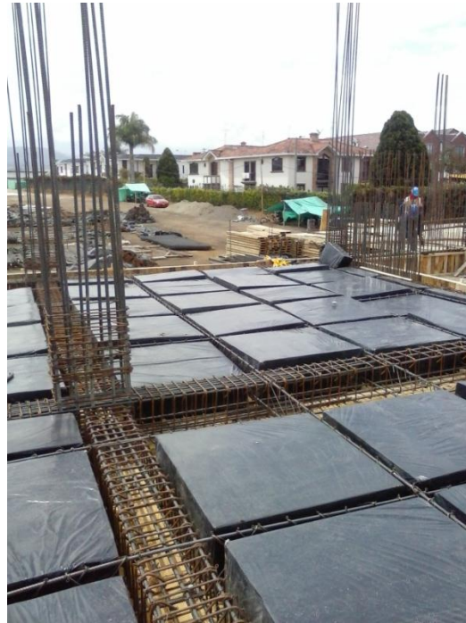
Figura 49. Colocación de casetones de icopor modulados. Fuente: El autor.
