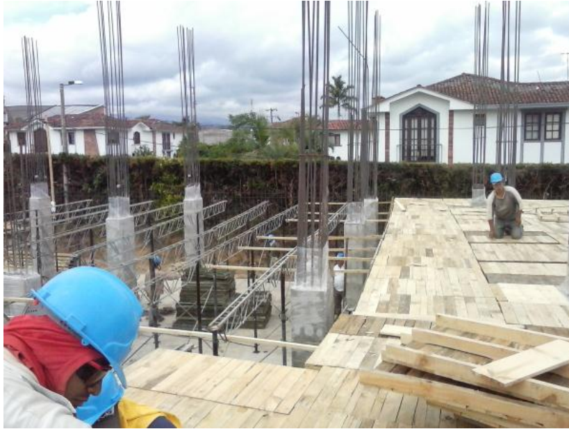
Figura 45. Colocación de gatos y cerchas. Fuente: El autor.
