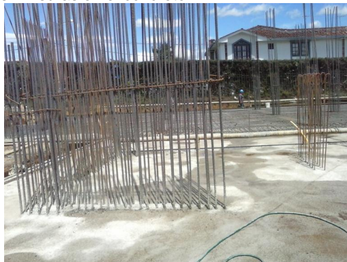
Figura 30. Curado del concreto de la cimentación Bloque B.
