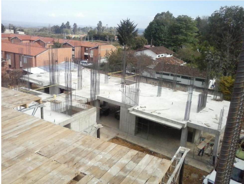
Figura 53. Curado del Bloque A con Antisol. Fuente: El autor.
