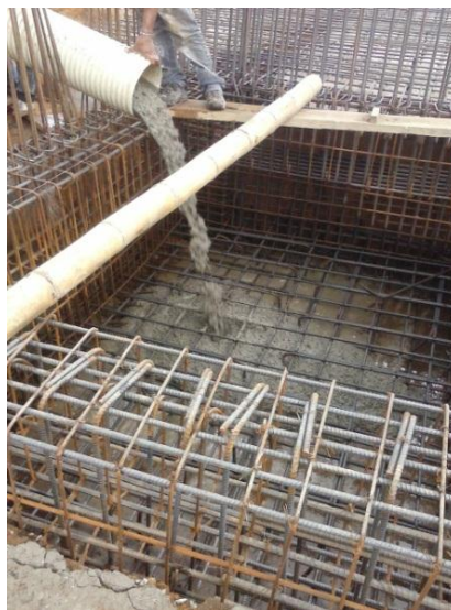
Figura 24. Colocación del concreto en la losa del foso del ascensor. Fuente: El autor.
