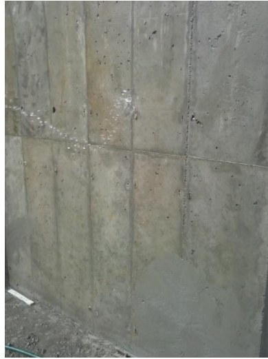
Figura 37. Errores de vibración corregidos.
