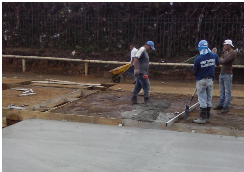
Figura 17. Fundición de solado de limpieza. Fuente: El autor.
