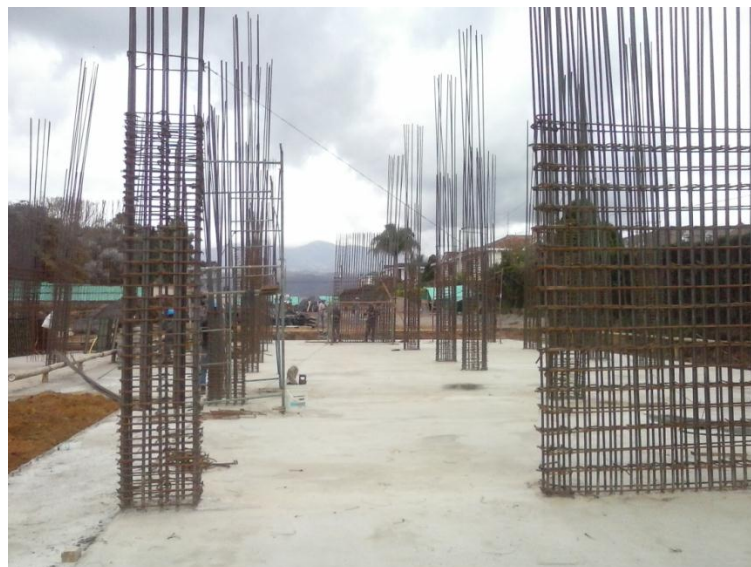
Figura 31. Armado de refuerzo Columnas y Pantallas. Fuente: El autor.
