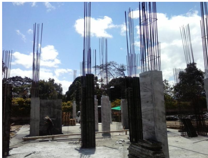
Figura 38. Curado de columnas y pantallas.
