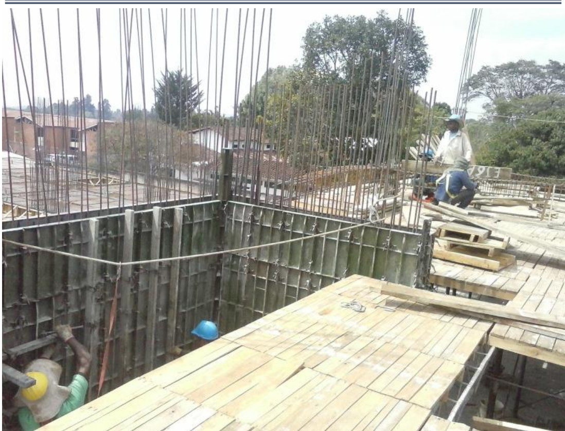
Figura 47. Colocación de entarimado y formaleta al mismo tiempo. Fuente: El autor.
