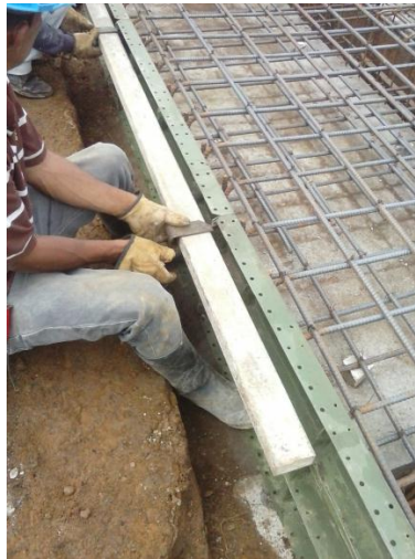
Figura 21A. Colocación de formaleta metálica tratada con ACPM y grasa en el perímetro de la cimentación.
