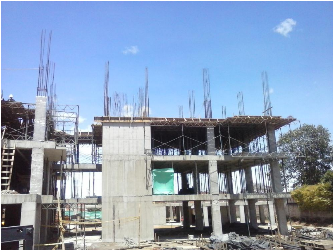
Figura 54. Post apuntalamiento Bloque B. Fuente: El autor.
