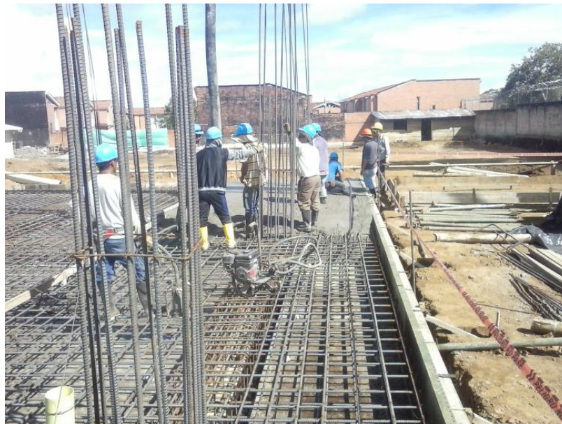
Figura 26. Segunda Fundición de cimentación. Fuente: El autor.
