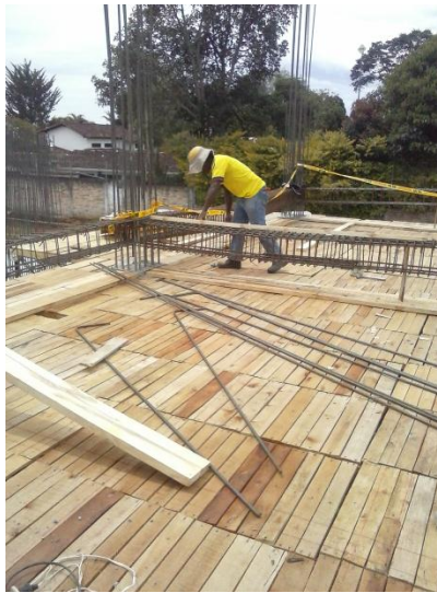
Figura 46. Colocación de encamado para vigas. Fuente: El autor.
