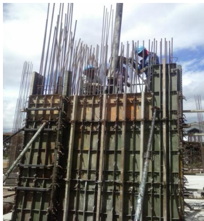
Figura 34. Fundición de las pantallas P3 y P4 (L de la escalera). Fuente: El autor.
