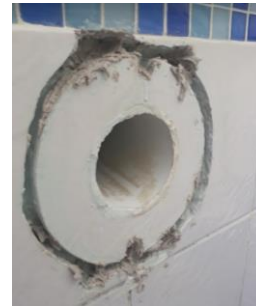
Figura 55: Aplicación de Sikadur 31
