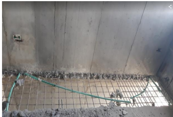
Figura 34: Demolición en losa
