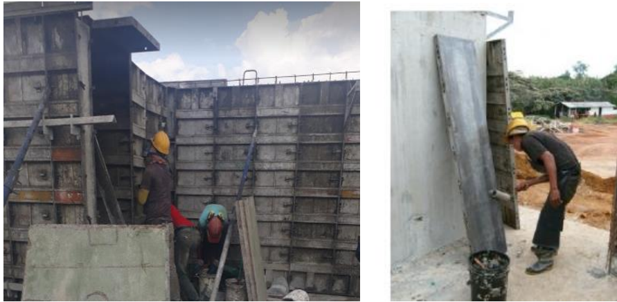
Figura 7: Fundición 2 armado de formaleta
