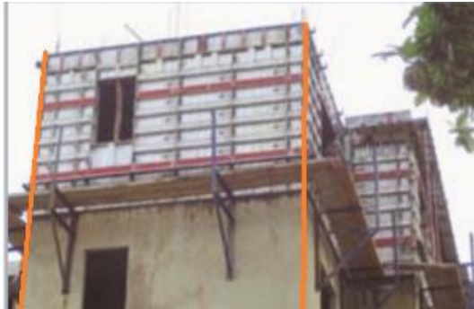
Figura 17 revisión de alineamiento vertical
