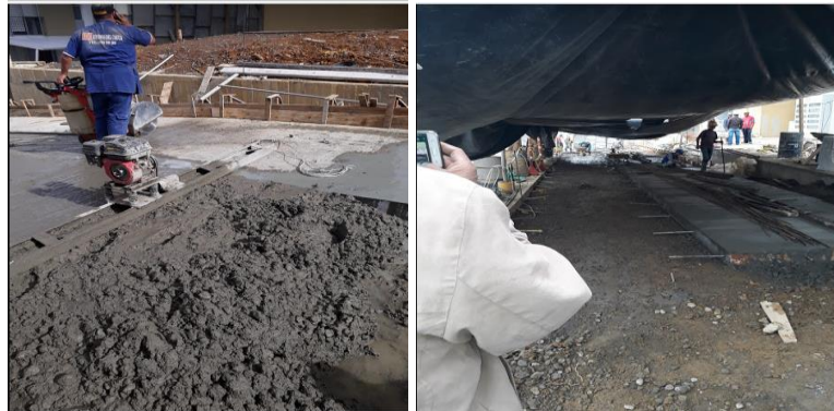
Figura 46: Fundición de losa de pavimento
