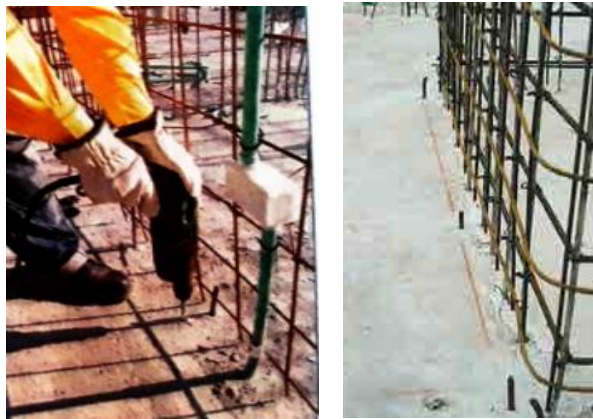
Figura 5.11 Instalación de pin de tope
