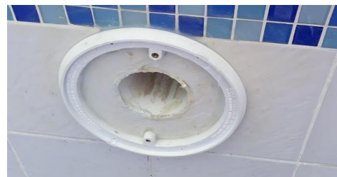
Figura 58: elemento después de aplicado sikasil pool
