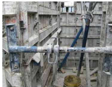
Figura 20: tensores de muros y vanos
