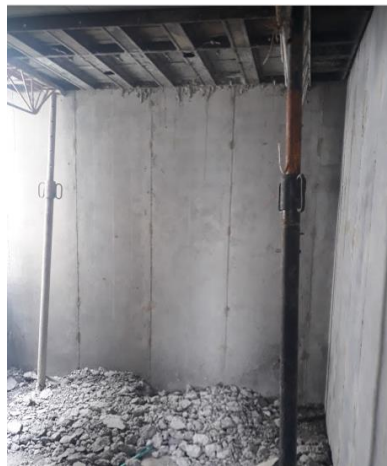
Figura 36: colocación de formaleta para fundición de losa
