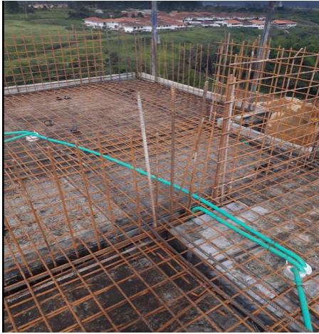
Figura 15: Foto de Armado de aceros en losa
