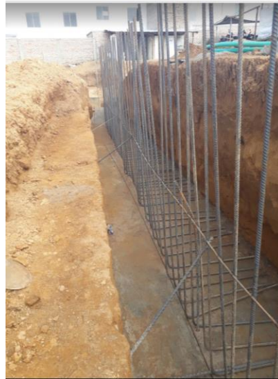
Figura 48 : Armado de aceros en muro de contención h=2m
