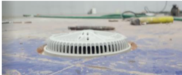
Figura 60: Instalación de rejillas en desagüe de fondo
