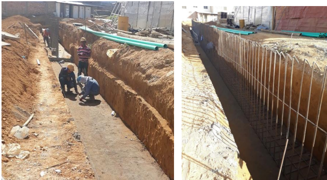
Figura 49: Armado de aceros en muro h: 1.2m
