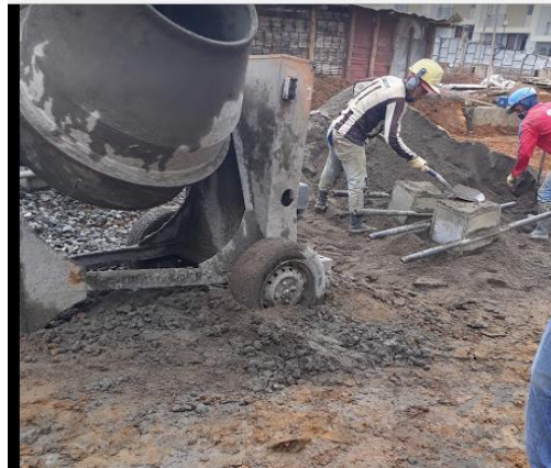
Figura 45: Preparación de mezcla de concreto pavimento
