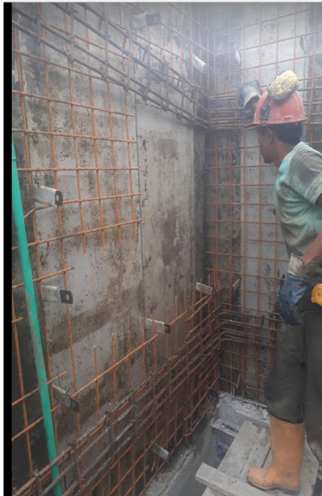
Figura 29: Ubicación de vigas en sobre recorrido ascensor
