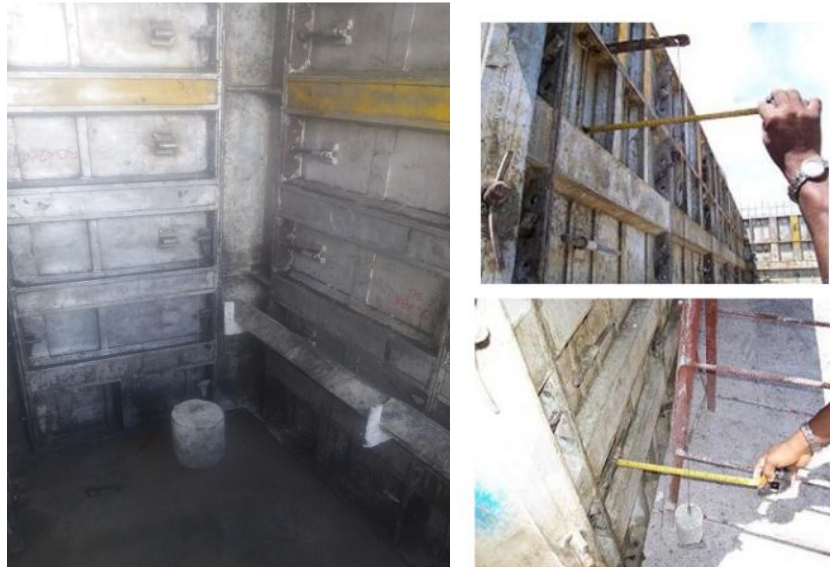
Figura 19: Revisión de plomos apartamento a fundir
