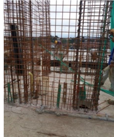
Figura 16: Foto de Armado de aceros en muros
