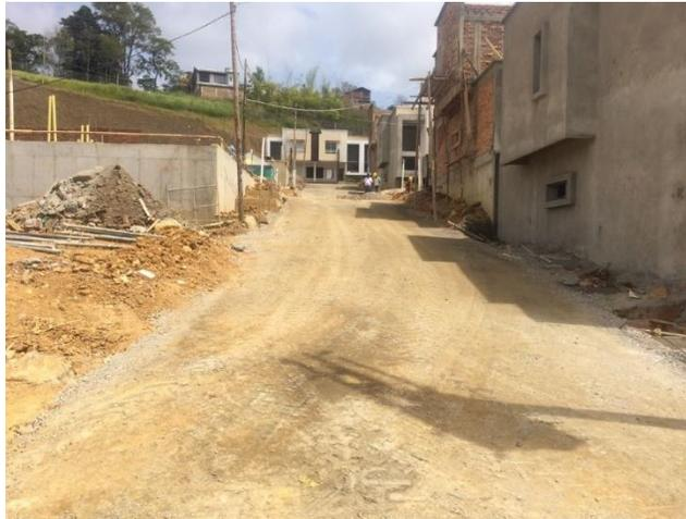
*Figuras N° 78: subbase lista para ensayo densidad. Fuente propia*
