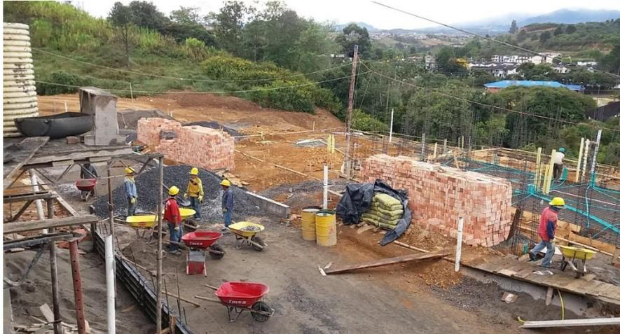
*Figura N°53: Preparación de la mezcla para fundición de losa. Fuente propia.*
