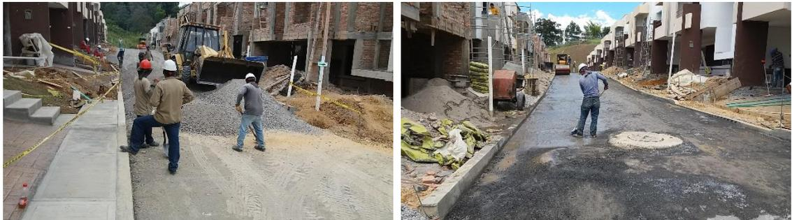
*Figuras N° 82 y 83: Material capa de subbase. Fuente propia*
