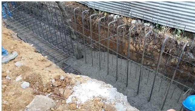
*Figura N°16: Vaciado de mezcla en zarpa tramo 2, muro de acceso vía ppal.
