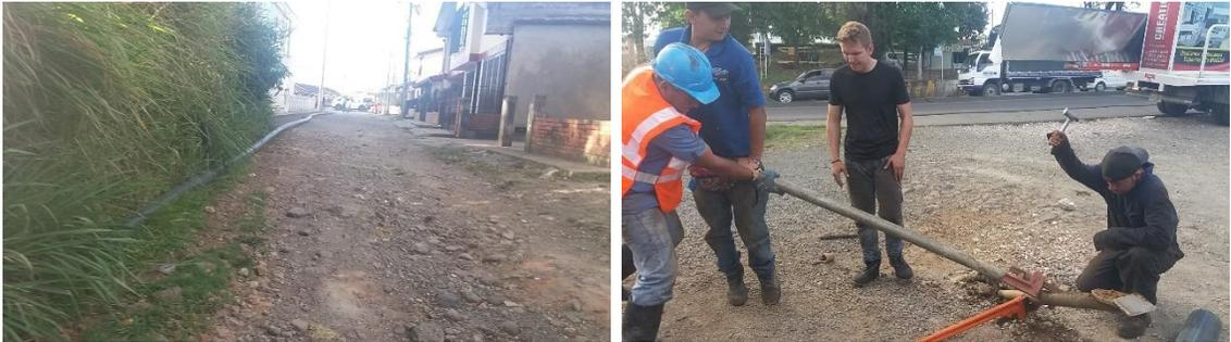
*Figuras N° 65 y 66: Tubería Flexible y broca cruzando la vía. Fuente propia*
