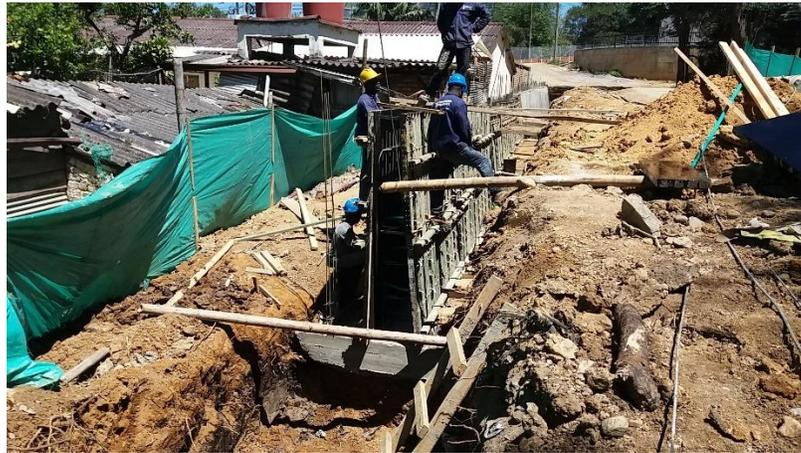
*Figura N°17: Vaciado de mezcla en pantalla tramo 2, muro de acceso vía ppal.
