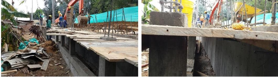
*Figura N°21 y 22: Formaleta de andén, muro vía ppal. Fuente propia.*
