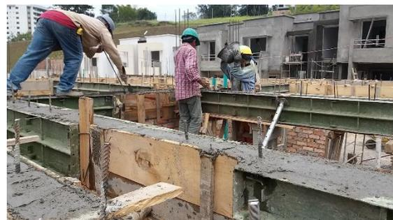
Figuras N°61 y 62: Encofrado y fundición de vigas. Fuente propia.
