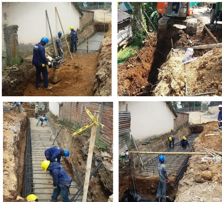
*Figura N°10: Solado y armado de zarpa, muro de acceso vía ppal. Fuente propia.*
