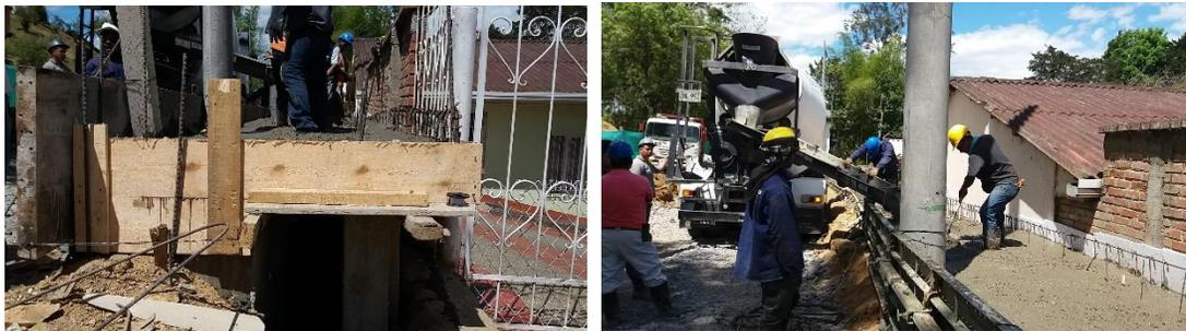
*Figura N°23 y 24: Formaleta de andén, muro vía ppal. Fuente propia.*
