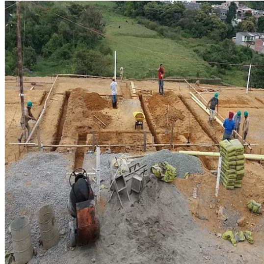
*Figuras N°43 y 44: Planteamiento y excavación tubería de alcantarillado. Fuente propia.*
