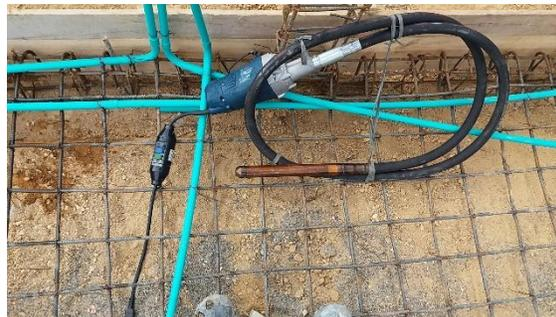
*Figura N°52: Vibrador de concreto. Fuente propia.*
