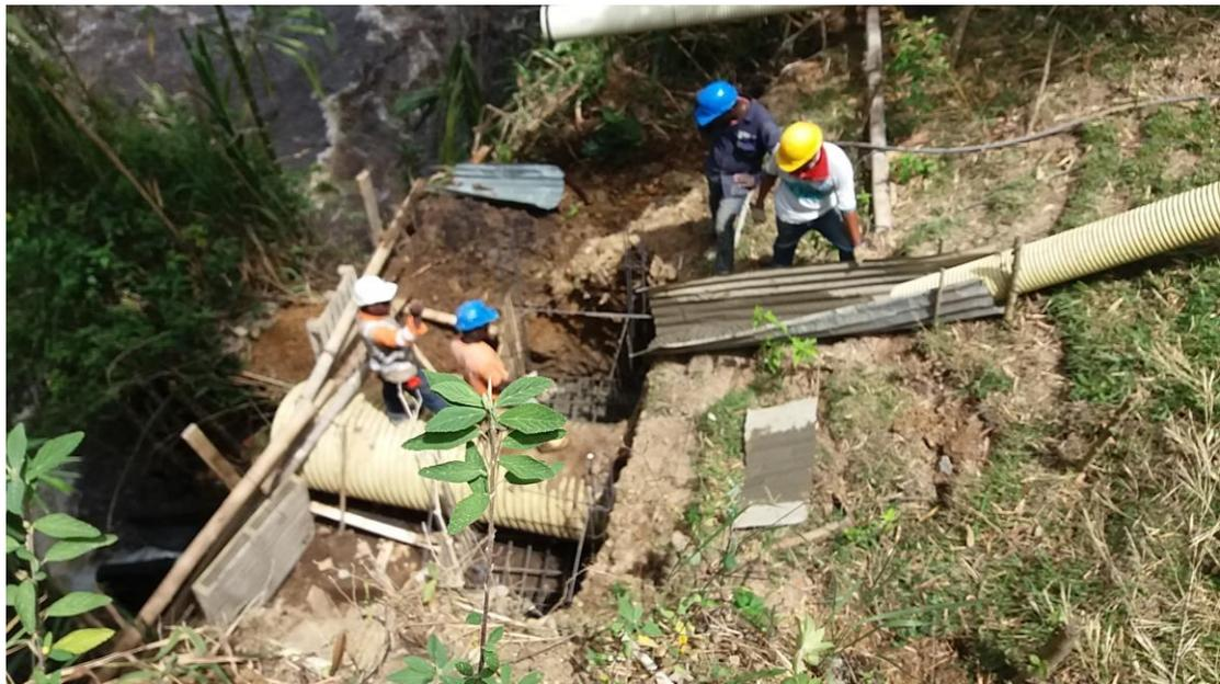
*Figura N°34 Fundición estructura de apoyo descole de tubería. Fuente propia.*
