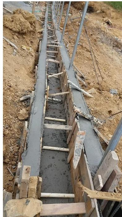
*Figuras N° 84 y 85: Construcción viga cuneta de cerramiento. Fuente propia.*
