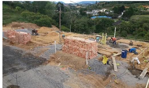
*Figuras N°45 y 46: Instalación tubería y fundición de cajas. Fuente propia.*
