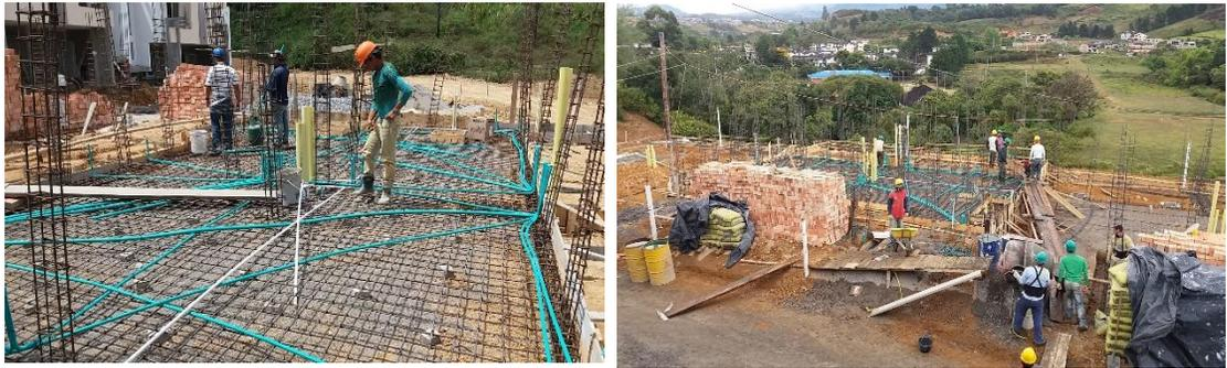
*Figuras N°50 y 51: Instalación tubería electicos, gas, agua y fundición de losa.
