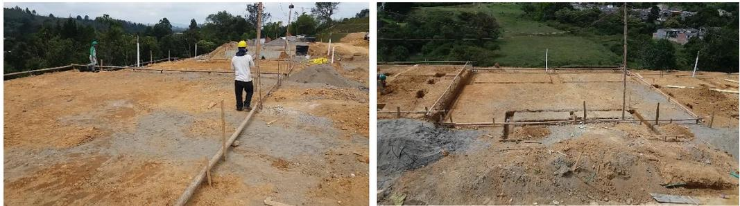
*Figuras N°41 y 42: Planteamiento y excavación de zapatas. Fuente propia.*
