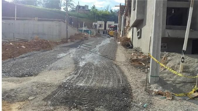
*Figura N° 81: Riego de material. Fuente propia.*
