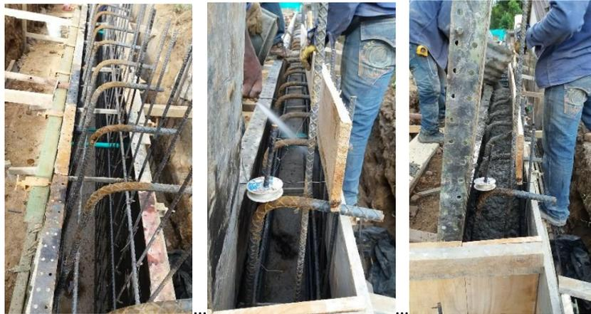
*Figura N°15: Formaleta y vaciado de mezcla en la pantalla, muro vía ppal. Fuente propia.*
