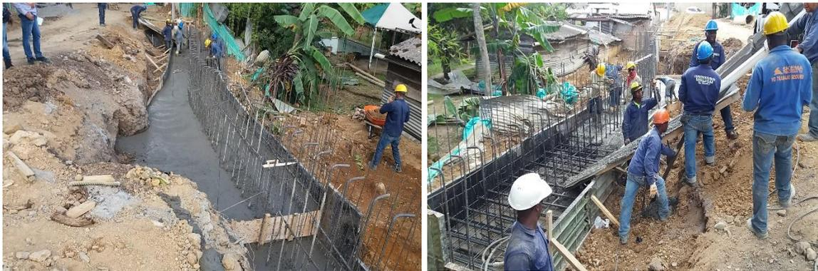
*Figura N°18: Vaciado de mezcla en zarpa tramo 3, muro de acceso vía ppal.
