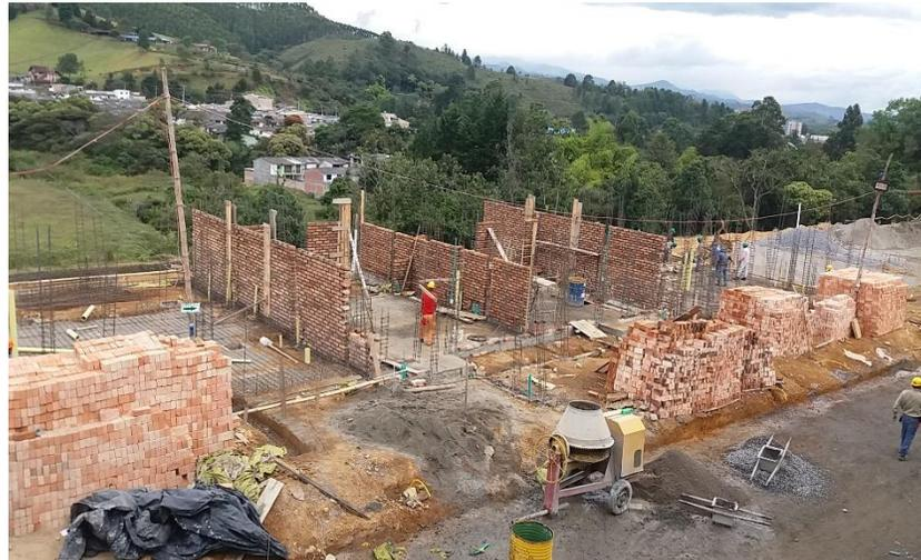
*Figura N° 56 y 57: detalle de confinamiento Muros y columnas, casas 3 y 4 manzana B. Fuente propia.*
