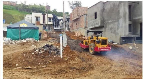
*Figuras N° 75 y 76: Material capa de subbase. Fuente propia*
