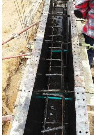
*Figura N°19: Fundición pantalla tramo 3, vía ppal. Fuente propia.*
