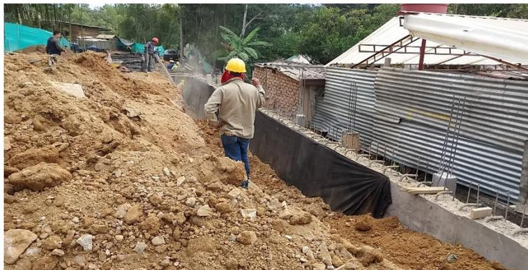
*Figura N°20: Relleno del muro, vía ppal. Fuente propia.*
