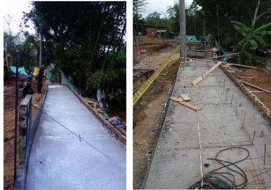
*Figura N°25 y 26: Fundición de andén, muro vía ppal. Fuente propia.*
