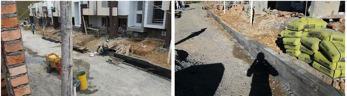
*Figuras N° 79 y 80: Material capa de subbase. Fuente propia*
