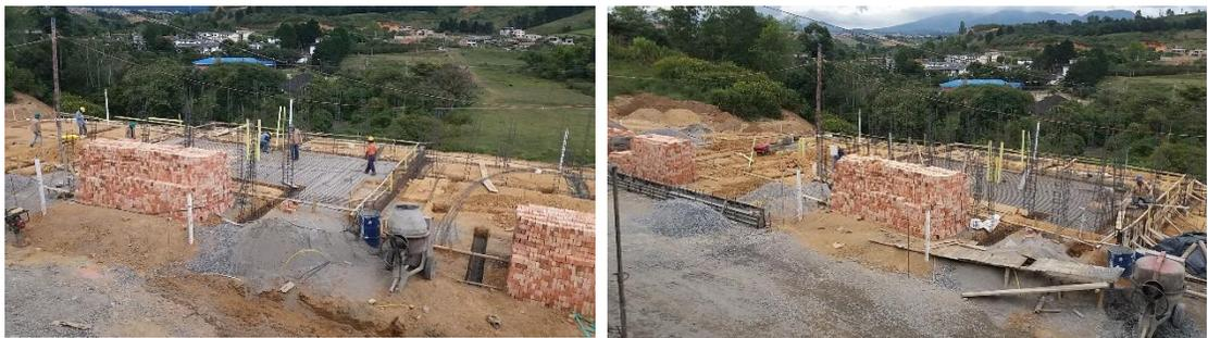
Figuras N°48 y 49: Instalación tubería y fundición de cajas. Fuente propia.
