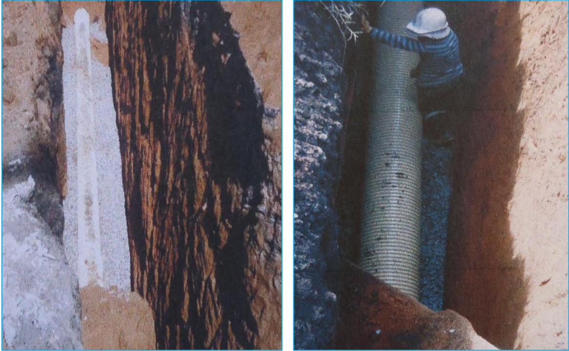
Imagen 23 - 24 Cimentación tubería flexible
