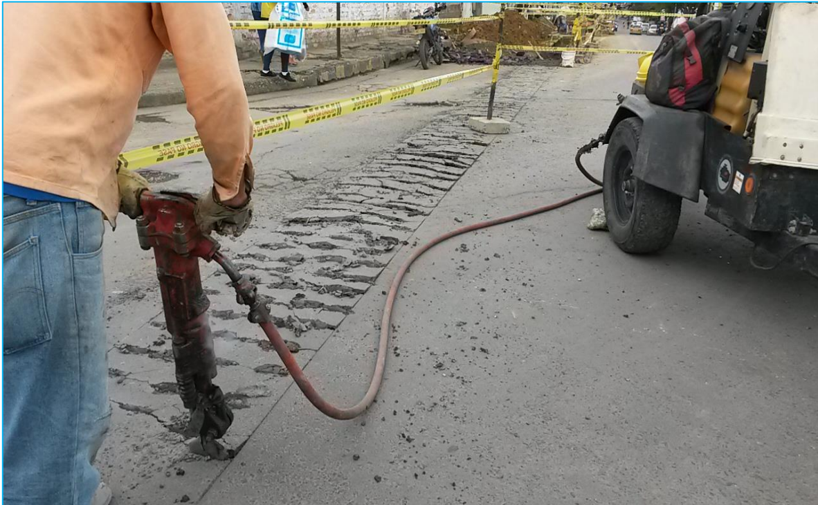
Imagen 11 Corte y demolición pavimento flexible
