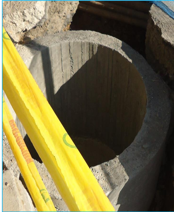
Imagen 27 - 28 Construcción cámaras de inspección Alcantarillado pluvial
