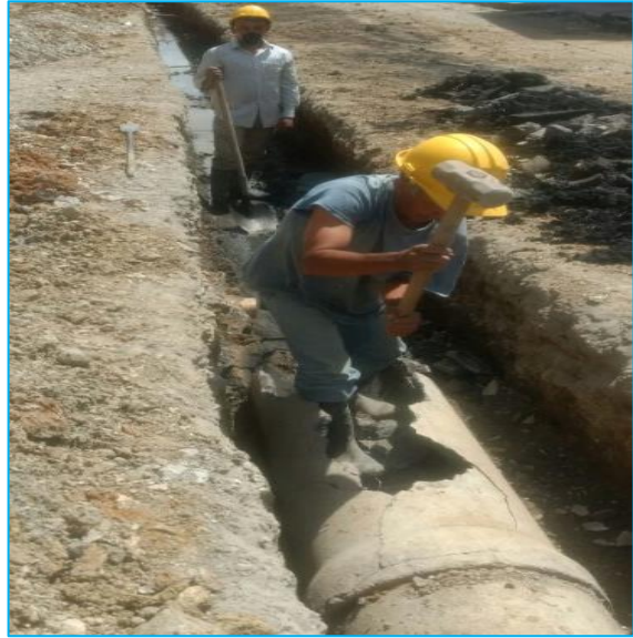
Imagen 18 -19 Demolición y retiro tubería en concreto existente
