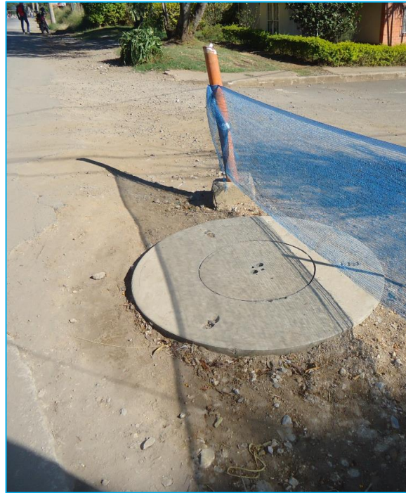
Imagen 35 - 36 Construcción cámaras de inspección Alcantarillado sanitario
