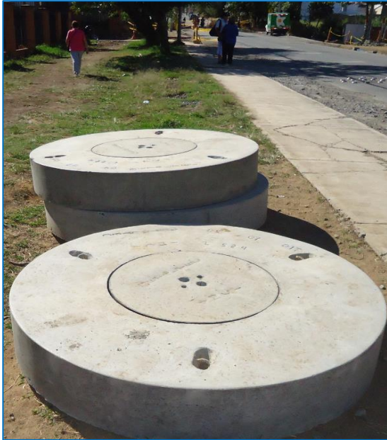
Imagen 59- 60 Construcción de brocales y cajas.
