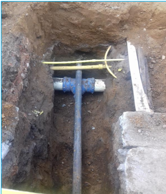
Imagen 20 - 21 Retiro tubería en PVC existente
