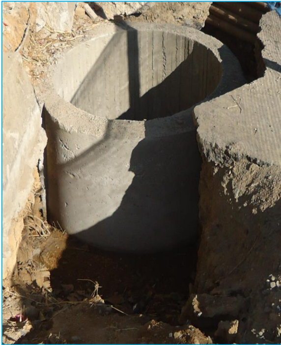
Imagen 35 - 36 Construcción cámaras de inspección Alcantarillado sanitario
