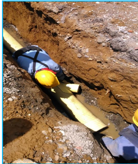
Imagen 33 – 34 Instalación sillas Y - instalaciones domiciliarias Alcantarillado sanitario
