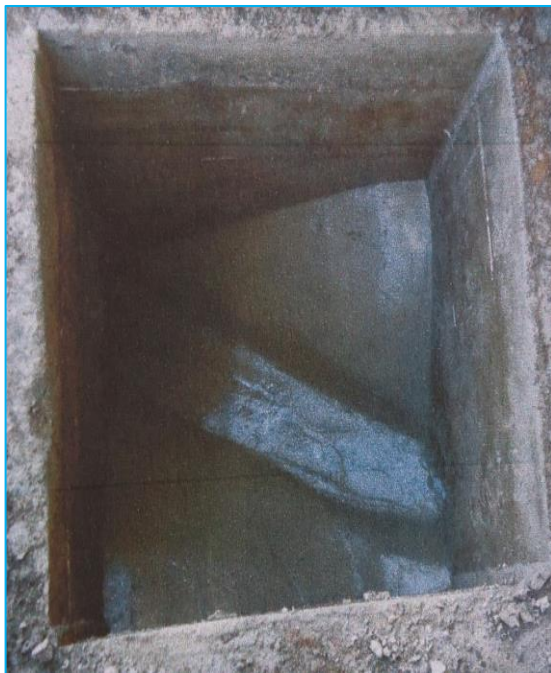
Imagen 37 - 38 Construcción cajillas - instalaciones domiciliarias Alcantarillado sanitario
