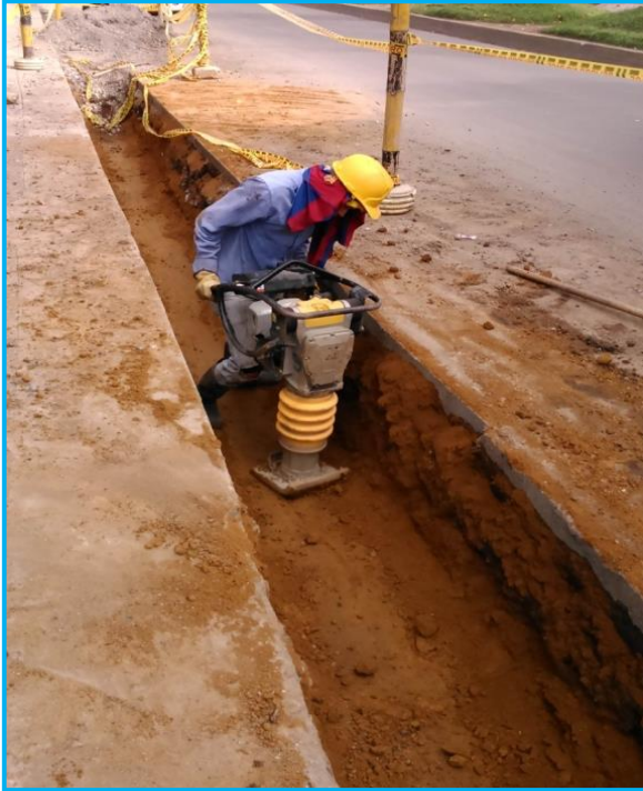
Imagen 53 – 54 Compactación con equipo mecánico de bajo peso.
