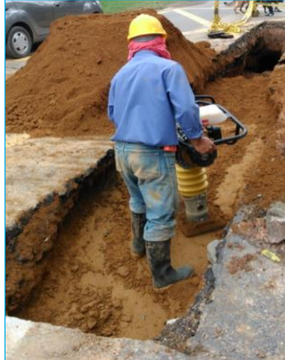
Imagen 53 – 54 Compactación con equipo mecánico de bajo peso.
