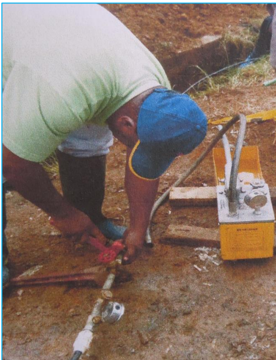
Imágenes 50 - 51 Prueba de presión manométrica
