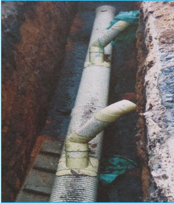
Imagen 31 - 32 instalación sillas Y - instalaciones domiciliarias Alcantarillado sanitario
