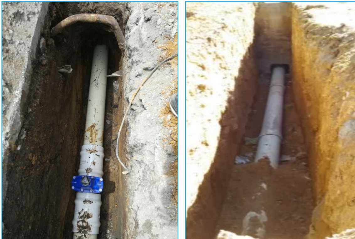
Imagen 39 - 40 Instalación tubería PVC unión mecánica red distribución acueducto
