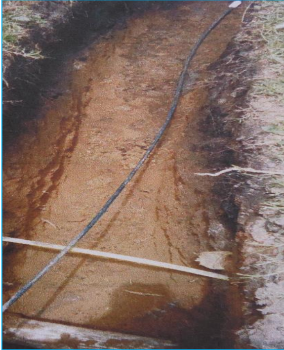
Imágenes 48 – 49 Conexiones domiciliarias manguera PF+UAD
