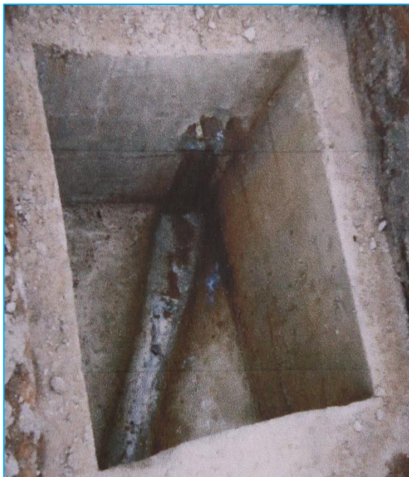
Imagen 37 - 38 Construcción cajillas - instalaciones domiciliarias Alcantarillado sanitario
