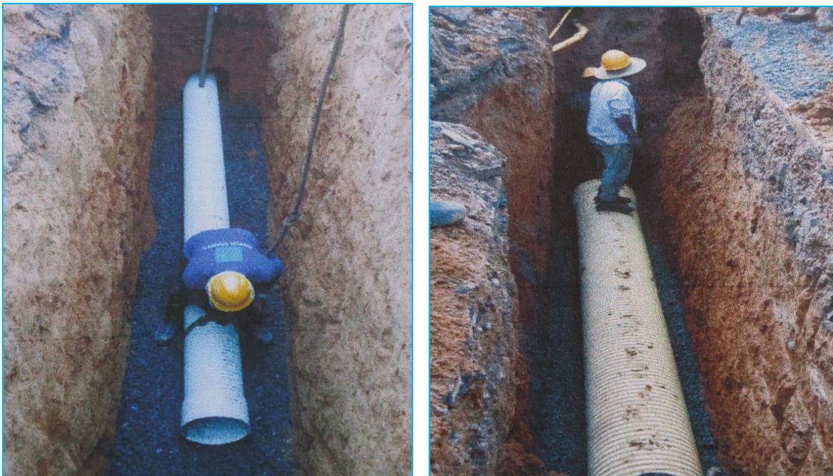
Imagen 25 – 26 Instalación tuberías diámetro 20" Alcantarillado pluvial
