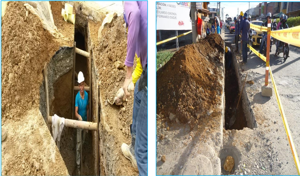
Imagen 16 - 17 Excavación en material común a mano
