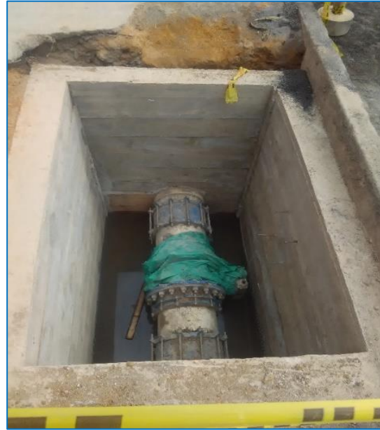
Imagen 59- 60 Construcción de brocales y cajas.
