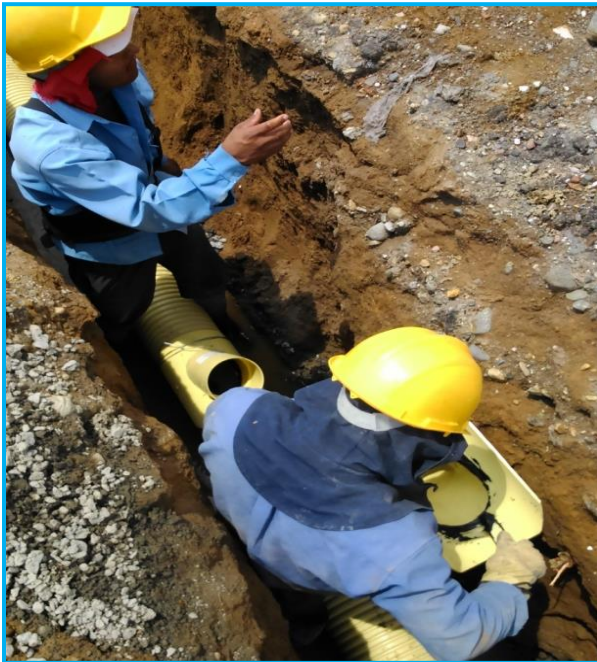
Imagen 33 – 34 Instalación sillas Y - instalaciones domiciliarias Alcantarillado sanitario
