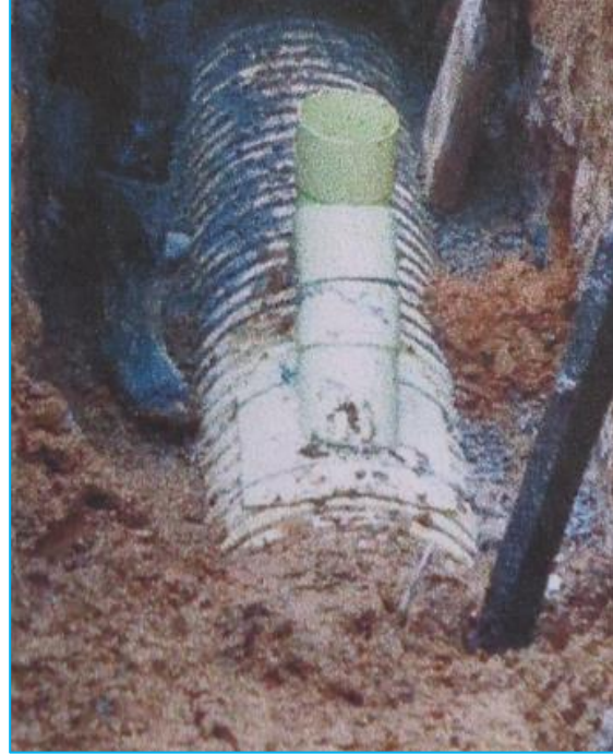
Imagen 31 - 32 instalación sillas Y - instalaciones domiciliarias Alcantarillado sanitario
