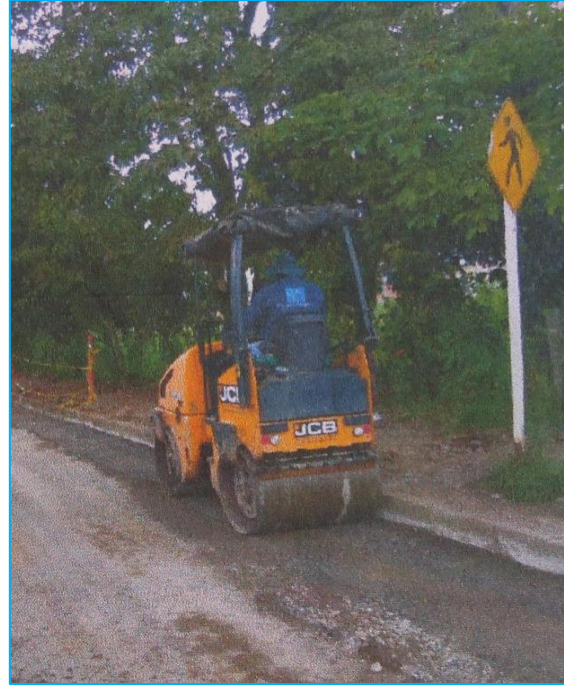
Imagen 55 - 56 Compactación con equipo mecánico convencional.
