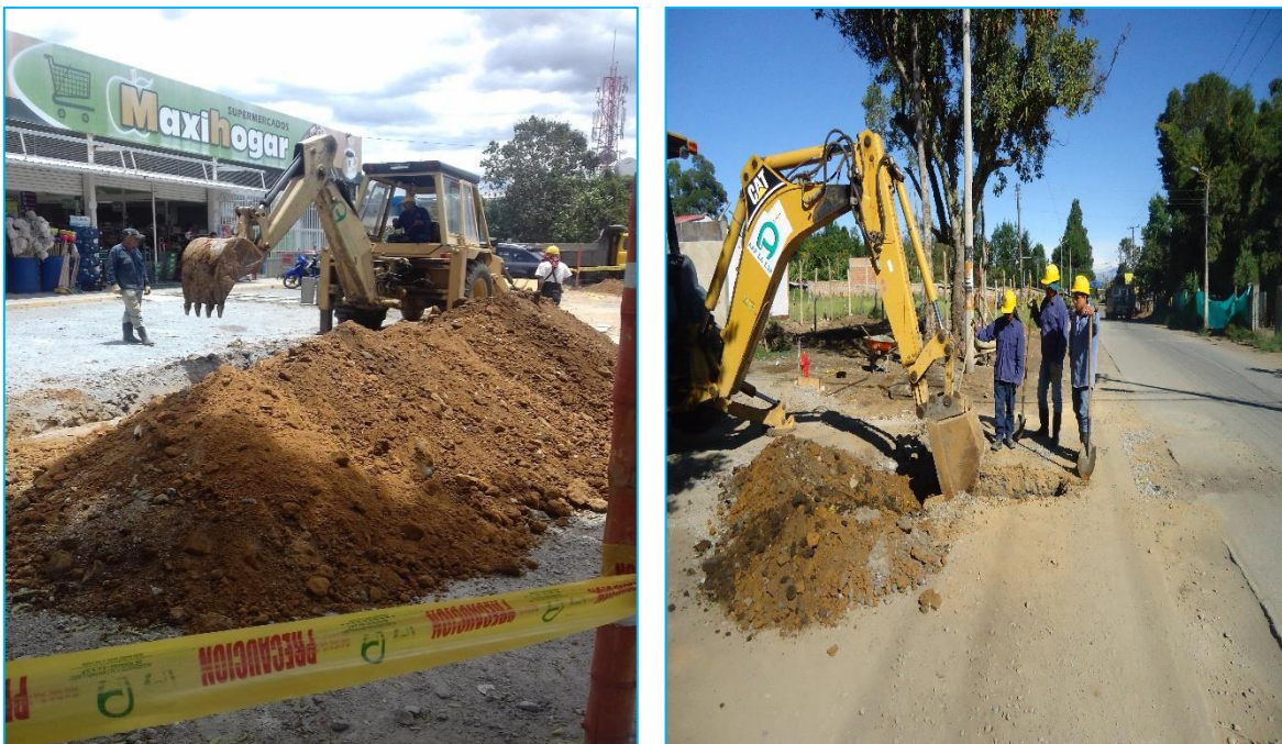
Imagen 14 - 15 Excavacion en material comun y conglomerado con maquinaria.
