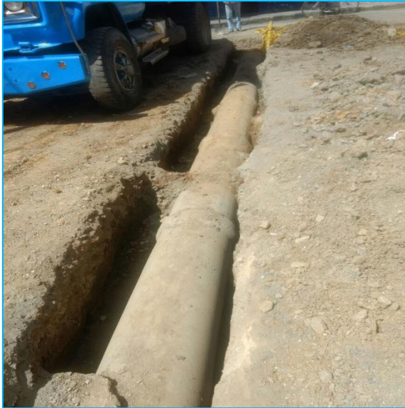
Imagen 18 -19 Demolición y retiro tubería en concreto existente
