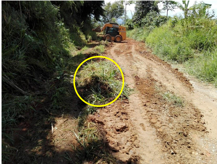
Figura 33. Retiro de material vegetal de la franja de vía
