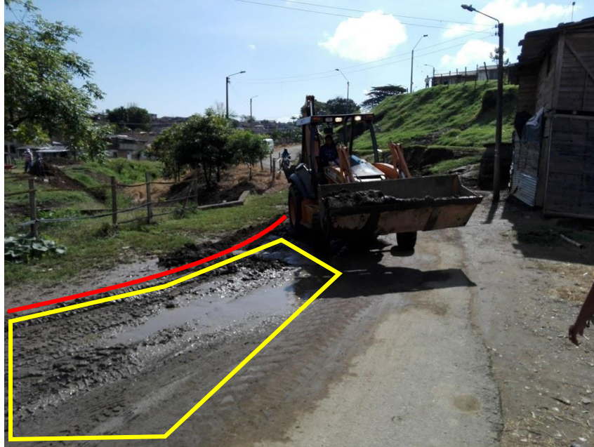
Figura 55. Retro cargador retirando fango presente en la vía
