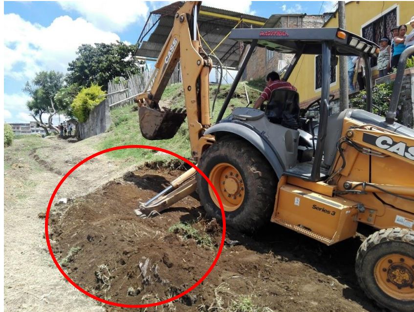
Figura 59. Retro cargador retirando montículos de tierra
