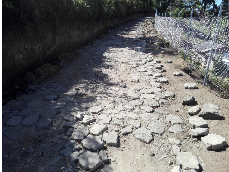
Figura 15. Presencia de material mal acomodado en la vía
