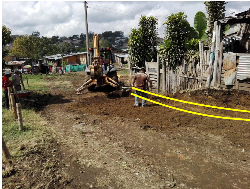
Figura 58. Retro cargador construyendo cuneta para evacuación de agua
