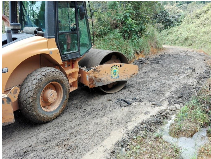
Figura 37. Vibro compactador trabajando en zona de suelo inestable
