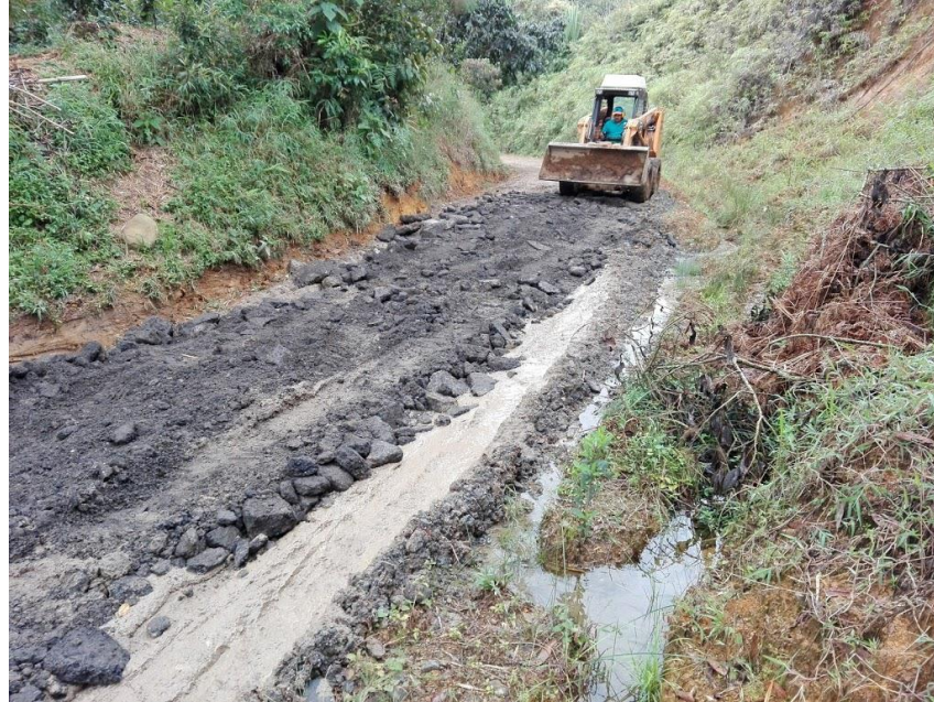
Figura 36. Viaje de carpeta depositado en zona de suelo inestable
