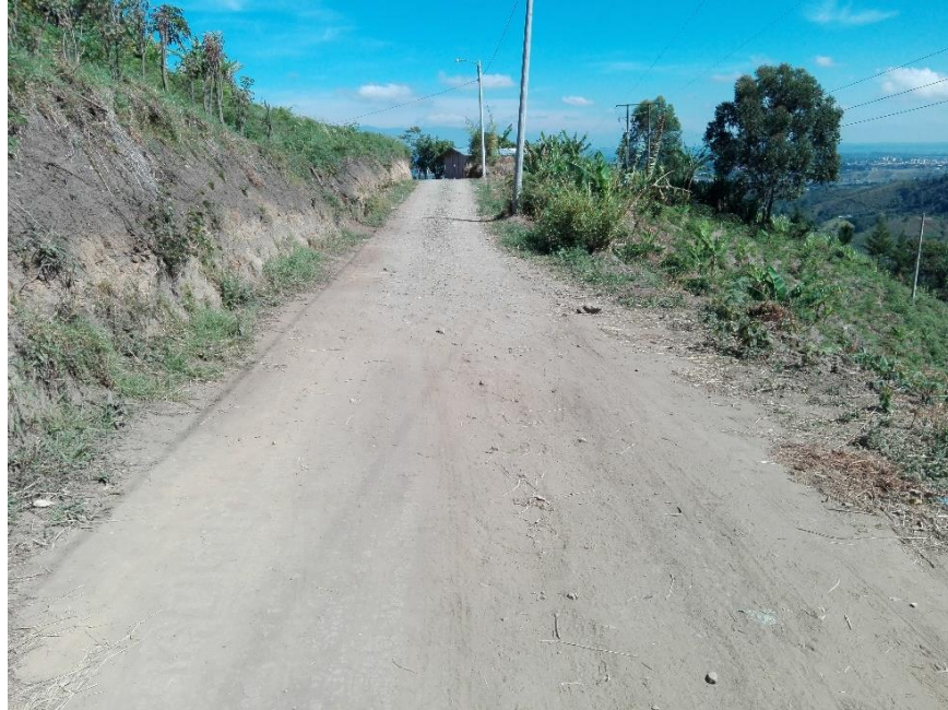
Figura 20. Tramo de vía con necesidad de limpieza de cuneta izquierda
