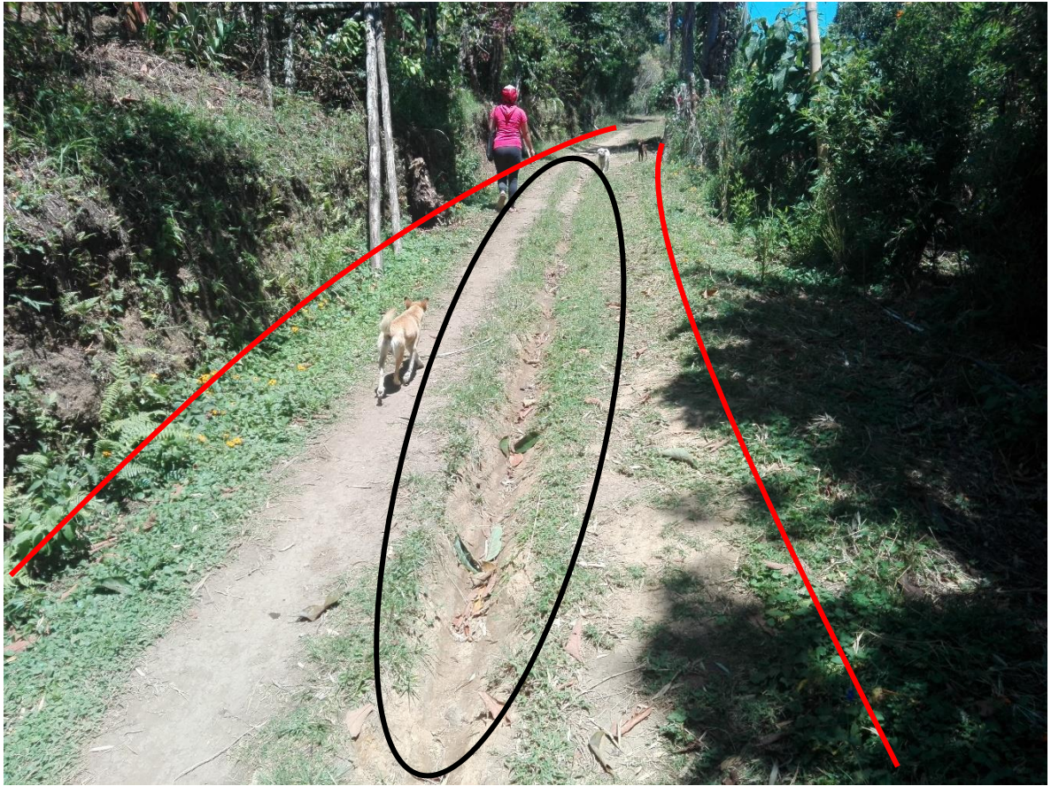
Figura 11. Bache de gran longitud sobre la vía
