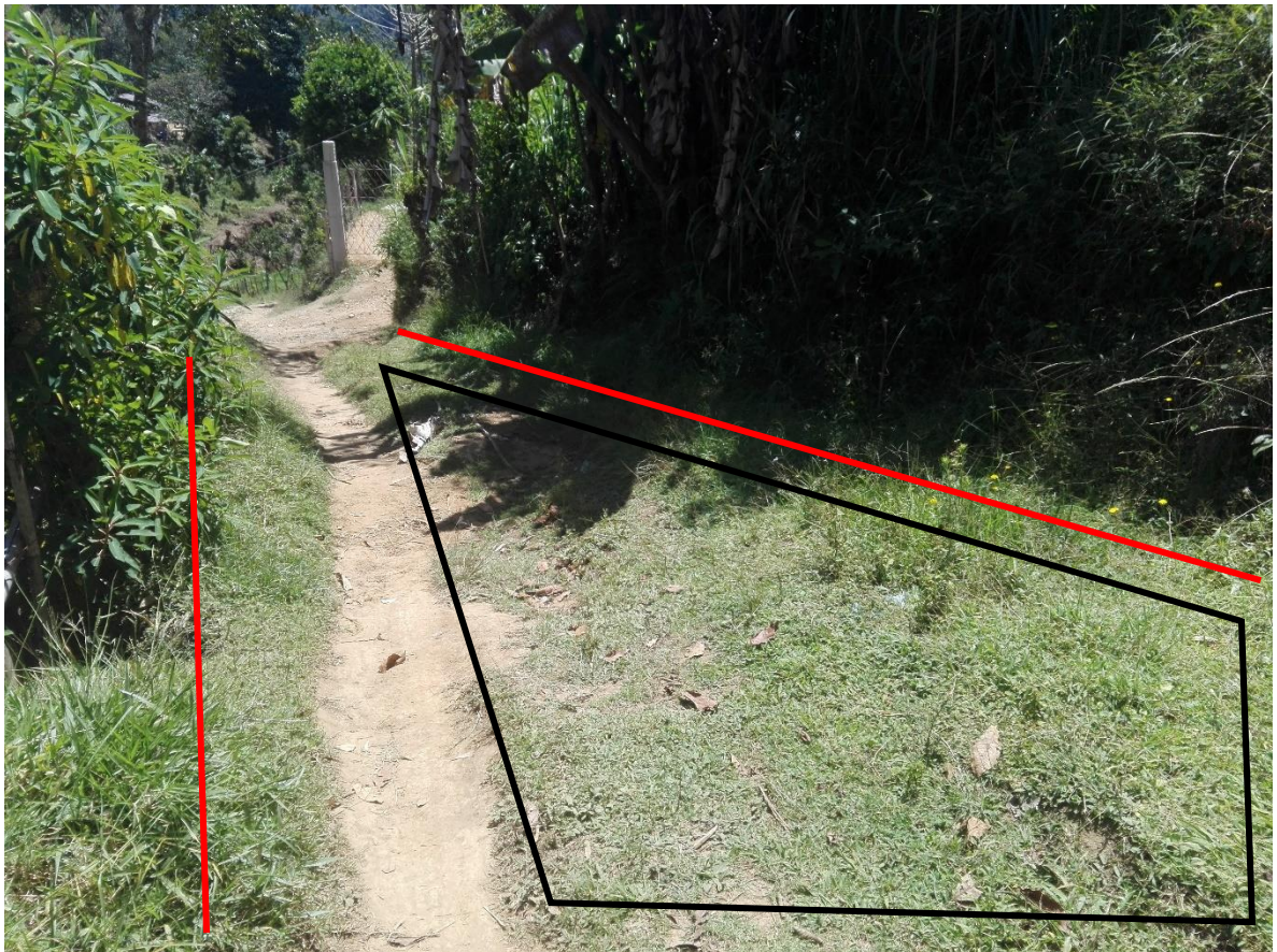
Figura 8. Invasión vegetal en la vía e inexistencia de cunetas
