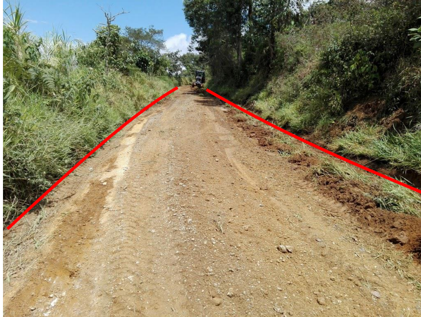
Figura 32. Ampliación de la calzada al cortar material vegetal
