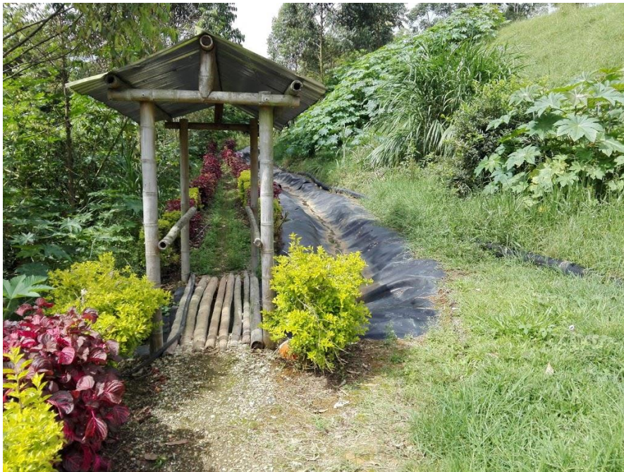
Figura 62. Canal de aguas a reparar con geo membrana
