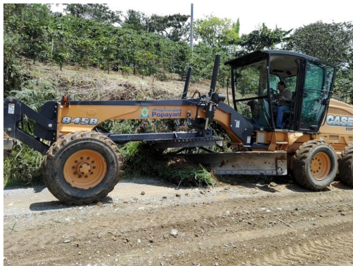
Figura 31. Motoniveladora recuperando lado izquierdo de la vía
