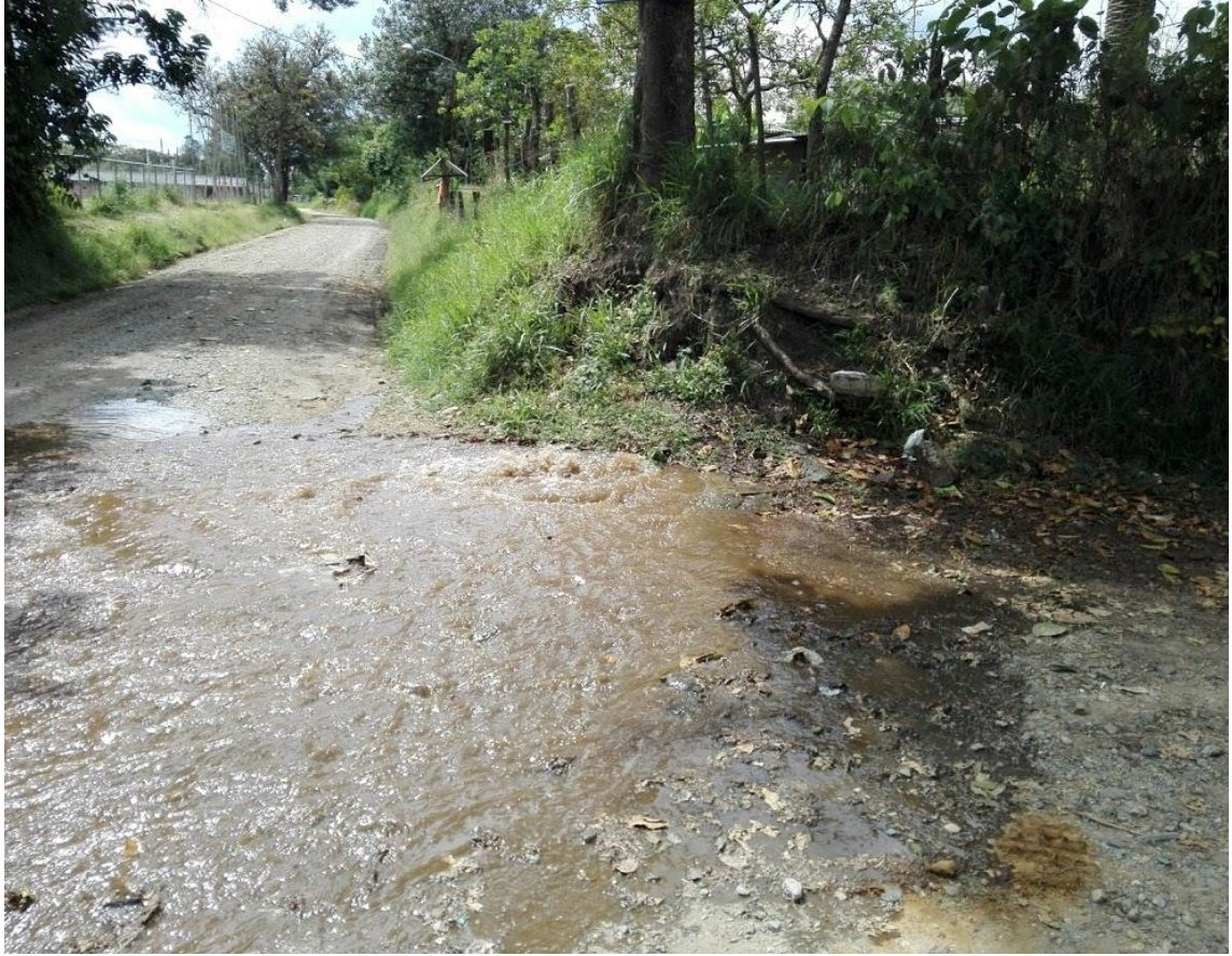
Figura 41. Fuga de agua por estallido de válvula de la empresa de acueducto
