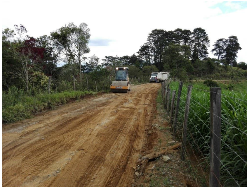
Figura 35. Vibro compactador comprimiendo el terreno intervenido
