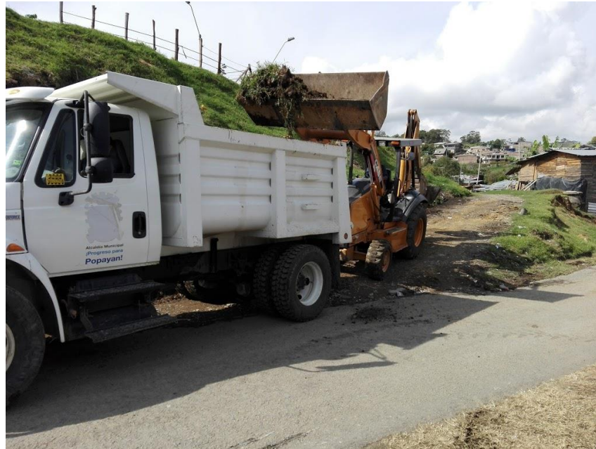
Figura 53. Retro cargador depositando desechos en volqueta
