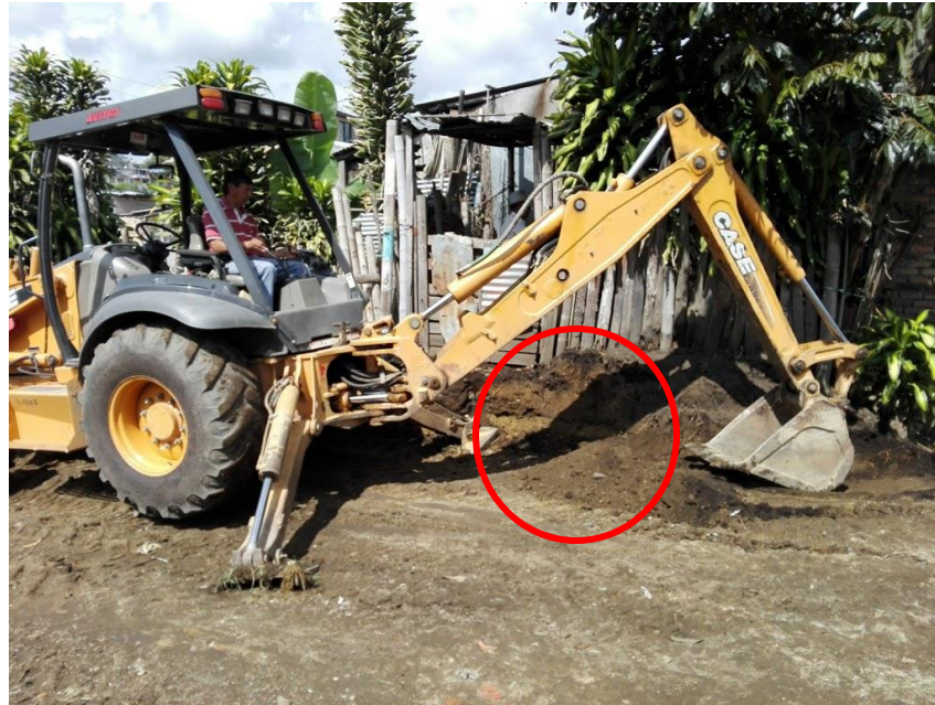
Figura 57. Retro cargador retirando material que invade la calle
