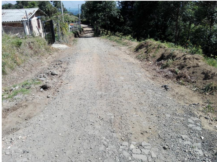
Figura 21. Tramo de vía en buen estado
