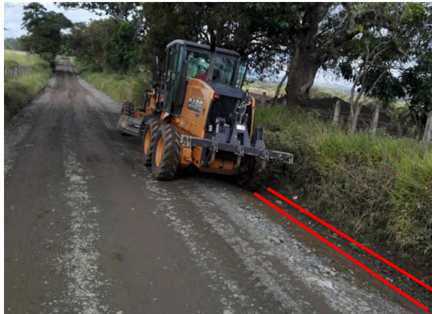
Figura 24. Motoniveladora conformando cuneta derecha de la vía
