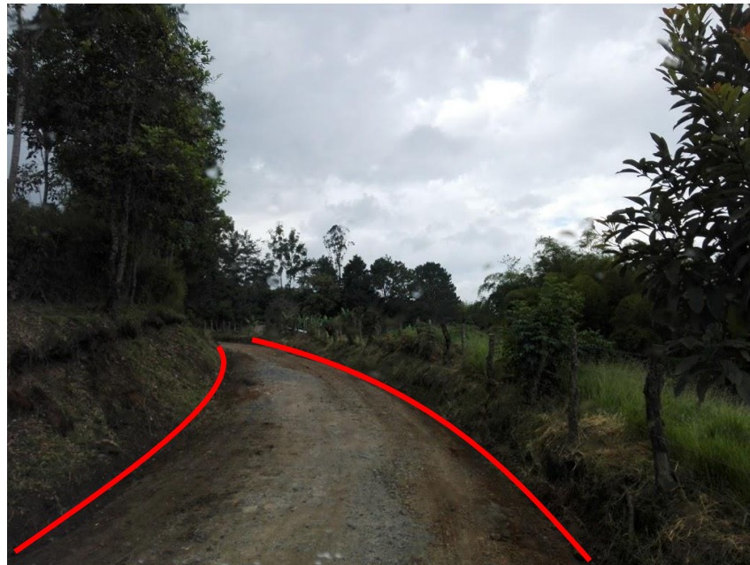
Figura 30. Cunetas conformadas, compactadas y limpias
