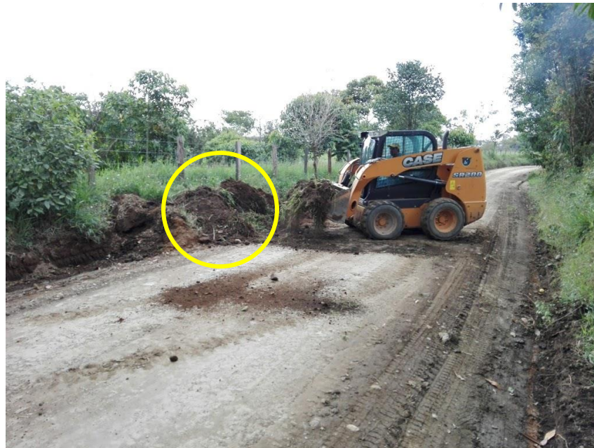
Figura 26. Mini cargador recogiendo material acumulado
