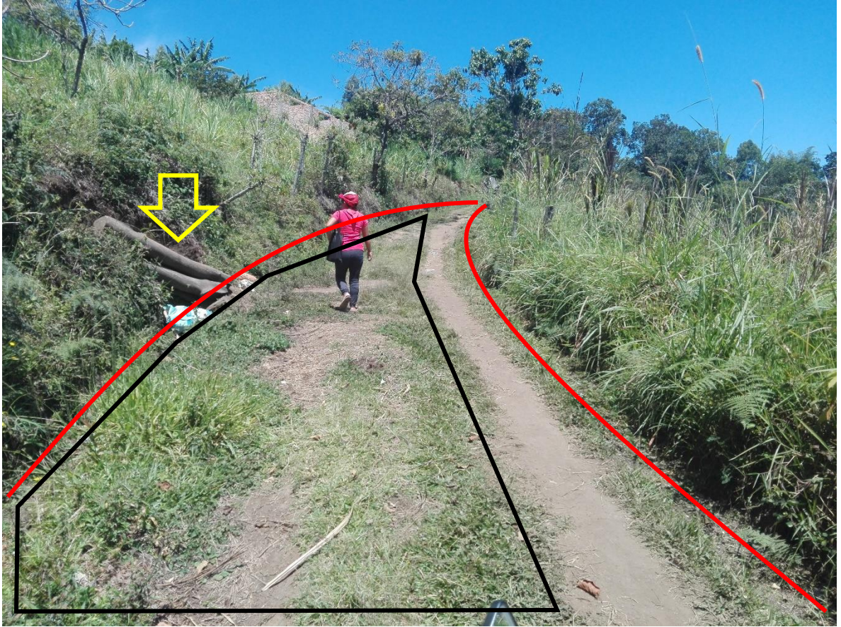
Figura 10. Invasión vegetal en la vía y presencia de materiales en cunetas
