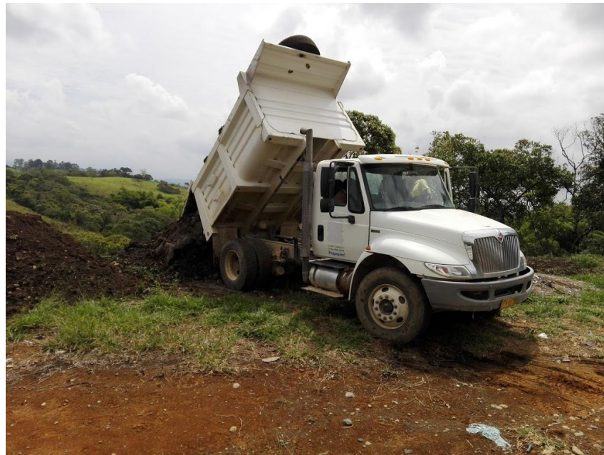
Figura 28. Volqueta descargando material acumulado
