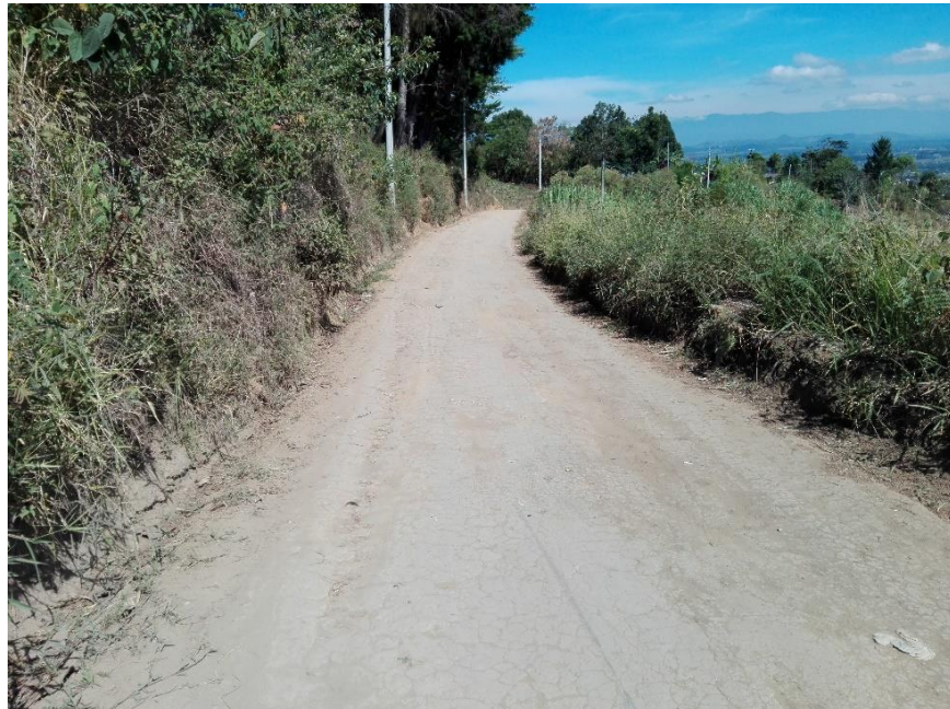
Figura 19. Tramo de vía con necesidad de poda en ambos lados
