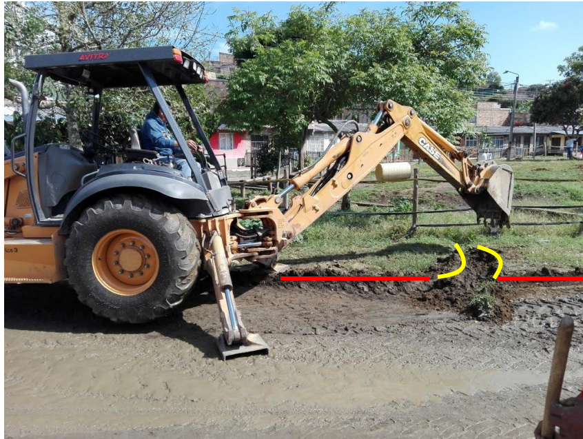
Figura 56. Retro cargador realizando zanja para evacuación de agua
