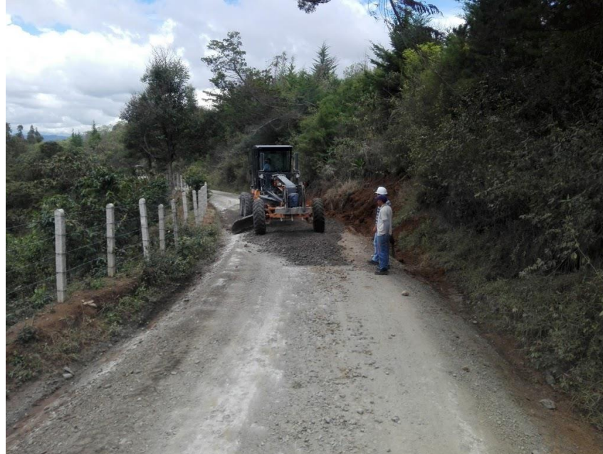
Figura 38. Motoniveladora extendiendo material en zonas con baches
