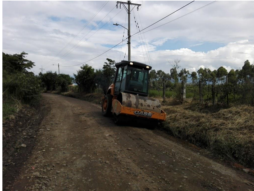
Figura 29. Vibro compactador comprimiendo material restante en cunetas
