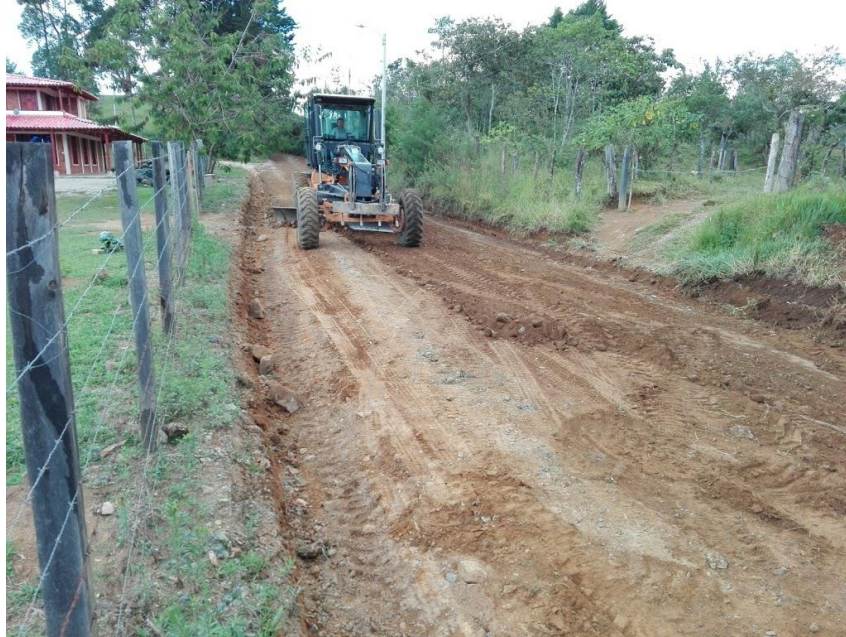
Figura 34. Motoniveladora realizando conformación de la vía
