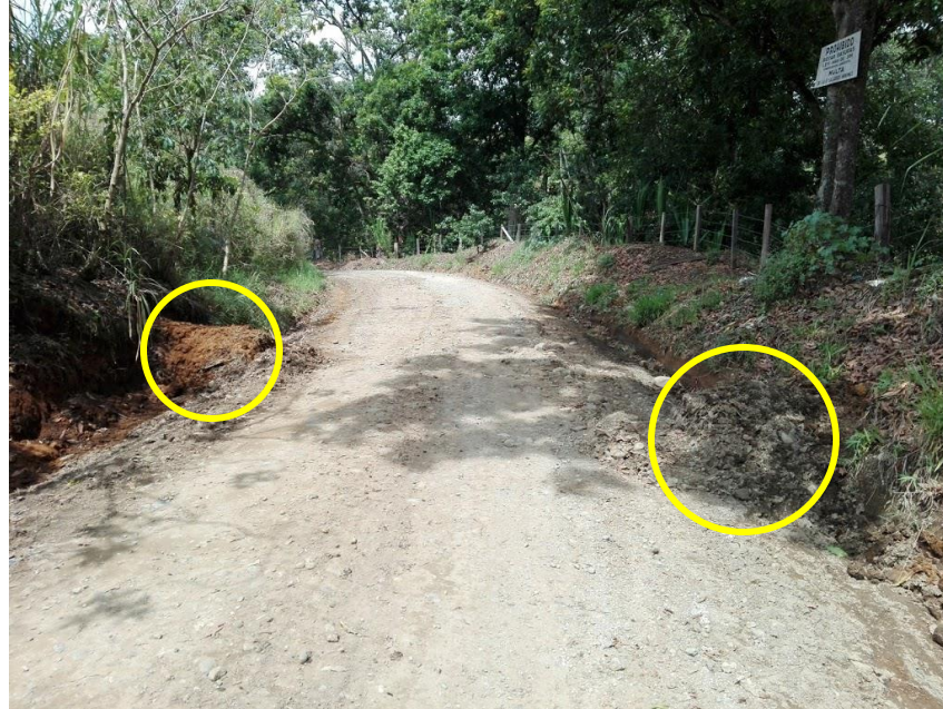
Figura 25. Acumulación de material dejada por las motoniveladoras
