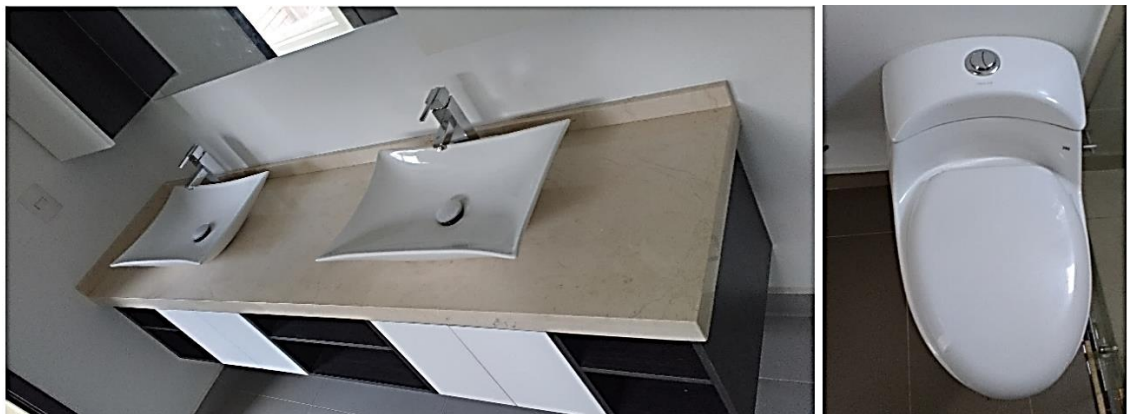
Figura 76 Instalación de lavamanos y sanitario
