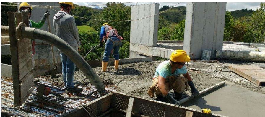
Figura 47 Distribución y nivelación del concreto
