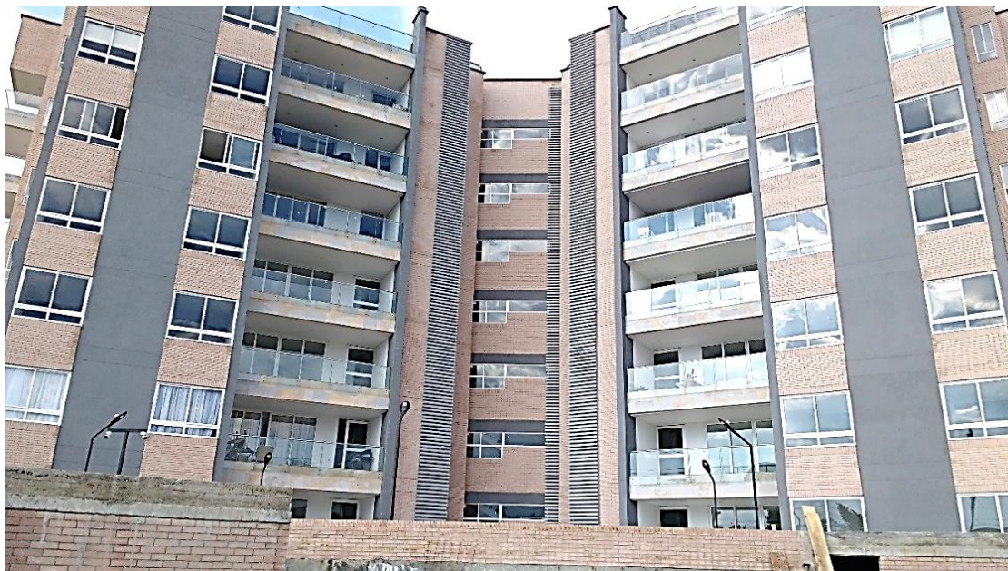
Figura 2 Fachada de torre 1
