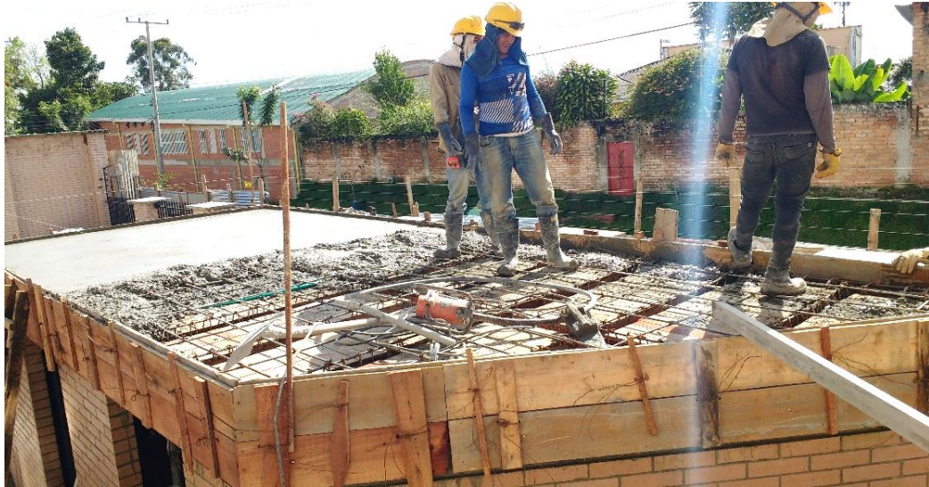
Figura 62 Fundición de losa aligerada
