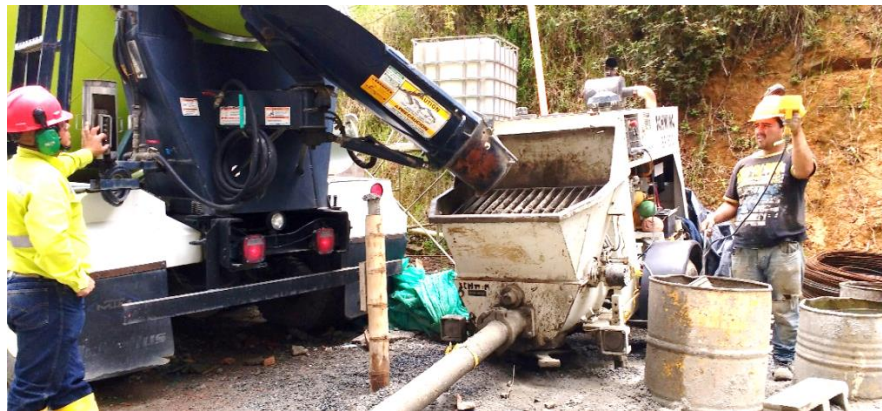
Figura 46 Bombeo del concreto
