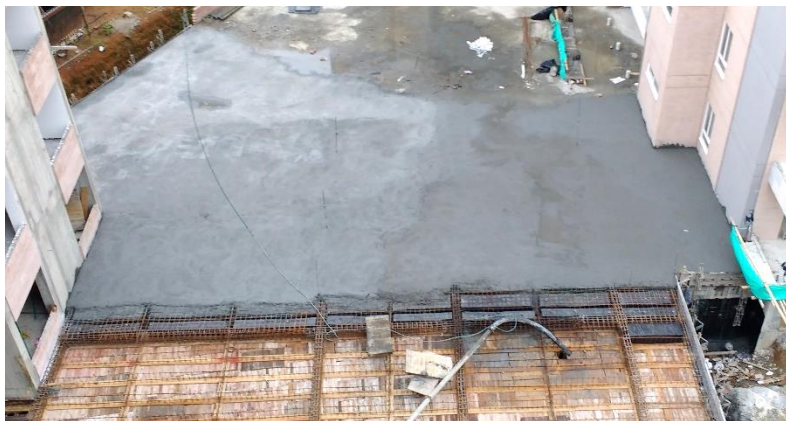
Figura 26 Fase 1 de fundición terminada
