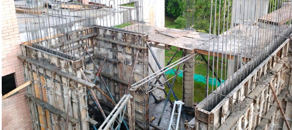
Figura 50 Formaleta metálica unispan para pantallas
