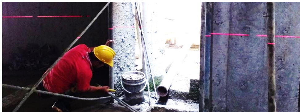
Figura 21 Toma de niveles con laser
