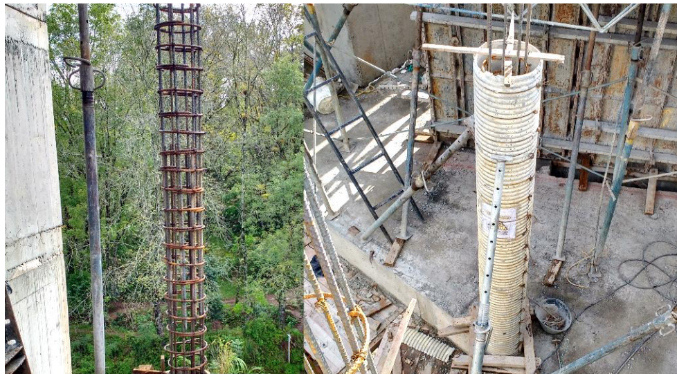
Figura 49 Formaleta de PVC para columna circular
