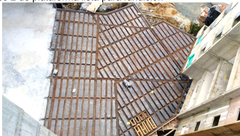
Figura 28 Fase 2 de plataforma lista para fundición
