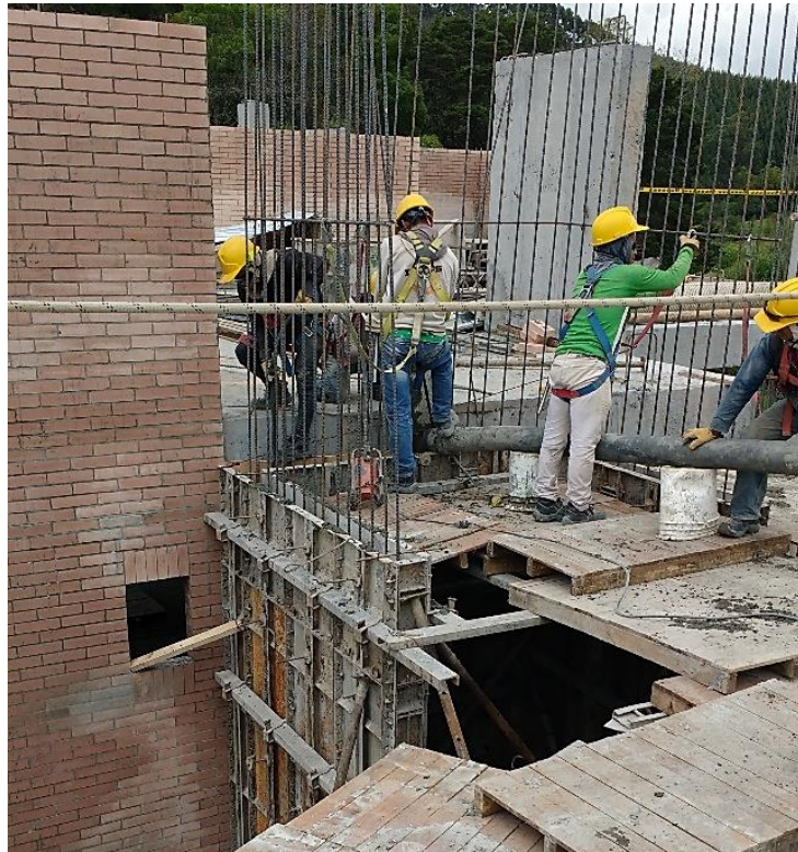
Figura 88 Trabajador asegurando gancho en foso ascensor
