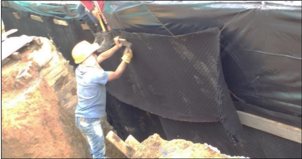
Figura 41 Instalación de geodren planar
