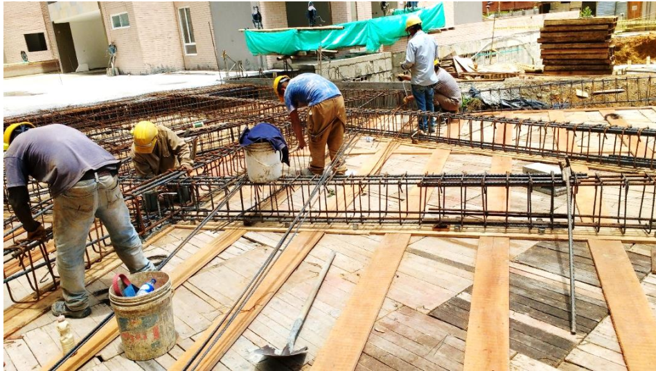
Figura 15 Armado de acero de refuerzo para vigas y nervios
