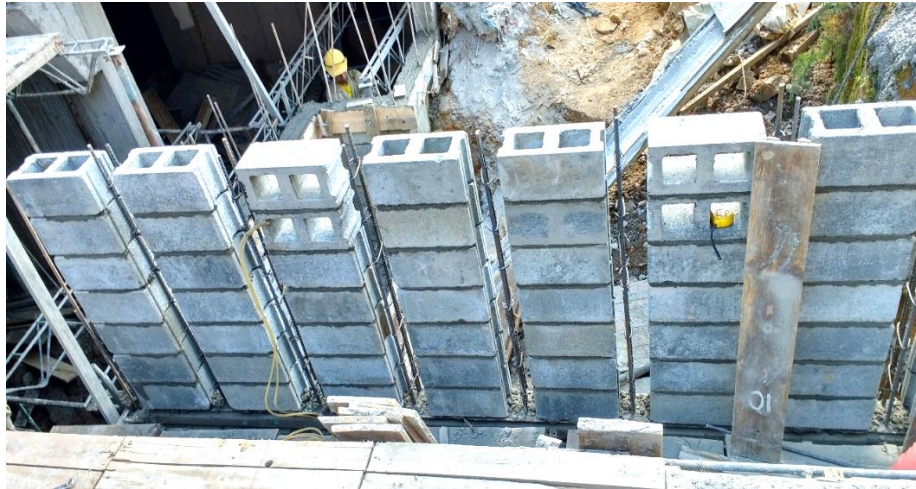
Figura 31 Armado del muro de contención
