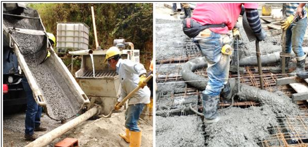
Figura 22 Vaciado del concreto
