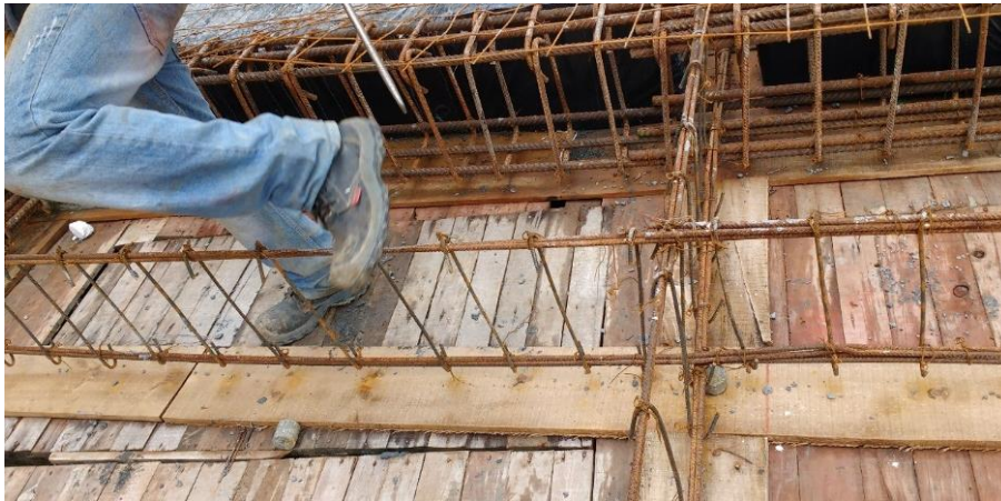
Figura 72 Correcta separación de estribos
