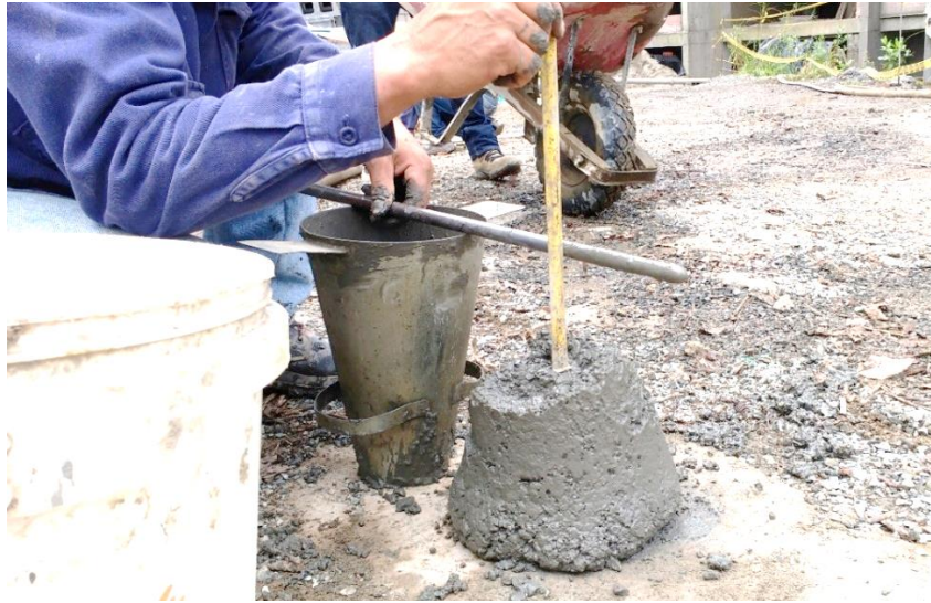
Figura 68 Toma de asentamiento del concreto
