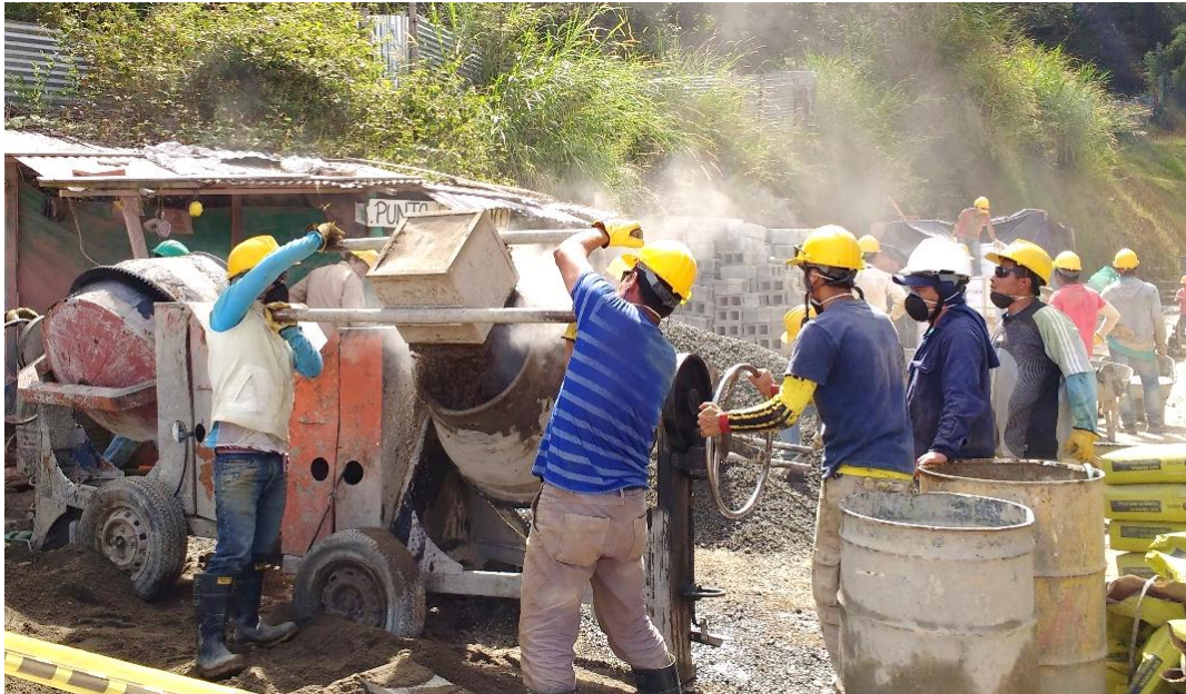
Figura 70 Medida en volumen del agregado con cajones
