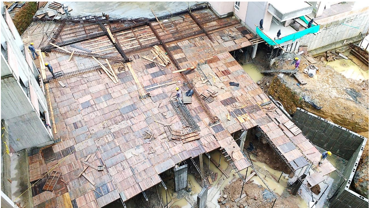
Figura 14 Superficie de tableros para plataforma
