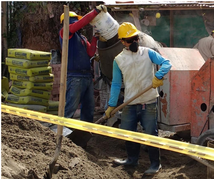
Figura 83 Elementos de protección personal exigidos en obra
