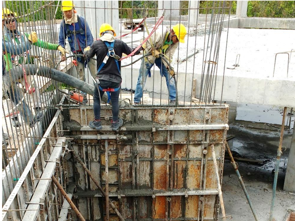
Figura 52 Vaciado y vibrado de concreto en formaletas
