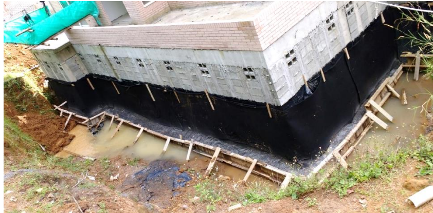
Figura 34 Obras de evacuación de agua del muro de contención
