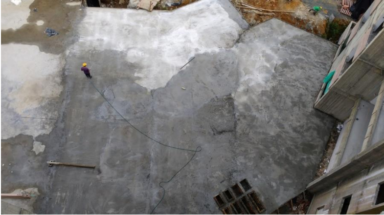
Figura 29 Losa plataforma terminada
