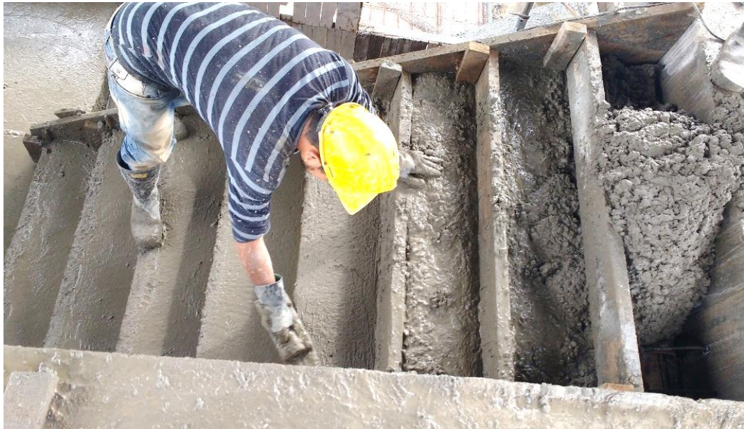
Figura 56 Colocación de concreto en escaleras
