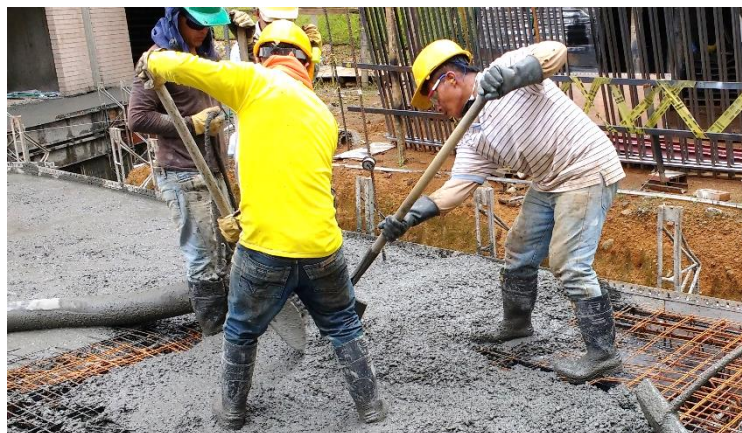
Figura 23 Distribución del concreto
