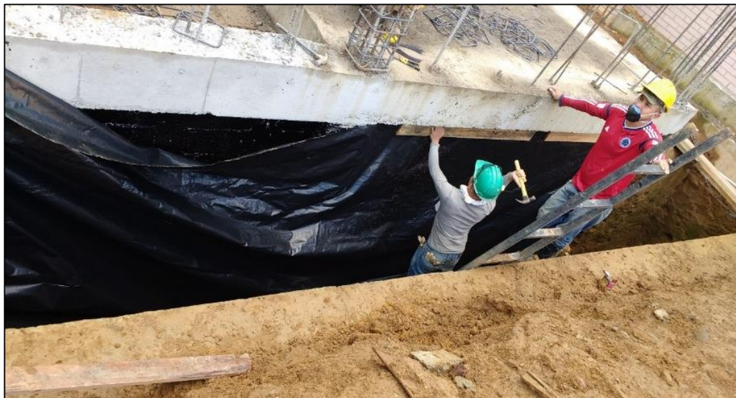
Figura 40 Instalación de plástico negro sobre impermeabilizante
