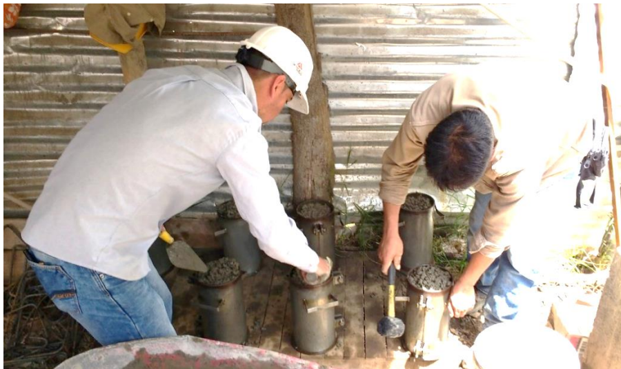
Figura 69 Toma de muestras de concreto para resistencias
