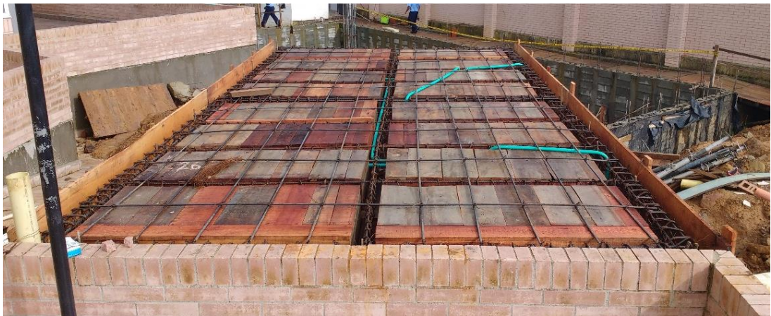
Figura 61 Instalación de casetones y acero de refuerzo
