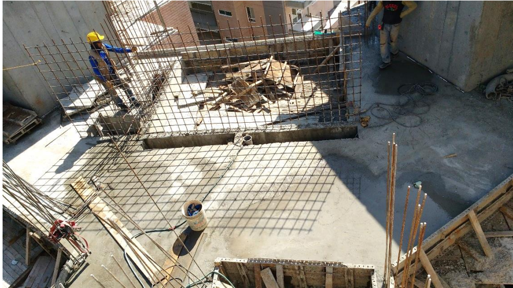
Figura 48 Losa de punto fijo terminada
