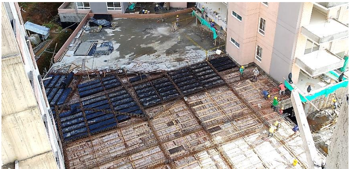
Figura 19 Instalación de casetones
