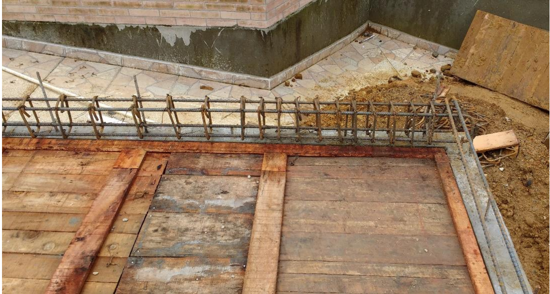
Figura 60 Armado de acero de refuerzo
