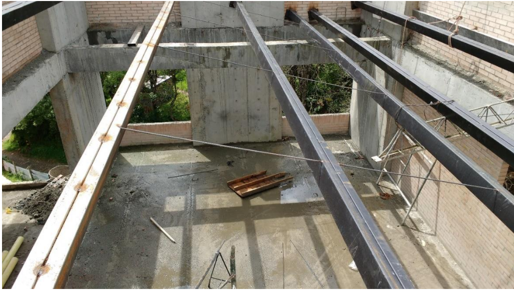
Figura 63 Perlina y tensores de cubierta metálica
