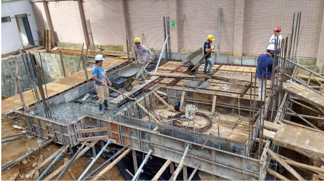
Figura 37 Fundición de losa de entresuelo cancha squash
