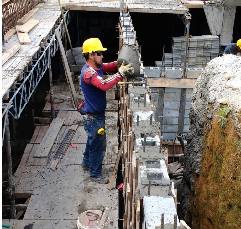
Figura 33 Llenado de encofrado para columnetas
