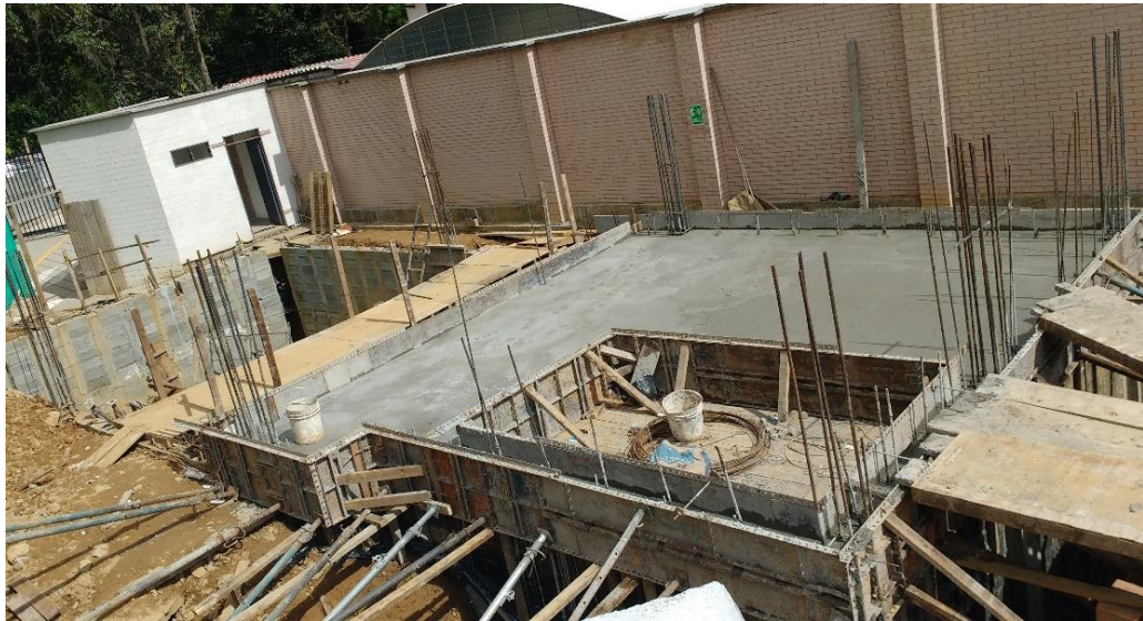
Figura 38 Finalización de losa de entresuelo
