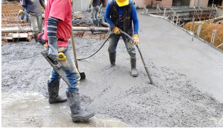
Figura 24 Vibrado del concreto
