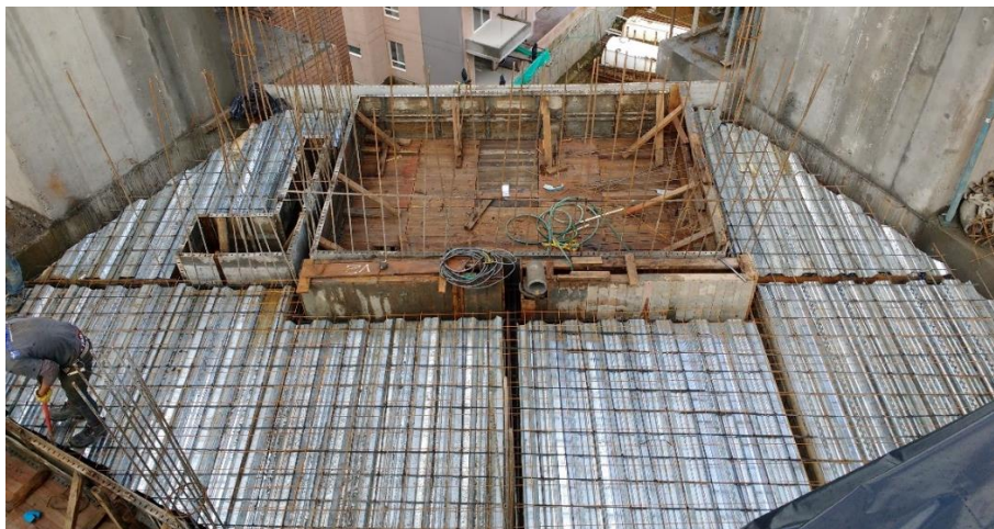
Figura 45 Instalación de acero de refuerzo y encofrado para vigas
