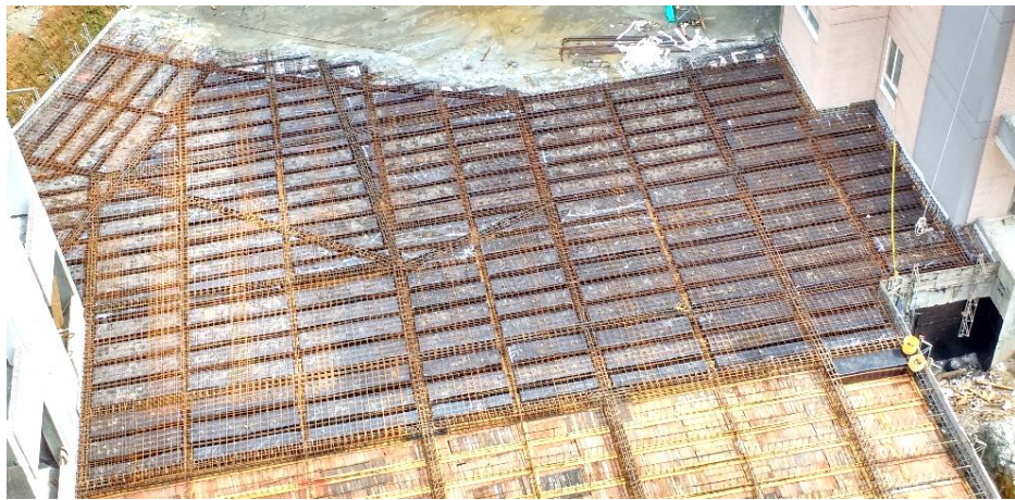
Figura 20. Instalación de casetones y acero de refuerzo para fase1
