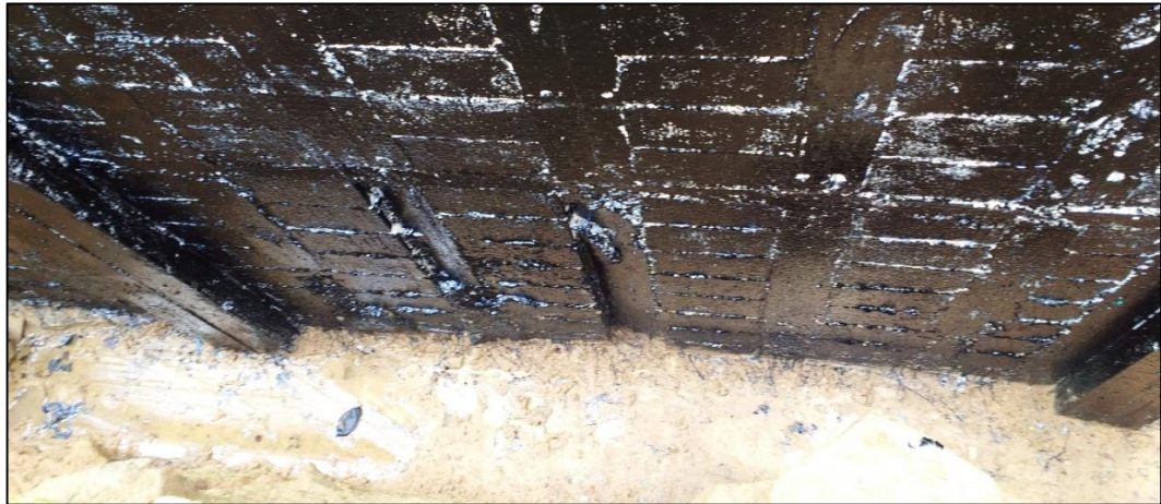
Figura 39 Aplicación de impermeabilizante igol denso sika
