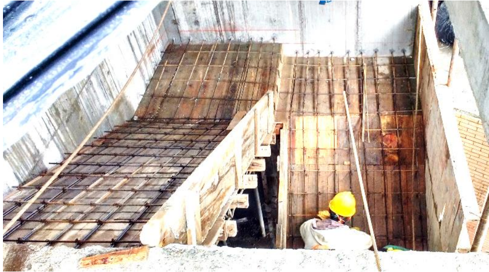
Figura 54 Acero de refuerzo para escaleras
