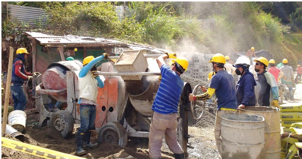
Figura 55 Elaboración de concreto en obra
