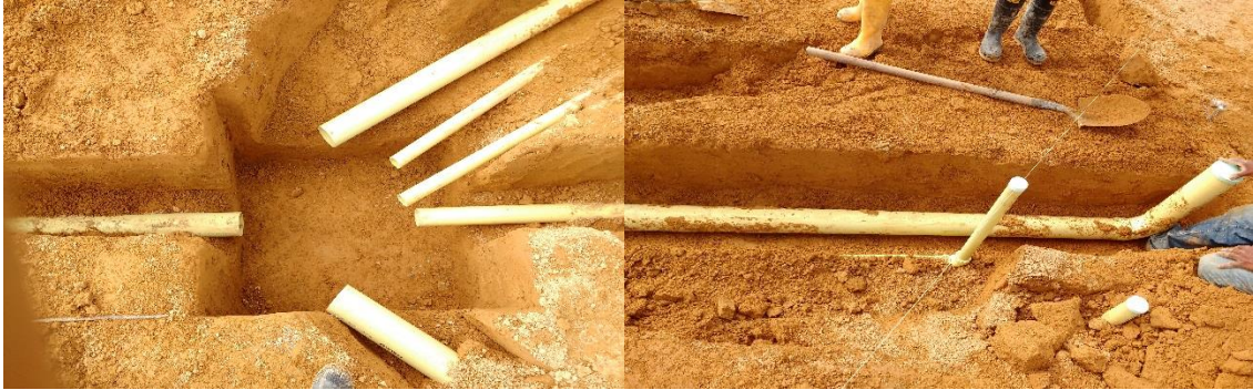
Figura 23. Instalación tubería sanitaria, caja de inspección.
