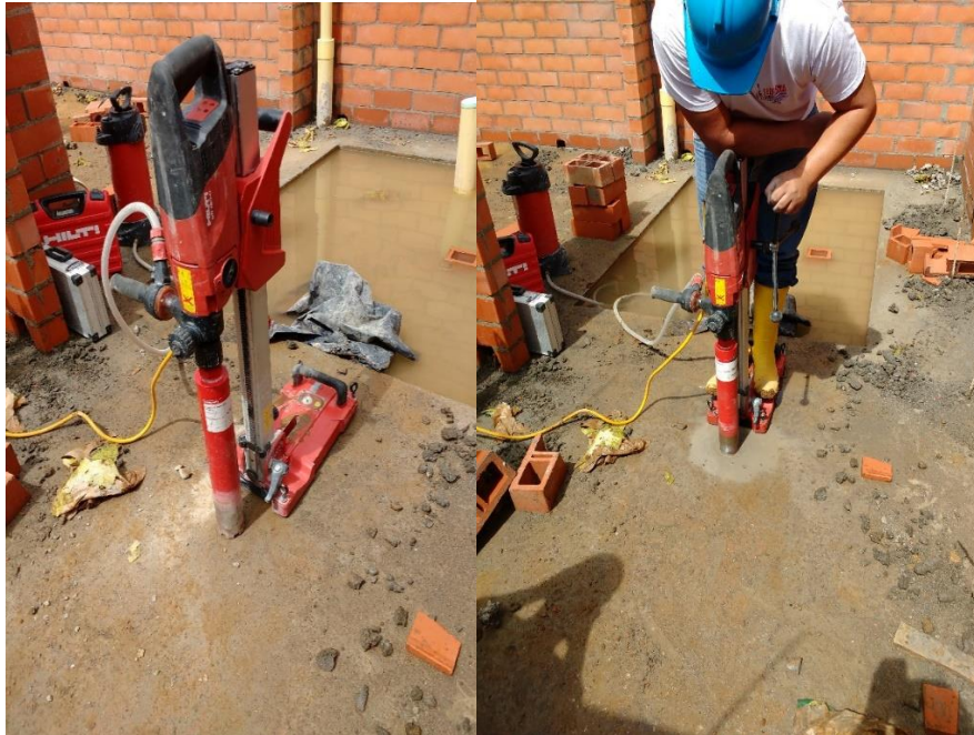
Figura 41. Equipo y extracción de núcleos
