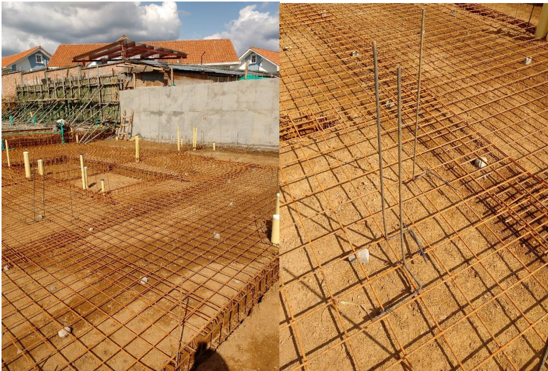
Figura 100. Chequeo de ubicación de acero de dovelas 3/8"
