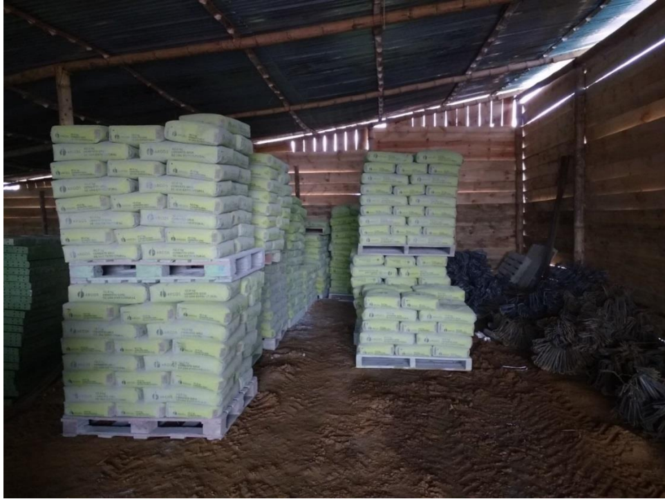
Figura 11. Almacenamiento del cemento
