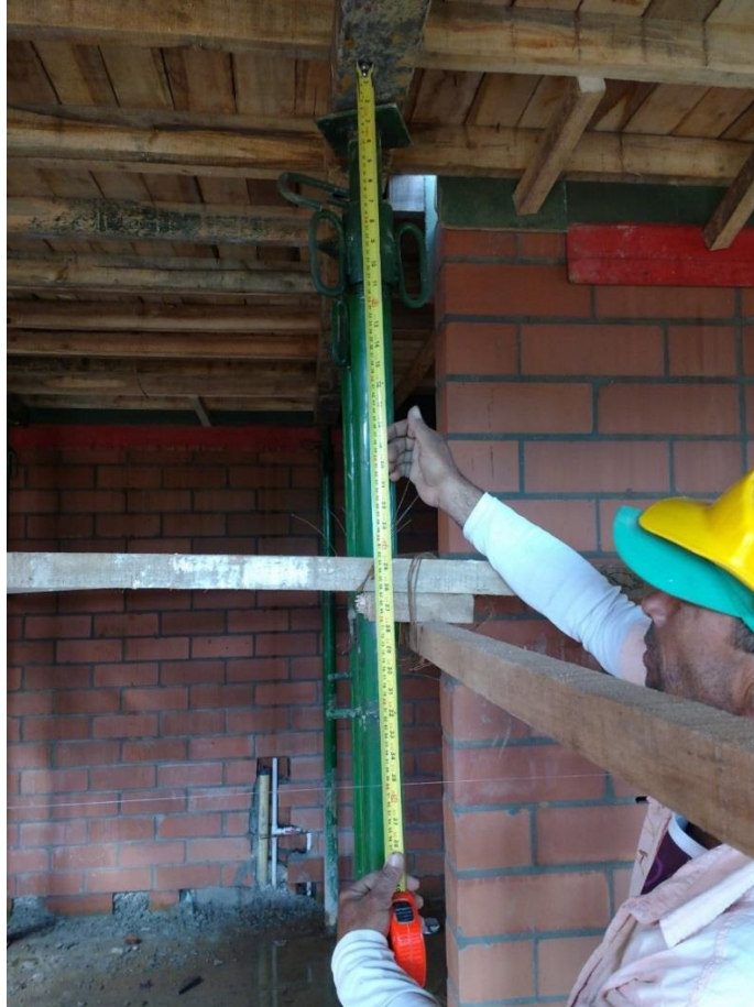
Figura 250. Nivelación en losa de entrepiso para su posterior fundición
