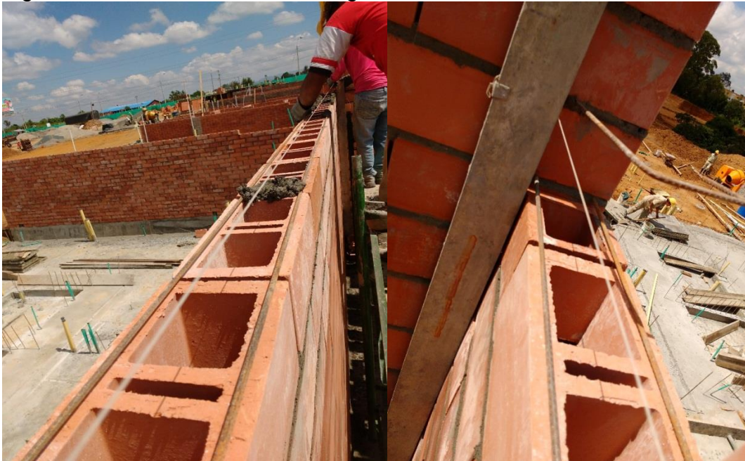
Figura 58. Correcta colocacion de grafiles
