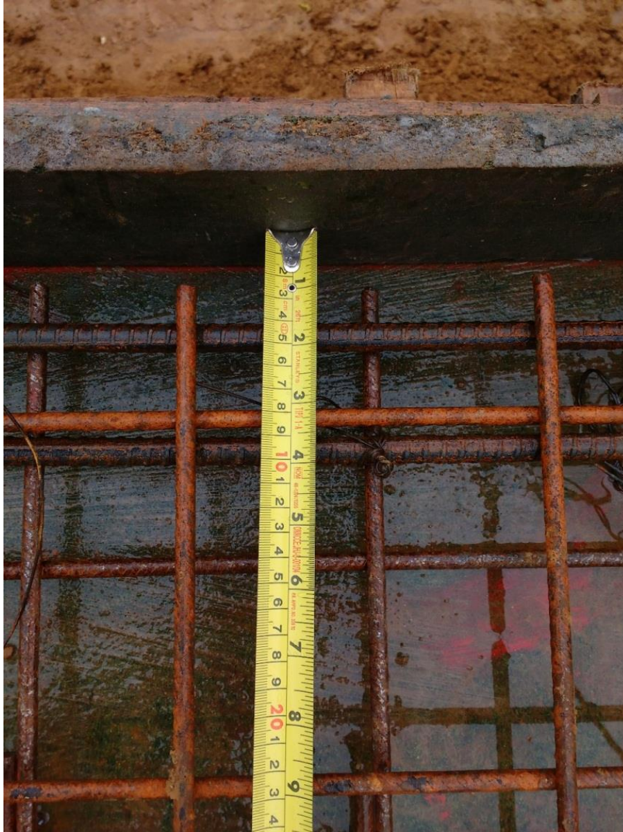
Figura 327. Corrección en la separación del refuerzo en V4
