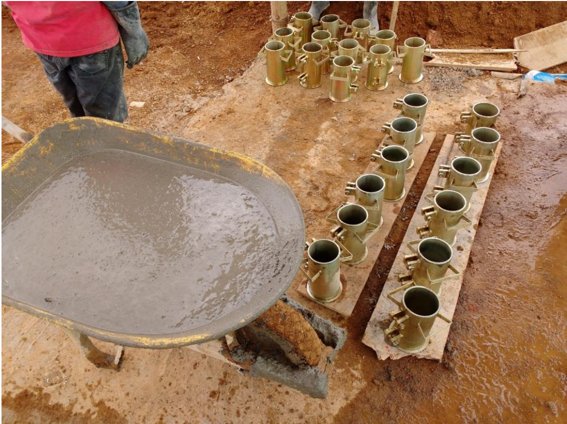
Figura 36. Concreto con agregado grueso 3/8" ( Grouting )
