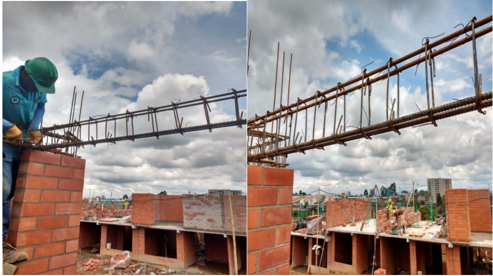
Figura 69. Corrección acero viga de amarre
