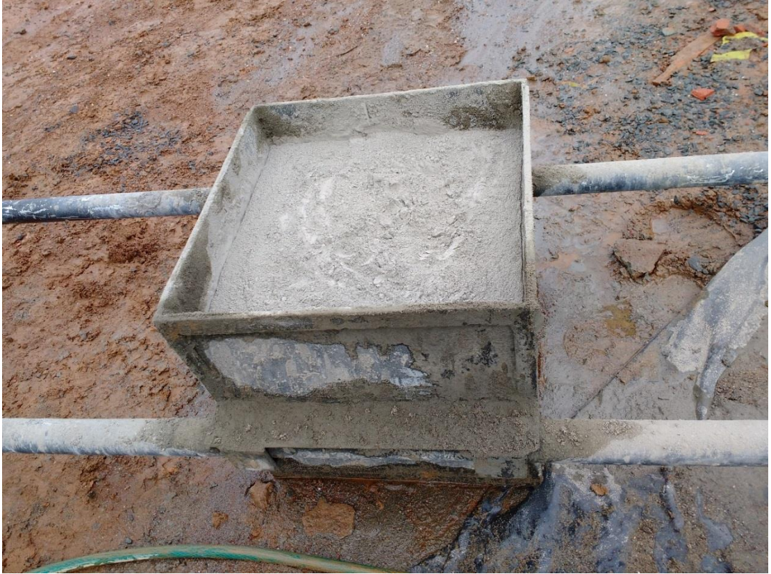
Figura 12. Volumen saco de cemento de 42,5kg en cajón de 0,35 3
