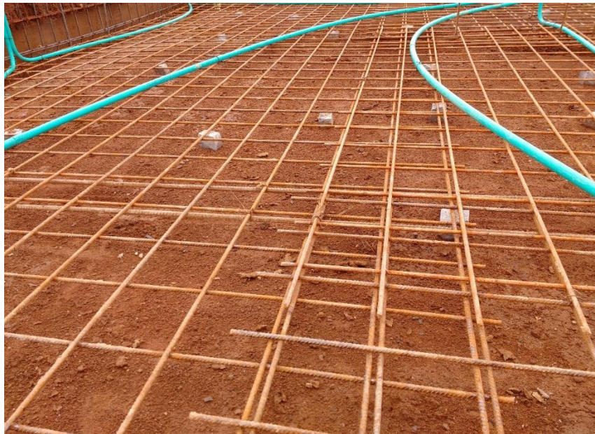
Figura 29. Reubicación aceros de refuerzo losa de cimentación
