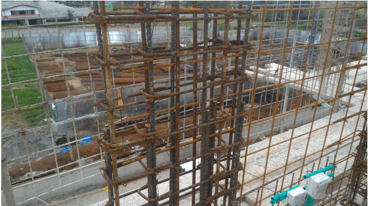
Figura N° 12: Elemento de borde con estribos.
