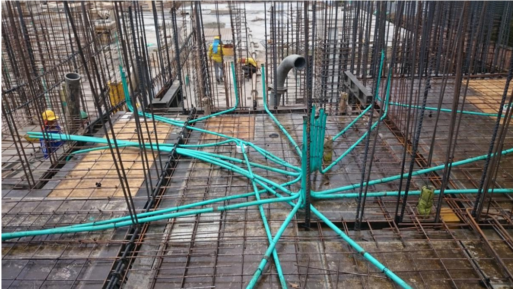
Figura N° 38: Tubería losa de entrepiso.
