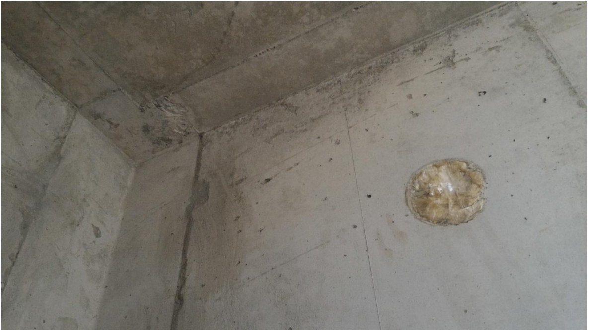
Figura N° 39: Pase circular para sifón.
