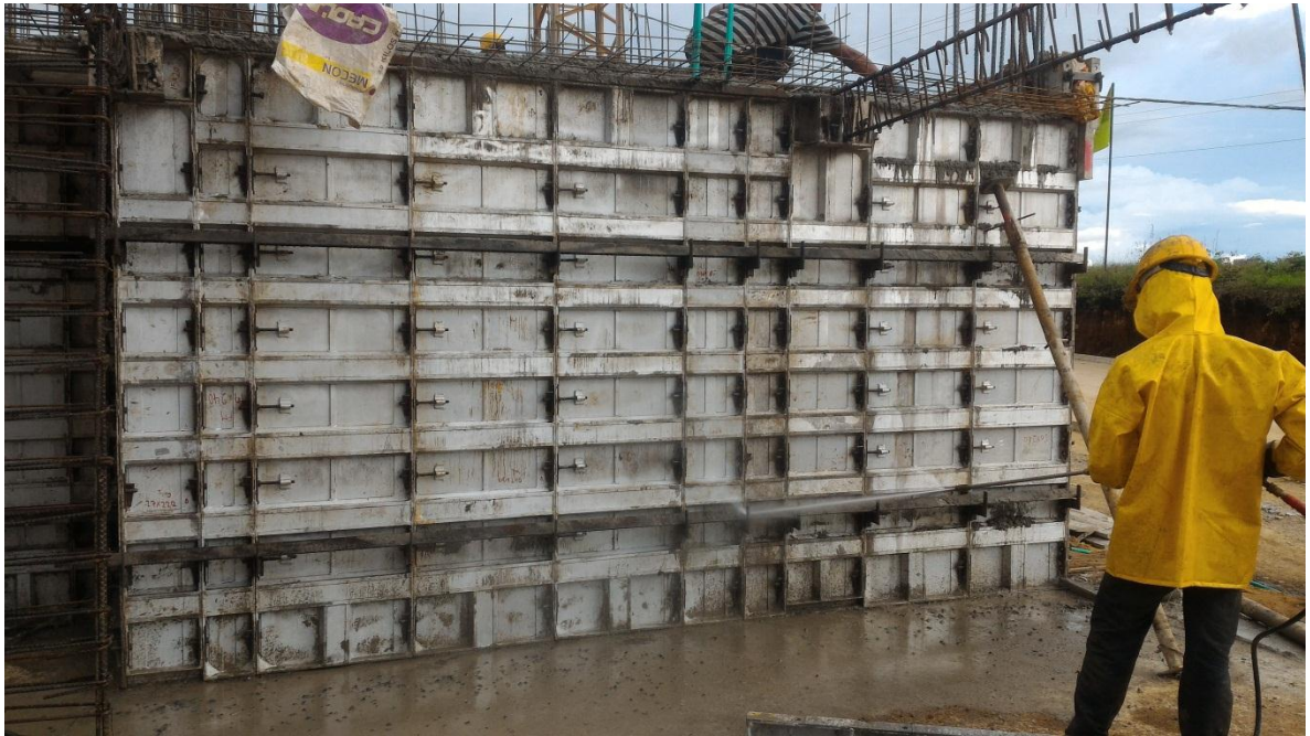
Figura N° 33: Encofrado de apartamento torre C.
