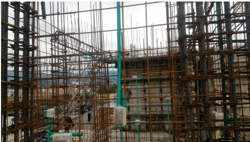
Figura N° 19: Tubería eléctrica para interruptores en pantallas.
