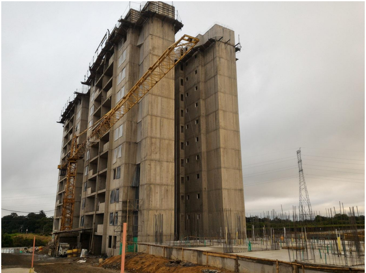
Figura N° 4: continuación de la construcción de la torre D, doceavo piso
