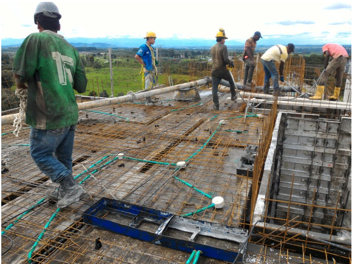
Figura N° 41: Fundición, malla superior instalada.
