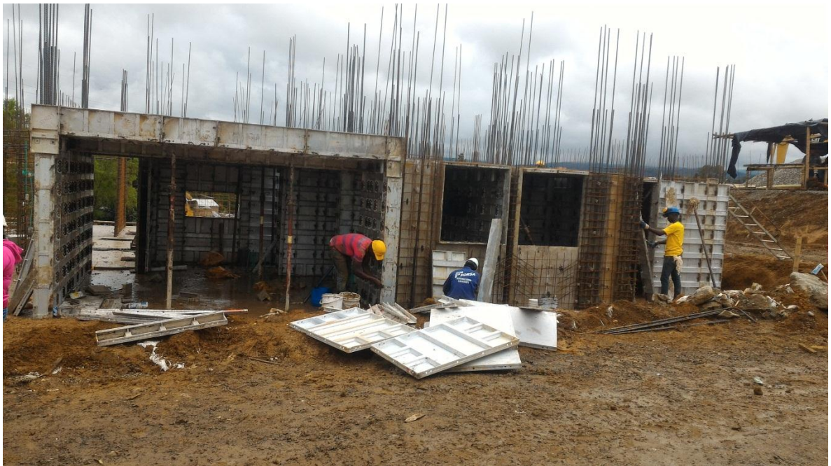
Figura N° 32: Encofrado de apartamento torre C.
