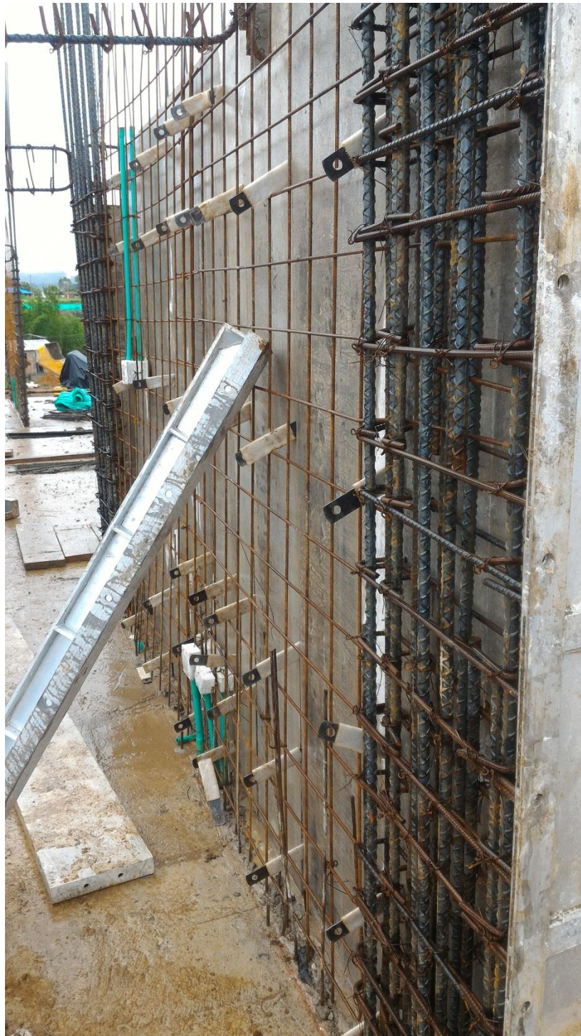
Figura N° 35: Encofrado de muro con formaleta Forsa.
