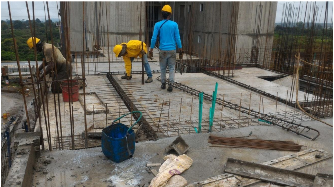
Figura N° 36: Malla inferior losa de entrepiso.
