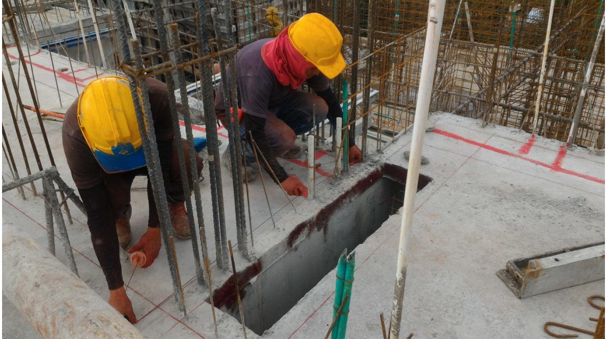
Figura N° 5: cimbrado de ejes de doceavo piso torre D
