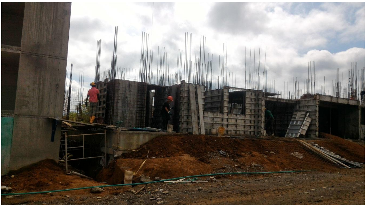
Figura N° 34: Encofrado de apartamento torre C..
