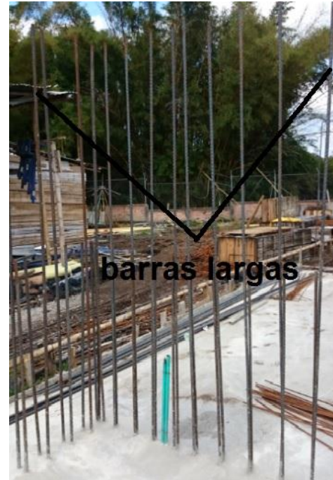
Figura N° 9: Barras largas elemento.
