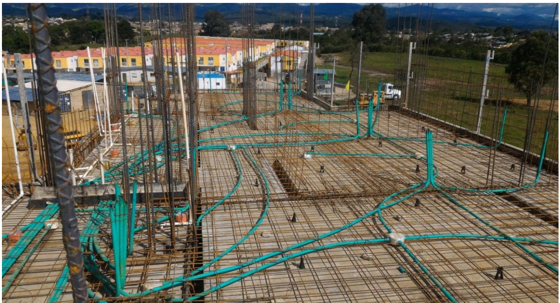
Figura N° 17: Tubería instalada en la losa.
