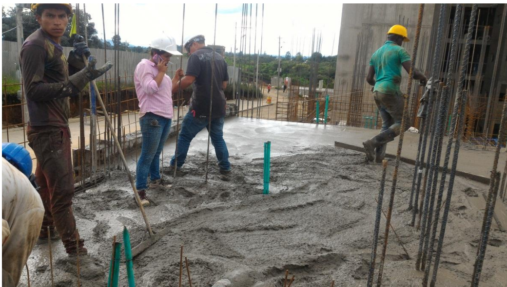
Figura N° 42: Fundición de apartamento.
