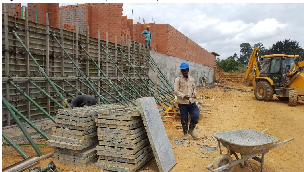
Figura 44. Fundición cuerpo del muro y formaleta.
