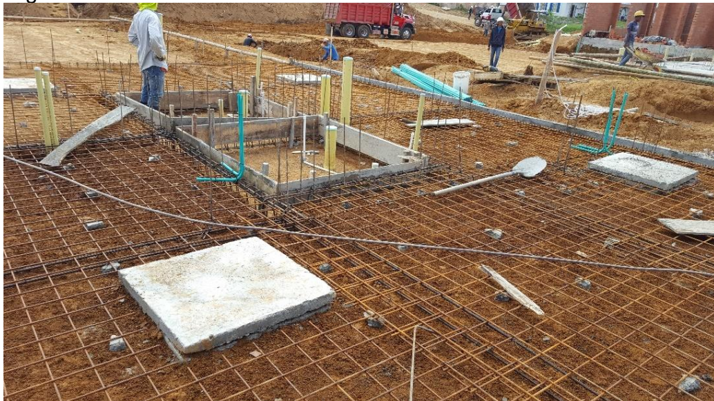
Figura 31. Acero listo en losa de cimentación.
