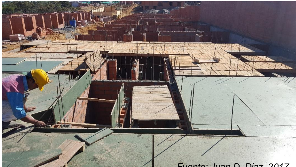
Figura 34. Formaleta losa de entrepiso.
