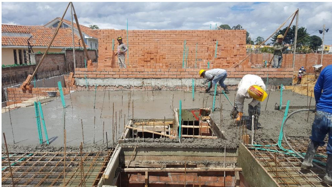
Figura 46. Acabado losa de entrepiso.
