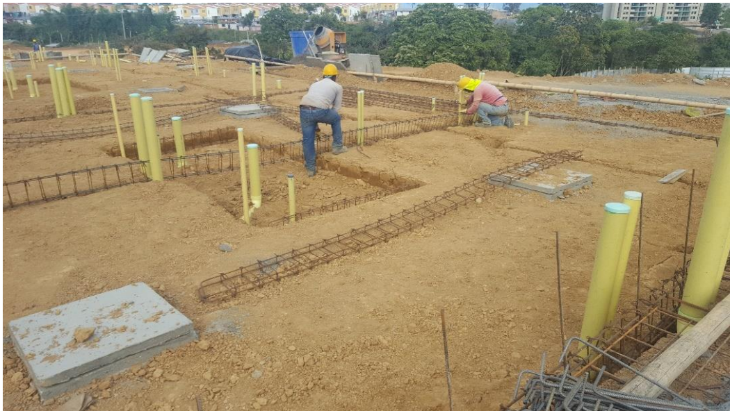
Figura 31. Acero listo en losa de cimentación.
