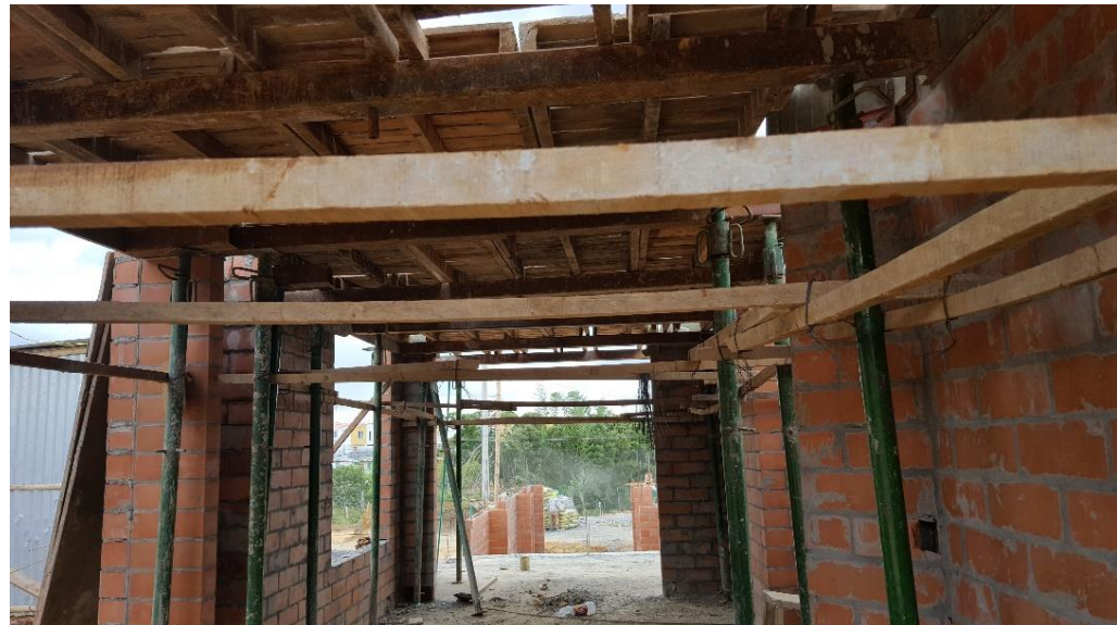
Figura 35. Nivelación losa de entrepiso.
