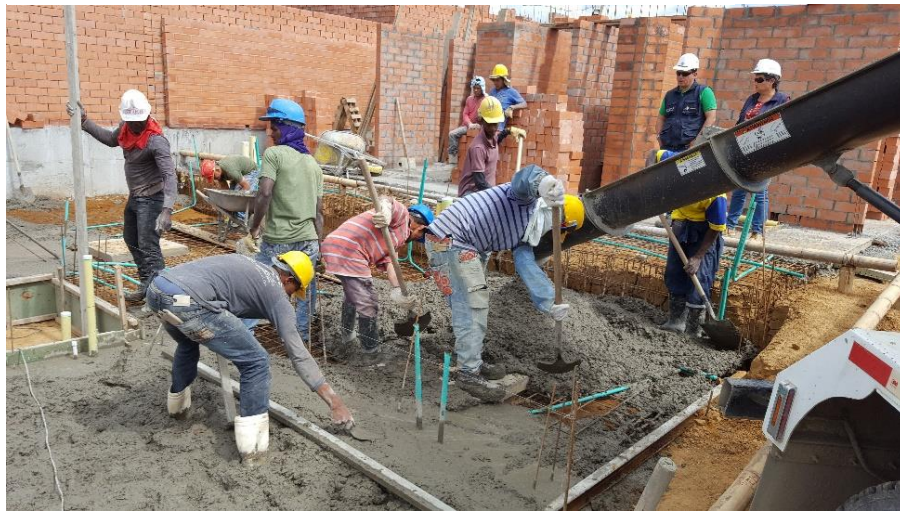
Figura 41. Fundición losa de cimentación.
