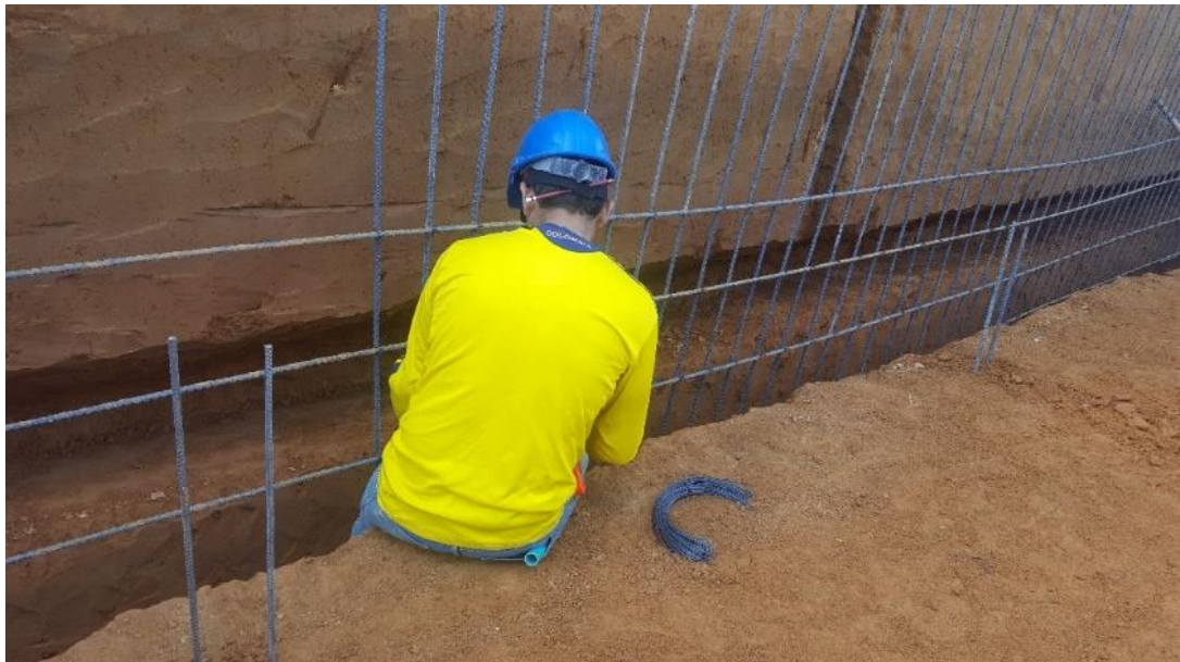
Figura 33. Acero zapata del muro.
