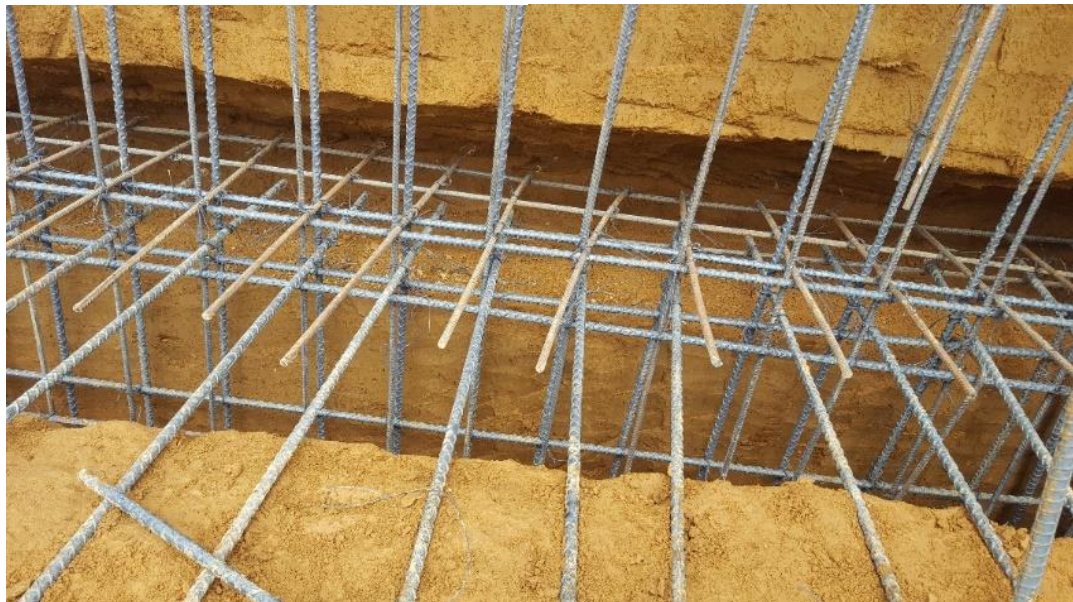
Figura 33. Acero zapata del muro.
