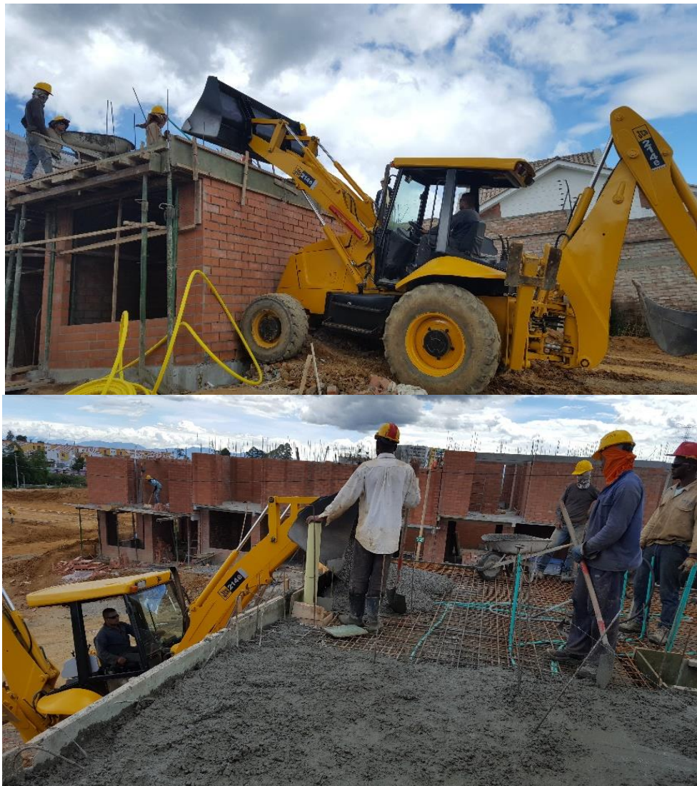
Figura 13. Fundición con retroexcavadora.
