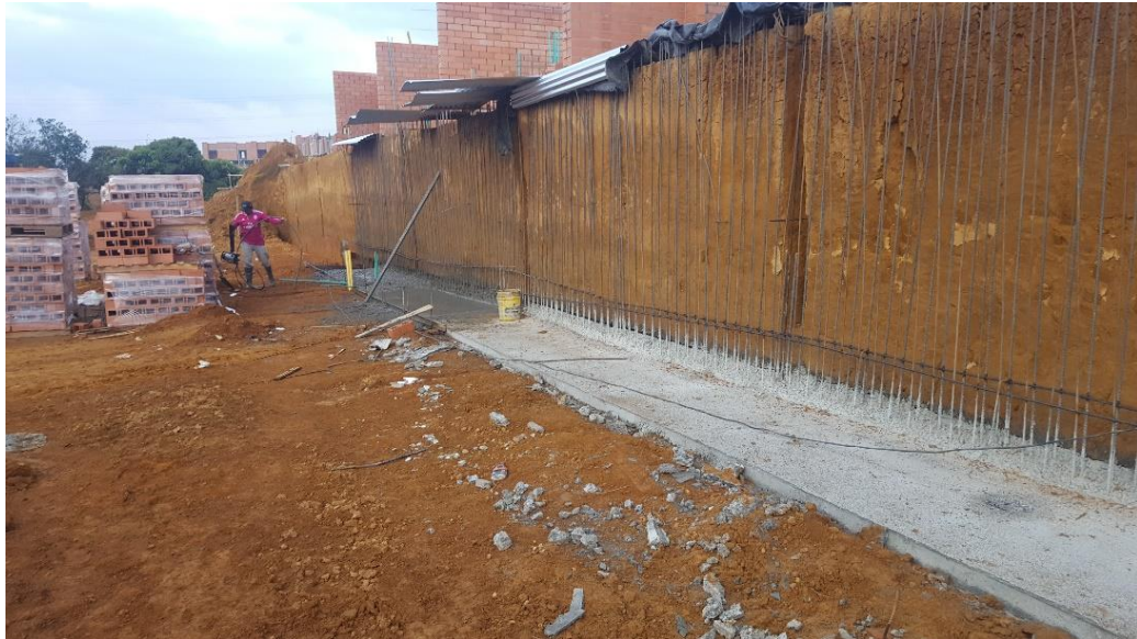
Figura 43. Fundición zapata del muro.
