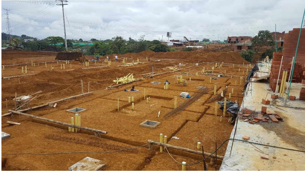
Figura 28. Instalación tubería sanitaria y pluvial.
