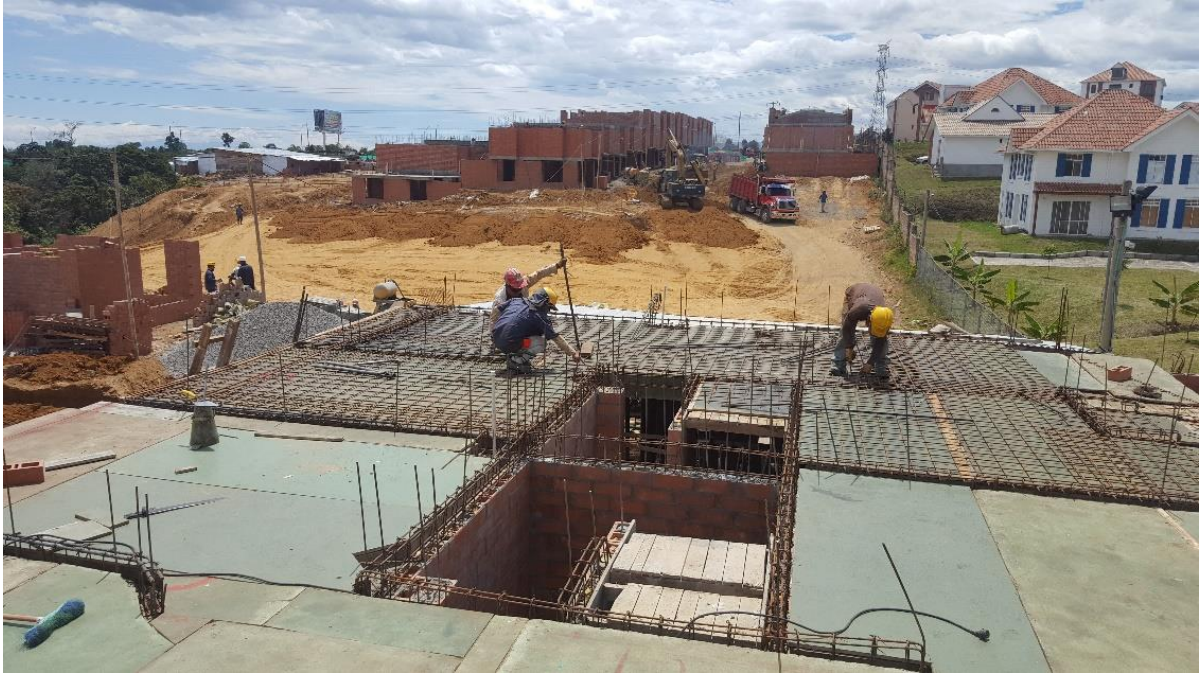
Figura 36. Acero losa de entrepiso.
