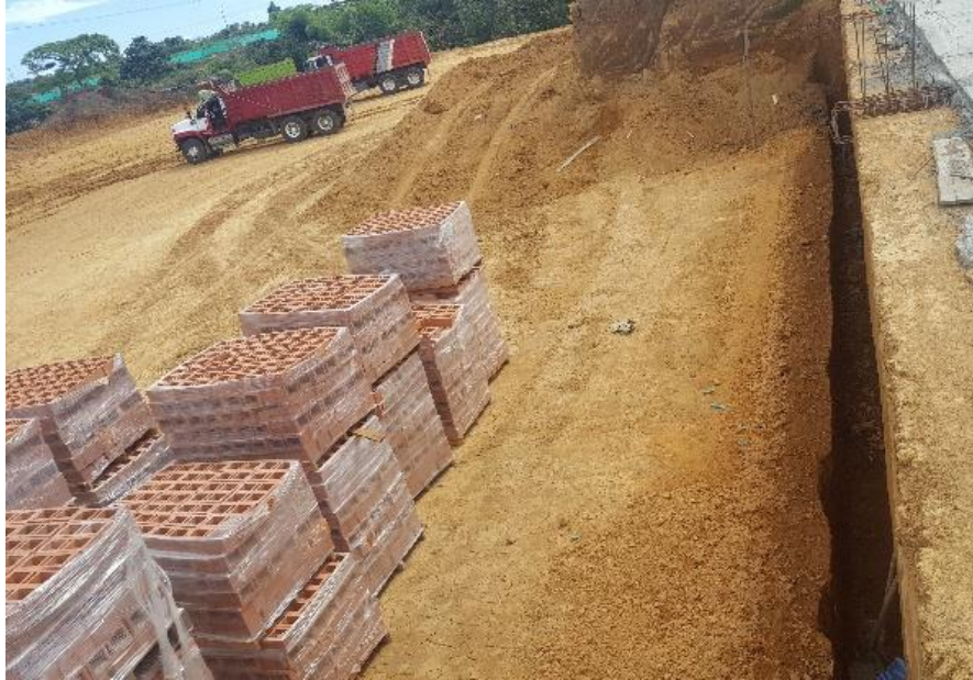
Figura 14. Almacenaje de ladrillo.
