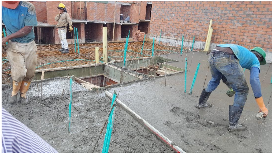
Figura 45. Fundición losa de entrepiso.
