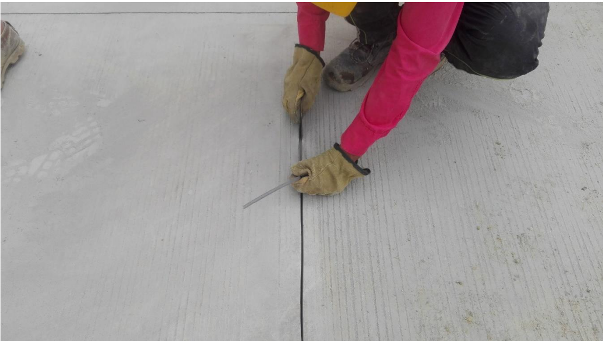
Fotografía 32. Sellado de dilataciones. ZikaRod 1/4. Fuente: Tomada por el pasante
