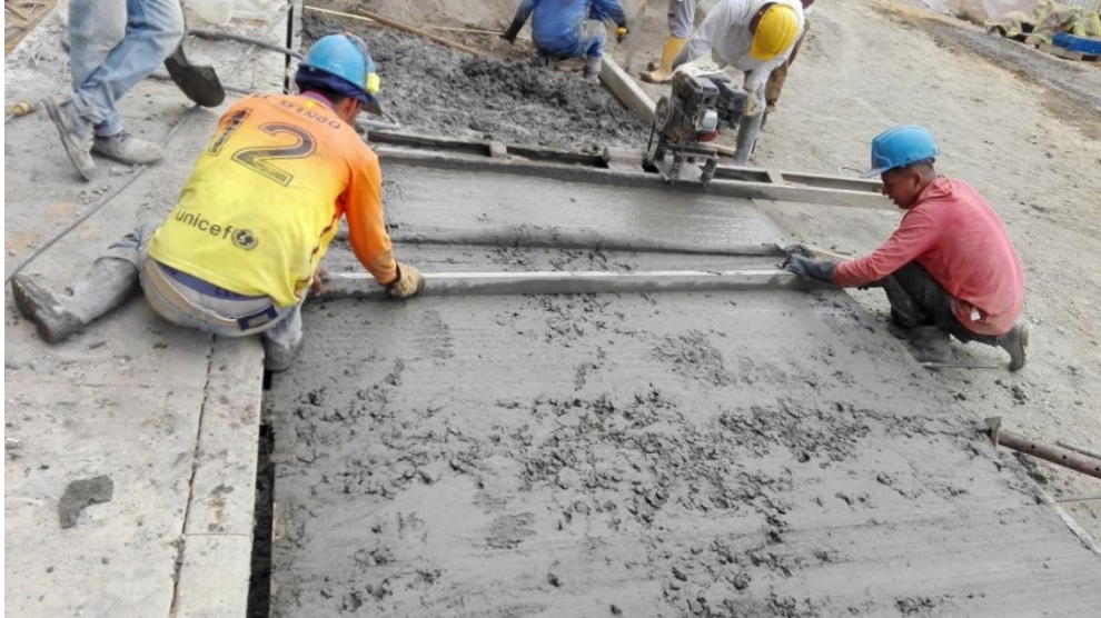
Fotografía 24. Nivelación de la superficie del pavimento. Fuente: Tomada por el pasante
