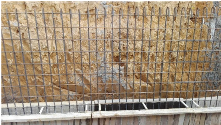
Fotografía 7. Refuerzo transversal y longitudinal del cuerpo del muro. Fuente: Tomada por el pasante
