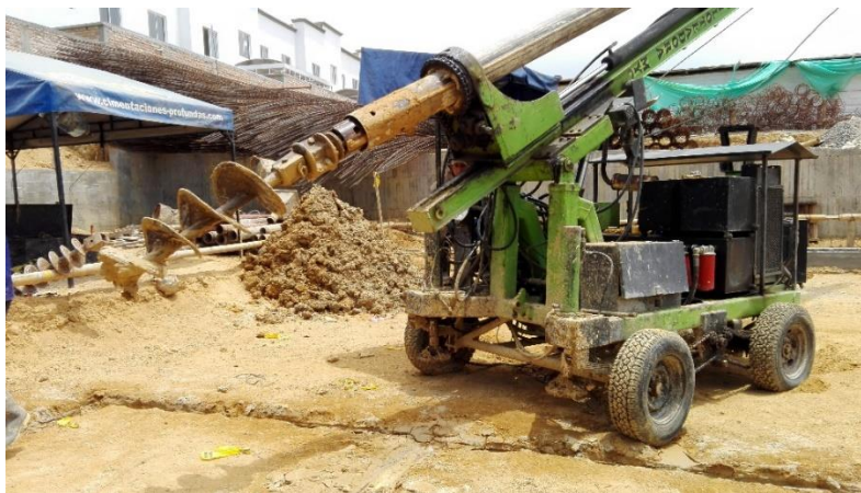
Fotografía 39. Piloteadora barreno helicoidal. Fuente: Tomada por el pasante
