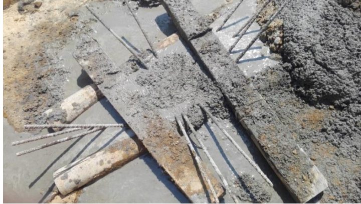
Fotografía 52. Fundición del pilote completada. Fuente: Tomada por el pasante
