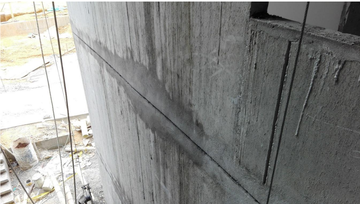
Fotografía 24. Resane de estrías Fuente: Tomada por el pasante
