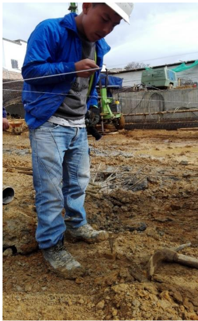
Fotografía 43. Localización del pilote con plomada. Fuente: Tomada por el pasante
