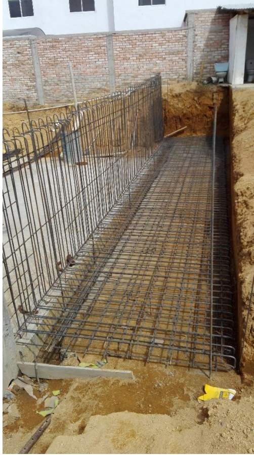
Fotografía 5. Armado del refuerzo muro 3. Fuente: Tomada por el pasante
