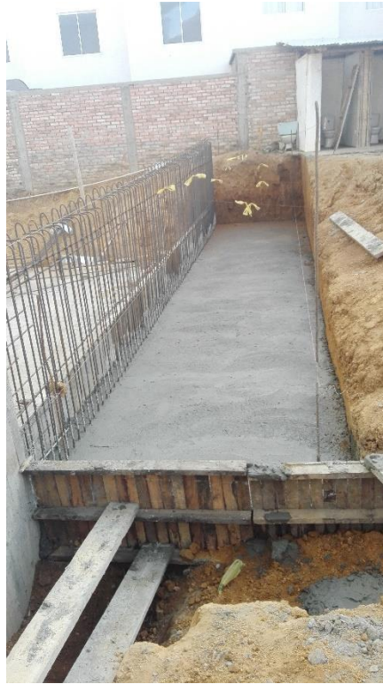
Fotografía 6. Fundición zapata muro 1. Fuente: Tomada por el pasante
