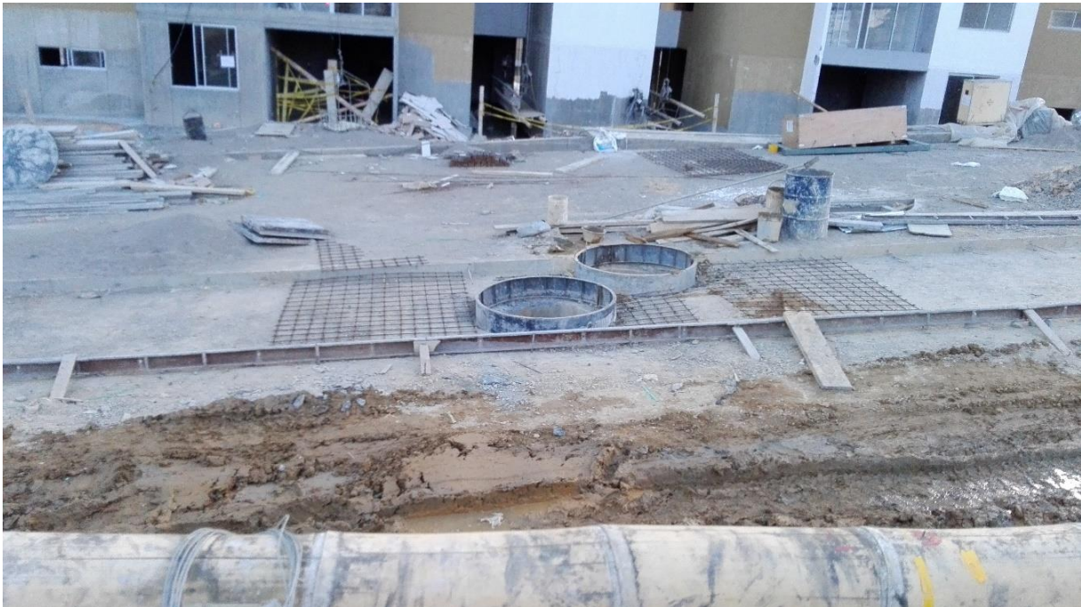
Fotografía 30. Curado del pavimento Fuente: Tomada por el pasante
