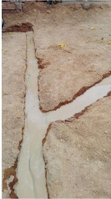
Fotografía 36. Cunetas para transporte del lodo. Fuente: Tomada por el pasante
