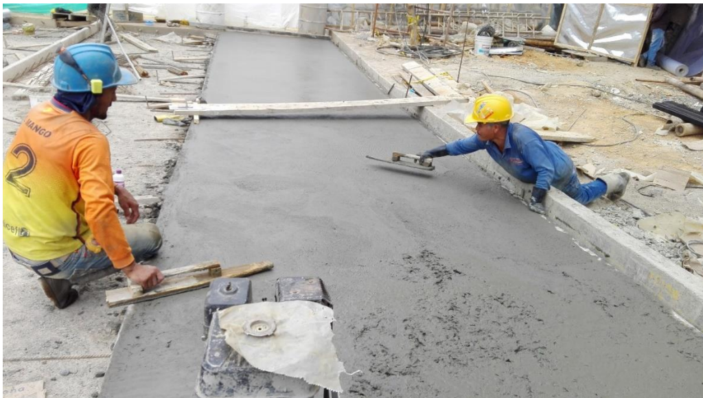
Fotografía 27. Acabado en la superficie del pavimento. Fuente: Tomada por el pasante
