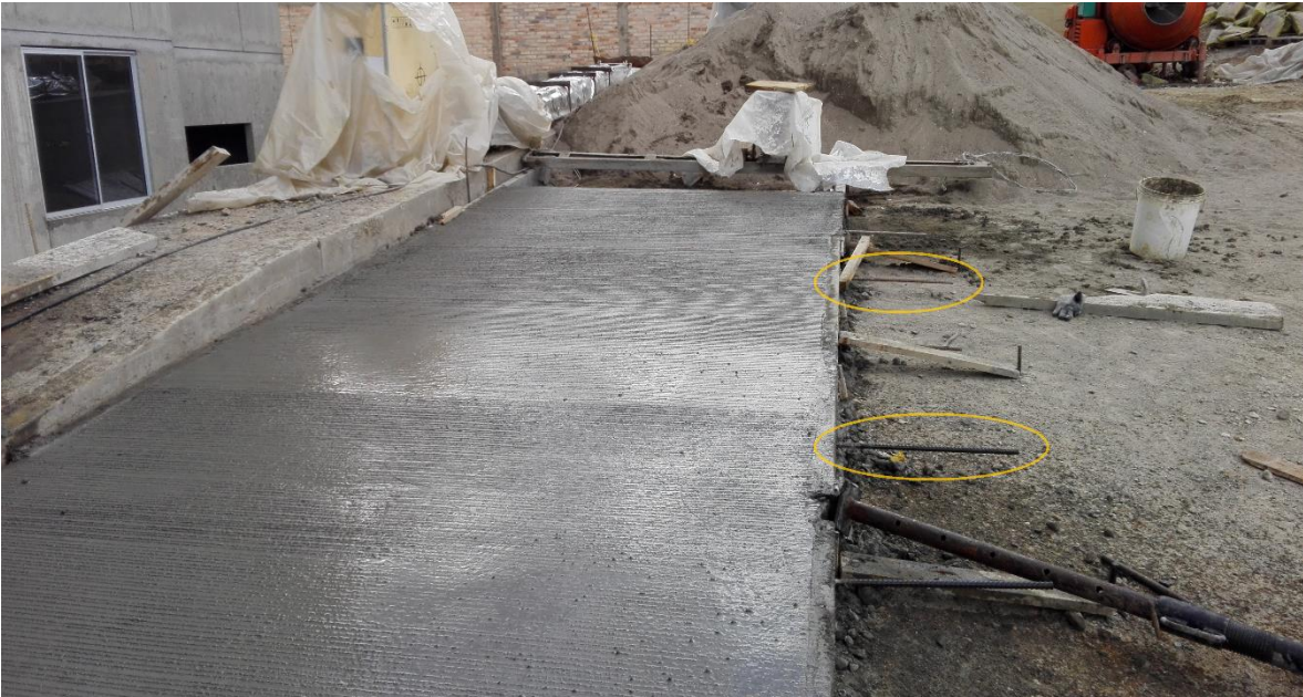
Fotografía 26. Refuerzo transversal. Fuente: Tomada por el pasante
