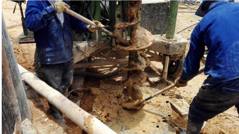
Fotografía 40. Limpieza de la perforación del pilote. Fuente: Tomada por el pasante
