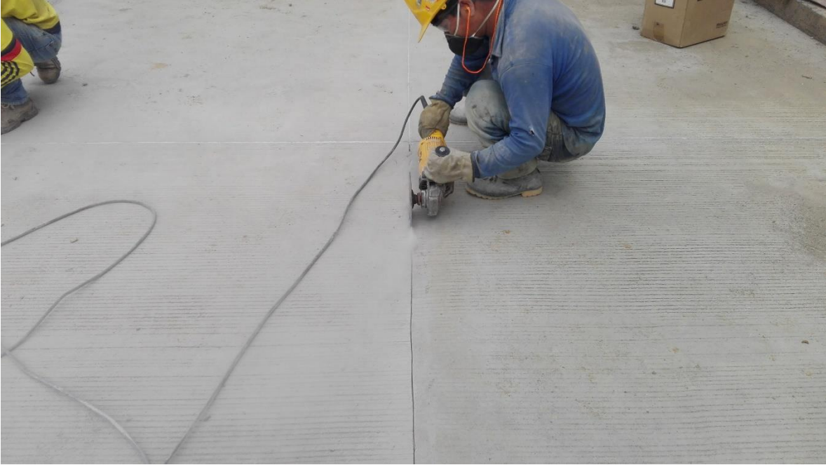
Fotografía 31. Corte del pavimento. Fuente: Tomada por el pasante
