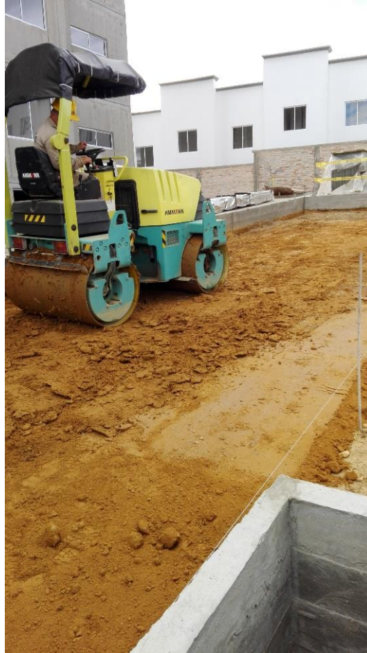
Fotografía 13. Compactación subrasante. Fuente: Tomada por el pasante
