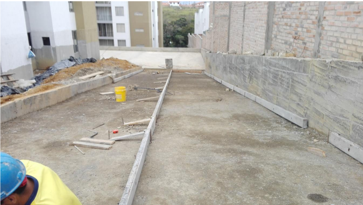
Fotografía 19. Formaleteado de la vía. Fuente: Tomada por el pasante
