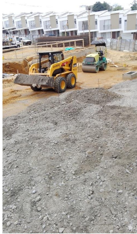
Fotografía 15. Minicargador depositando el material de subbase. Fuente: Tomada por el pasante
