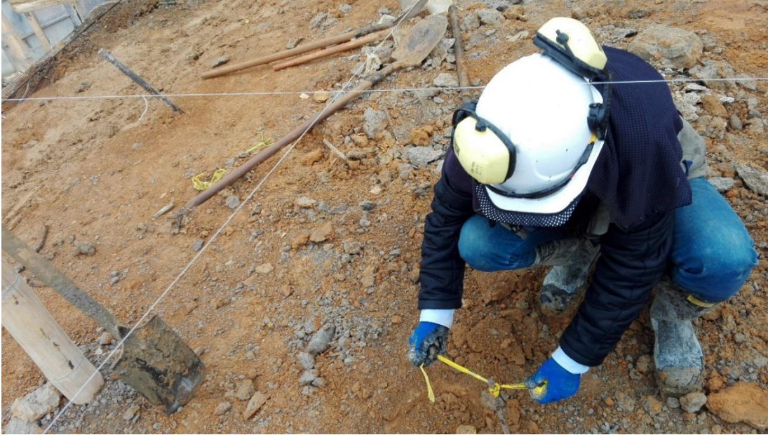
Fotografía 42. Templado de hilos. Fuente: Tomada por el pasante
