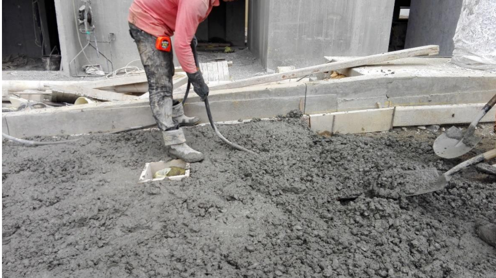
Fotografía 22. Proceso de vibrado. Fuente: Tomada por el pasante
