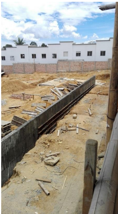
Fotografía 10. Muro Fundido. Fuente: Tomada por el pasante
