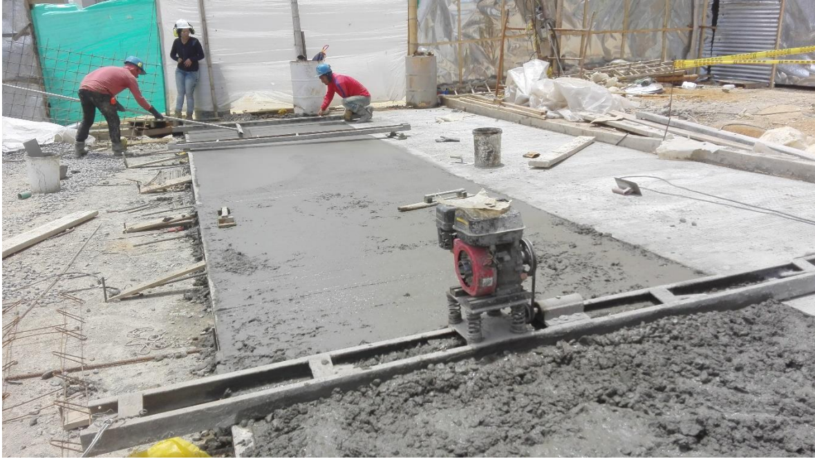
Fotografía 28. Acabado en la superficie del pavimento. Fuente: Tomada por el pasante
