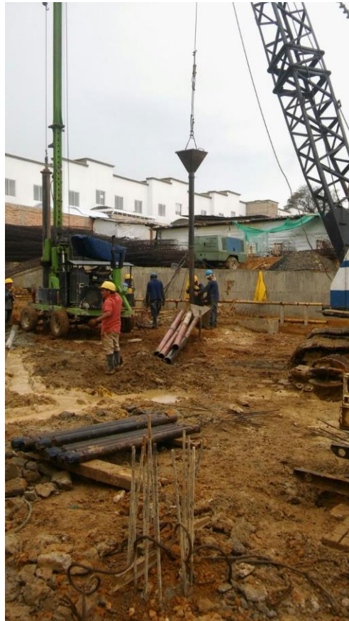
Fotografía 48. Instalación tubería de fundición. Fuente: Tomada por el pasante
