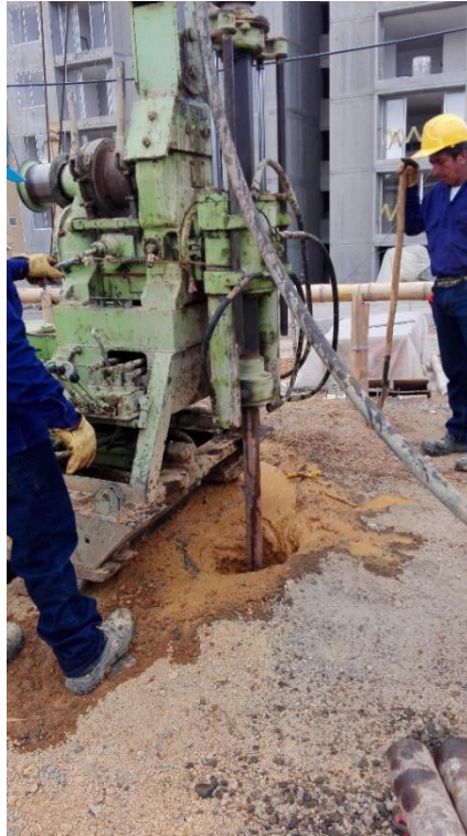
Fotografía 38. Piloteadora perforando. Fuente: Tomada por el pasante
