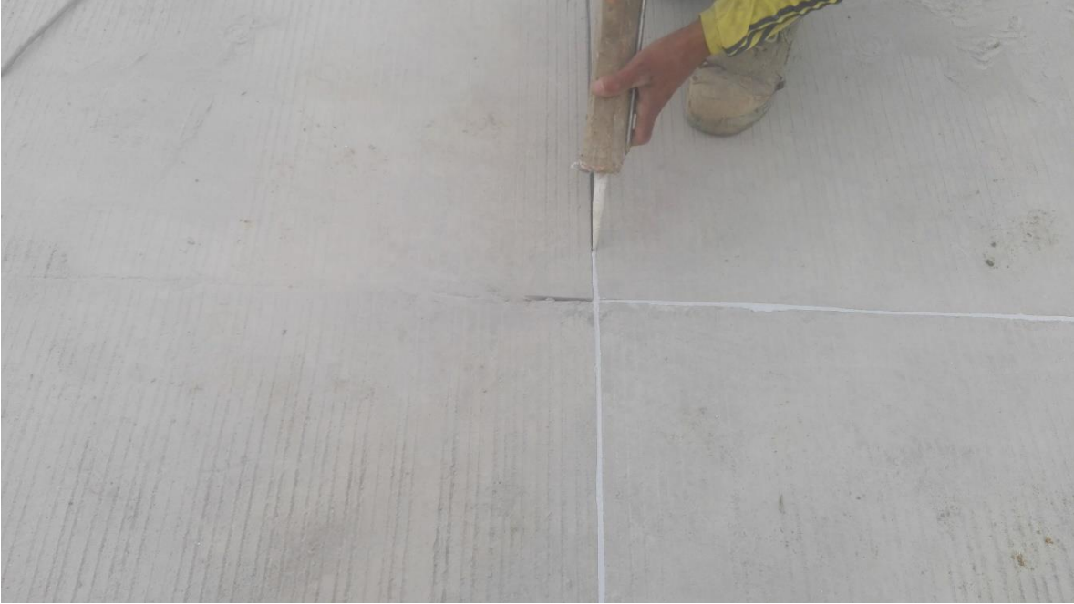
Fotografía 33. Sellado de dilataciones. ZikaFlex 401. Fuente: Tomada por el pasante
