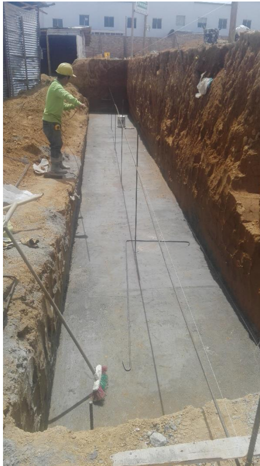
Fotografía 2. Vista de superficie del solado. Fuente: Tomada por el pasante
