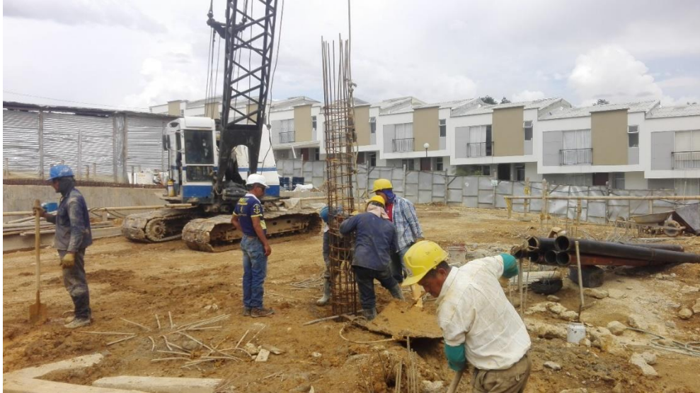
Fotografía 45. Instalación de castillos de acero. Fuente: Tomada por el pasante
