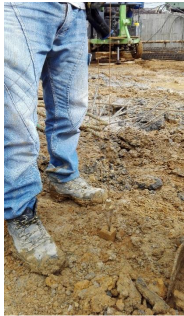
Fotografía 43. Localización del pilote con plomada. Fuente: Tomada por el pasante
