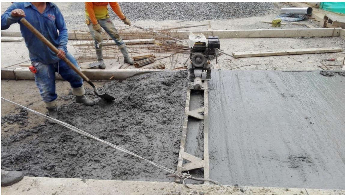
Fotografía 23. Regla vibratoria. Fuente: Tomada por el pasante
