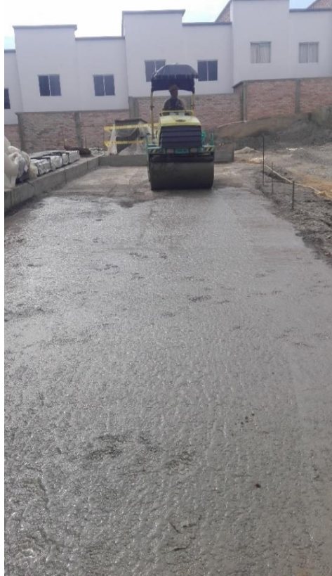
Fotografía 17. Compactación de la subbase. Fuente: Tomada por el pasante
