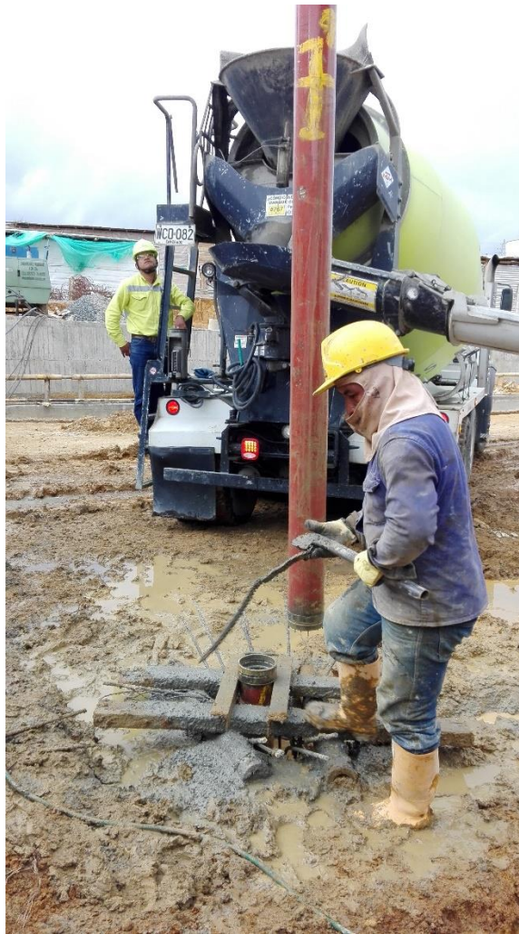
Fotografía 51. Retiración de tubos. Fuente: Tomada por el pasante
