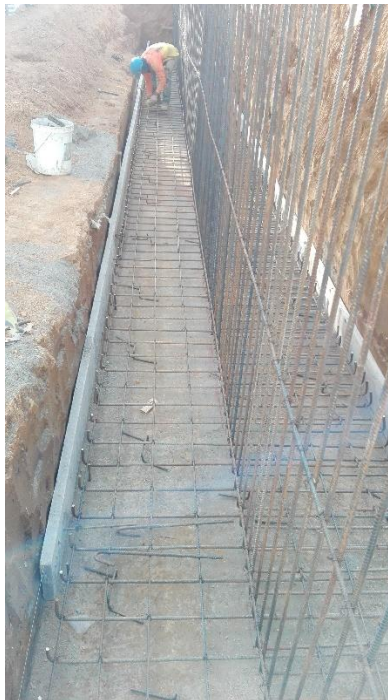
Fotografía 4. Armado del refuerzo muro 2. Fuente: Tomada por el pasante
