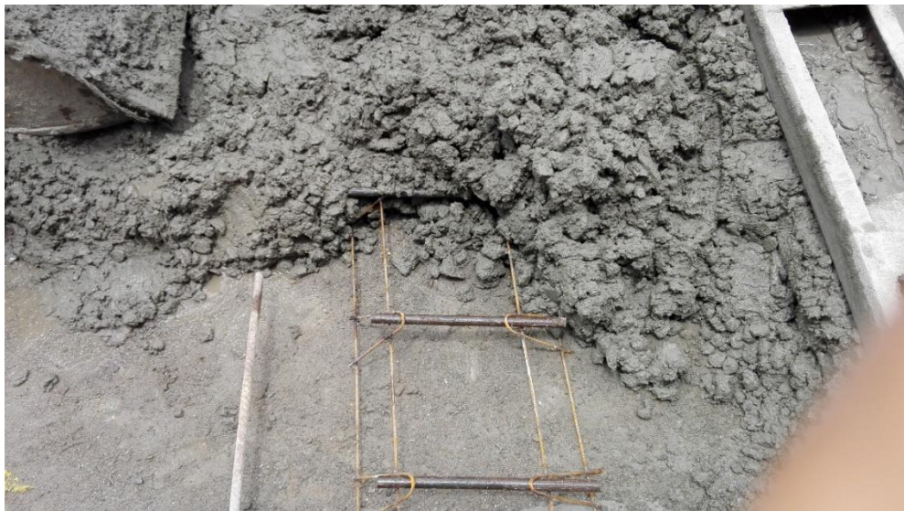
Fotografía 25. Refuerzo longitudinal. Fuente: Tomada por el pasante
