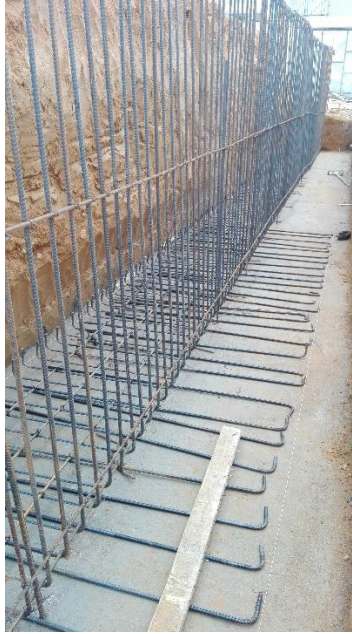
Fotografía 3. Armado del refuerzo muro 2. Fuente: Tomada por el pasante
