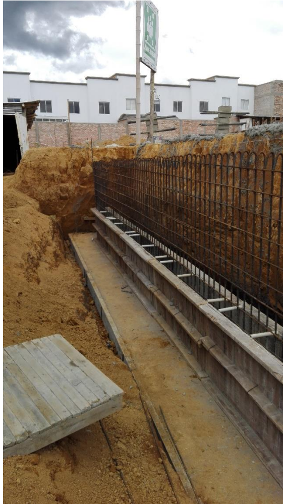
Fotografía 8. Instalación de la Formaleta. Fuente: Tomada por el pasante
