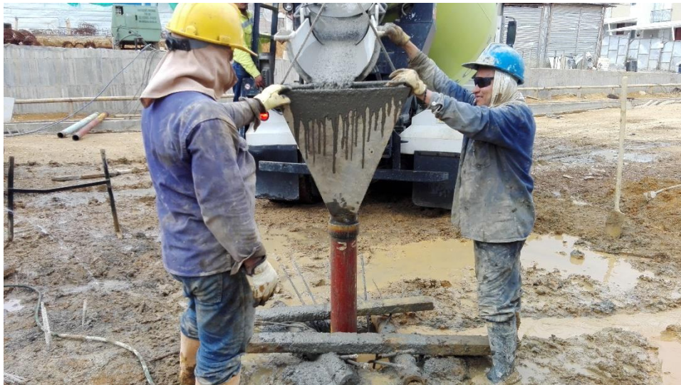
Fotografía 50. Fundición del pilote. Fuente: Tomada por el pasante
