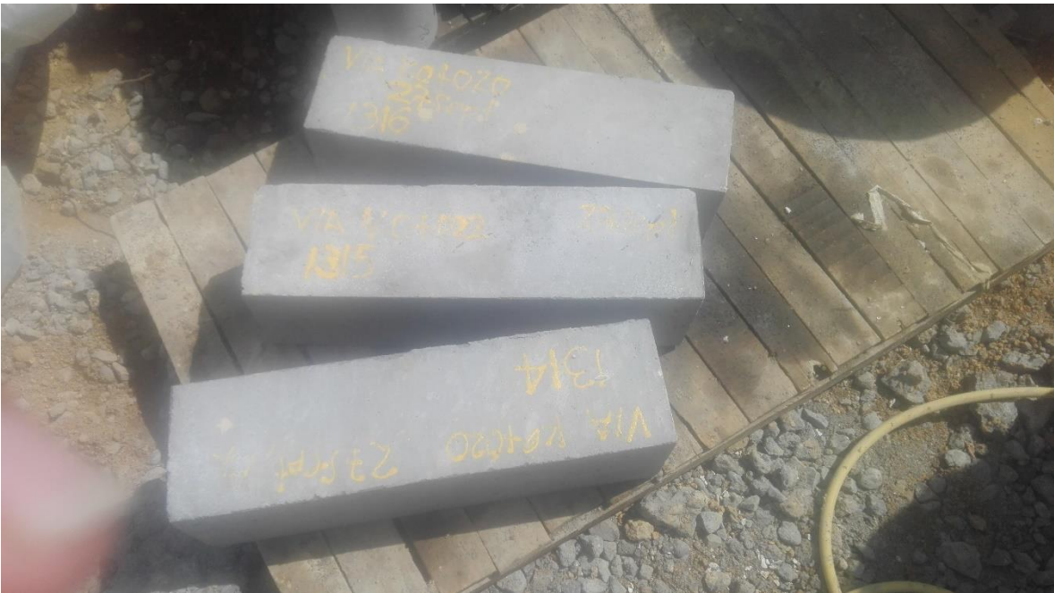
Fotografía 34. Viguetas. Fuente: Tomada por el pasante
