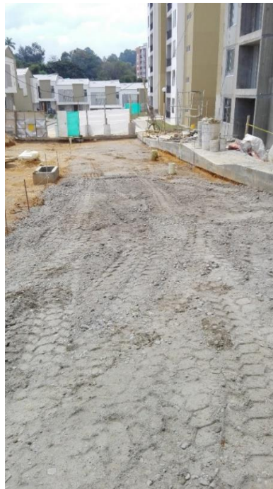
Fotografía 16. Extendido de la subbase. Fuente: Tomada por el pasante
