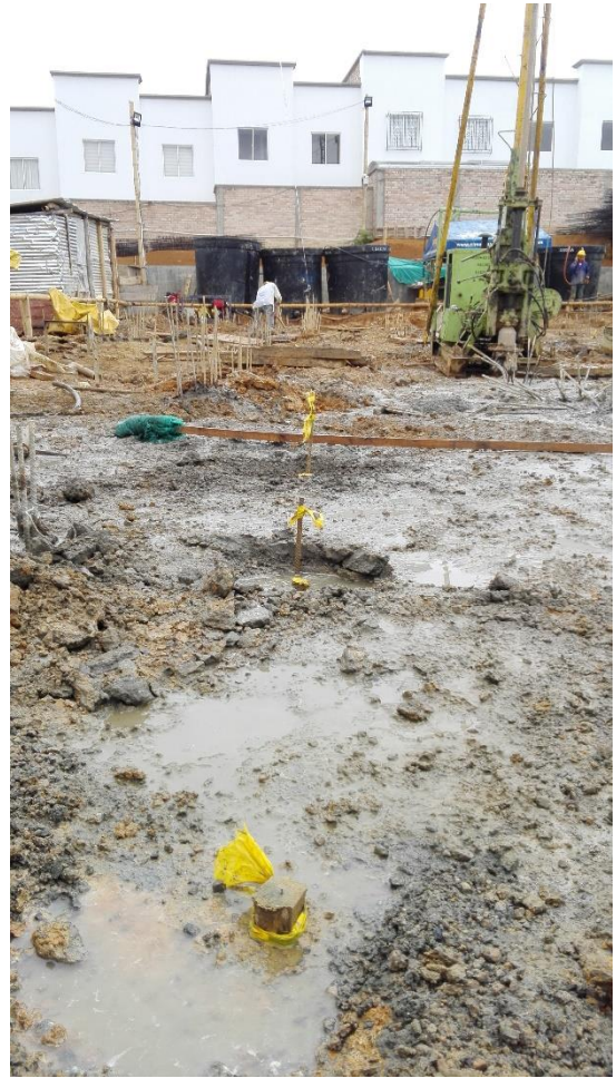
Fotografía 44. Pilotes localizados sobre estacas. Fuente: Tomada por el pasante
