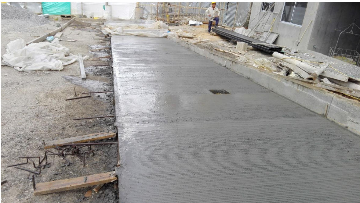
Fotografía 29. Pavimento finalizado. Fuente: Tomada por el pasante
