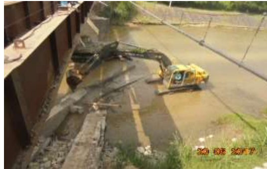
Demolicion de la ultima seccion que queda de los estribos existentes, de la pila central y retiro de escombros del lecho del rio
