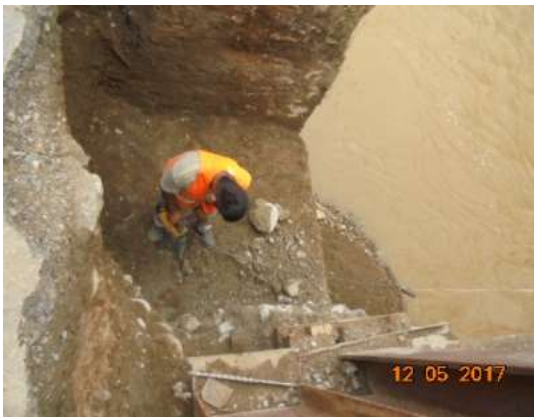
Fundición de solado de limpieza y recalce en los dos estribos con viga transversal de soporte en concreto de 4000 psi
