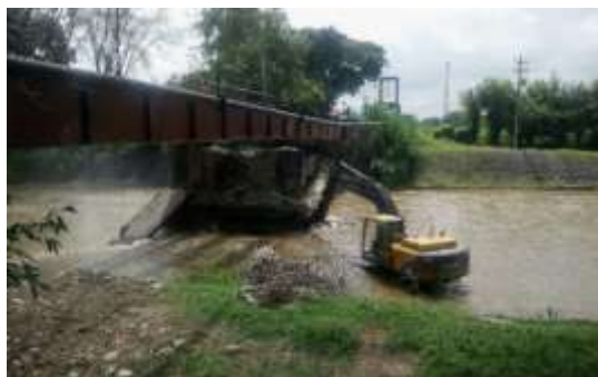
Demolicion de la ultima seccion que queda de los estribos existentes, de la pila central y retiro de escombros del lecho del rio
