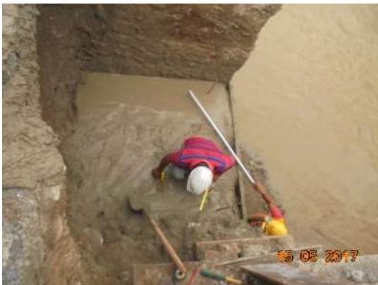
Fundición de solado de limpieza y recalce en los dos estribos con viga transversal de soporte en concreto de 4000 psi
