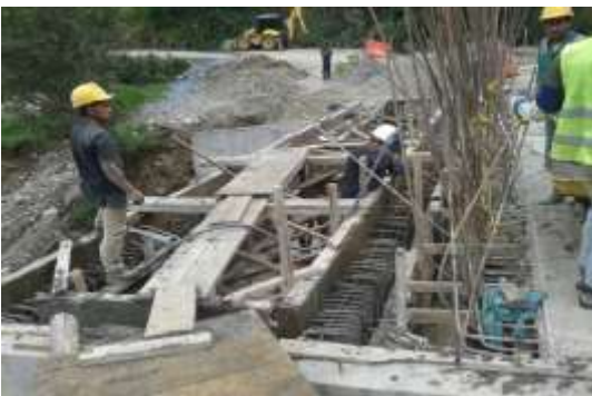
Construcción de filtro en el trasdós y relleno estructural para el puente en la quebrada quintero PR22+165.
