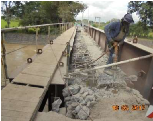
Demolición de estribos y fundición de los recalces en los estribos para ubicar la viga central.
