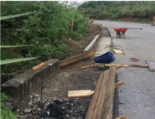
Se realiza extensión de base granular en el PR20+850.
