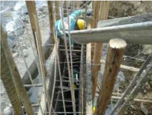
Instalacion de aceros de refuerzo y fundicion de vigas longitudinales y diafragmas - margen izquierdo
