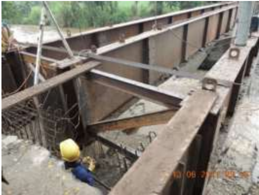
Fundición de muros de acompañamiento
