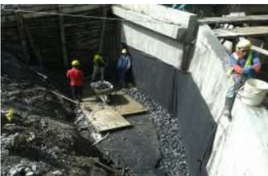
Construcción de filtro en el trasdós y relleno estructural para el puente en la quebrada quintero PR22+165.
