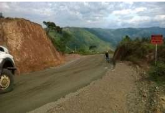
Se realiza extensión de base granular en el PR20+850.
