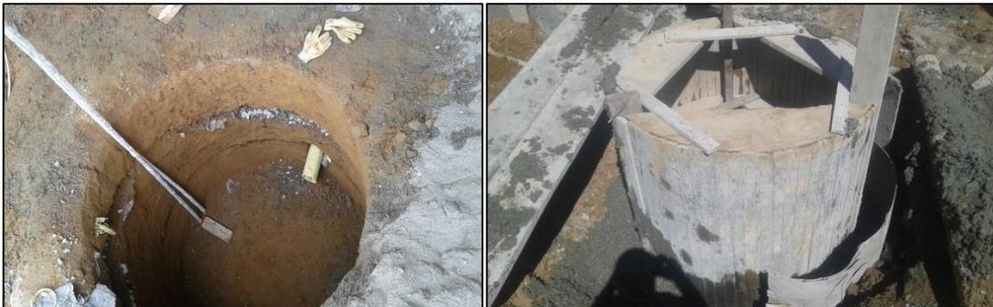
Después de colocar la formaleta y verificar su verticalidad con plomadas, se procedió al vaciado del concreto como se puede ver en la figura 22; en este caso se utilizó un concreto de proporciones 1:2:3 para obtener una resistencia de 3000psi o 21 Mpa compactado con vibrocompactador eléctrico en capas de 30cm.
