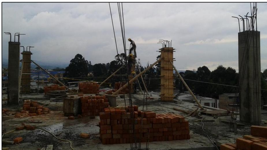
Se marcó con cimbra la ubicación de la formaleta en la losa de entrepiso, seguidamente se incrustó en esta unos apoyos en cuartón de madera de 2"x2" en donde se señaló la formaleta de la columna. Simultáneamente se realizaron 4 tableros laterales para cada una de las caras, de la siguiente manera:
