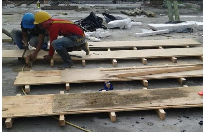
1. Se cortó cuartones de 2x4" cada 0.75m, se perforó en el espacio de los extremos (no mayor a 0.12m) y se ubicó sobre una superficie como indica la *figura 37* (en el piso donde se armaron) cada 0.5m de distancia horizontal.
