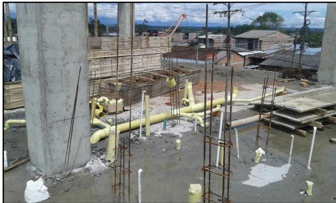
Como se puede ver en la *figura 16*, las instalaciones hidrosanitarias son actividades previas a la fundición de losa y construcción de muros, por tal motivo se deben ubicar con exactitud según los planos y la construcción existente.
