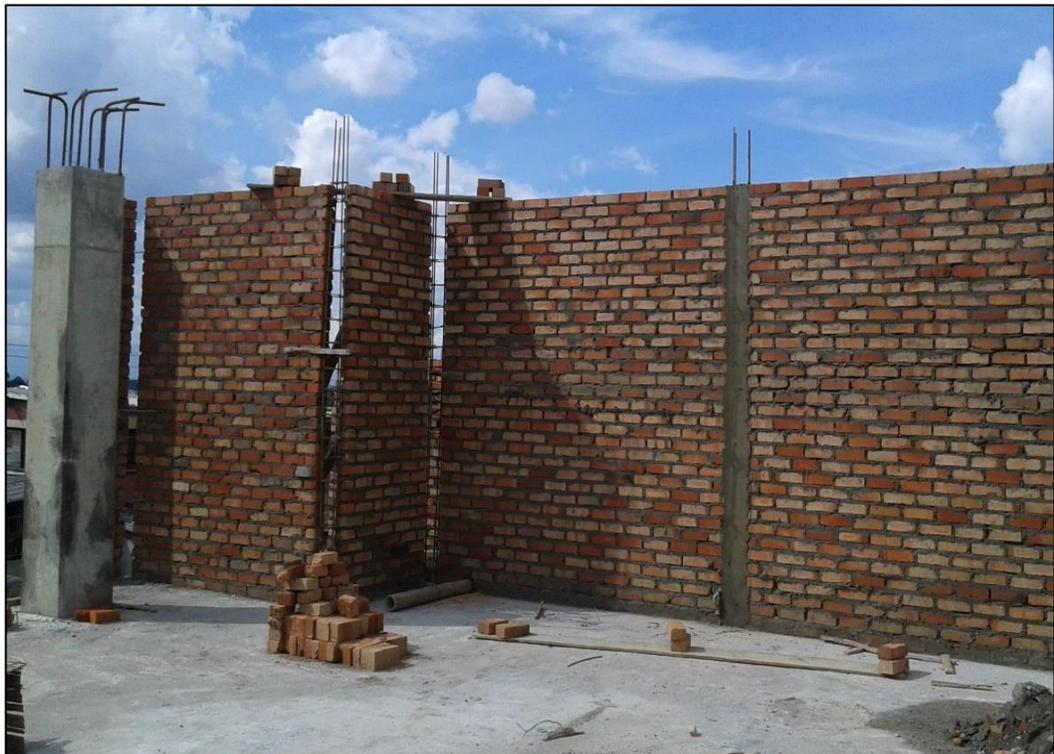
Previamente a la pega del ladrillo, los bloques de arcilla fueron sumergidos en agua durante la noche anterior, con el fin de retener la cantidad necesaria para llenar sus vacíos, evitando que este material absorbiera el agua del mortero de pega y así obtener un correcto fraguado y una resistencia óptima.
