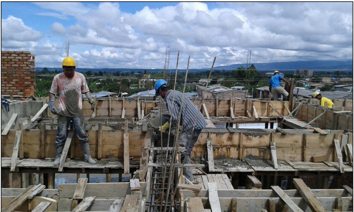
Al igual que las columnas se realiza el mismo proceso para el vaciado del concreto, utilizando el vibro compactador eléctrico para realizar una adecuada distribución del en toda la viga.
