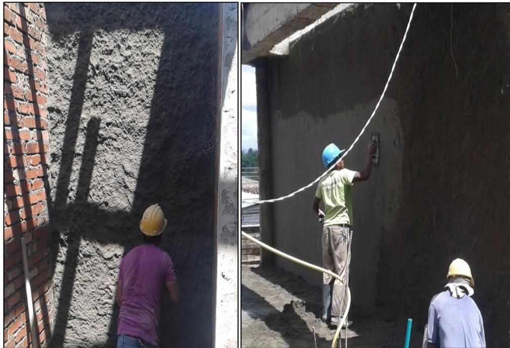
Figura 50. Fuente: Elaboración propia. Repello de muros.
