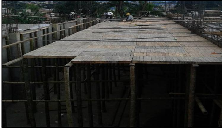
Elementos de construcción de formaleta para fundición de losa.
