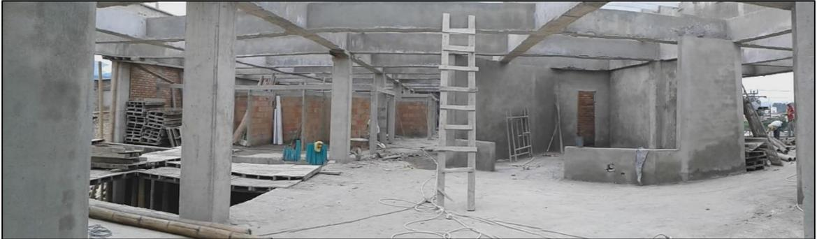
Por el diseño del centro comercial, la idea arquitectónica para las vigas, la estructura y la cubierta, fue dejarlas visibles estructuralmente dando un aspecto rustico pero terminado, lo que ocasionó una construcción estricta en cuando a los acabados y detalles.
