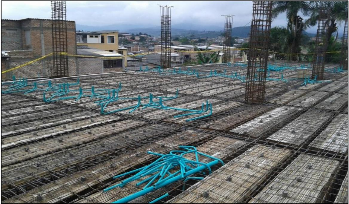
Figura 29. Fuente: Elaboración propia. Instalación de tubería eléctrica.
