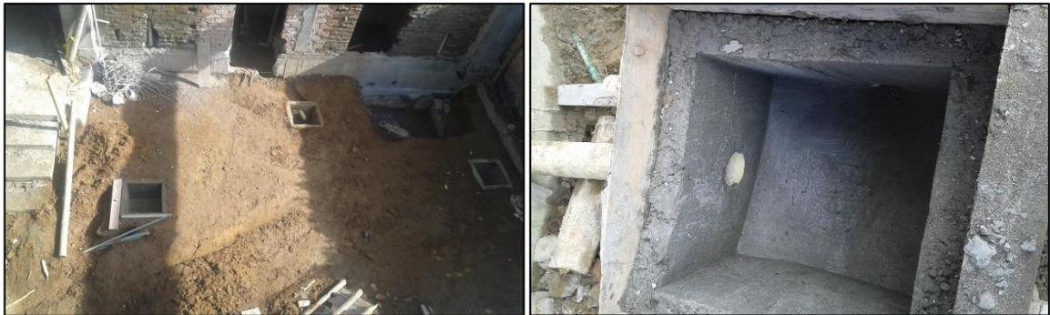
Al igual que las cámaras de inspección se hicieron formaletas para fundición, pero en este caso más pequeñas y de forma cuadrada, se construyeron cañuelas que conducen las aguas residuales a la tubería que se transportan el agua a la red principal, como se puede ver en la *figura 23*.
