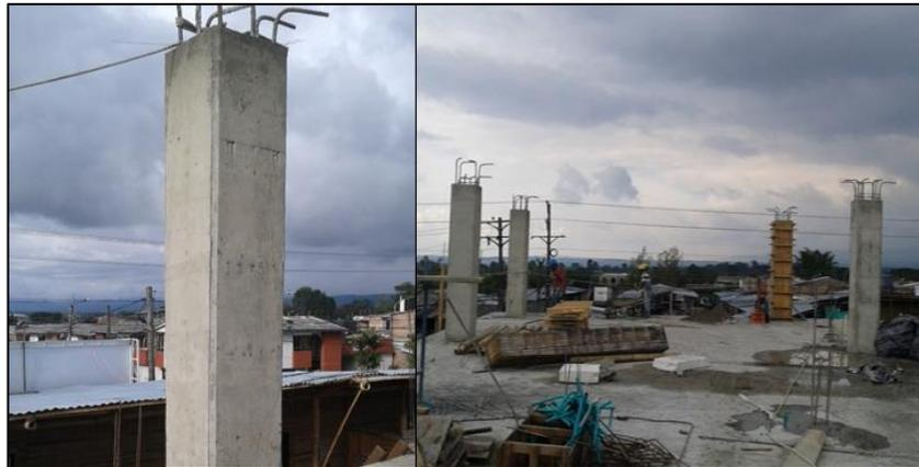
El triplex en la formaleta se utilizó con el fin de garantizar un acabado liso en las columnas, para evitar la necesidad de empañetarlas con mortero, como se puede ver en la *figura 41*.
