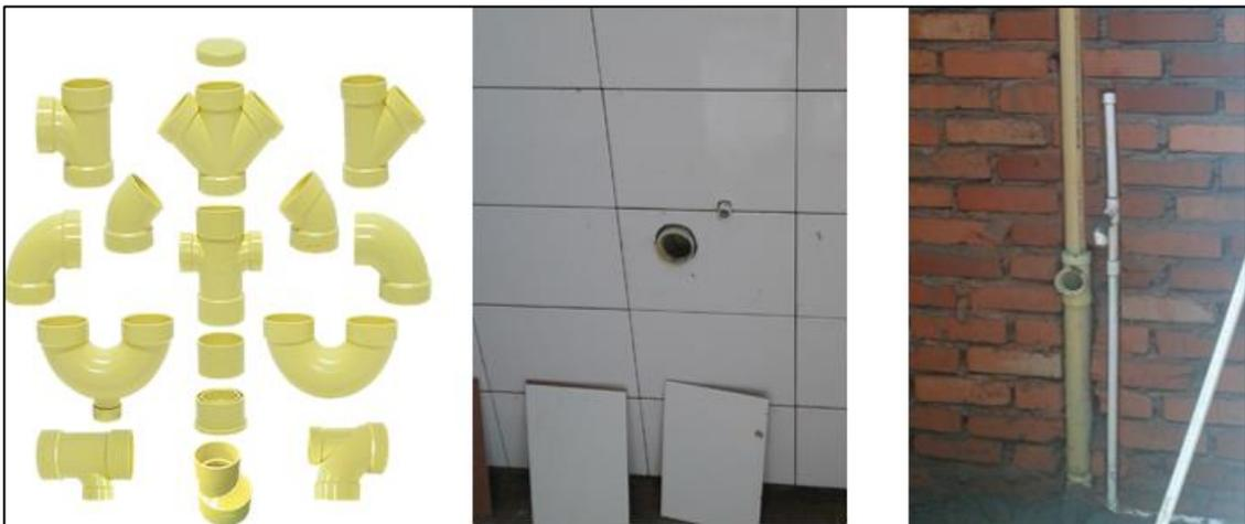
El cuidado importante a tener en cuenta en la parte sanitaria es el desnivel entre el punto inicial y final de una tubería, logrando por efectos de gravedad la conducción de aguas residuales y aguas lluvias a los colectores principales, por este motivo los
