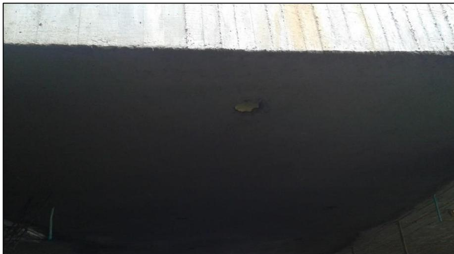
En primera instancia se debió humedecer el cielo raso según indicaciones del ingeniero director de obra, por lo menos 3 horas antes de la aplicación del mortero, para mejorar la adherencia con el concreto. Seguidamente se hizo un mortero especial con mayor cantidad de agua y cemento, para ser aplicado como la primera capa entre el cielo raso y el mortero, llamado comúnmente champeo.
