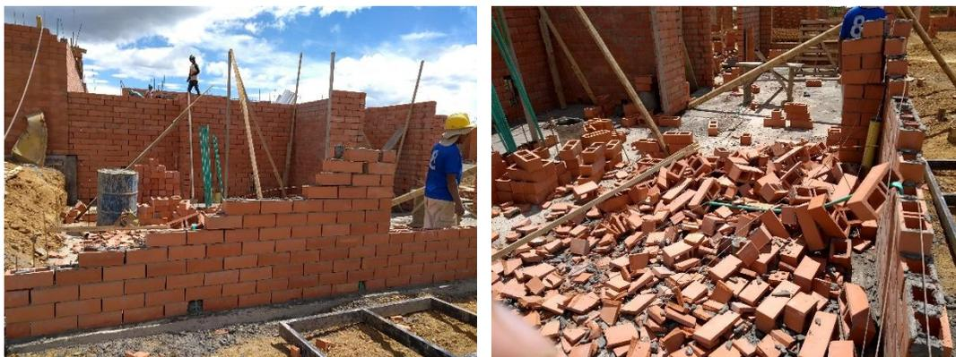
**Figura 29.** Muro que colapso
