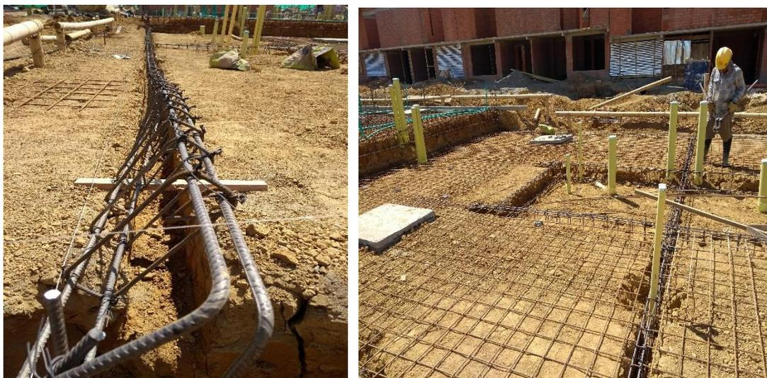
**Figura 23.** Cimentación superficial (*losas y vigas*)
