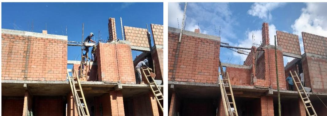
**Figura 33. Demolición viga y muro**
