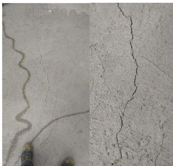
**Figura 26** Mal vertimiento del Antisol
