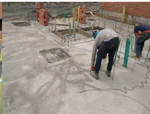
**Figura 25** Mal vertimiento del Antisol
