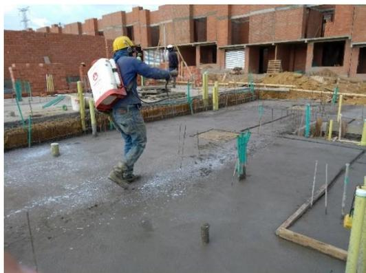
**Figura 24** Curado del concreto
