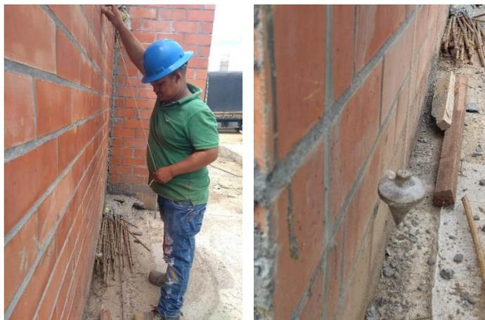
**Figura 28.** Desplome de muros
