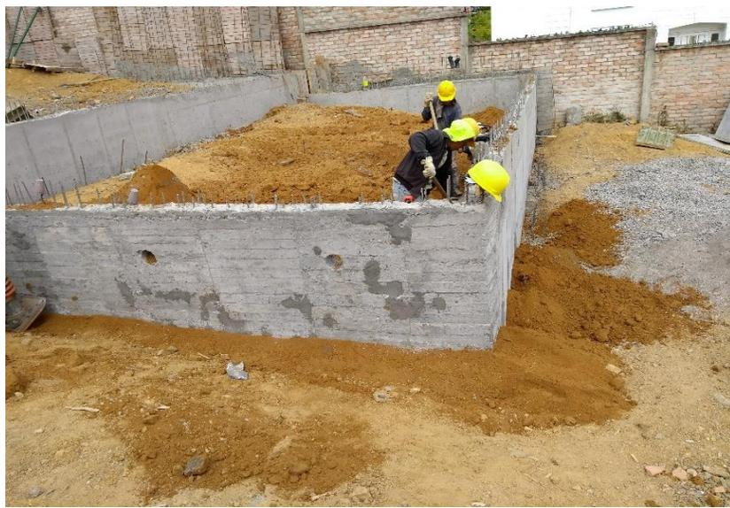
**Figura 3.** Muros de contención
