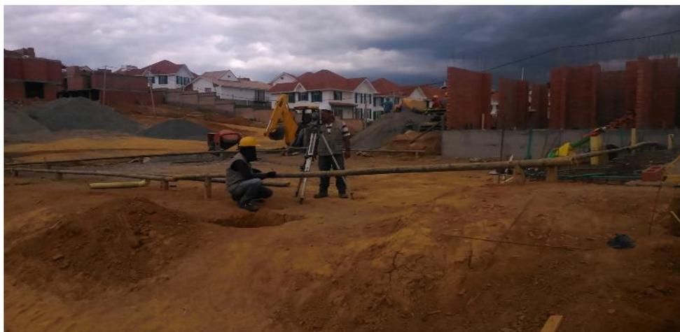
**Figura 22.** Replanteo de puntos
