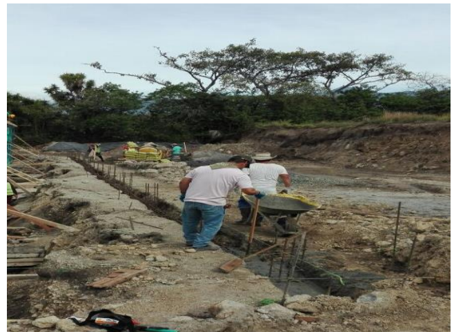
Ilustración 20. Fundición de viga de cierre.
