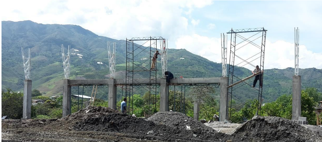
Ilustración 28. Anclaje de columnas de celosía. Eje 2
