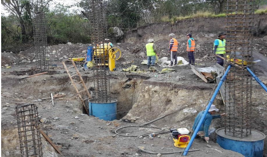
Ilustración 14. Fundición de pilotes.
