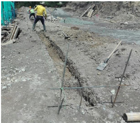
Ilustración 19. Excavación para viga de cierre
