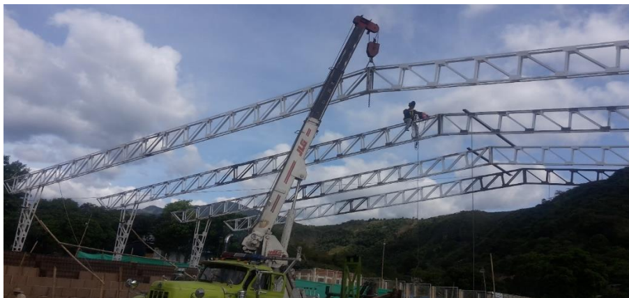
Ilustración 31. Montaje de cerchas con grúa.
