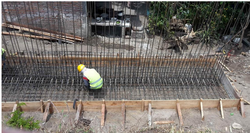
Ilustración 11. Armado de acero para zarpa y encofrado para fundición.
