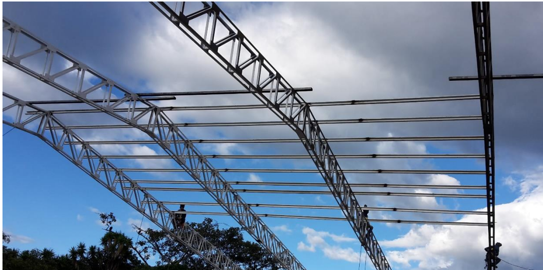
Ilustración 32. Instalación de correas metálicas.
