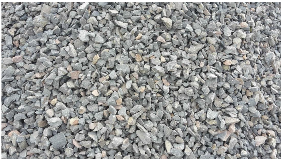
Ilustración 38. Agregado grueso en obra.
