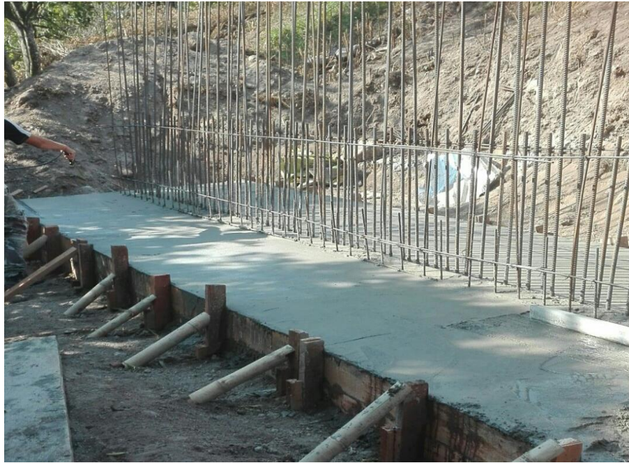
Ilustración 12. Fundición de Zarpa.
