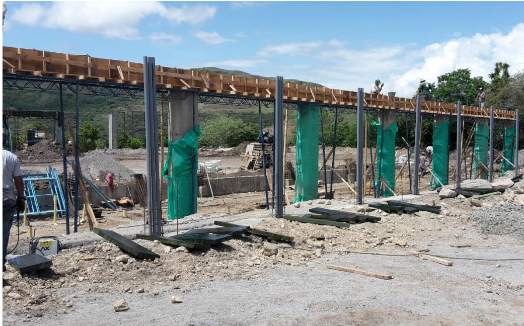
Ilustración 22. Fundición de Viga elevada eje 1.
