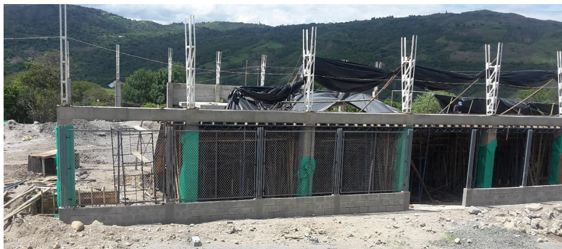
Ilustración 29. Columnas de celosía sobre pedestales.
