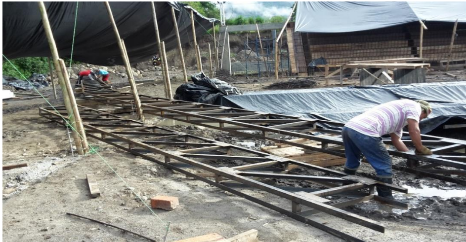
Ilustración 30. Unión y limpieza de cerchas.
