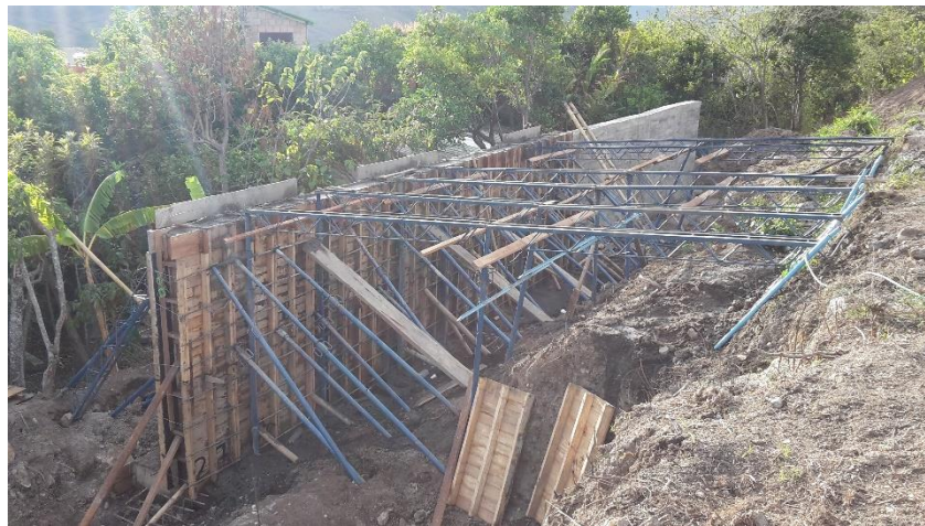
Ilustración 13. Etapa 2 del muro fundido sin desencofrar.
