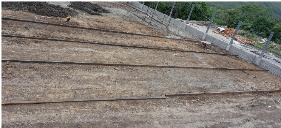
Ilustración 34. Encofrado de carriles con perfiles metálicos.
