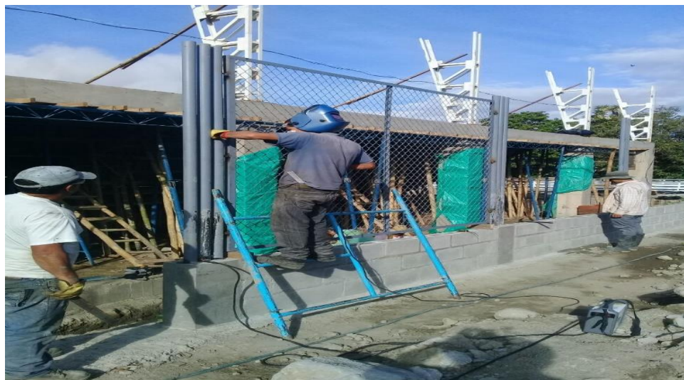
Ilustración 33. Instalación de malla para cierre
