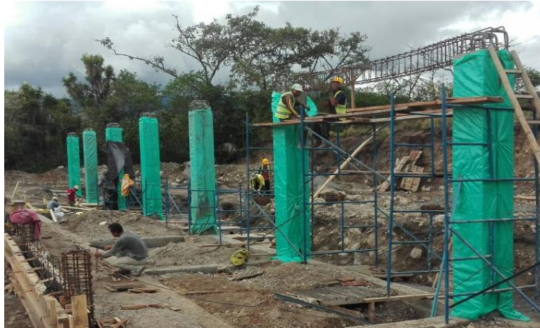
Ilustración 18. Armado de la viga elevada eje 1.
