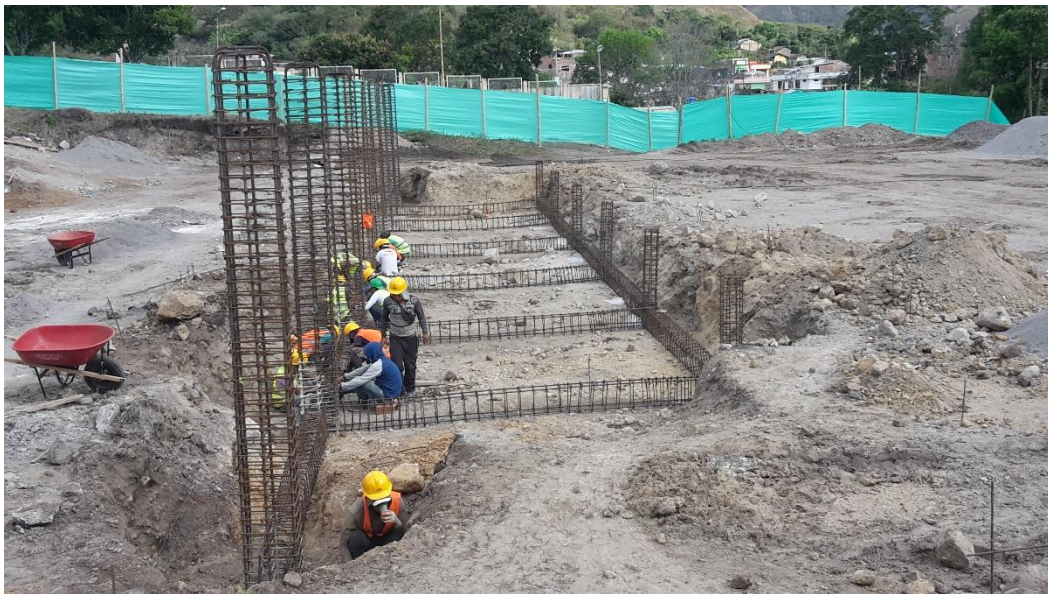
Ilustración 16. Armado de estructura de gradería.
