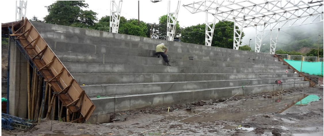
Ilustración 26. Gradería fundida.
