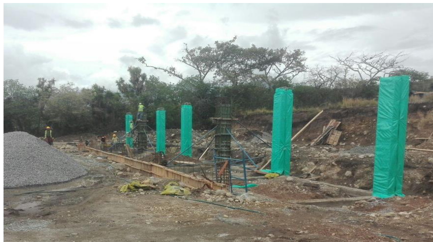
Ilustración 17. Encofrado y fundición de pedestales eje 1.
