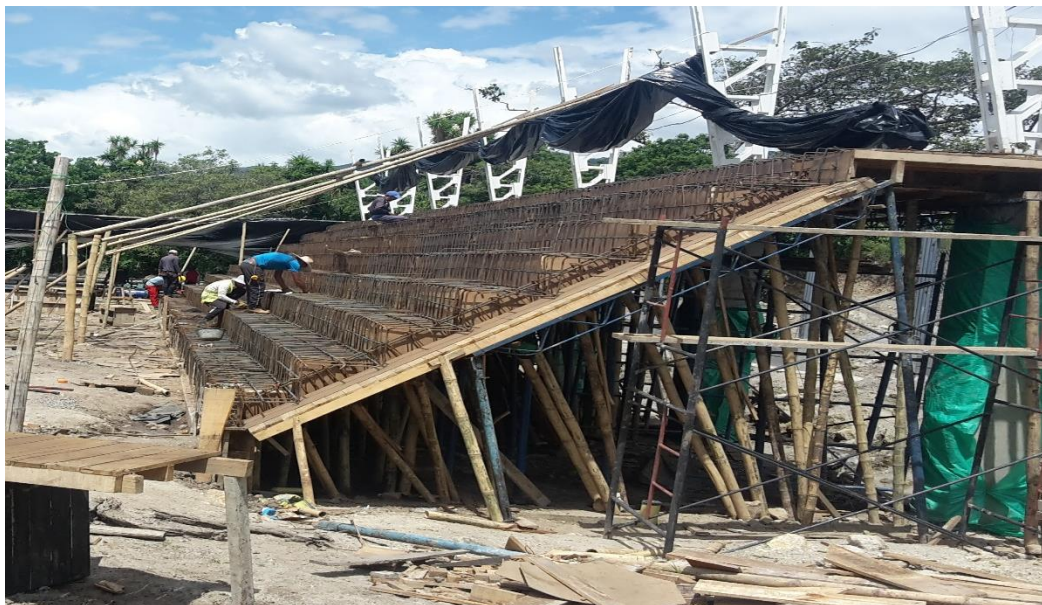
Ilustración 27. Detalle debajo de gradería (Zona de Camerinos)
