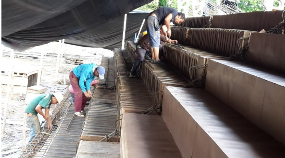
Ilustración 24. Armado de acero para gradería.
