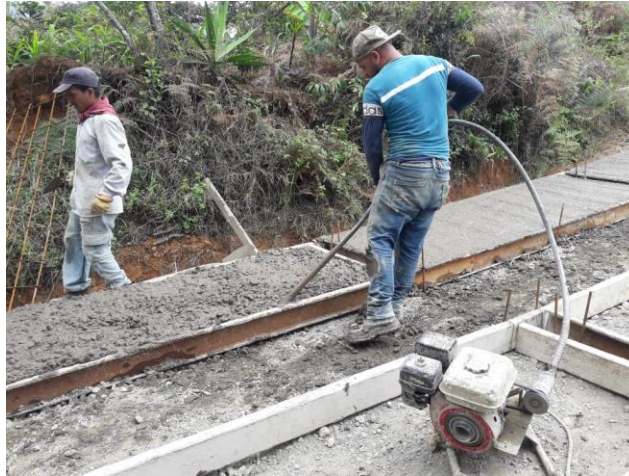
FIGURA 29: Fundición de placas en concreto reforzado y detalle de formaleta.
