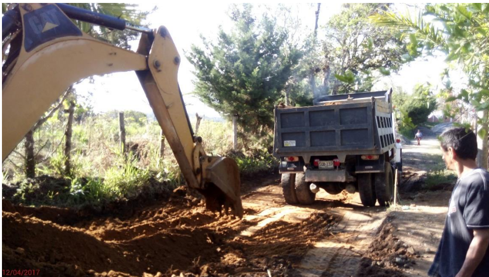
Figura 15. Retiro de material de excavación tramo 1, Corregimiento de Siberia - Cementerio.
