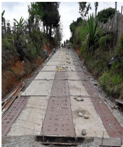
FIGURA 34: Acabados y aplicación de anti sol en de placas concreto ciclópeo
