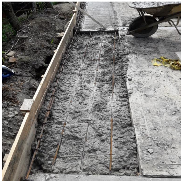
FIGURA 40: Acero de refuerzo berma.
