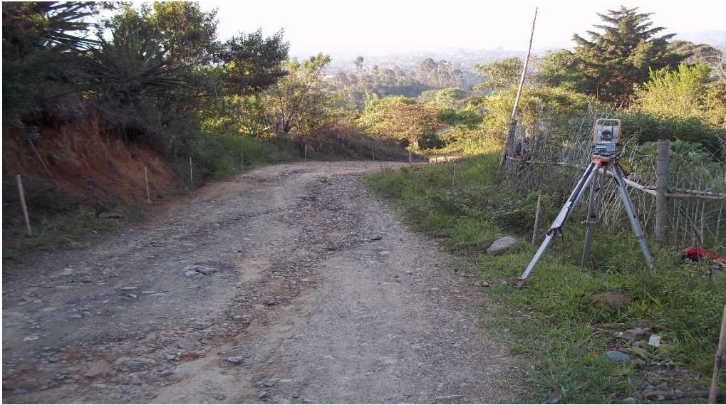
Figura 7. Localización y replanteo de la vía (Crucero Rosario – Siberia)
