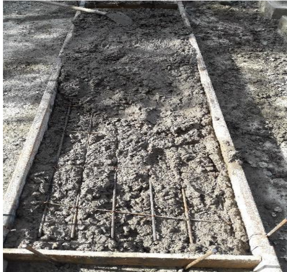
FIGURA 23: Colocación de parrillas de refuerzo.
