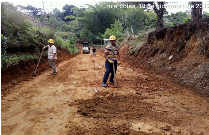
Figura 11. Uso del vibro compactador para la conformación.
