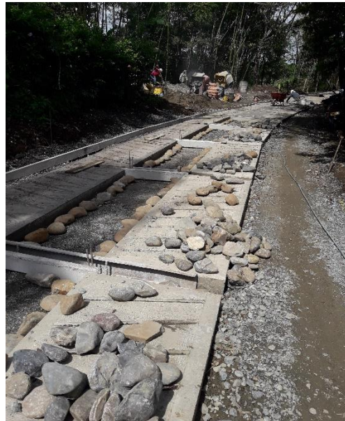
Figura 62 y 63. CONSTRUCCION DE HUELLAS EN CONCRETO CICLOPEO Y PIEDRA PEGADA
