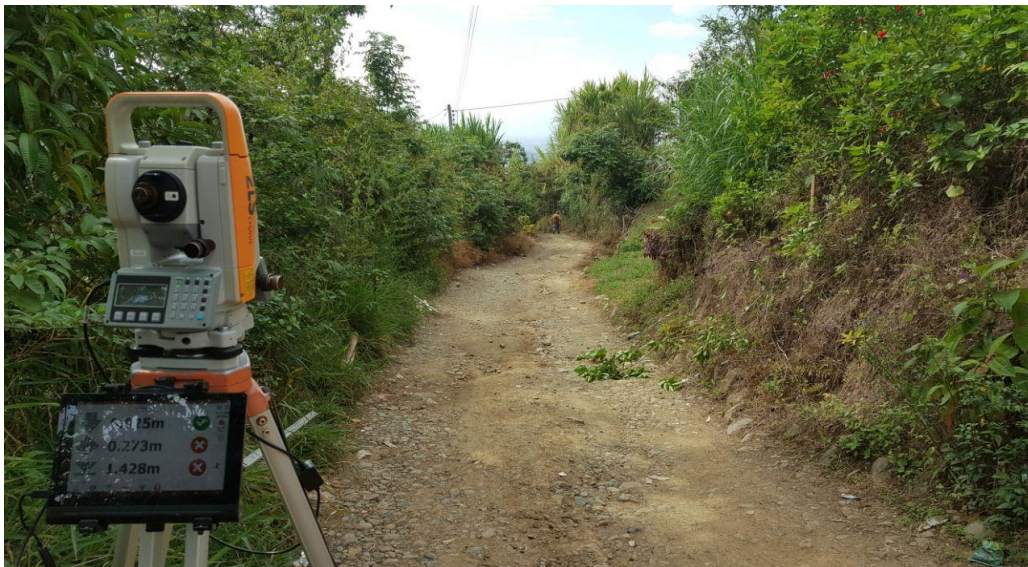
Figura 8. Localización y replanteo de la vía (Crucero Rosario – Siberia).
