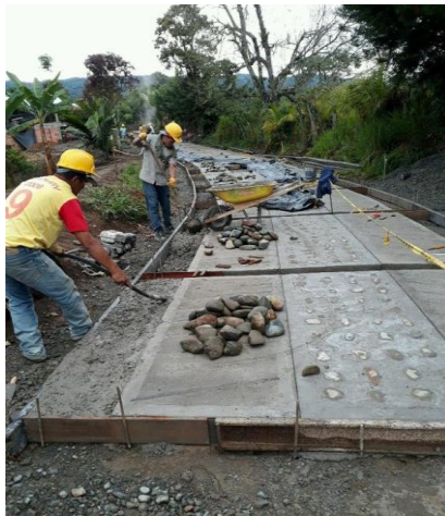
FIGURA 33: Construcción de placas en concreto ciclópeo
