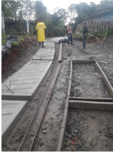
FIGURA 28: Fundición de placas en concreto reforzado.
