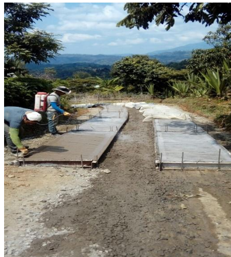
FIGURA 30: Suministro de antisol para la protección de placas de concreto reforzado.
