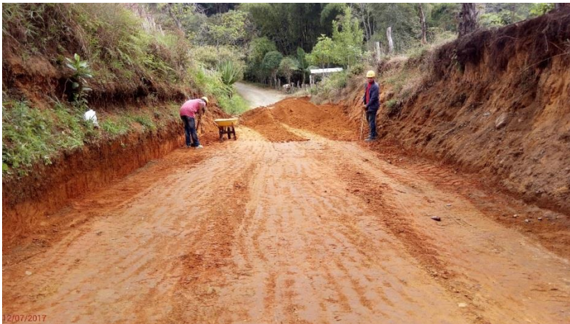
Figura 10. Adecuación manual de terreno.
