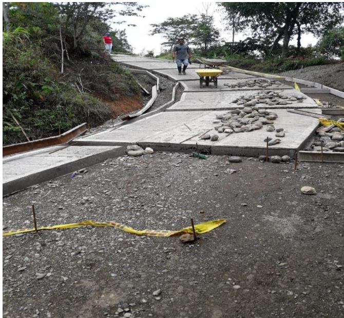
FIGURA 38: Construcción de sobre ancho en concreto ciclópeo.
