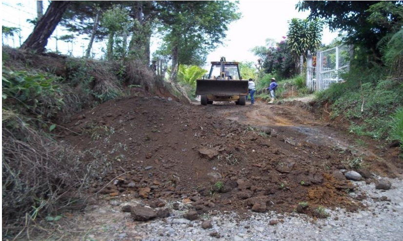
Figura 14. Excavación de sub rasante tramo 1, Corregimiento de Siberia - Cementerio
