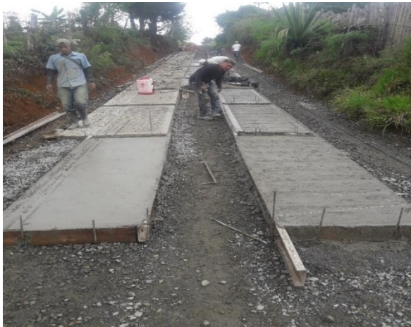
FIGURA 24: Fundición y construcción de huellas de concreto reforzado
