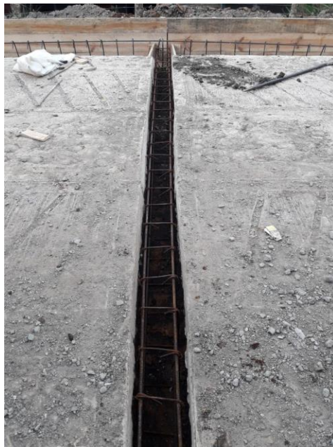
FIGURA 43: Excavación y colocación del acero de refuerzo.
