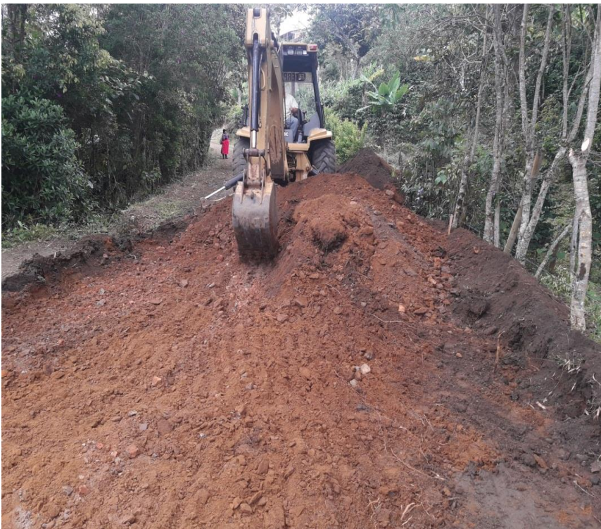
Figura 9. Escarificación de la vía Corregimiento de Siberia – Cementerio.
