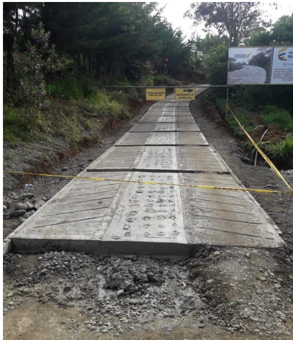
FIGURA 35: Tramo final de vía completada – eje central de placa en concreto ciclópeo finalizado.
