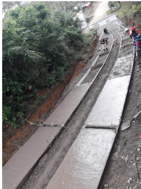
FIGURA 28: Fundición de placas en concreto reforzado.
