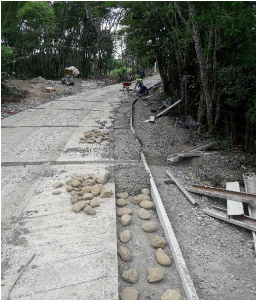
Figura 62 y 63. CONSTRUCCION DE HUELLAS EN CONCRETO CICLOPEO Y PIEDRA PEGADA
