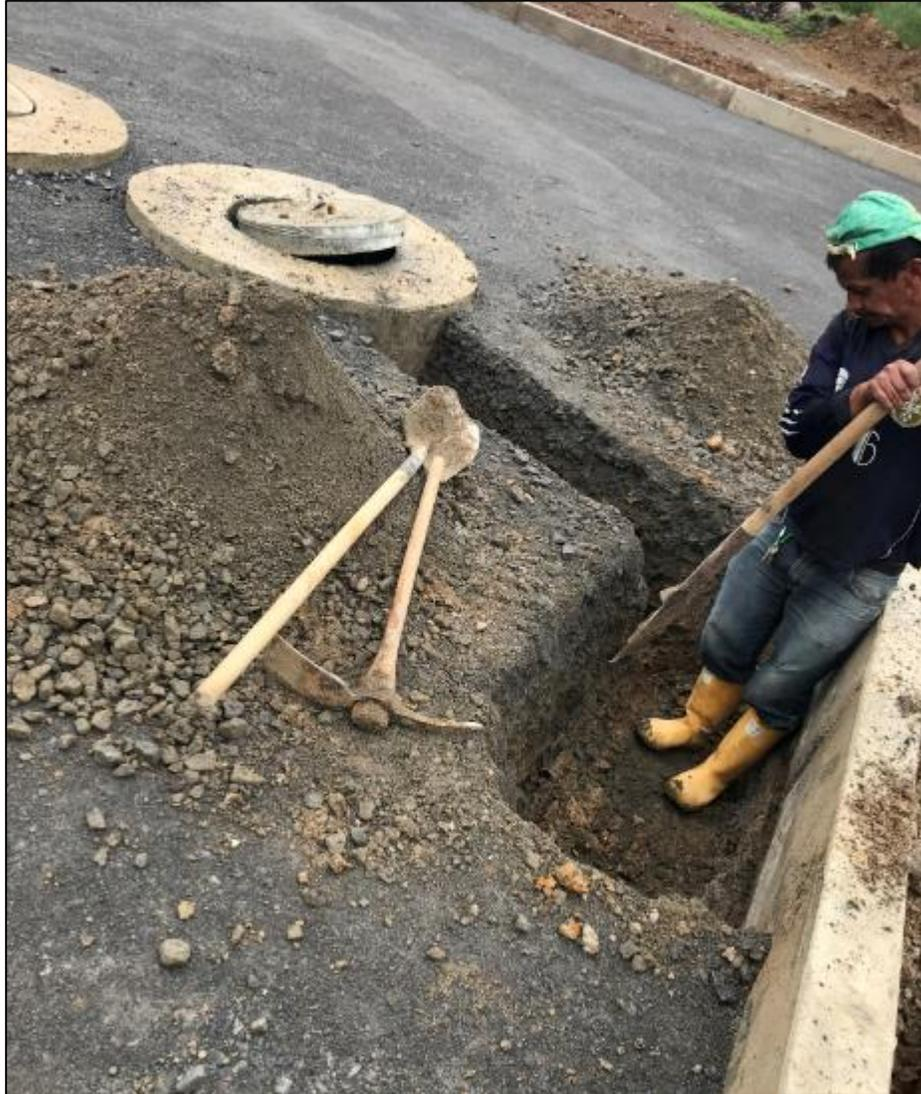
*Imagen 68: Excavación para sumidero sencillo, empalme eje 2 y eje 3.
