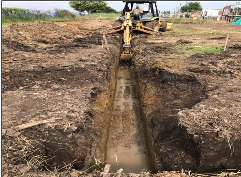
*Imagen 13: Excavación para construcción de filtro sobre eje 2 y 3.
