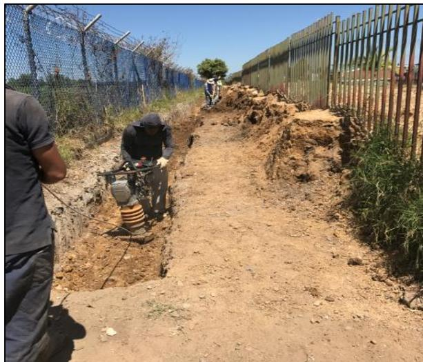
*Imagen 30: Compactación de la excavación sobre filtro vía servidumbre. Fuente: Propia.*
