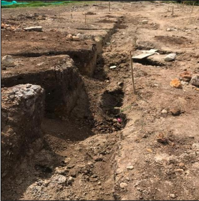
*Imagen 23: Relleno de excavación para alcantarillado sanitario. Fuente: Propia.*
