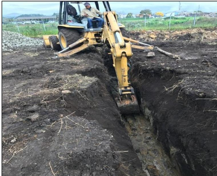
*Imagen 12: Excavación para construcción de filtro sobre eje 1. Fuente: Propia.*
