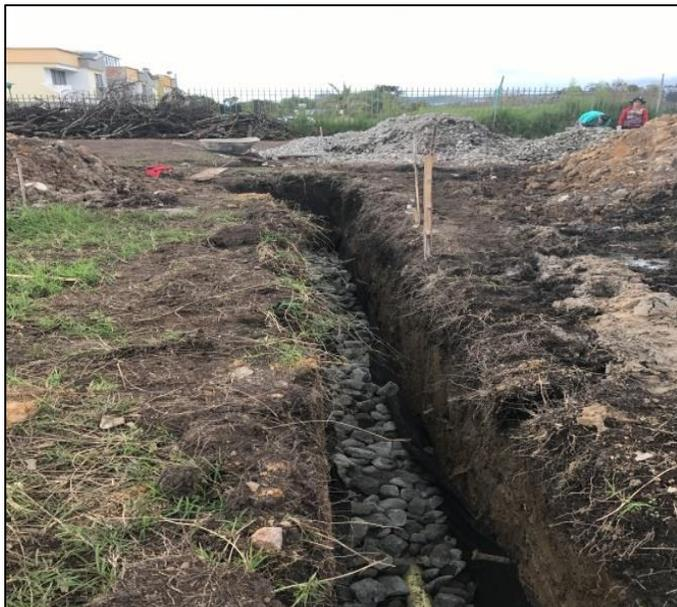
*Imagen 17: Construcción de filtro eje 2. Fuente: Propia.*
