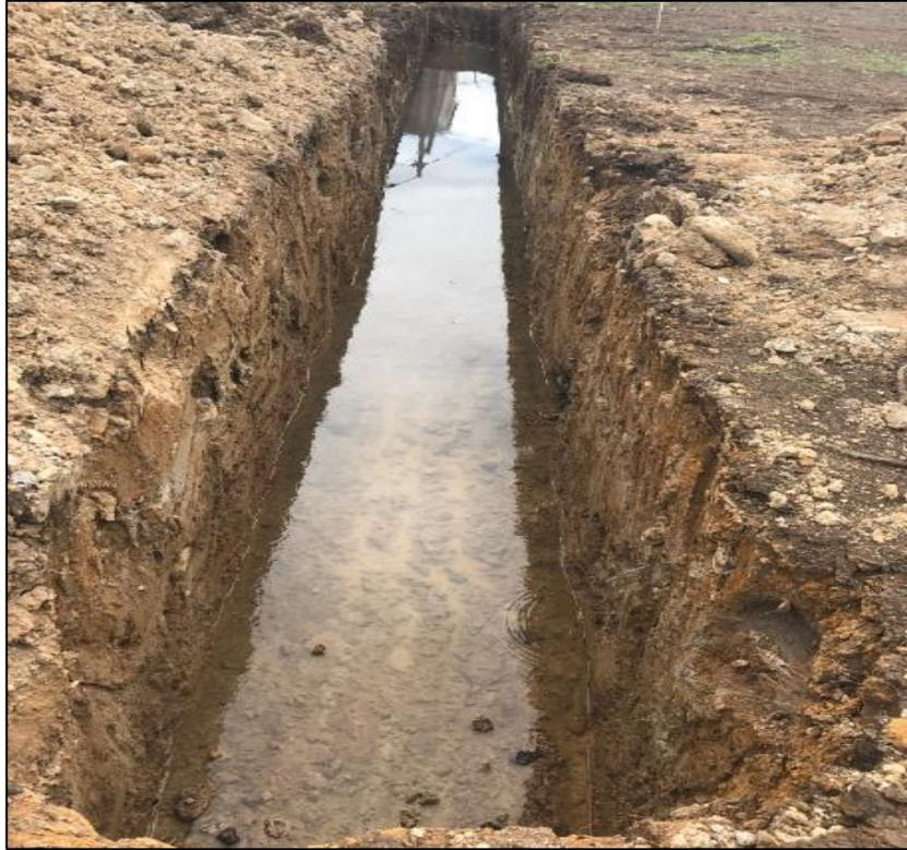
Imagen 22: *Excavación de alcantarillado eje 3 luego de lluvia.*
