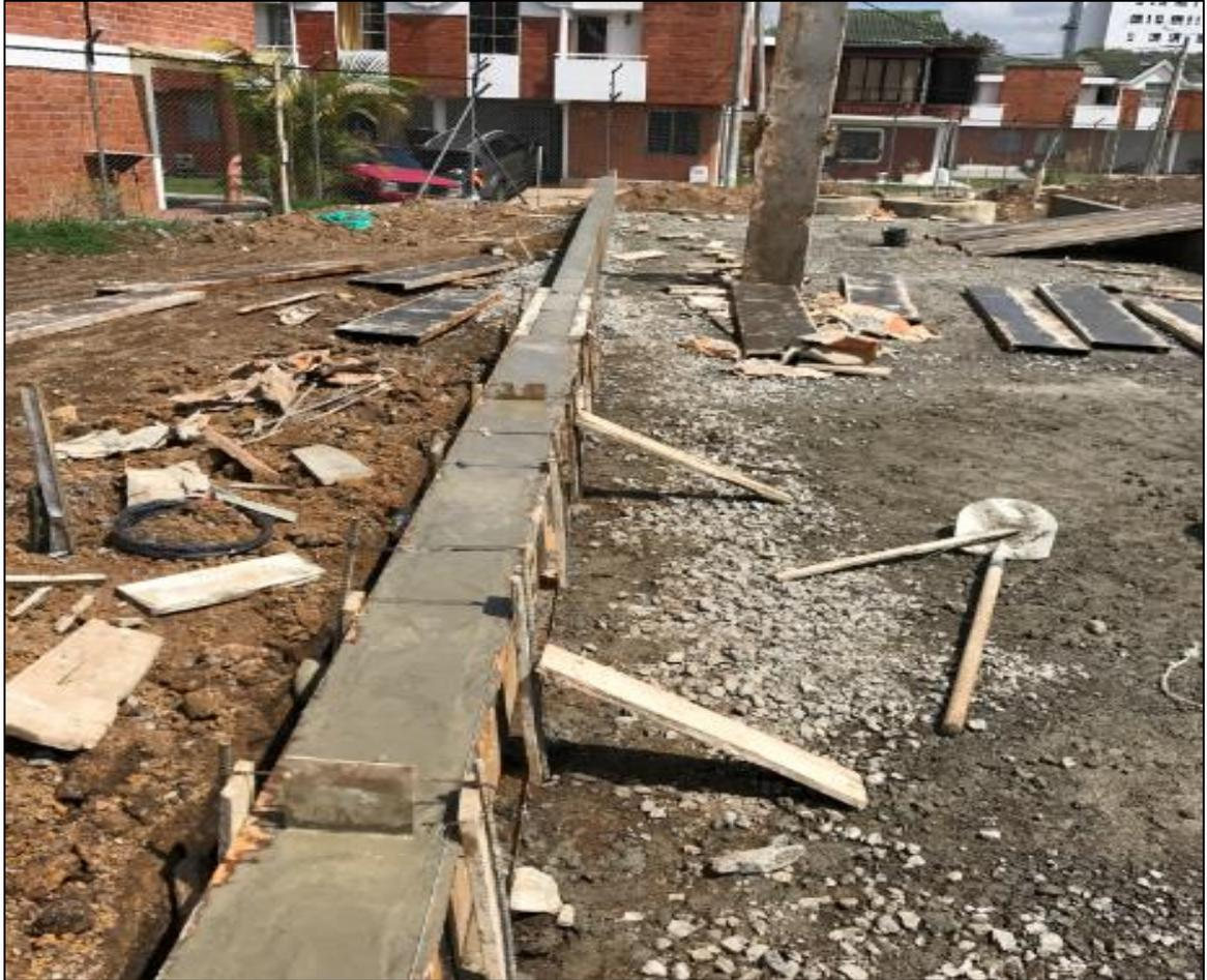
*Imagen 55: Retiro de formaleta en tramo margen izquierdo eje 3.
