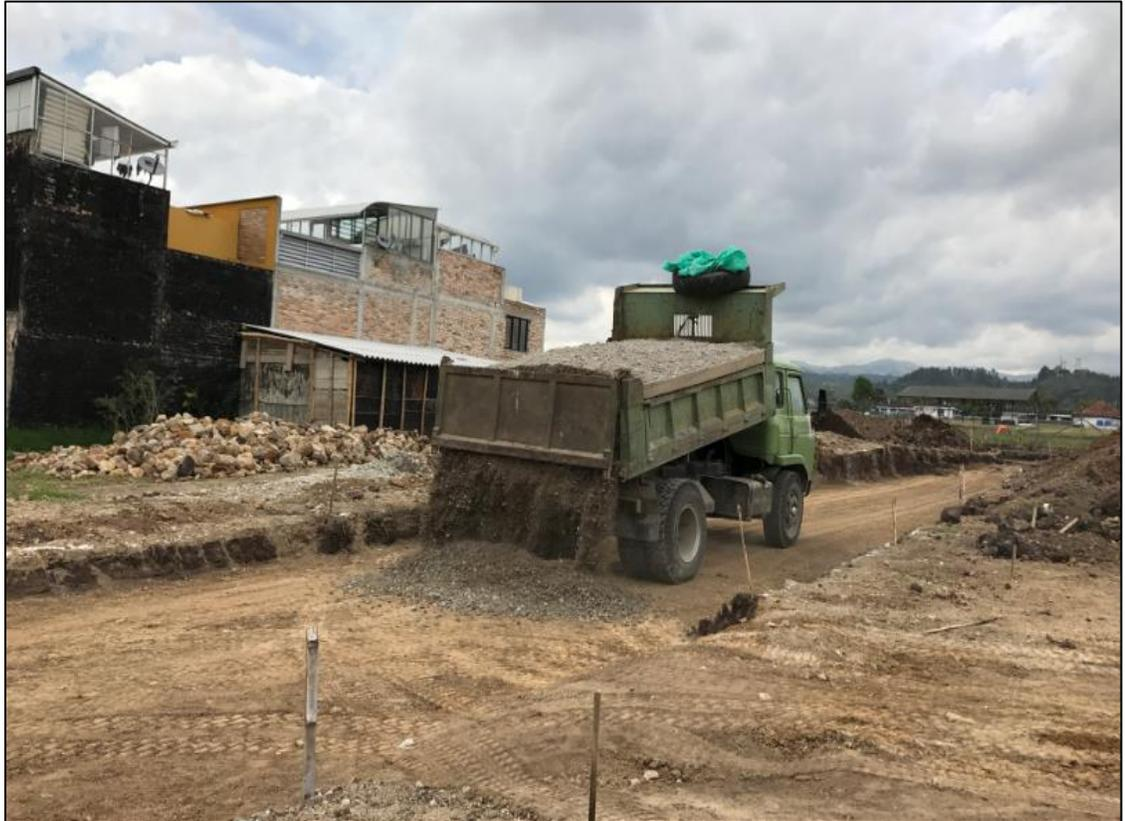
*Imagen 37: Acopio de material de sub-base eje 1.
