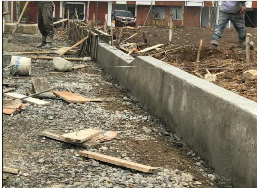
*Imagen 54: Tramo terminado e instalación de formaleta margen derecha eje 3
