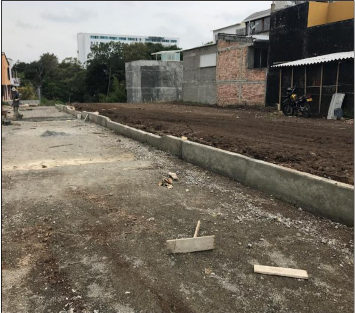
*Imagen 50: Sardinel terminado, margen derecho eje 1 entre cámaras.
