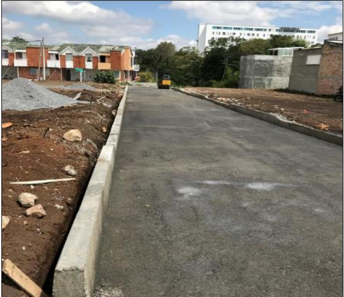
*Imagen 56: Compactación de la primera capa de base, parte final eje 1 tramo entre cámaras. Fuente: Propia.*
