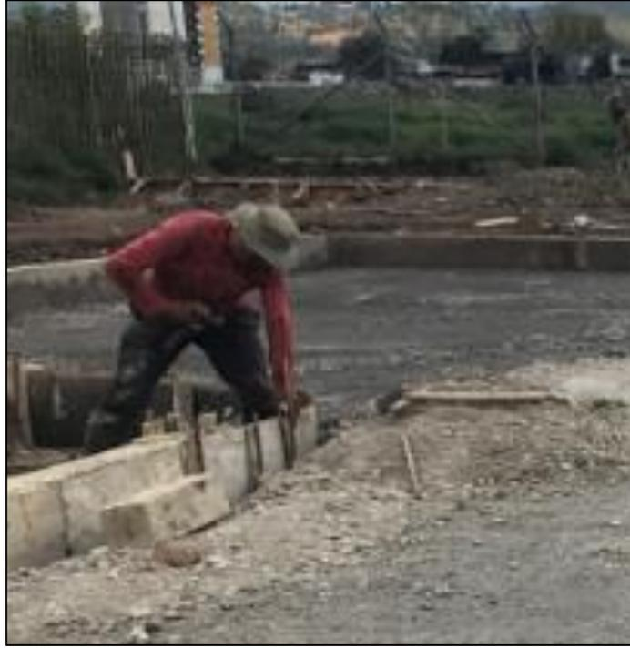
*Imagen 62: Construcción de curvas en intersección de ejes y parqueaderos.
