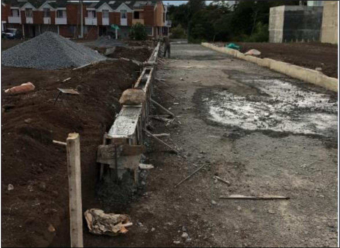
*Imagen 52: Fundición del tramo final eje 2 margen izquierda. Fuente: Propia.*
