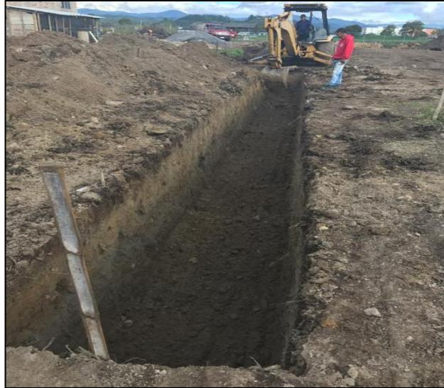
*Imagen 19: Excavación para alcantarillado sanitario y pluvial. Fuente: Propia.*
