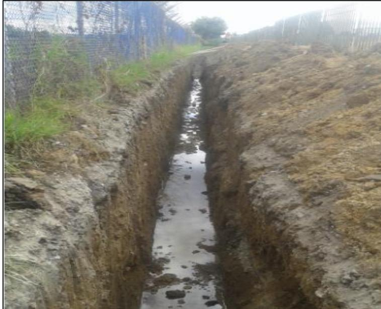
*Imagen 26: Excavación para filtro sobre vía servidumbre. Fuente: Propia.*
