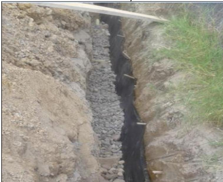
*Imagen 27: Construcción filtro sobre vía servidumbre. Fuente: Propia.*
