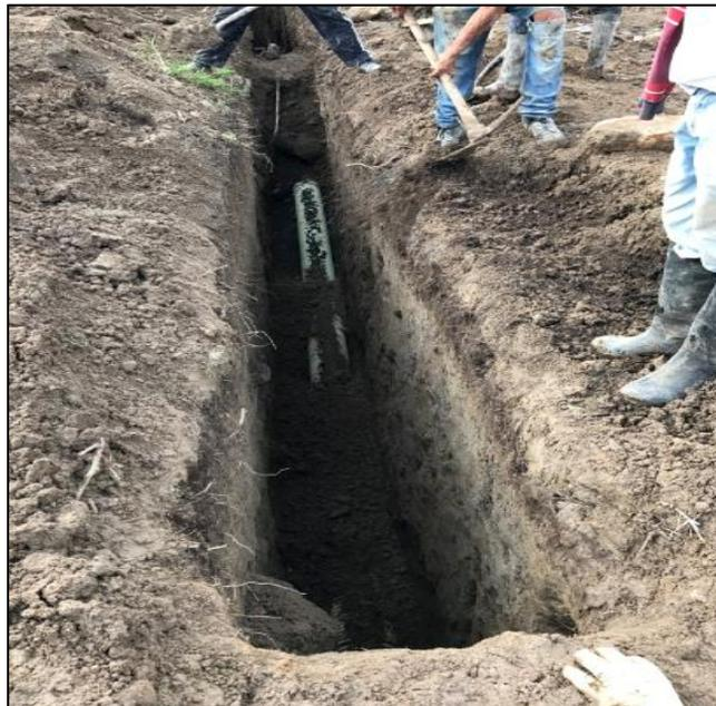
*Imagen 11: Instalación tubería novafort para descole alcantarillado sanitario.*
