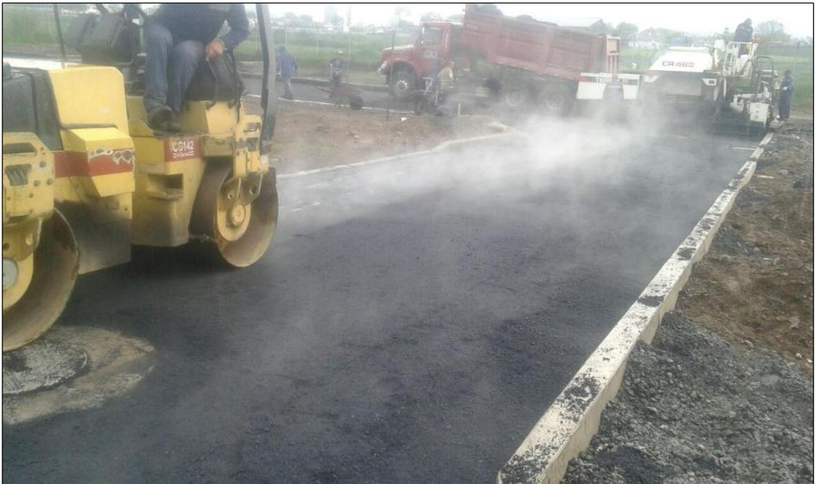
*Imagen 70: Extensión de capa de carpeta asfáltica con finisher, eje 2.
