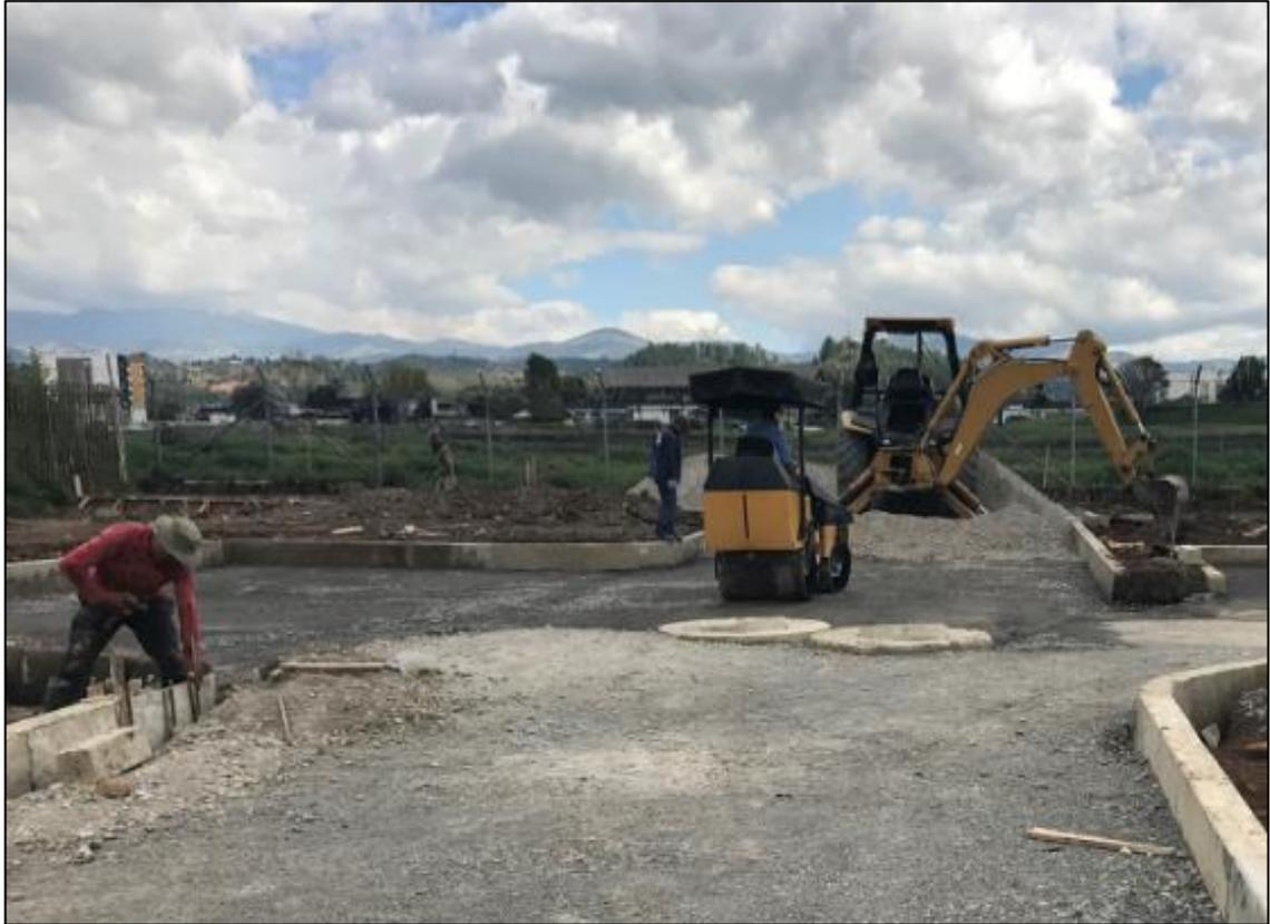
*Imagen 61: Extensión primera capa de base parte inicial eje 1, entre cámaras y vía servidumbre. Fuente: Propia.*
