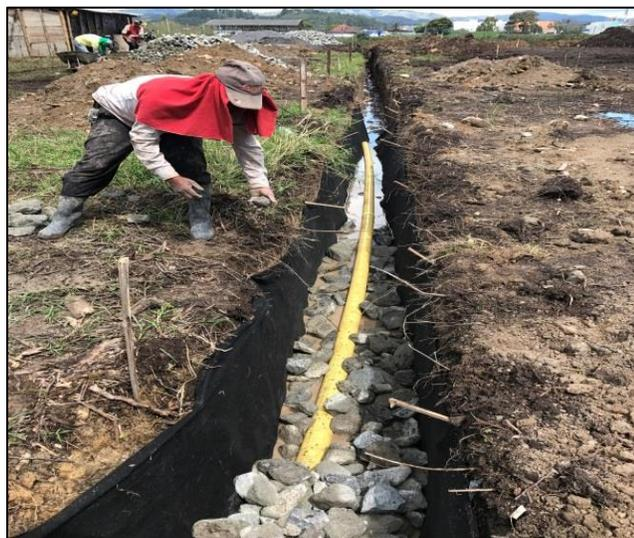
*Imagen 16: Construcción de filtro eje 1. Fuente: Propia.*
