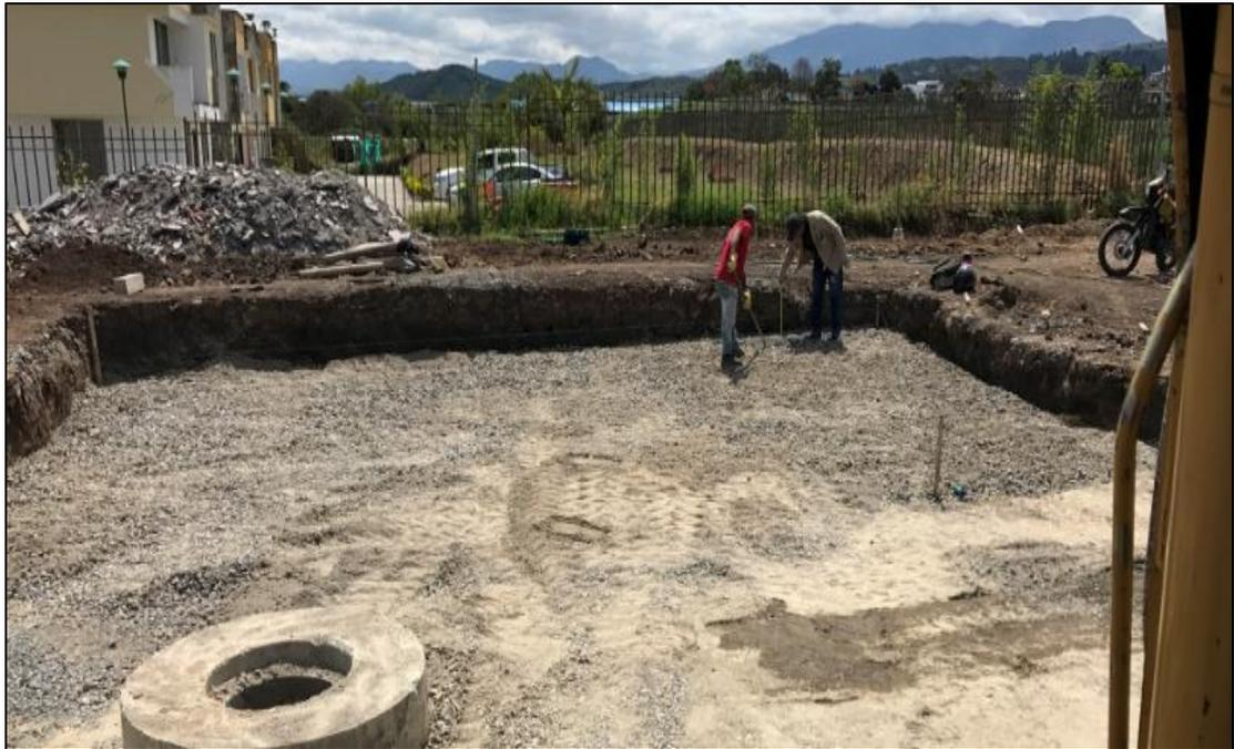
*Imagen 39: Nivelación de la capa de sub-base granular en parqueadero eje 1.
