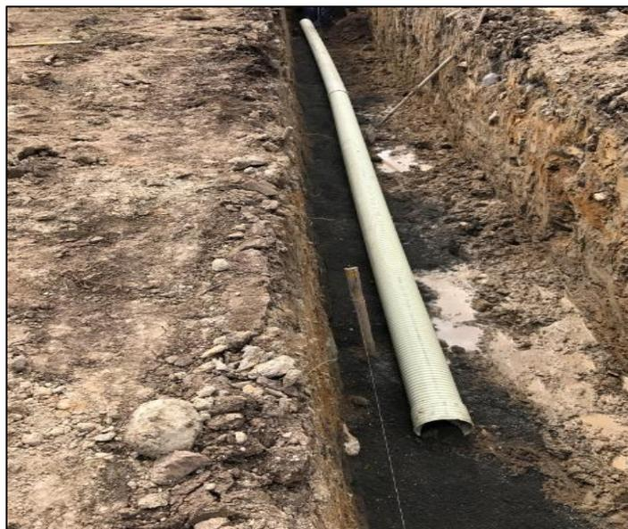
*Imagen 20: Instalación tubería para alcantarillado pluvial y sanitario eje 1.
