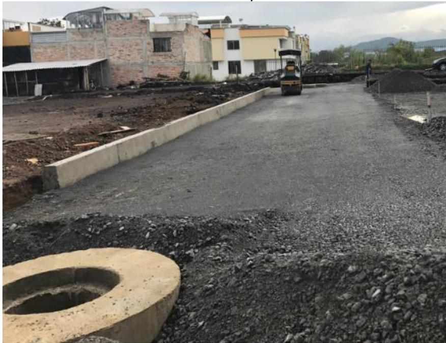
*Imagen 58: Compactación primera capa de base sobre eje 2, sobre la vía.
