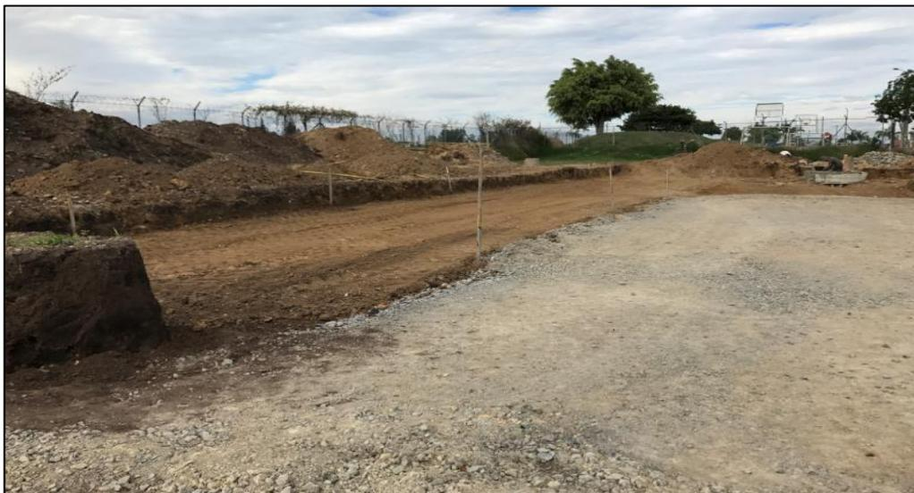
*Imagen 42: Extensión de sub-base granular sobre eje 2.
