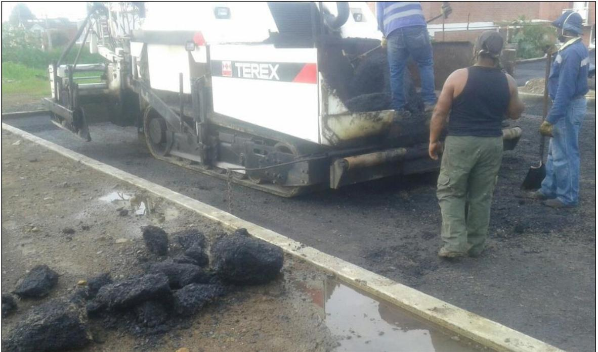
*Imagen 72: Retiro de grumos de mezcla asfáltica. Fuente: Propia.*
