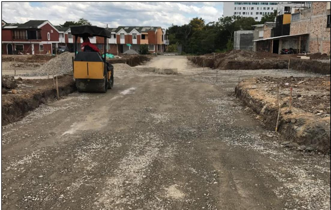
*Imagen 40: Compactación faltante del eje 1 y parqueadero en el margen derecho. Fuente: Propia.*
