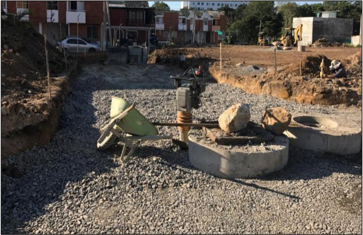
*Imagen 44: Extensión sub-base granular sobre eje 3. Fuente: Propia.*
