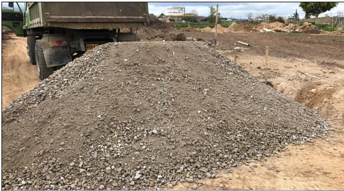
*Imagen 36: Acopio de material de sub-base sobre el eje 1. Fuente: Propia.*
