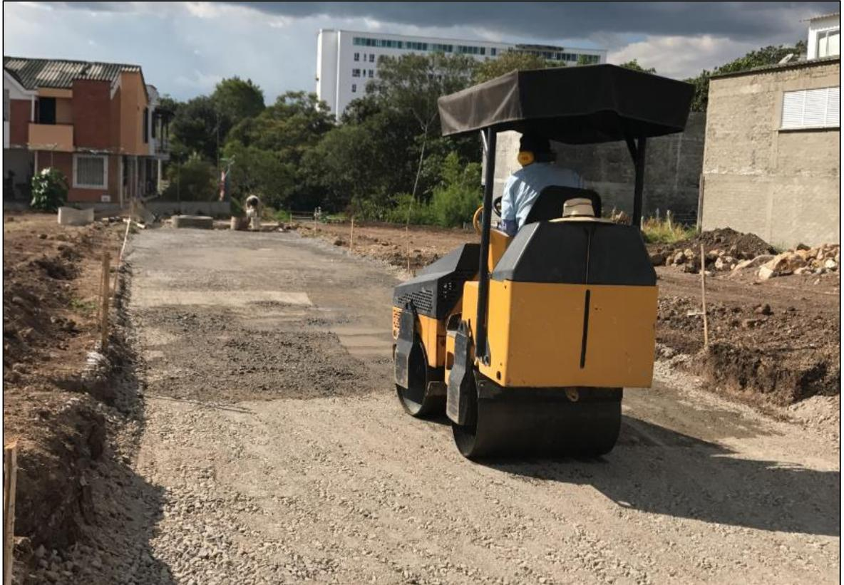
*Imagen 38: COmpactacion sub-base granular, tramo final eje 1. Fuente: Propia.*
