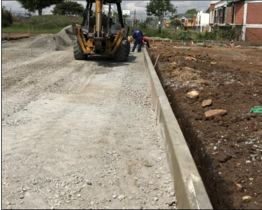
*Imagen 57: Extensión de primera capa de base sobre eje 2, sobre la vía.
