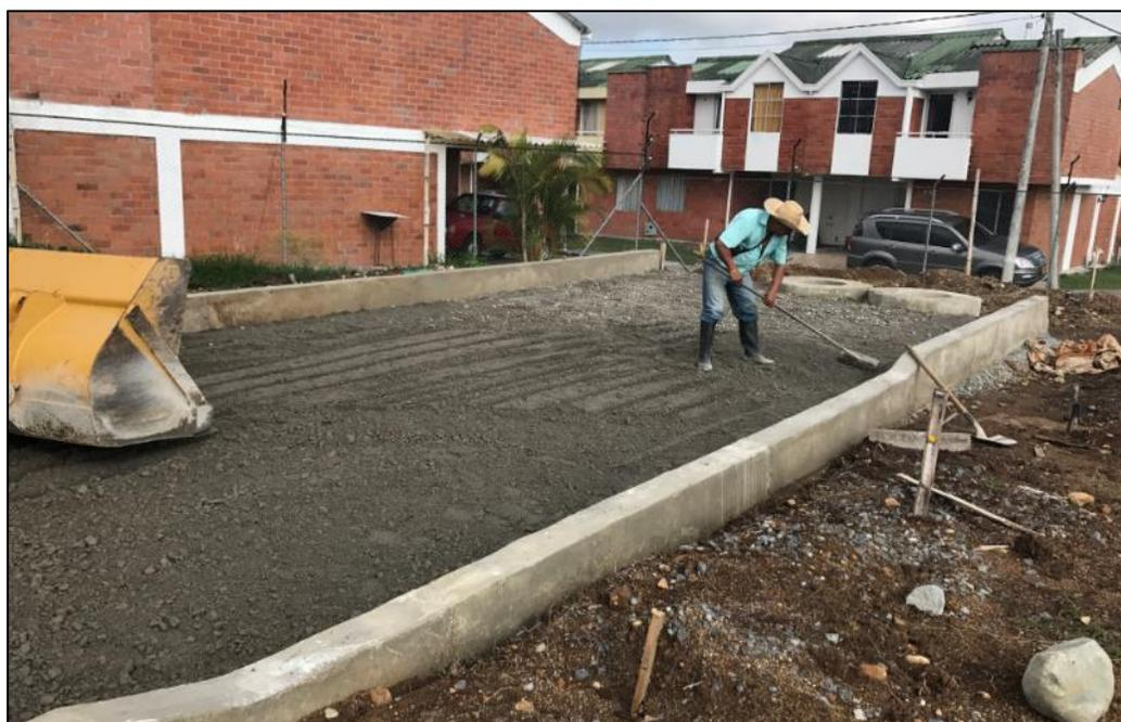
*Imagen 60: Extensión de primea capa de base sobre eje 3. Fuente: Propia.*
