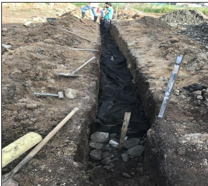
*Imagen 18: Construcción de filtro eje 3. Fuente: Propia.*
