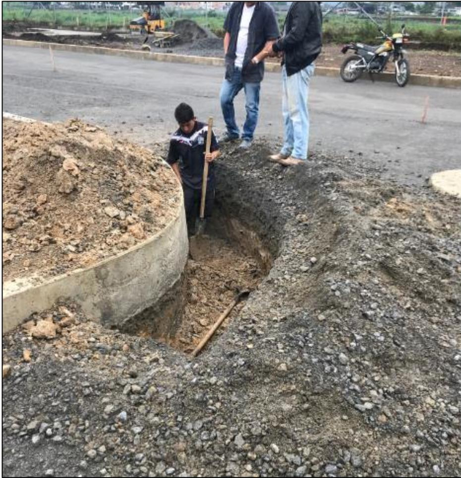
*Imagen 69: Excavación para sumidero doble, empalme eje 2 y eje 3 en curva.
