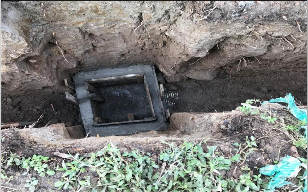
*Imagen 10: Caja de cambio de dirección para descole alcantarillado sanitario.*
