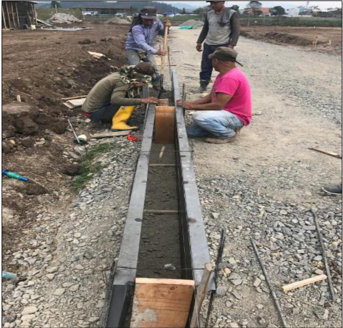
*Imagen 49: Instalación de formaleta metálica margen derecha del tramo final eje 1.
