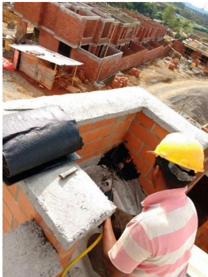
Figura 56 Instalación de manto edil.
