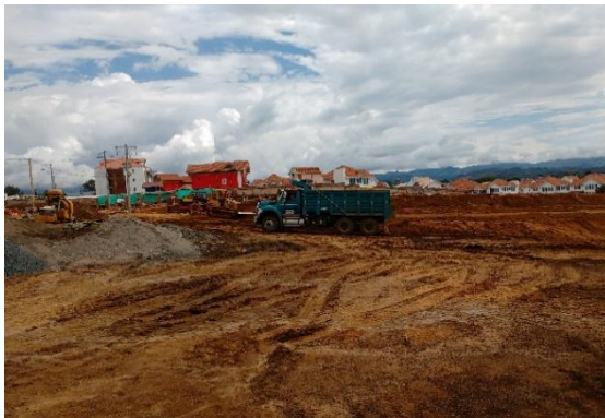
Figura 8. Movimiento de tierra
