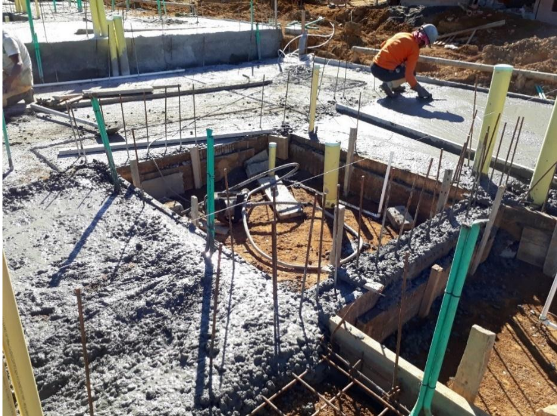
Figura 21. Fundición losa cimentación
