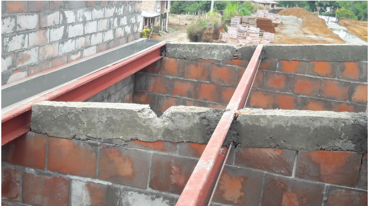
Figura 50. Instalación de perlines
