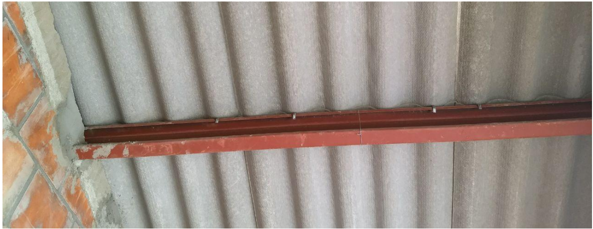
Figura 51. Anclaje de perlines
