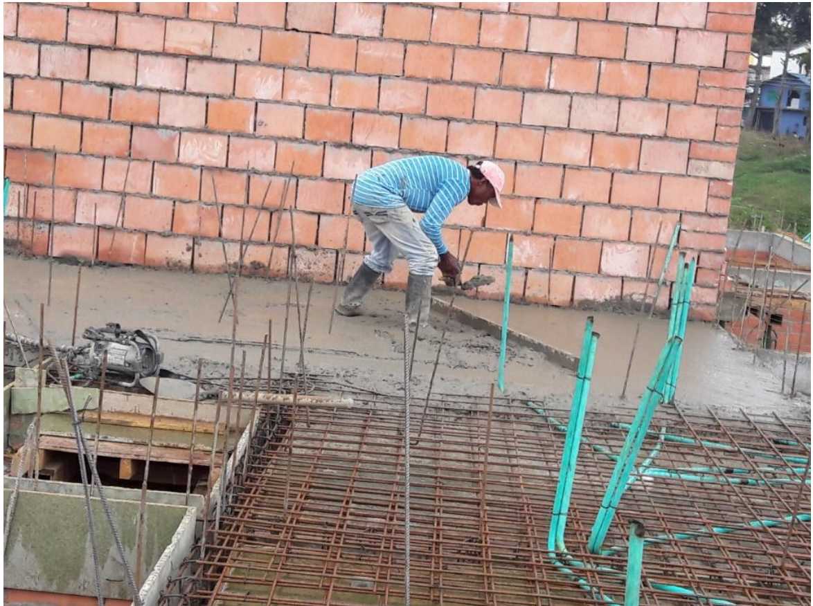
Figura 43. Fundición losa entre piso
