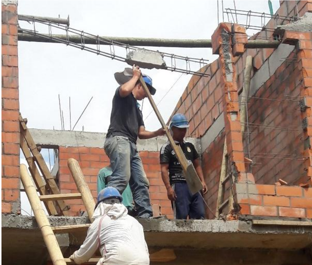
Figura 44. Retroceso muro en mampostería
