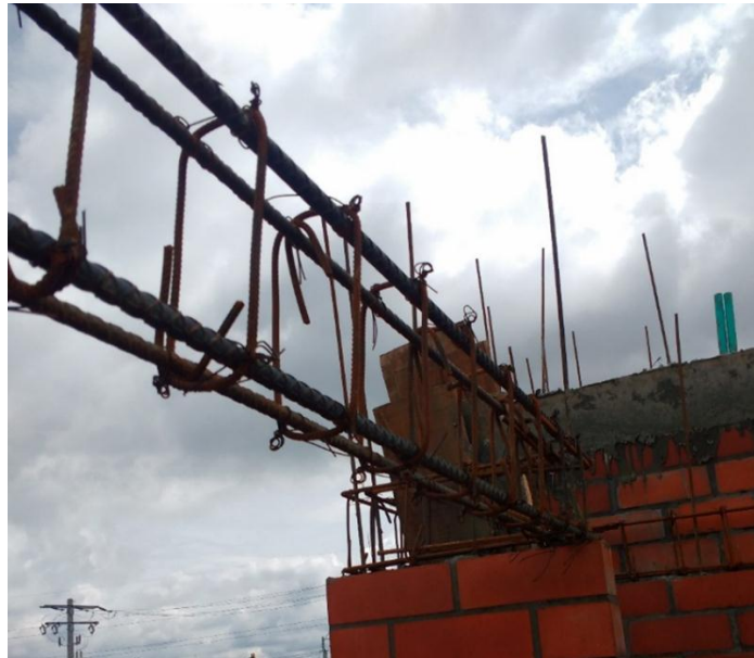
Figura 46. Acero vigas de amarre
