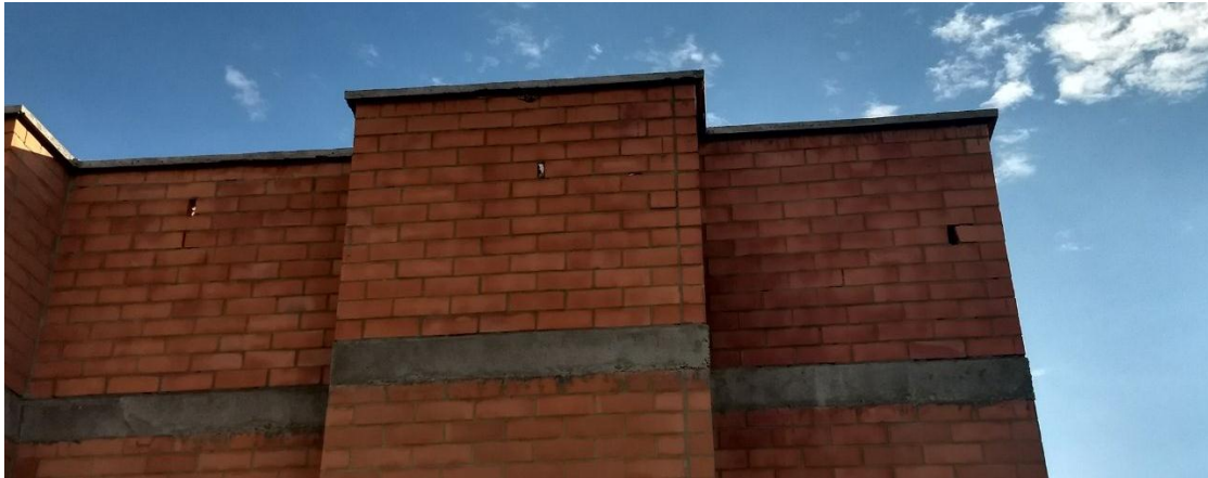
Figura 49. Mampostería de culata
