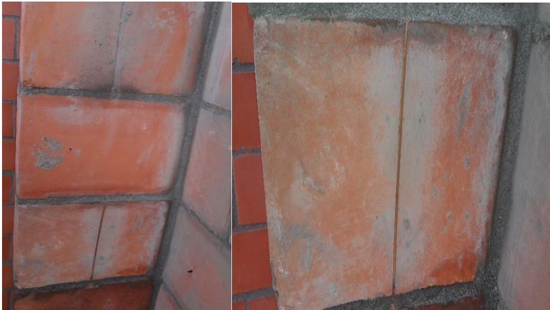
Figura 31. Cambio de fachaleta ladrillo sucio
