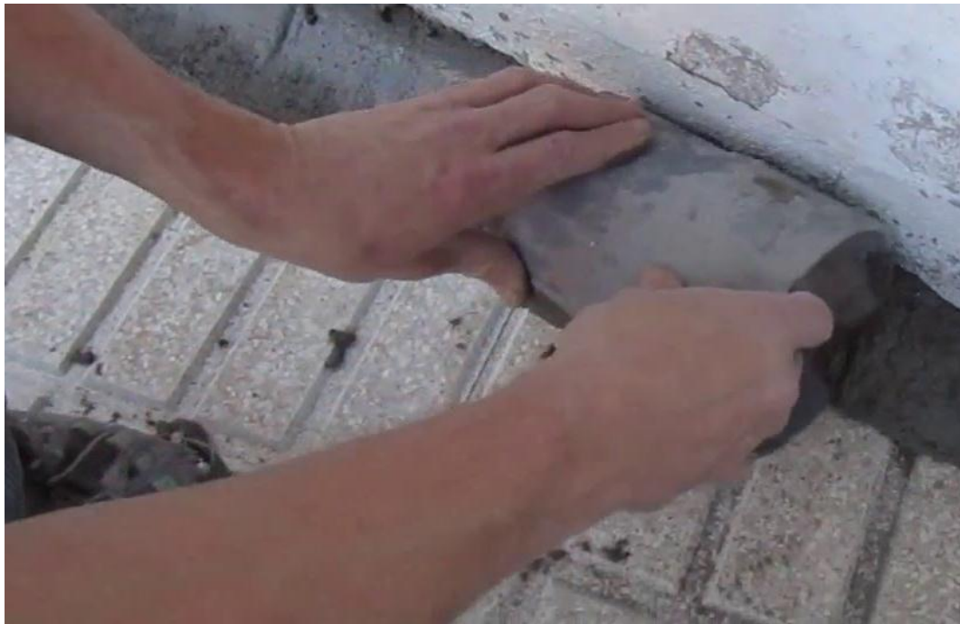
Figura 55 Instalación de media caña.
