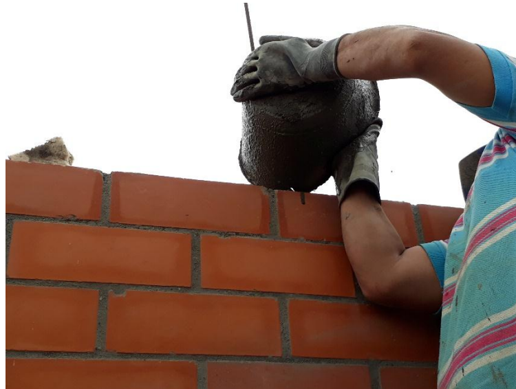
Figura 33. Fundición de dovelas
