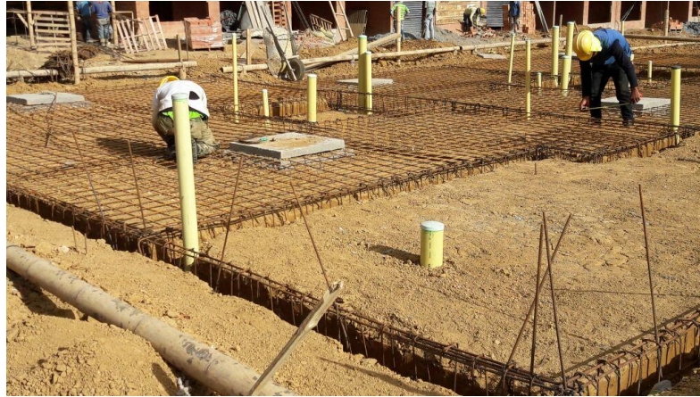
Figura 20. Losa de cimentación
