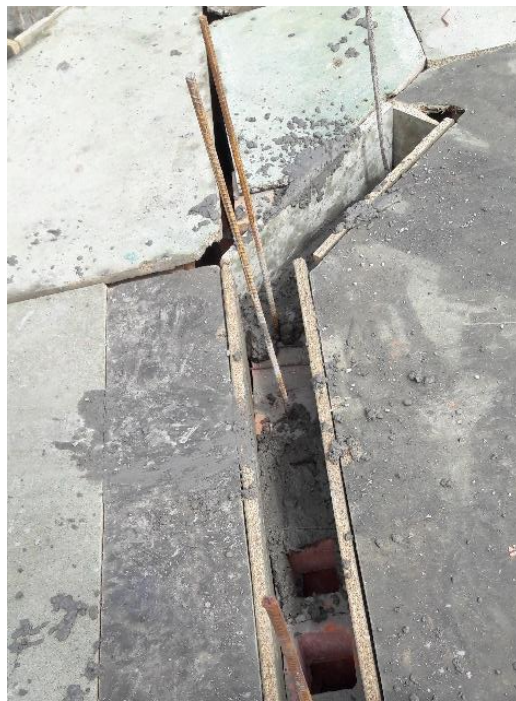
Figura 35. Dovelas adicionales losa entrepiso
