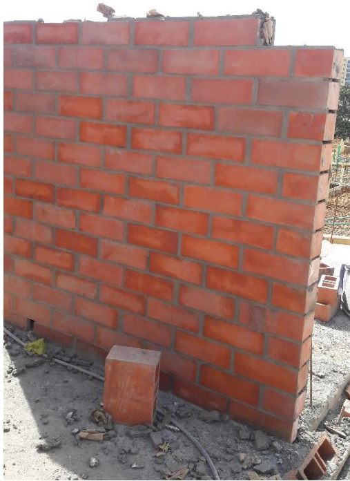
Figura 37. Muro en mampostería a la vista
