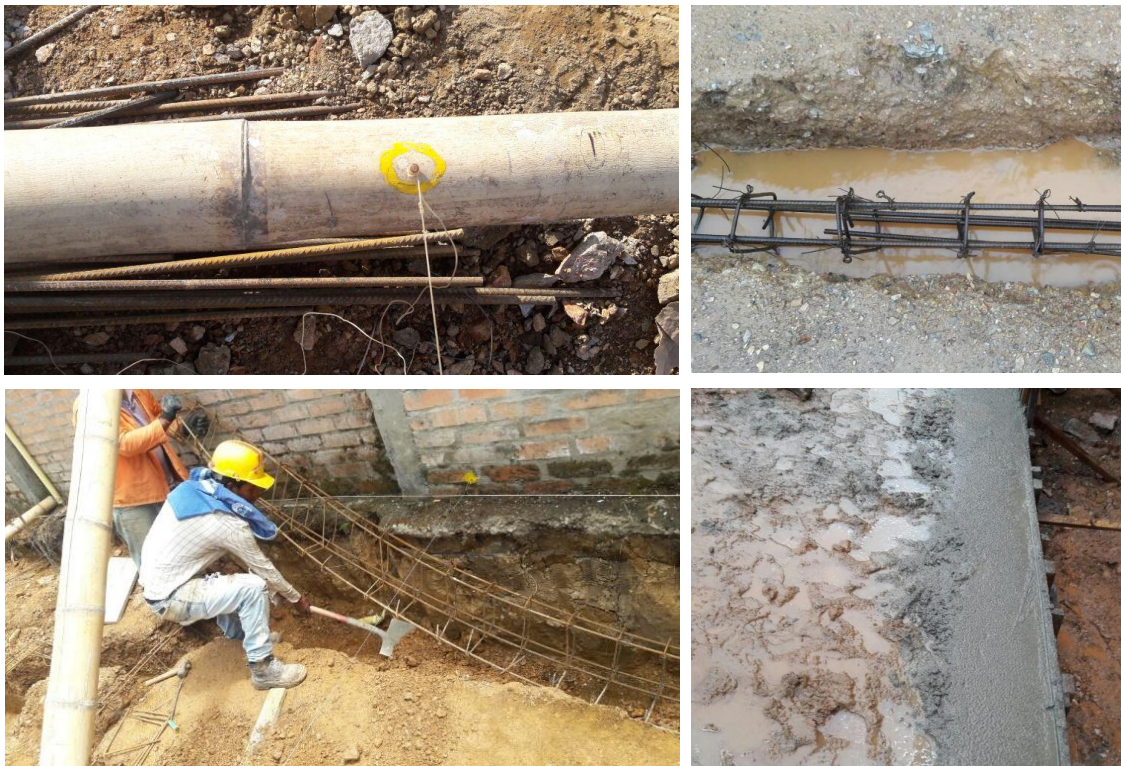
Figura 12. Localización y replanteo.
