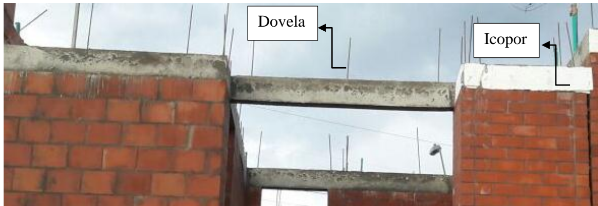
Figura 48. Fundición vigas de amarre
