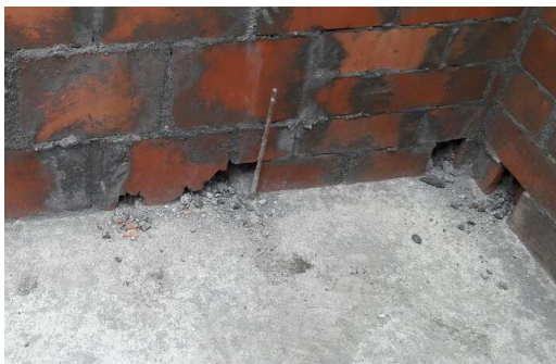
Figura 15. Arranques de dovelas
