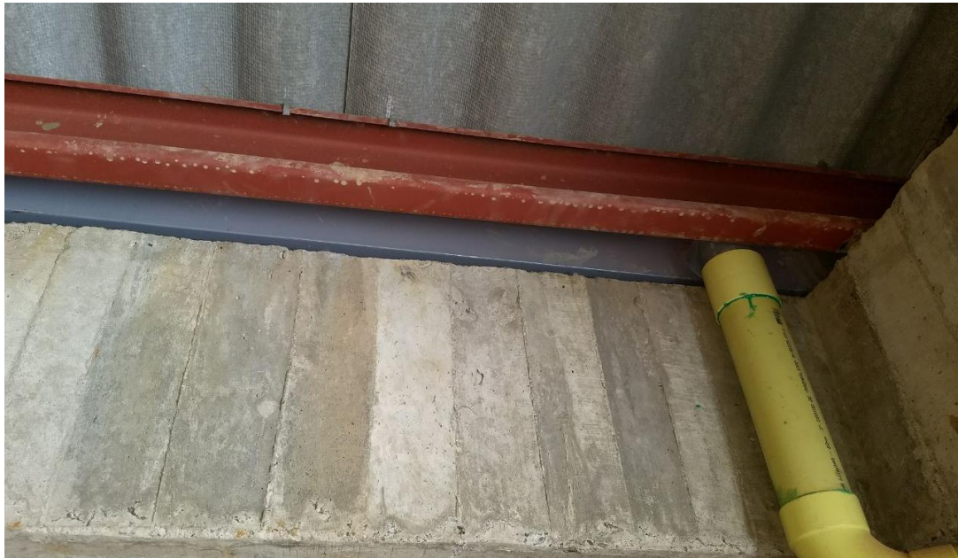
Figura 52. Instalación canal metálico
