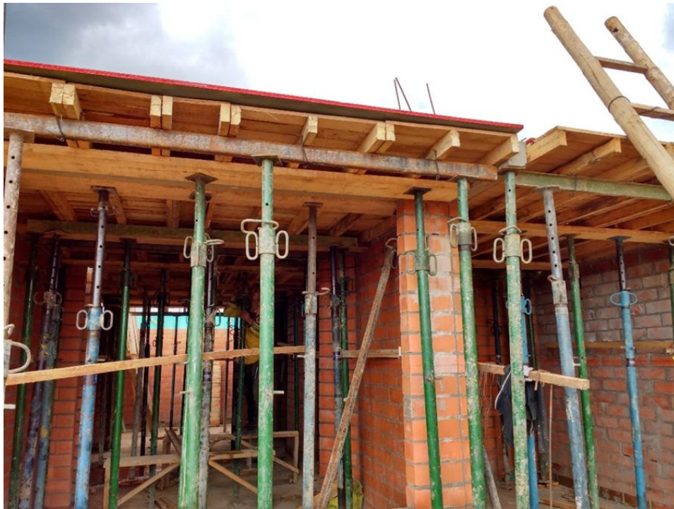
Figura 38. Formaleta losa entrepiso
