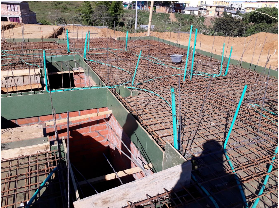
Figura 39. Ubicación acero losa entrepiso
