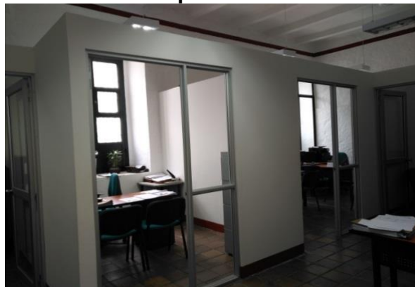
Figura 4.10 Marcos para puertas instaladas, divisiones y pintura blanca aplicada.
