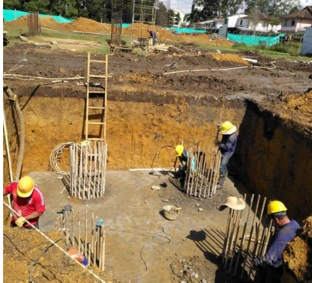
Figura 4.19 Obreros trabajando en uno de los dados
