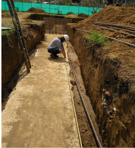
Figura 4.23 Toma de medidas de las varillas de acero.
