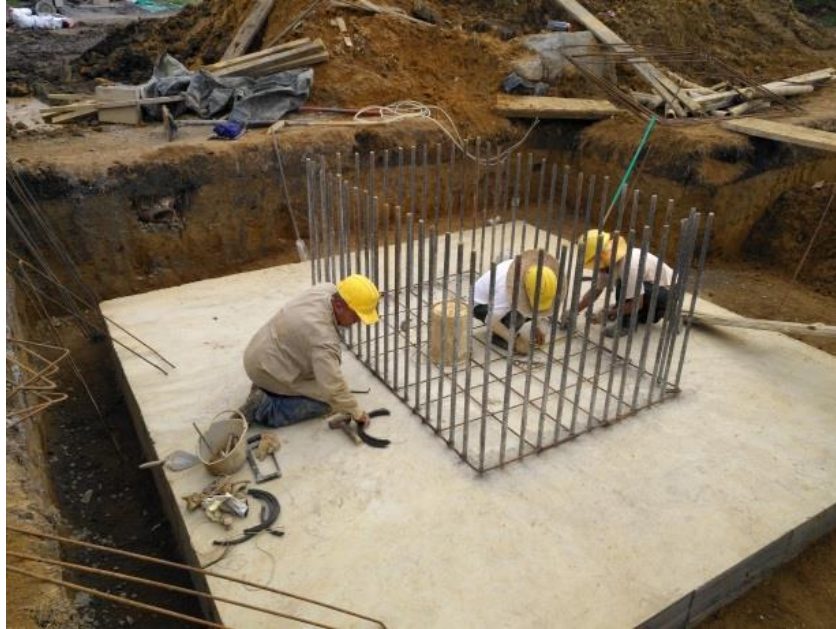
Figura 4.21 Armado de acero
