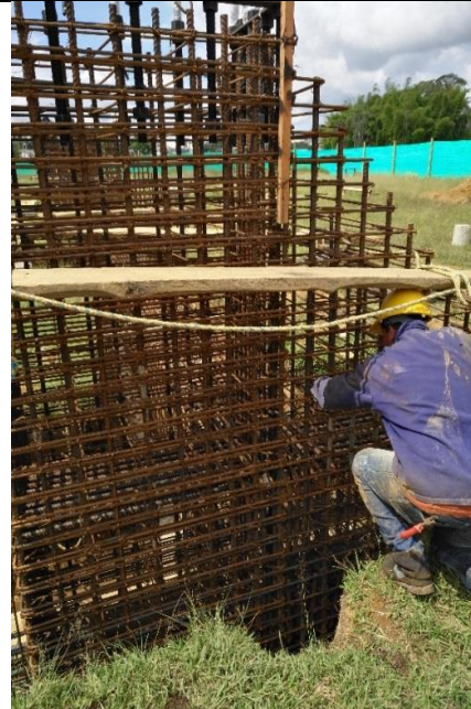
Figura 4.29 Vista de perfil del pedestal.
