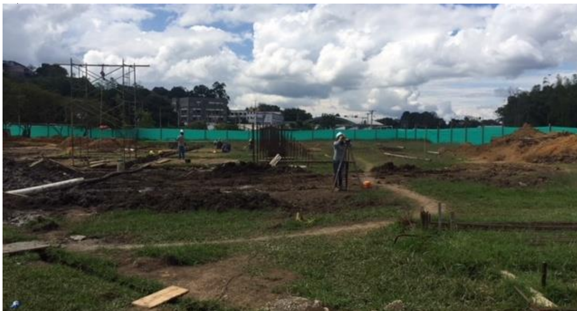
Figura 4.25 Toma de niveles en obra.
