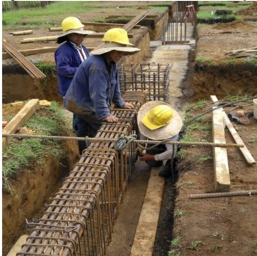
Figura 4.15 Personal de la obra CECUN instalando flejes.
