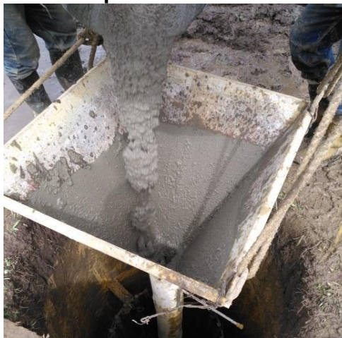
Figura 4.17 Fundición de pilotes en concreto de 3100psi- 22MPA premezclado.
