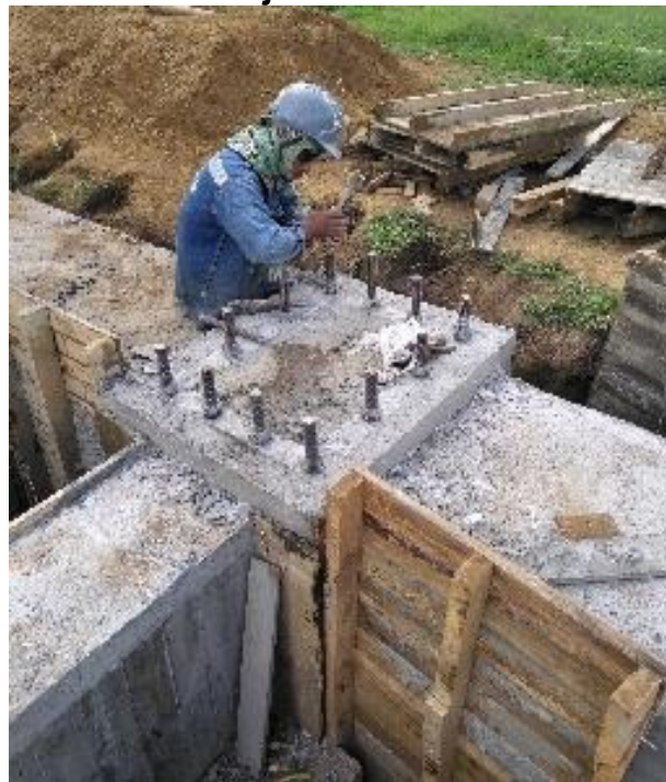
Figura 4.30 Operario de MEISA trabajando en la instalación de la placa base cajón armado.
