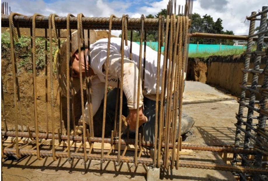
Figura 4.14. Amarre de flejes en viga de cimentación
