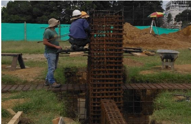
Figura 4.27 Operarios de MEISA trabajando en la instalación de pernos para acoplamiento de columnas metálicas en pedestales inclinados.
