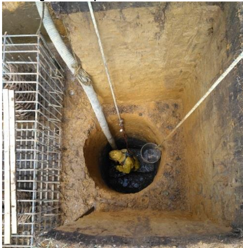
Figura 4.18. Operario dentro del Caisson.
