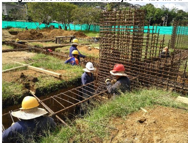
Figura 4.26 Instalación de flejes de 420 MPA.
