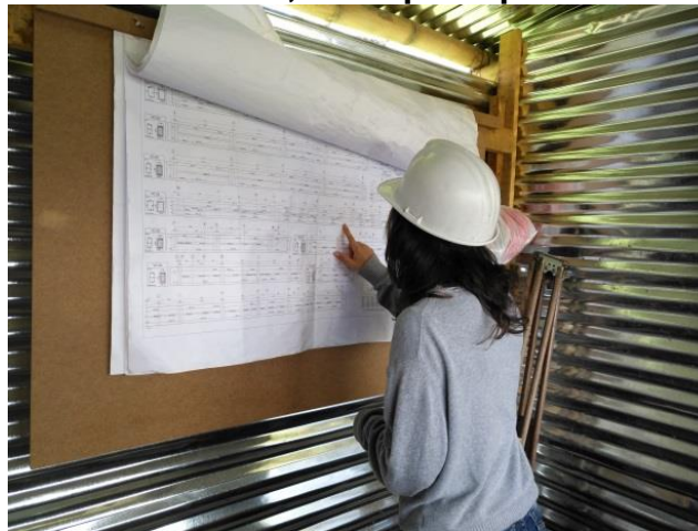
Figura 4.20 Revisión del número de varillas y longitud correspondiente a cada viga de cimentación, tanto principal como secundaria.
