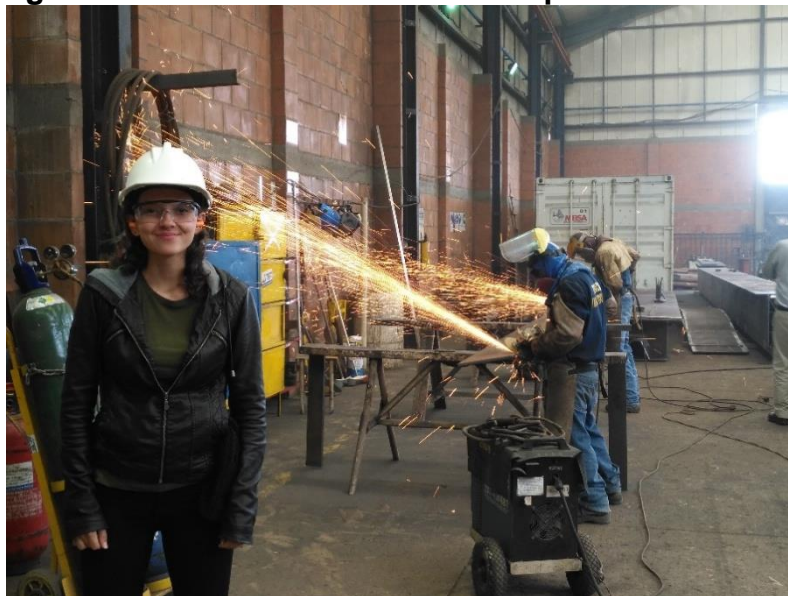
Figura 4.44 Proceso de soldadura en piezas metálicas.
