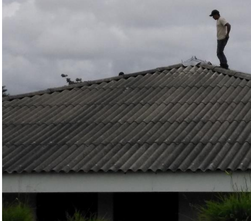
Figura 4.49 Operario sin ninguna protección dada la altura del predio, instalación de para rayos en la Facultad de Ciencias Agrarias.
