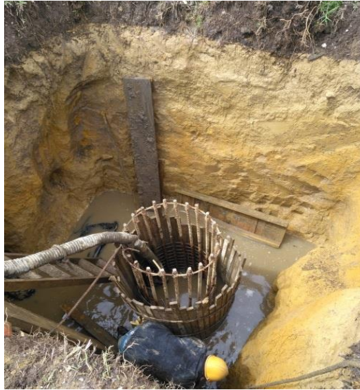
Figura 4.16 Succión del agua en el pilote por bombeo, se puede observar una parte del Castillo de acero y formaleta del pilote
