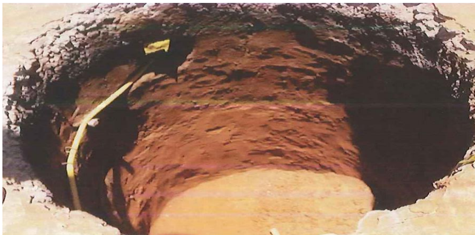
Figura 4. Excavación manual en material conglomerado hasta 2.5 m.
