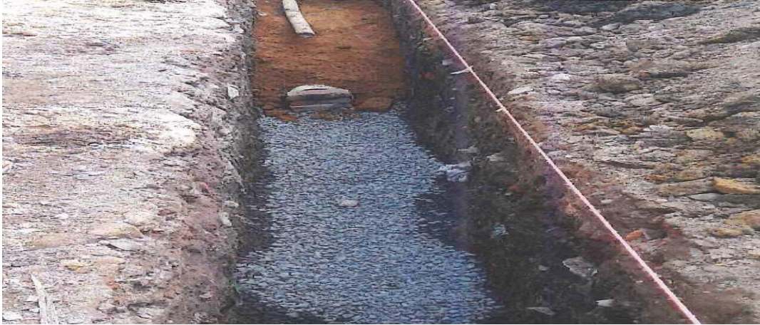
Figura 8. Colocación de material granular para cimentación.
