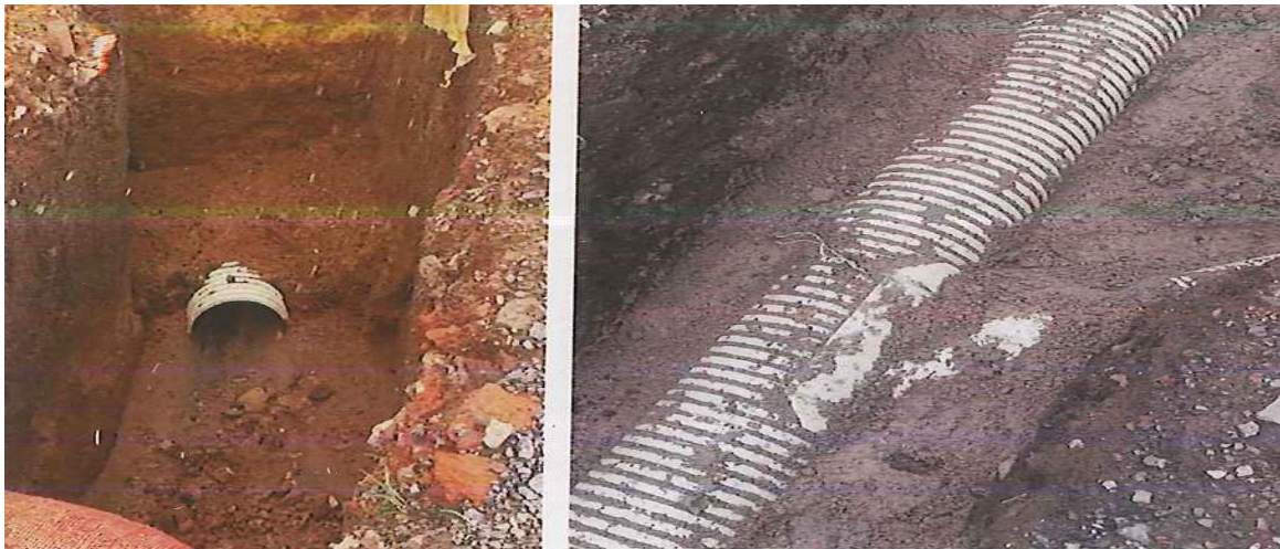
Figura 11. Suministro e instalación de tubería PVC unión mecánica alcantarillado D = 10”.
