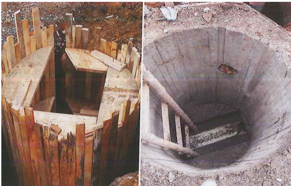
Figura 19. Construcción de una cámara de inspección.
