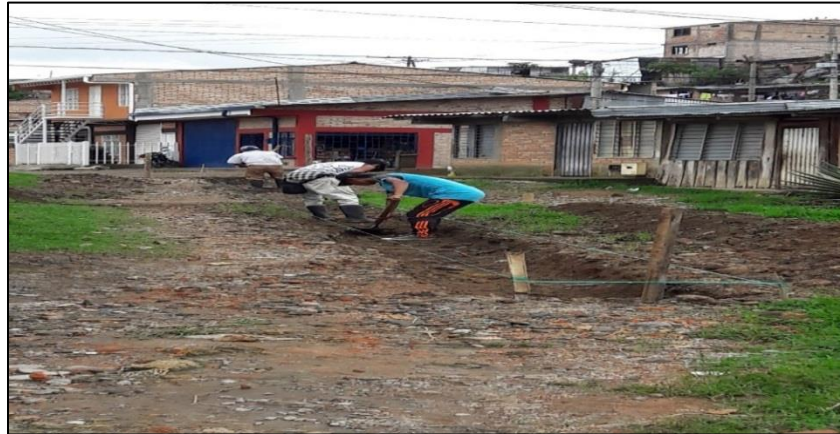
Figura 3. Excavación manual en material común hasta 2.5 m.
