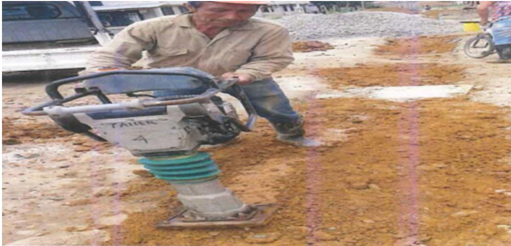
Figura 40. Se realizo relleno tipo II mecánico con material limo-arcilloso.
