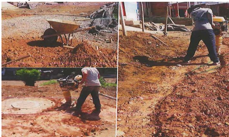
Figura 15. Relleno tipo III, mecánico con material roca muerta.
