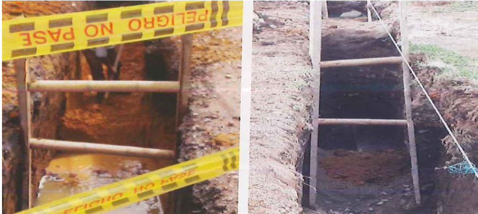
Figura 5. Entibado apuntalado en madera cara en contacto con talud.
