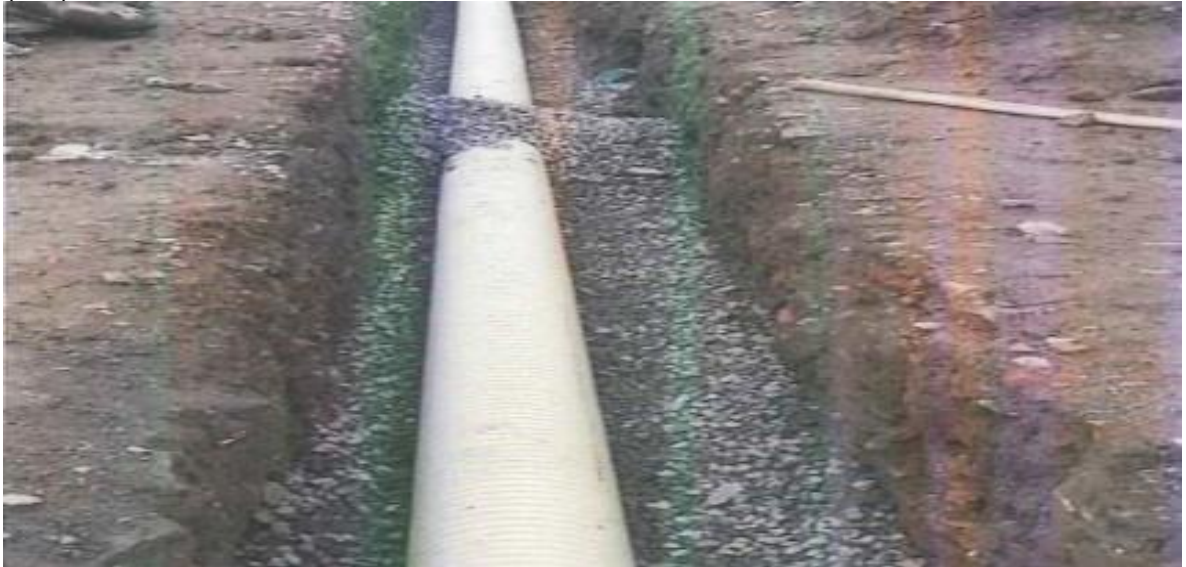
Figura 37. Suministro e instalación tubería PVC U.M para alcantarillado D=250 mm (10").
