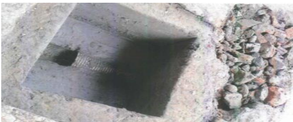
Figura 42. Construcción cajas de distribución en concreto 0.6x0.6x1 tapa e=0.1m acometidas domiciliarias.
