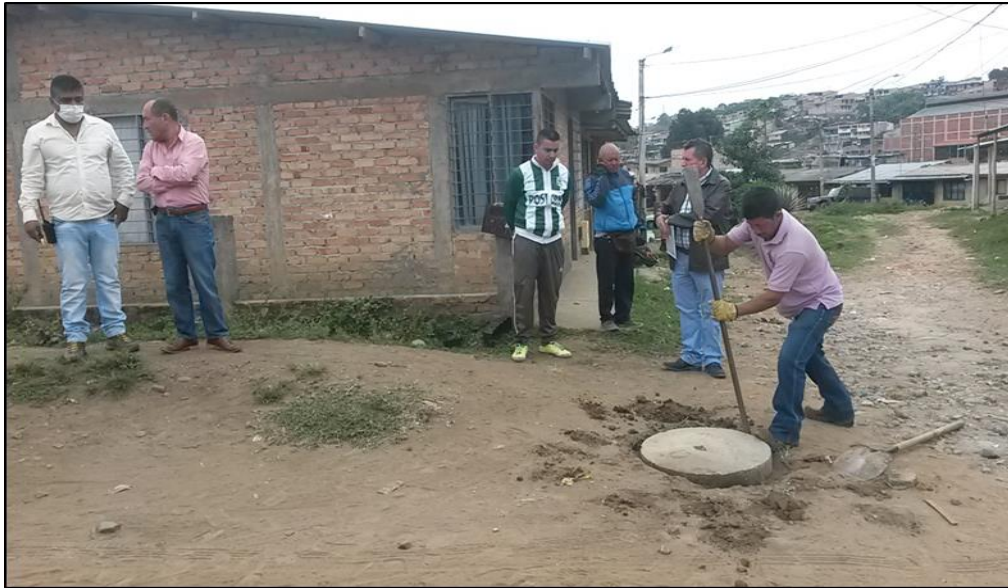
Figura 1. Reposición colector sanitario carrera 33 B, calle 17 A hacia la transversal 33C, Barrio 31 de marzo.
