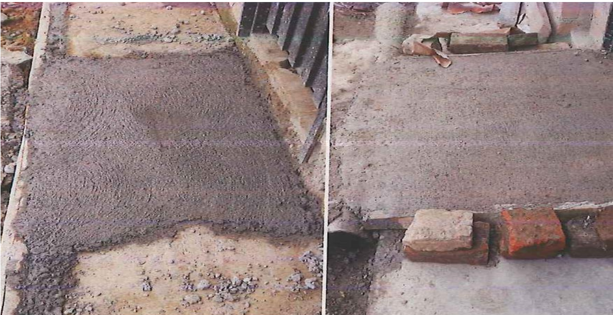
Figura 25. Construcción de andenes en concreto de 2500 psi.
