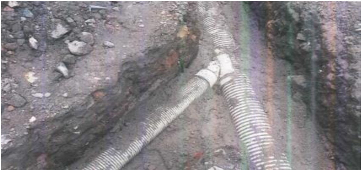
Figura 38. Suministro e instalación de acometidas domiciliarias mediante tubería PVC U.M para alcantarillado D=160mm (6").
