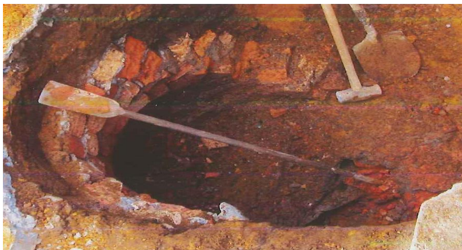
Figura 17. Demolición de cámara de inspección en ladrillo.
