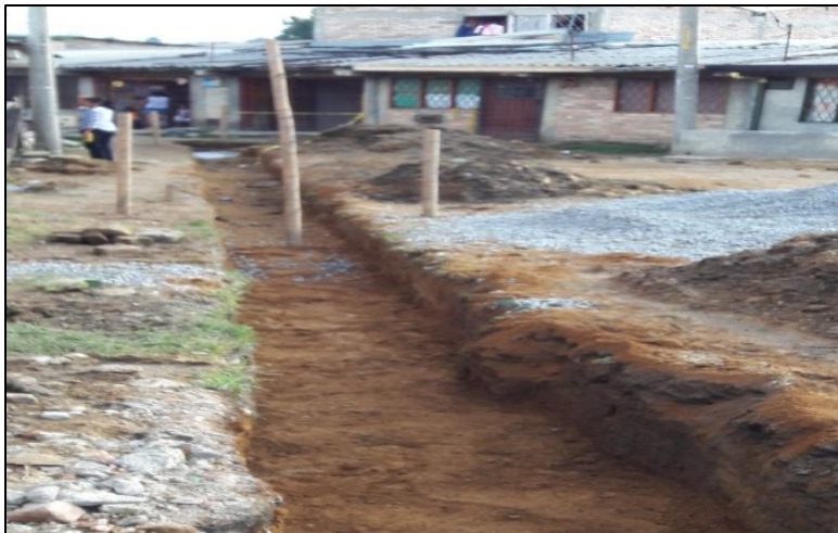
Figura 14. Relleno con material de préstamo, tipo II mecánico, limo-arcilloso.
