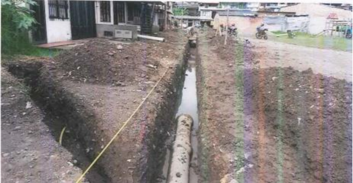
Figura 35. Se retira la tubería de concreto existente.
