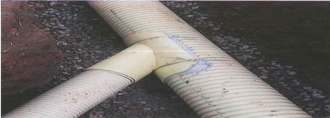
Figura 12. Suministro e instalación de silla YEE PVC para alcantarillado de 10" x 6".
