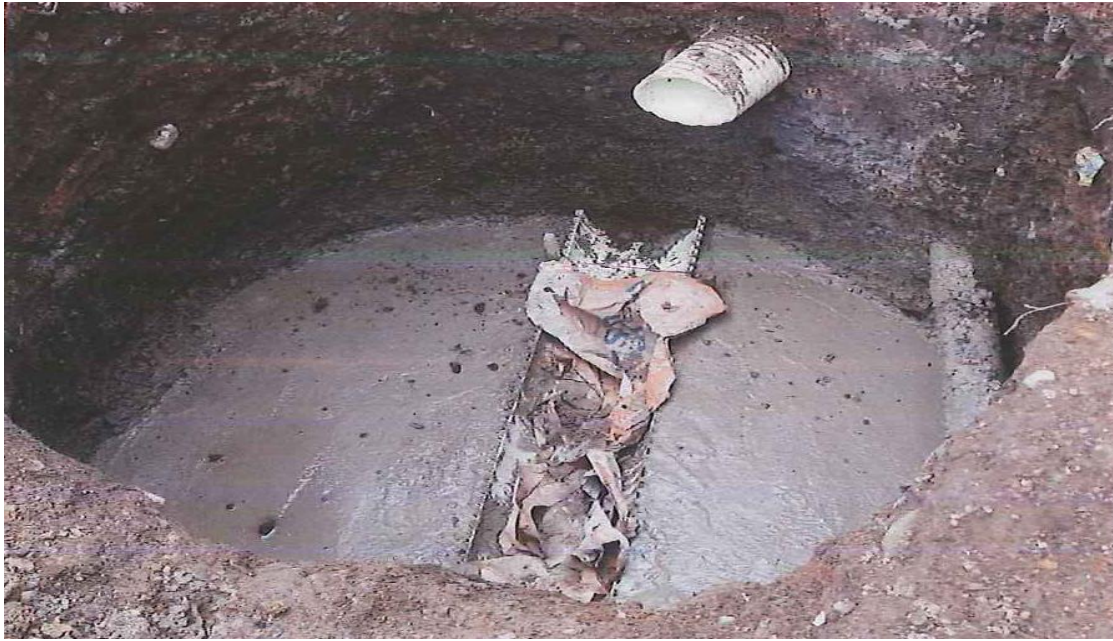
Figura 18. Construcción losa de fondo concreto 3000 PSI para cámara de inspección, incluye cañuela.
