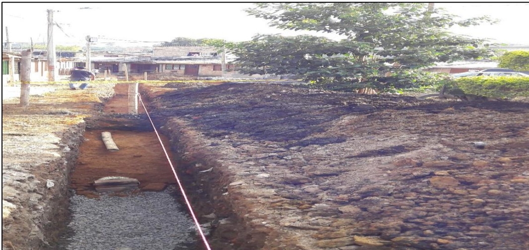
Figura 9. Construcción de filtro en grava para tubería.
