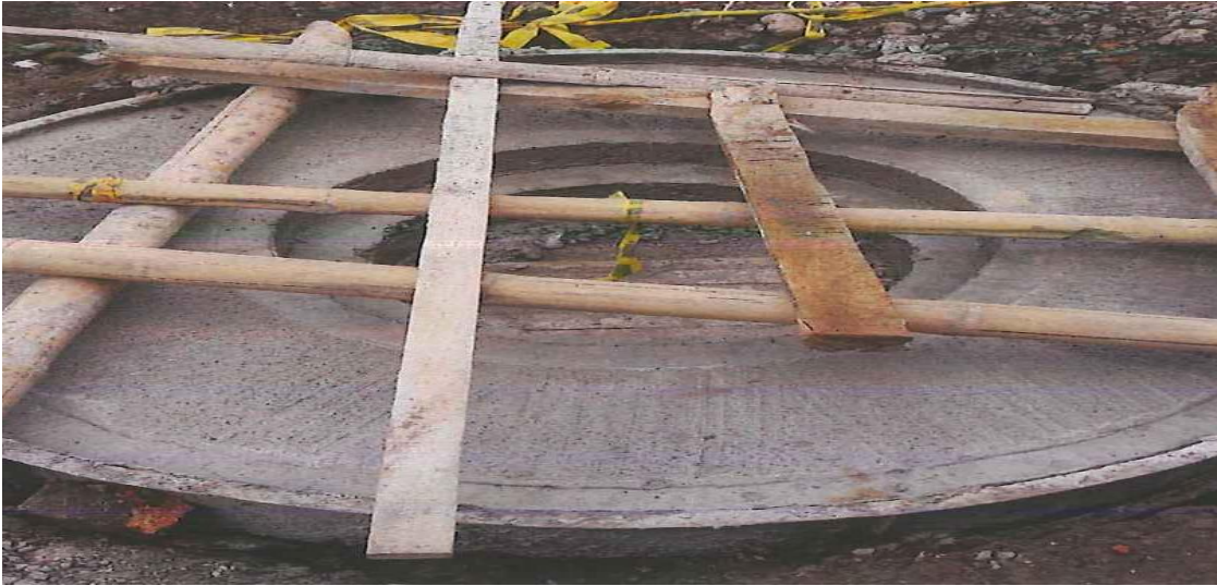
Figura 20. Construcción de brocal en concreto de 4000 PSI D = 1.5 m.
