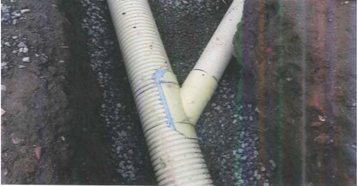
Figura 39. Instalación de silla YEE de PVC de 10"×6" (250mm×160mm), tubería PVC U.M para alcantarillado D=160mm (6").
