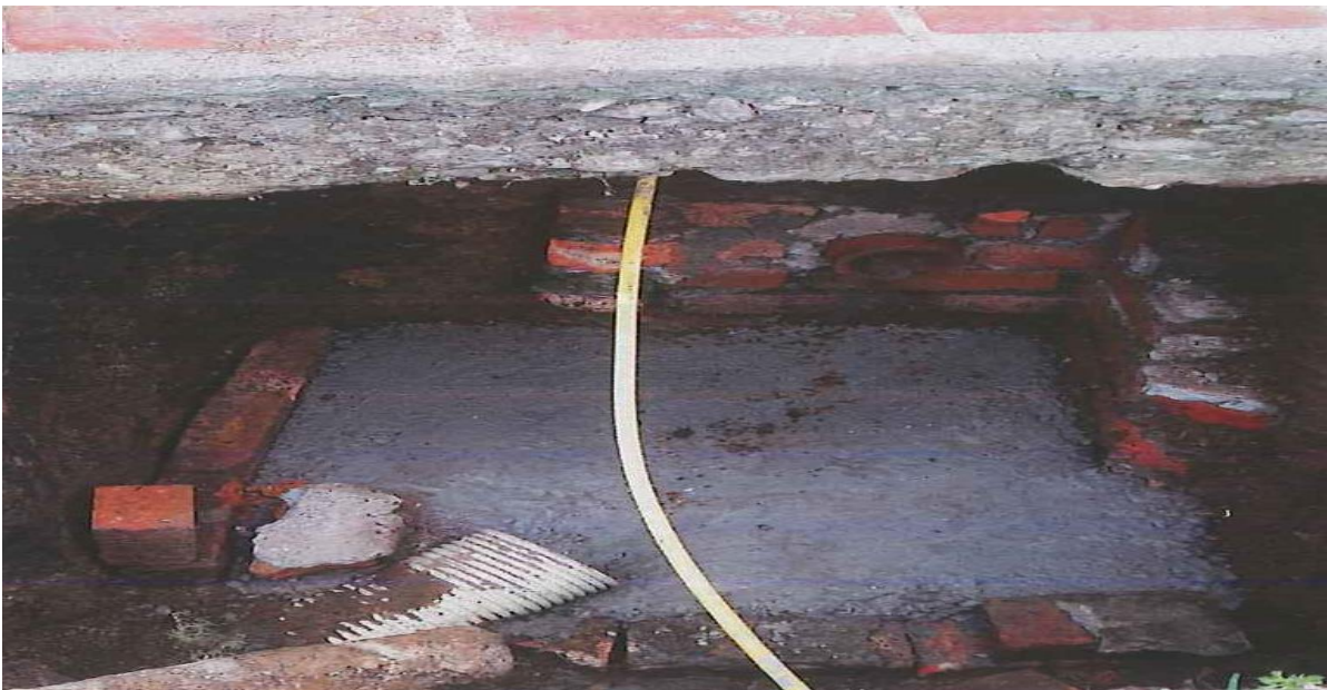
Figura 23. Demolición de cajas de distribución en ladrillo.
