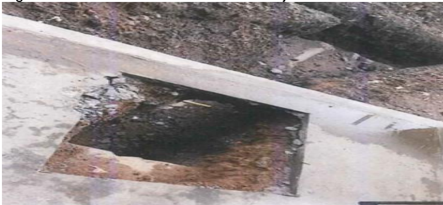
Figura 41. Actividad de demolición de cajas de distribución en ladrillo.
