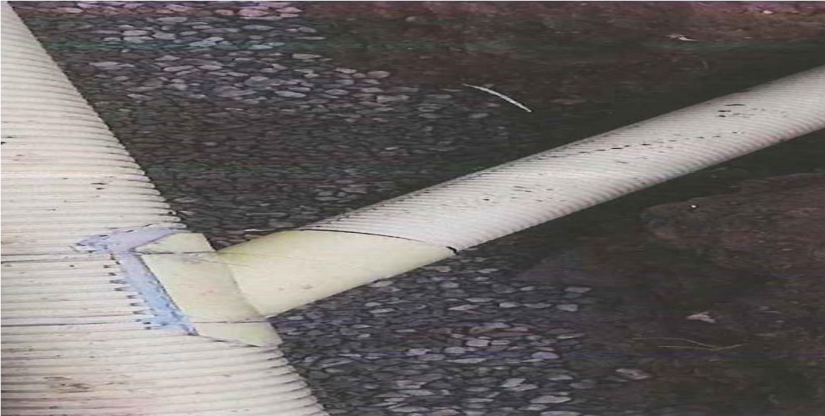
Figura 10. Suministro e instalación de tubería PVC unión mecánica alcantarillado D = 6”.
