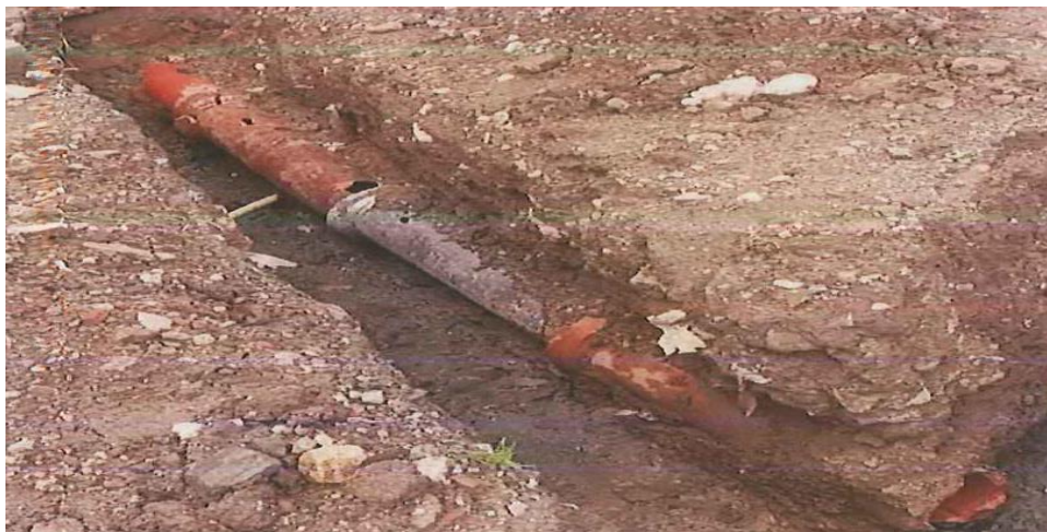
Figura 6. Retiro de la tubería existente.
