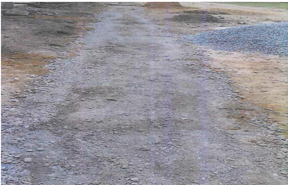
Figura 28. Suministro y compactación de sub-base.
