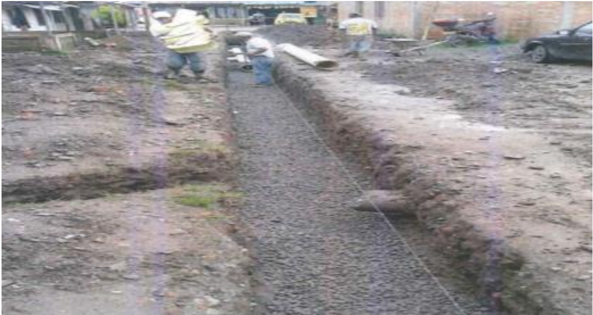
Figura 36. Suministro y colocación de material granular para cimentación en grava 3/4".
