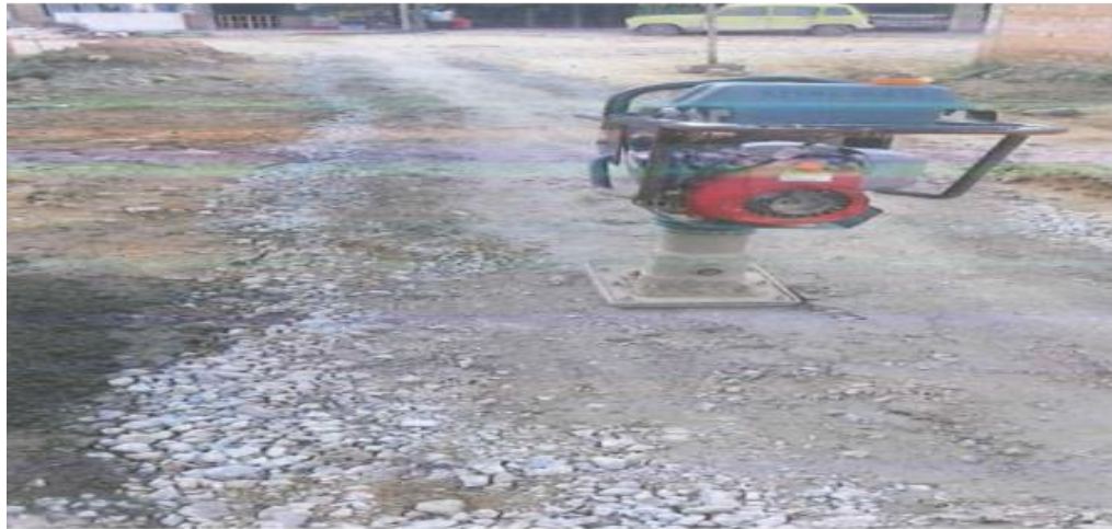
Figura 43. Suministro riego y compactación de sub-base mecánico.
