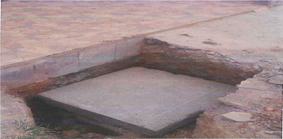
Figura 22. Demolición de andenes en concreto.
