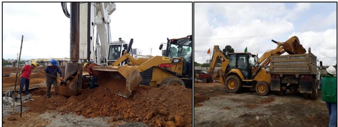
Figura 53. Proceso de cargue y descargue de material.
