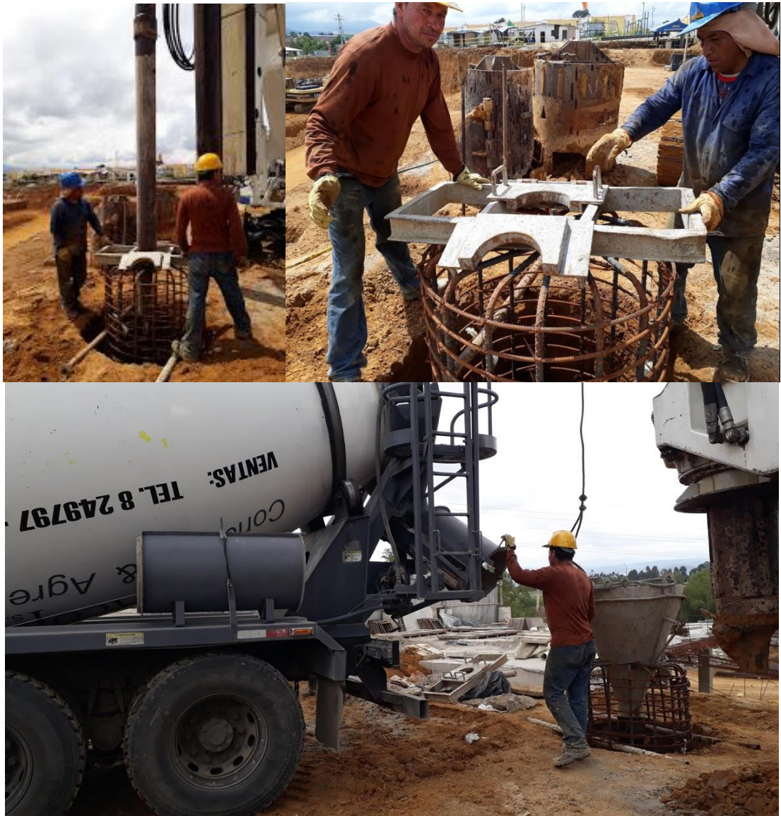
Figura 55. Proceso de vaciado del concreto tremie para fundición de los caissons.
