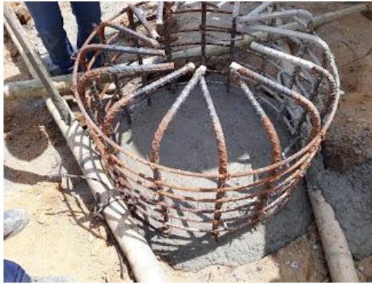
Figura 57. Terminación del proceso de fundición de un caisson para la cimentación profunda.
