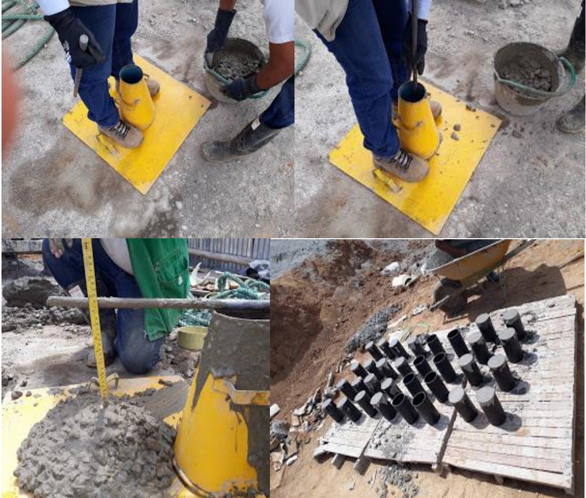
Figura 56. Muestras tomadas del concreto para verificar el estado de la mezcla.
