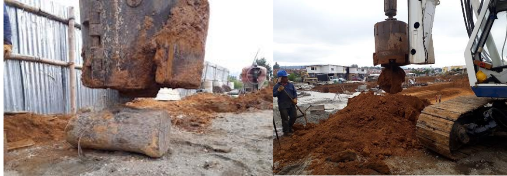
Figura 50. Descargue de suelo por la Piloteadora.
