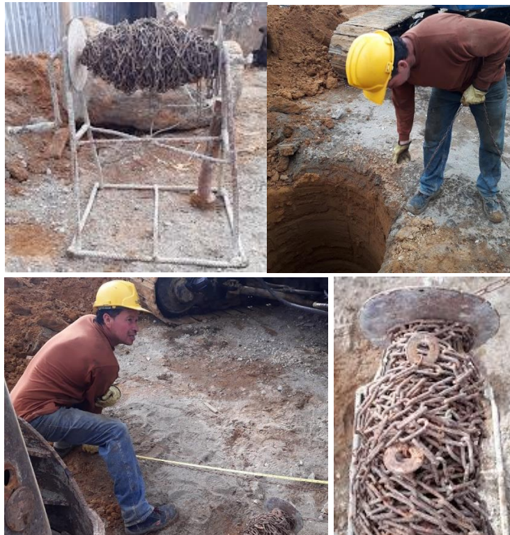
Figura 51. Proceso de medición de la profundidad de los caissons.
