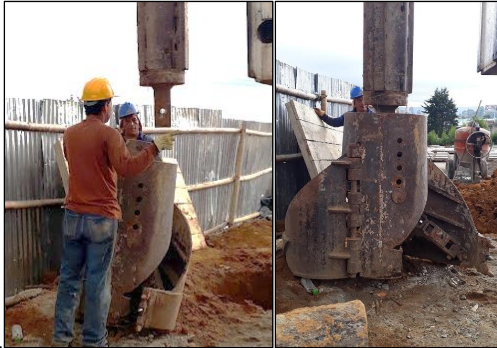
Figura 52. Proceso de cambio de accesorio de la piloteadora.
