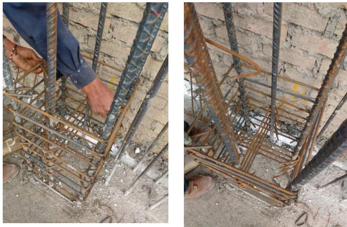
Figura 58. Amarre de estribos y ganchos para columnas. Fuente: tomada por pasante.
