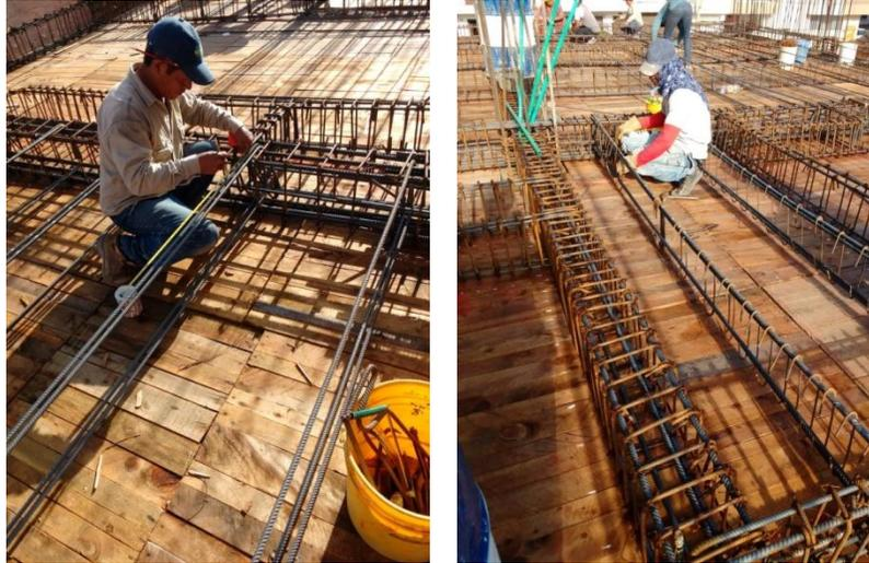
Figura 84. Colocación y amarre de aceros para losa aligerada. Fuente: tomada por pasante.
