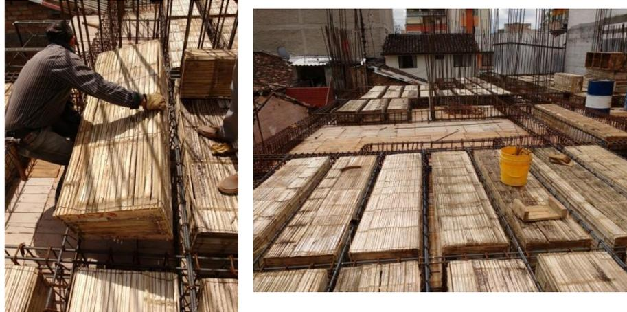
Figura 86. Colocación de casetones para losa de entrepiso. Fuente: tomada por pasante.
