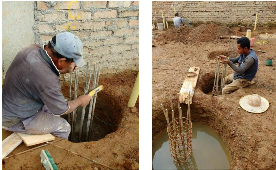
Figura 24. Adecuación de la parte superior de los pilotes. Fuente: tomada por el pasante
