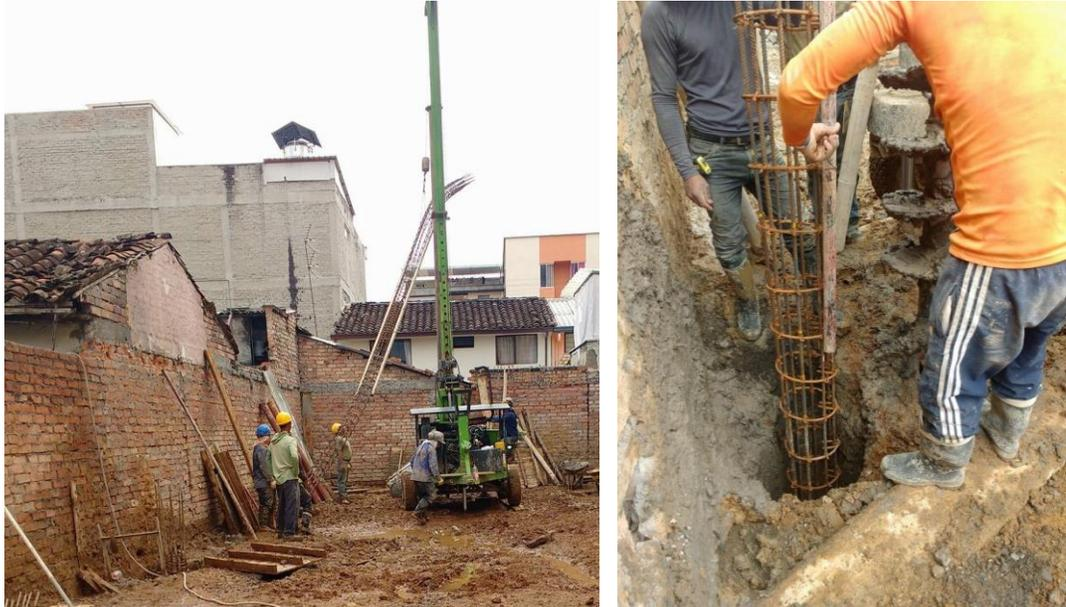
Figura 8. Colocación de los castillos de acero para los pilotes. Fuente: tomada por el pasante
