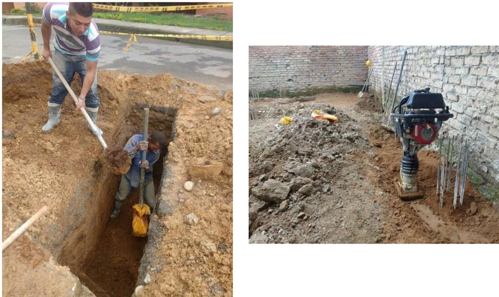
Figura 20. Colocación de tubería y relleno de zanjas. Fuente: tomada por el pasante
