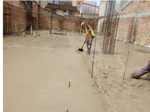
Figura 56. Tallada y vibrada de mezcla de concreto. Franja para instalación de redes.
