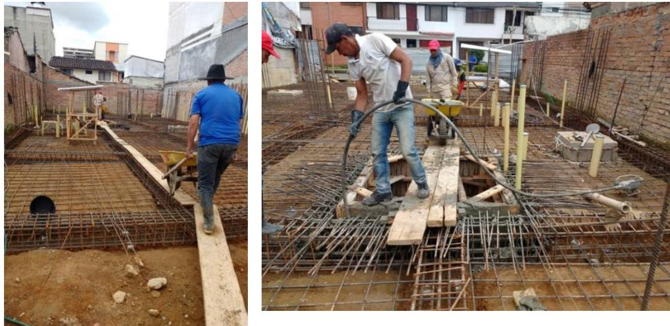
Figura 41. Fundición del foso de ascensor. Fuente: tomada por pasante.
