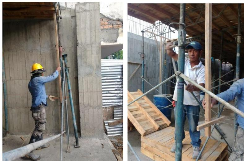
Figura 80. Ajuste de nivelación para entablado de losa de entrepiso. Fuente: tomada por pasante.
