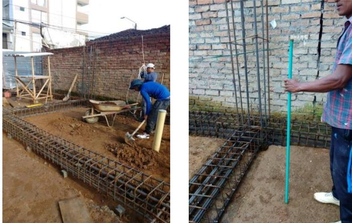
Figura 43. Perfilación y chequeo de la misma, para el terreno de la losa de cimentación. Fuente: tomada por pasante.
