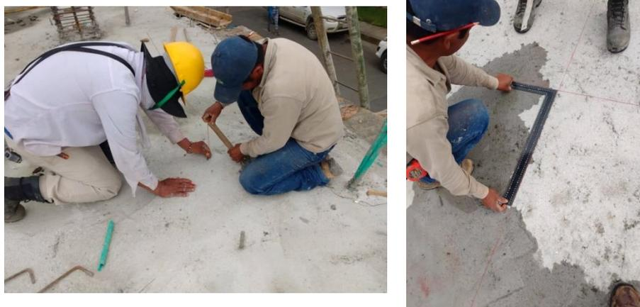
Figura 92. Cimbrado de formaleta para pantallas y columnas del piso 2. Fuente: tomada por pasante.
