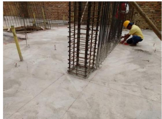
Figura 62. Cimbrado de formaletas para pantallas y columnas. Fuente: tomada por pasante.
