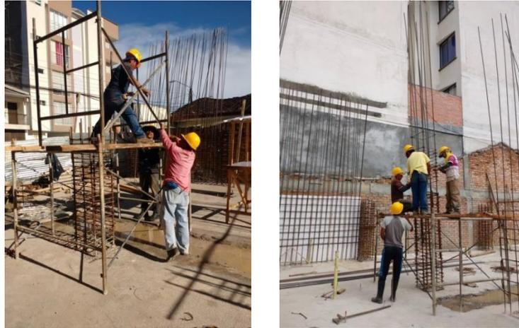
Figura 59. Colocación de andamios y amarre de aceros longitudinales para columnas.
