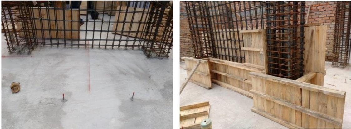
Figura 65. Colocación de camillas para formaleta. Fuente: tomada por pasante.
