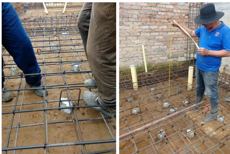
Figura 46. Recubrimiento de aceros y chequeo de niveles. Fuente: tomada por pasante.
