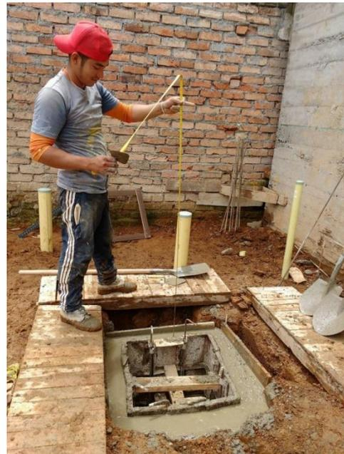
Figura 23. Fundición cajas de desagüe. Fuente: tomada por el pasante
