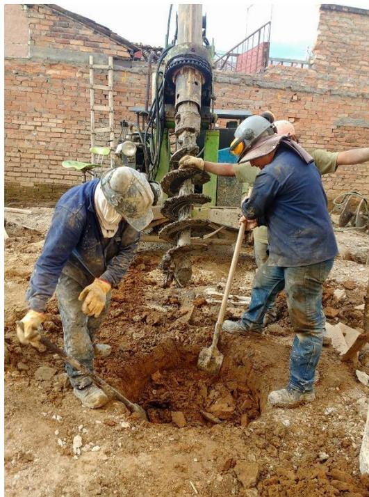
Figura 7. Excavación correspondiente a pilotes. Fuente: tomada por el pasante
