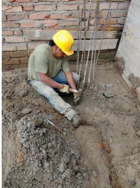
Figura 13. Demolición parte superior pilote. Fuente: tomada por el pasante.
