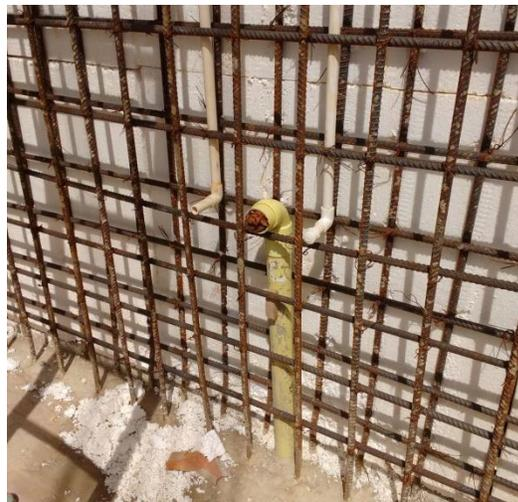
Figura 64. Colocación de tuberías de suministro de agua potable. Fuente: tomada por pasante.
