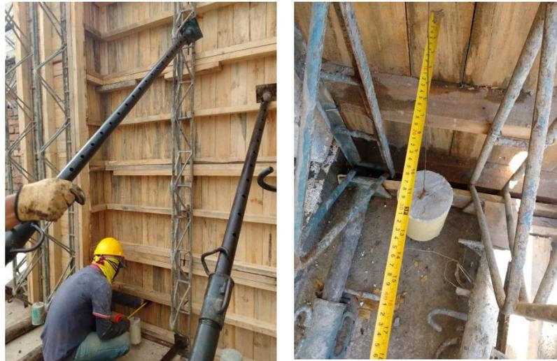
Figura 69. Rectificación de plomo para formaletas. Fuente: tomada por pasante.
