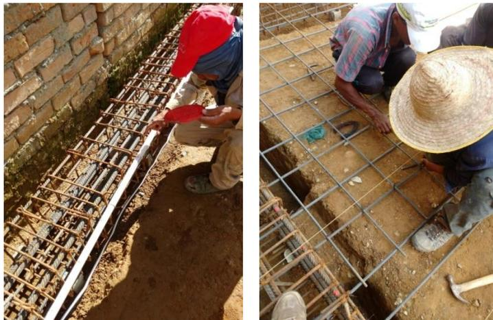
Figura 44. Colocación y amarre de aceros para losa de cimentación. Fuente: tomada por pasante.
