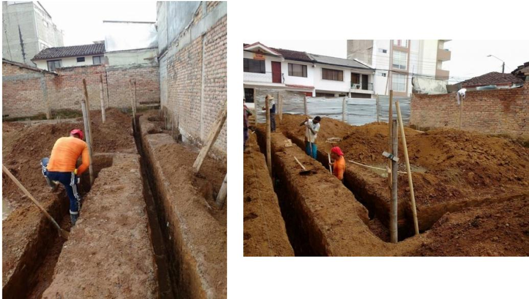
Figura 18. Excavación tanto de zanjas como de cajas de desagüe de alcantarillado pluvial y sanitario. Fuente: tomada por el pasante
