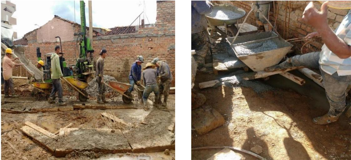
Figura 10. Vaciado de concreto. Fuente: tomada por el pasante
