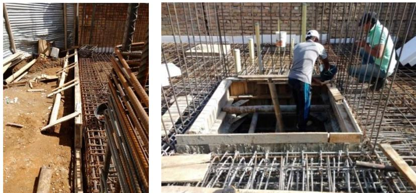
Figura 54. Formaleta para: Viga eje A y pantallas ascensor. Fuente: tomada por pasante.
