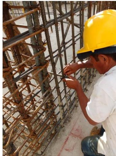
Figura 63. Colocación de pines para formaletas de pantallas. Fuente: tomada por pasante.
