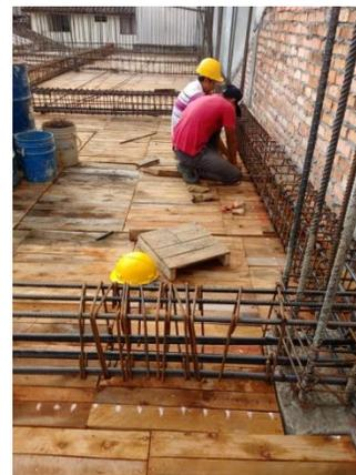
Figura 81. Cimbrado y amarre de aceros longitudinales y transversales para vigas de entrepiso. Fuente: tomada por pasante.
