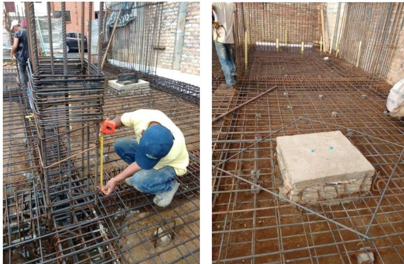
Figura 53. Colocación y amarre de estribos de columnas, refuerzo para cajas de recolección del alcantarillado. Fuente: tomada por pasante.
