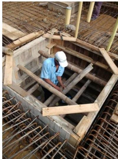
Figura 40. Colocación de formaleta para foso de ascensor. Fuente: tomada por pasante.
