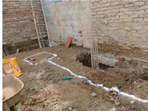
Figura 16. Localización de cajas de desagüe y tubería de alcantarillado sanitario y pluvial. Cajas de desagüe de dimensiones 0.80\*0.80\*0.70m. Fuente: tomada por el pasante
