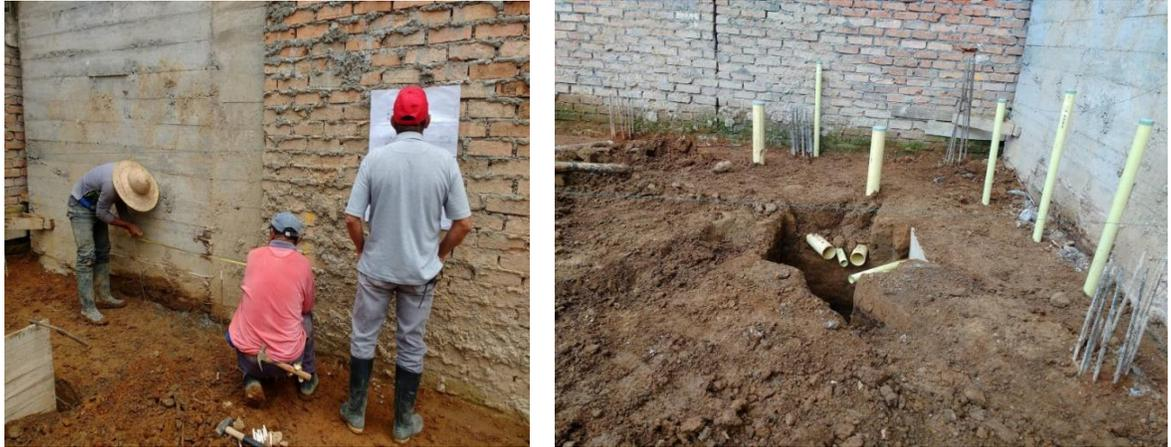
Figura 22. Colocación de ramales para puntos de desagüe. Fuente: tomada por el pasante
