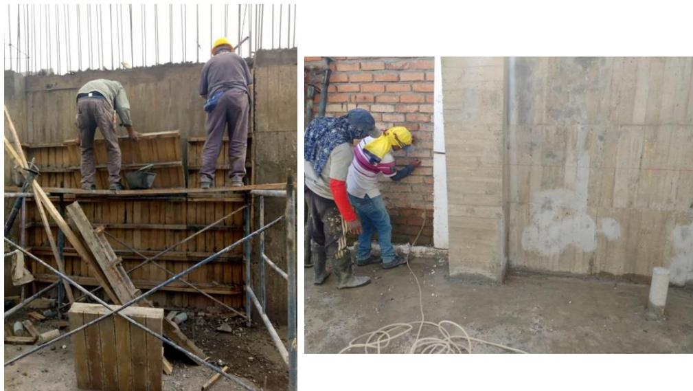
Figura 72. Nuevo refuerzo para pantallas de ascensor. Fuente: tomada por pasante.
