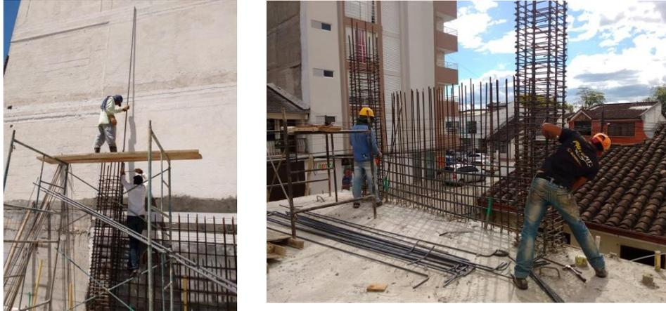
Figura 93. Amarre de aceros para columnas y pantallas. Fuente: tomada por pasante.
