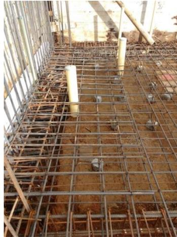
Figura 51. Refuerzo de losa de cimentación.
