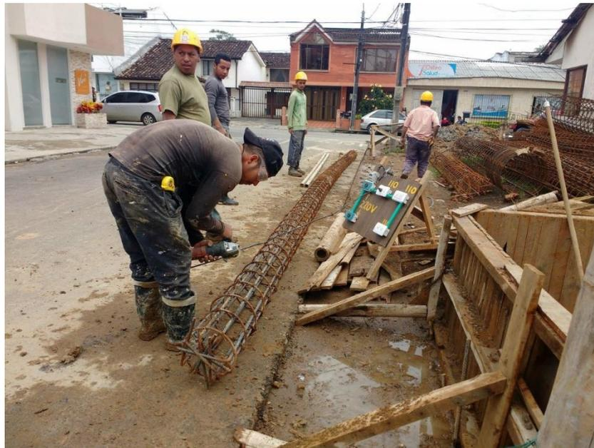
Figura 12. Corte castillo de acero de acuerdo a la profundidad requerida. Fuente: tomada por el pasante
