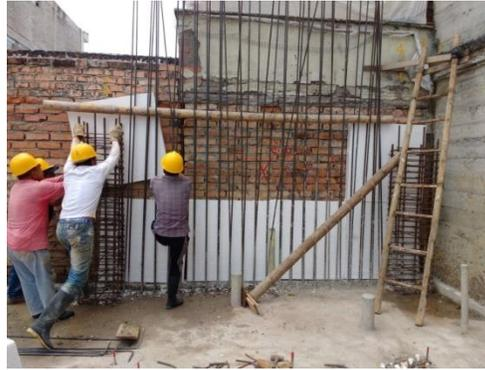
Figura 61. Colocación de icopor. Fuente: tomada por pasante.
