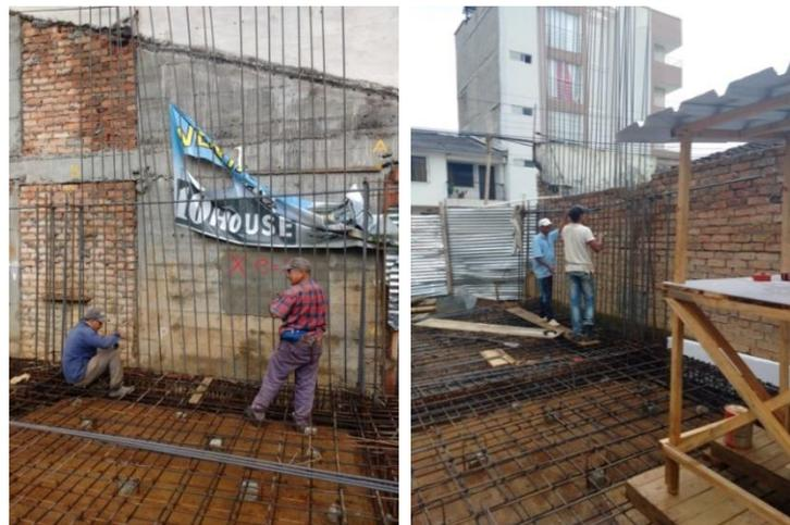
Figura 50. Colocación y amarre de aceros verticales para pantallas. Fuente: tomada por pasante
