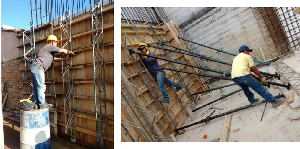
Figura 67. Colocación de cerchas y tacos metálicos. Fuente: tomada por pasante
