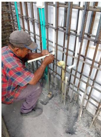
Figura 94. Ubicación de altura para puntos de desagüe en pantallas del segundo piso. Fuente: tomada por pasante.
