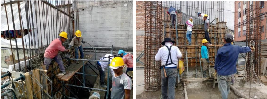
Figura 70. Fundición de columnas y pantallas. Fuente: tomada por pasante.
