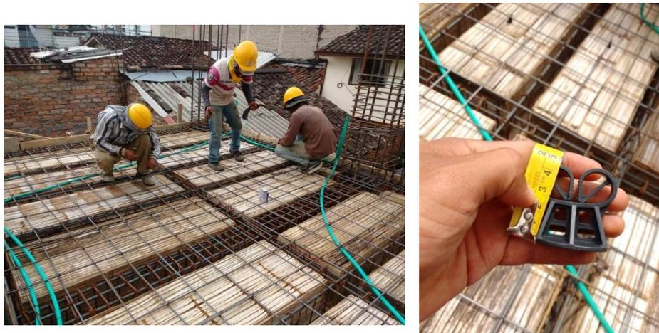
Figura 89. Colocación y amarre de aceros para losa de compresión. Fuente: tomada por pasante.
