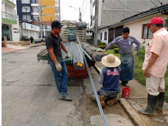
Figura 101. Recibimiento de acero en obra. Fuente: tomada por el pasante
