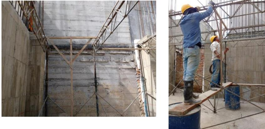
Figura 75. Chequeo y corrección de espaciamento-to entre cerchas metálicas. Fuente: tomada por pasante.
