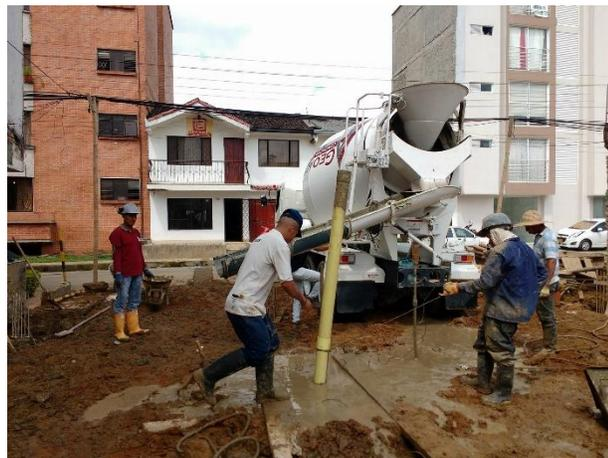
Figura 11. Expulsión de lodo y agua freática. Fuente: tomada por el pasante
