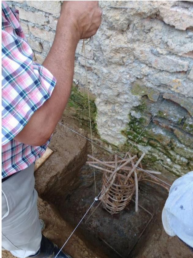
Figura 26. Chequeo de ubicación de pilotes. Fuente: tomada por el pasante
