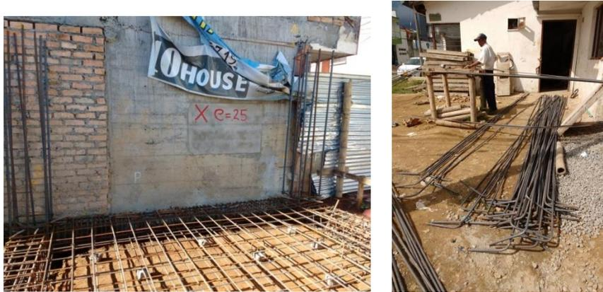
Figura 49. Ubicación y figuración de ganchos para aceros de pantallas. Fuente: tomada por pasante.
