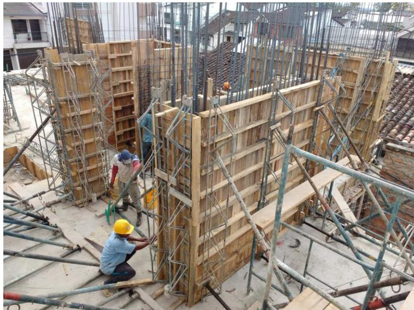
Figura 97. Avance de colocación de formaletas hasta la fecha de finalización de pasantía. Fuente: tomada por pasante
