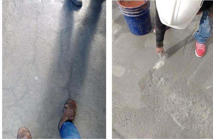
Figura 91. Curado para losa de entrepiso piso 2. Fuente: tomada por pasante.
