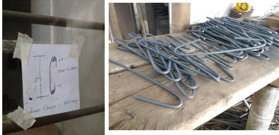
Figura 82. Acero transversal para nervios de losa aligerada. Fuente: tomada por pasante.
