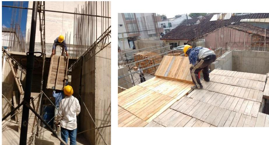
Figura 76. Colocación de tableros de madera de 0.70\*1.40m. Fuente: tomada por pasante.
