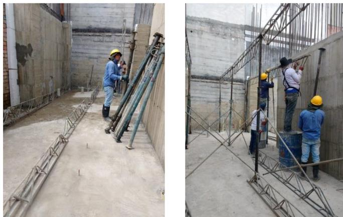
Figura 74. Colocación de cerchas y tacos metálicos. Fuente: tomada por pasante.
