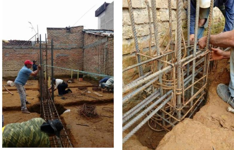
Figura 32. Ubicación y amarre de estribo guía para aceros longitudinales. Fuente: tomada por el pasante
