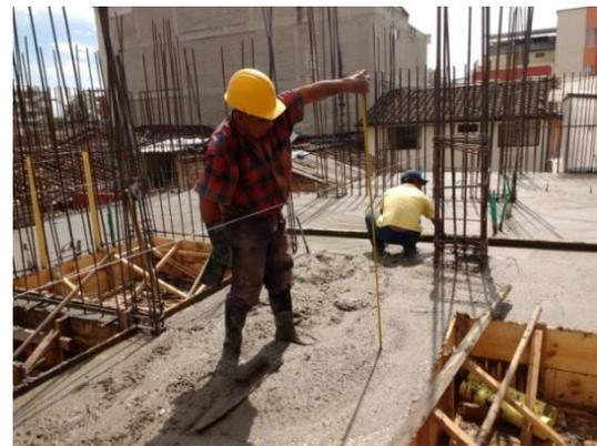
Figura 90. Fundición losa de entrepiso piso 2. Fuente: tomada por pasante.
