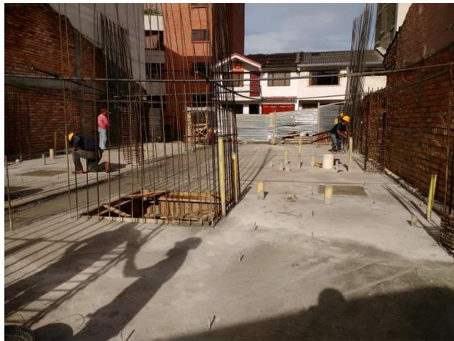
Figura 57. Colocación de pines y estado de losa de cimentación al día siguiente de fundición.
