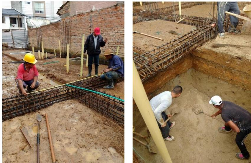
Figura 36. Localización e inicio de excavación para foso de ascensor. Fuente: tomada por el pasante.
