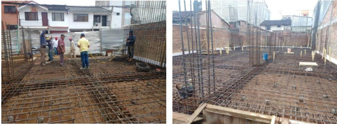
Figura 55. Ubicación de franja para diferentes redes e imagen de finalización de amarre de aceros para continuar con fundición de losa y vigas de cimentación. Fuente: tomada por pasante.
