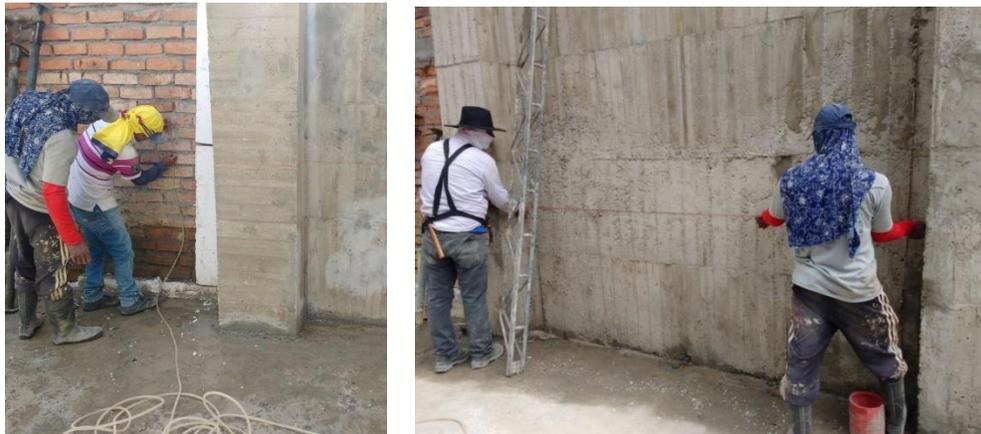
Figura 73. Cimbrado del nivel N+1.35. Fuente: tomada por pasante.
