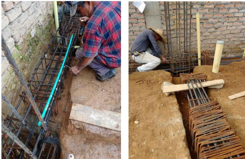
Figura 34. Colocación y amarre de estribos. Fuente: tomada por el pasante
