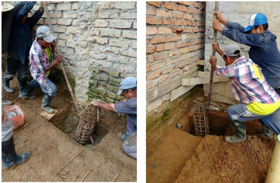
Figura 27. Corrección de ubicación de pilotes. Fuente: tomada por el pasante
