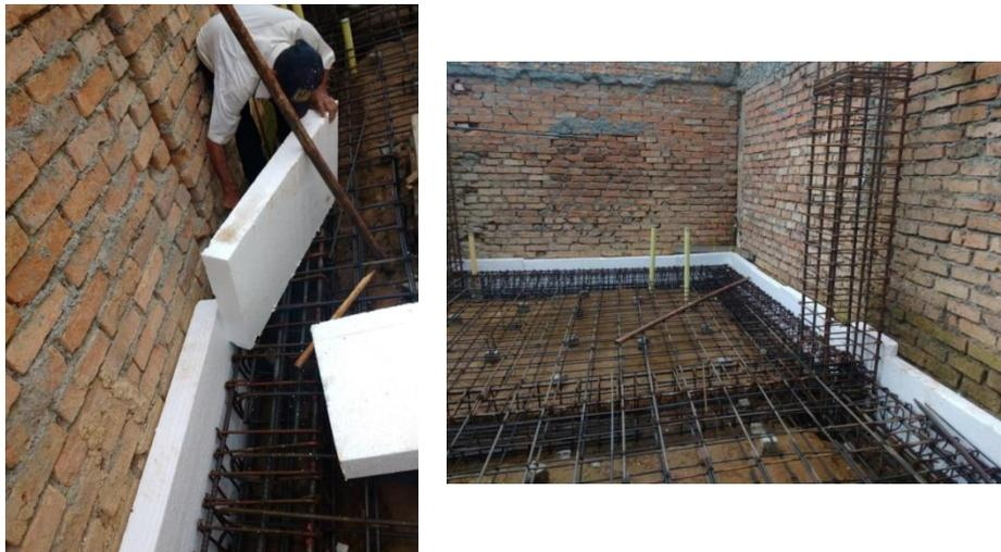
Figura 52. Colocación de icopor en el contorno del edificio. Fuente: tomada por pasante.
