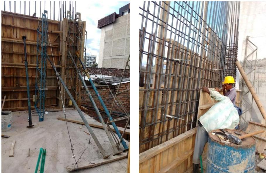
Figura 95. Colocación de formaleta de pantallas y columnas para el segundo piso. Fuente: tomada por pasante.
