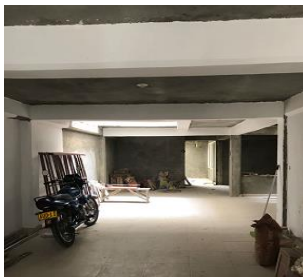
Edificación de 4 pisos con sistema estructural de pórticos de concreto
