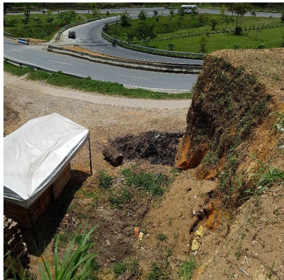
Movimiento de tierra visto desde la parte alta.
