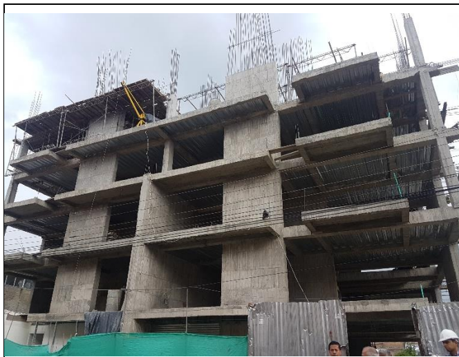
Construcción de 4 pisos, proyección de 5.
