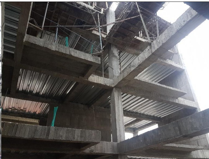
Estructura de vigas, pantallas y columnas en concreto reforzado y losa en stall deck.
