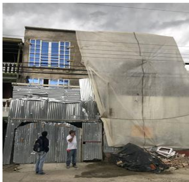
Construcción de vivienda multifamiliar de 4 pisos
