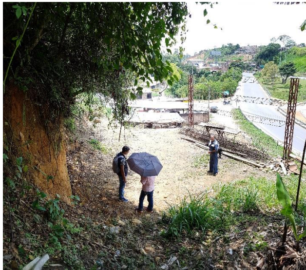
Corte de talud y explanación visto desde otro nivel.
