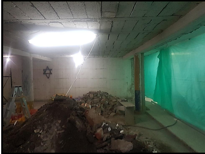
Imagen 56. Demolición de muros divisorios de carga, fuente propia.
