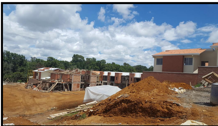
Imagen 71. Obras de urbanismo y construcción, fuente propia.
