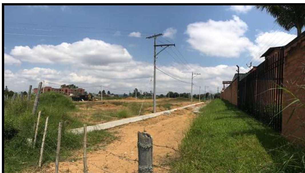
Imagen 16. Apertura de vías de acceso, fuente propia.
