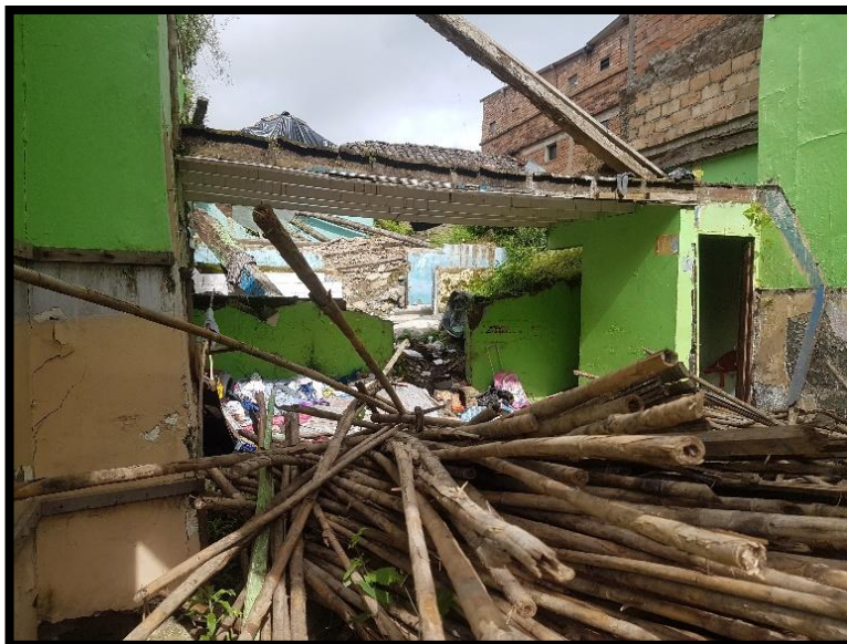
Imagen 79. Demolicion de cubiertas y muros internos, fuente propia.
