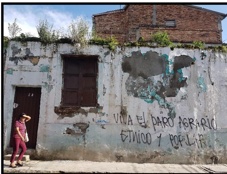
Imagen 77. Muros perimetrales y fachada de la vivienda, fuente propia.
