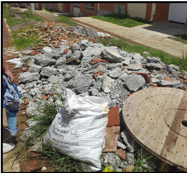
Imagen 44. Escombros acopiados en espacio público, fuente propia.
