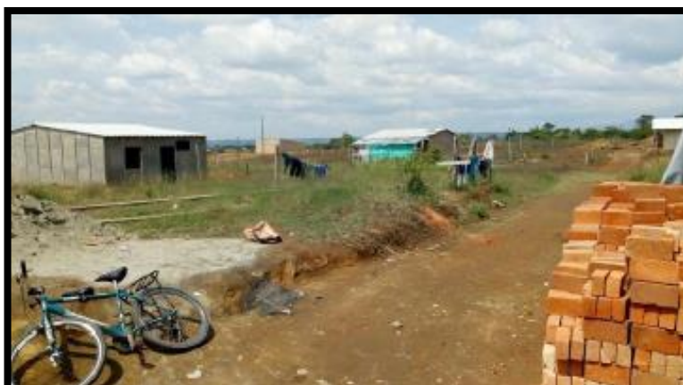
Imagen 12. Construcción de urbanismo, fuente propia.
