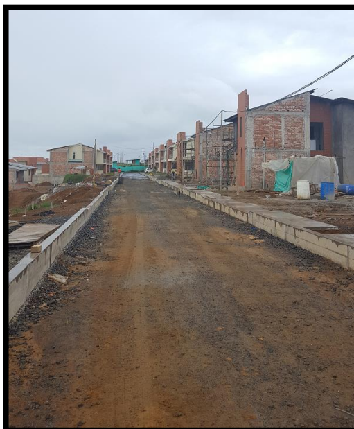
Imagen 75. Vías de circulación vehicular en etapa de pavimentación, fuente propia.
