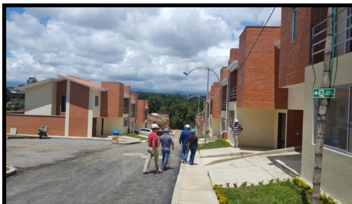
Imagen 69. Viviendas tipo 2, parte se encuentran en etapa de acabados y otras en etapa de reparaciones generales, fuente propia.
