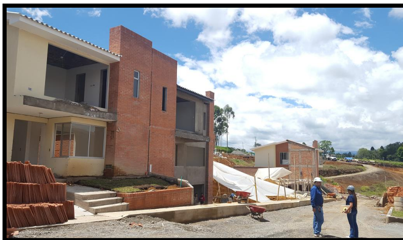
Imagen 70. Viviendas tipo 4, se encuentran en etapa de cimentación, fuente propia.
