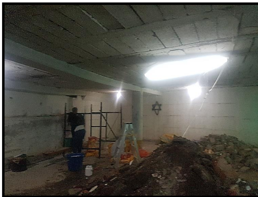
Imagen 55. Deflexión de vigas, fuente propia.
