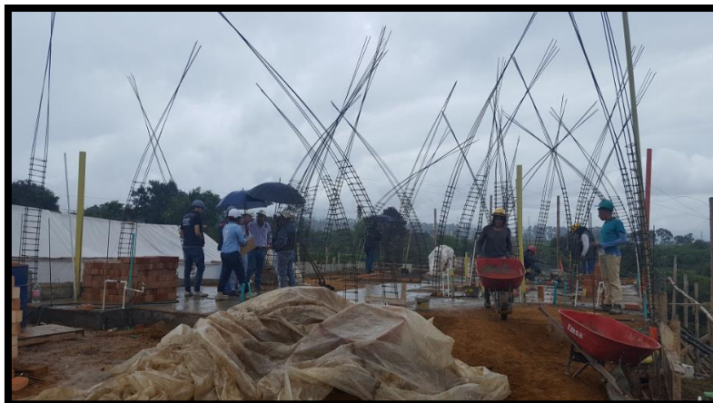
Imagen 73. Armado del refuerzo de las columnas de confinamiento y levantamiento de muros de ladrillo, casa tipo 1, fuente propia.
