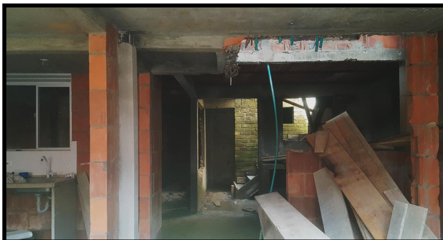
Imagen 46. Demolición de muros de carga, modificación y ampliación de la vivienda, fuente propia.
