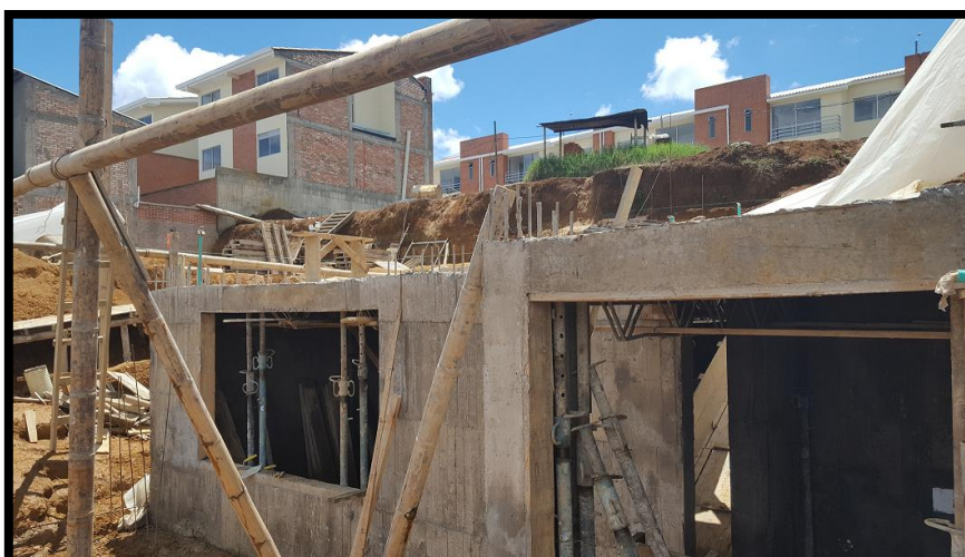
Imagen 72. Construcción cajón de cimentación en concreto, casta tipo 4, fuente propia.
