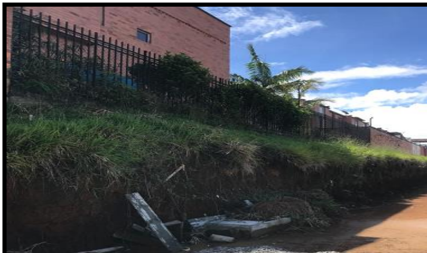
Imagen 17. Corte vertical del talud, a escasos 2,20m del cerramiento del conjunto residencial, fuente propia.
