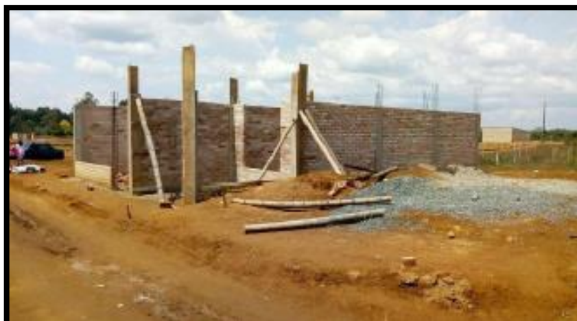
Imagen 14. Obras de construcción, fuente propia.
