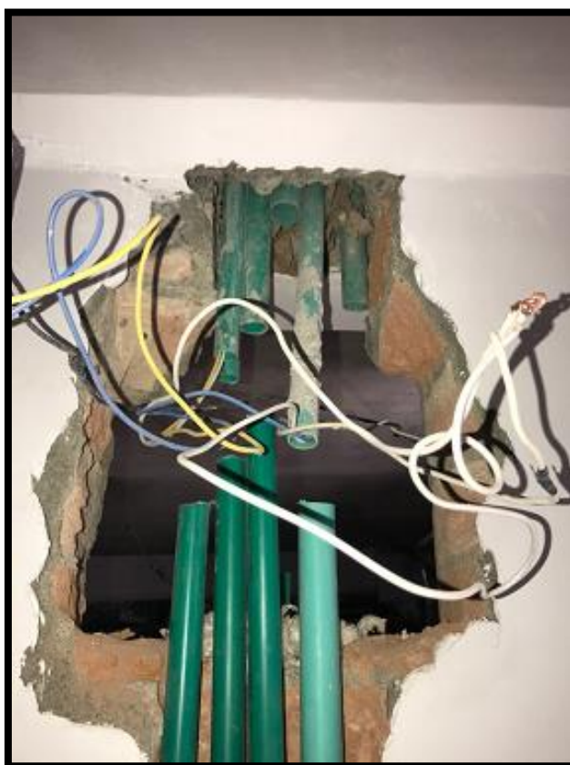
Imagen 32. Perforación de vigas para colocación de instalaciones eléctricas, fuente propia.
