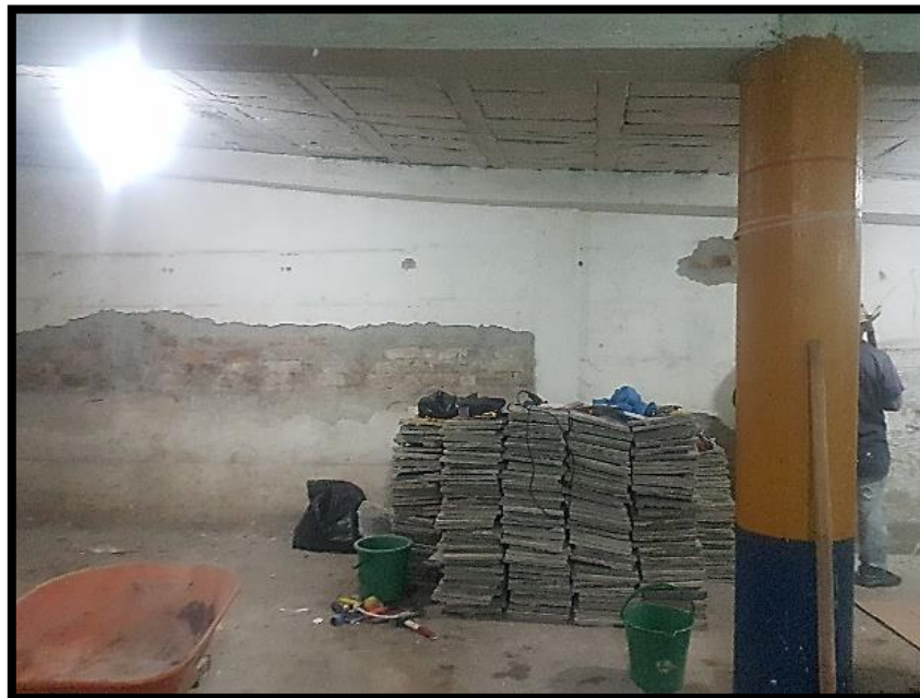
Imagen 57. Reparaciones locativas, fuente propia.
