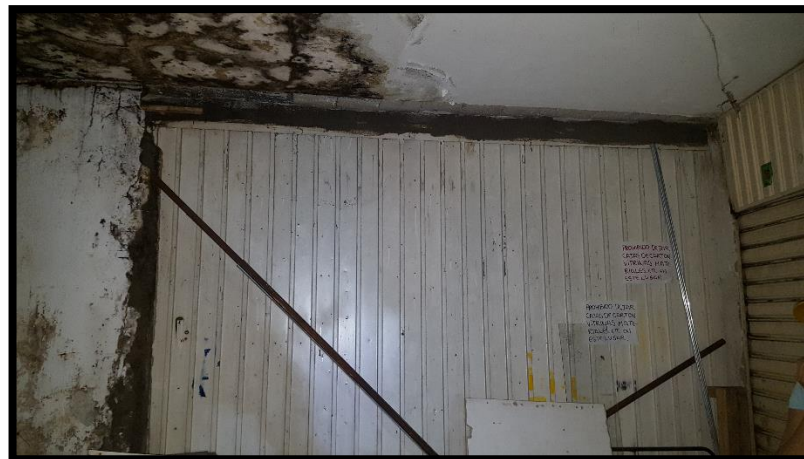
Imagen 63. Demolición de muros de carga, fuente propia.
