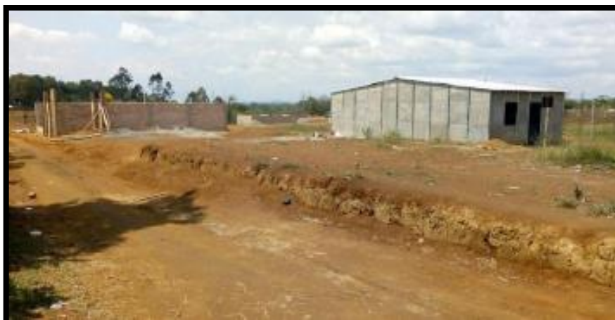
Imagen 13. Obras de urbanismo, fuente propia.
