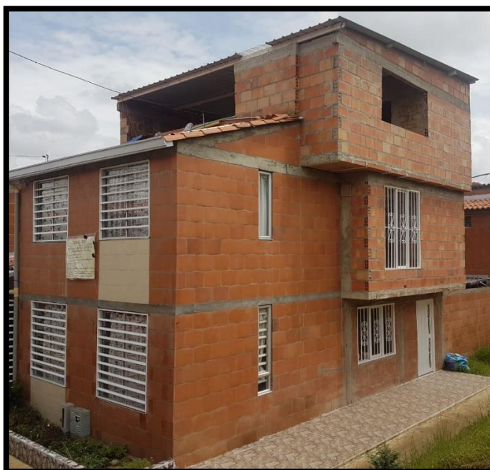
Imagen 45. Construcción de segundo piso con proyección al tercero, fuente propia.
