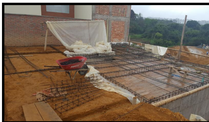
Imagen 74. Armado del refuerzo de vigas de cimentación, casa tipo 4, fuente propia.
