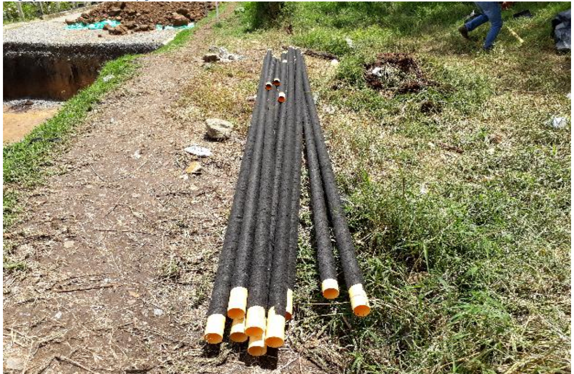
Fotografía 41. Drenes de pvc y geotextil
