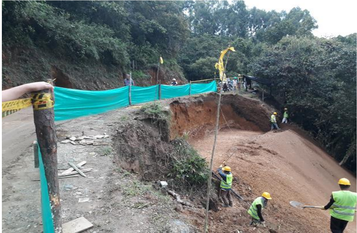
Fotografía 49. Excavación y localización de caisson K2+300 - K2+500
