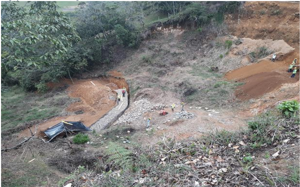
Fotografía 48. Construcción de gaviones
