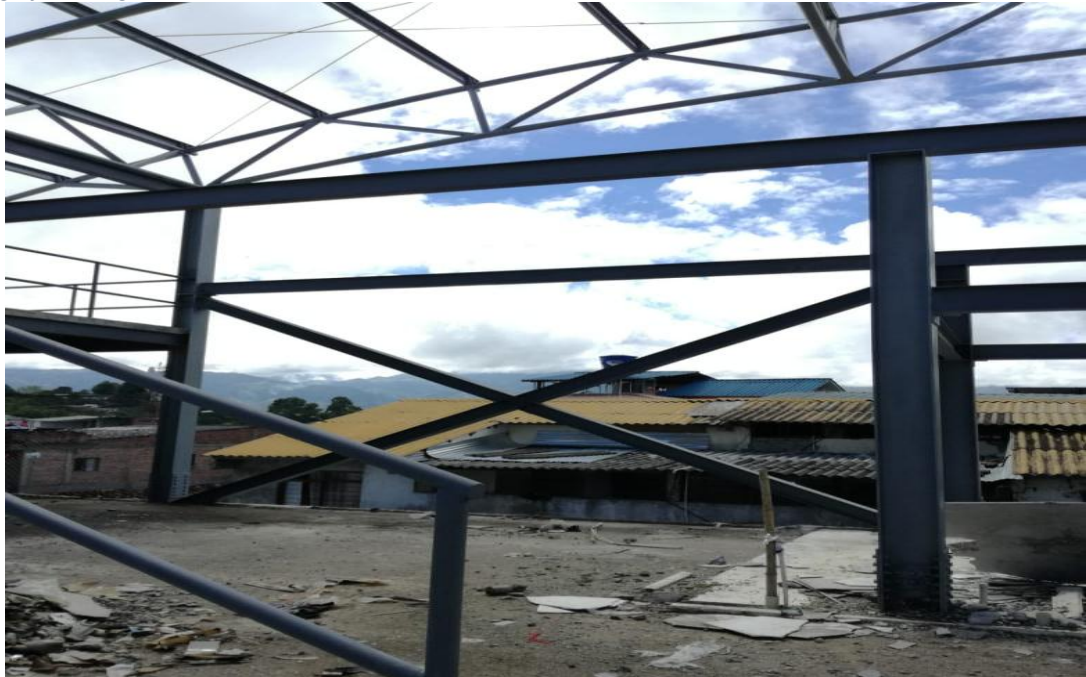
Fotografía 29. Rigidizador en estructura metálica
