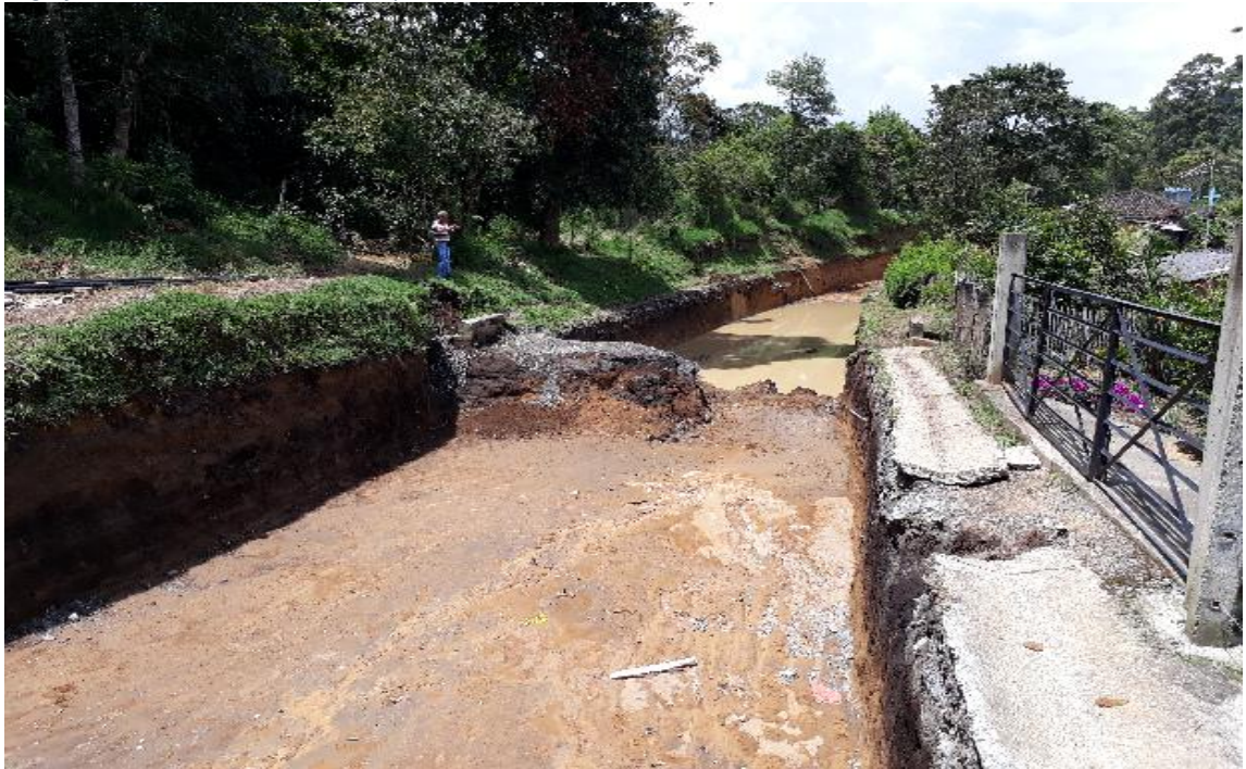
Fotografía 39. Excavación en el primer punto critico
