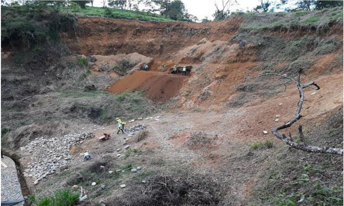
Fotografía 47. Excavación para construcción de pantallas de concreto
