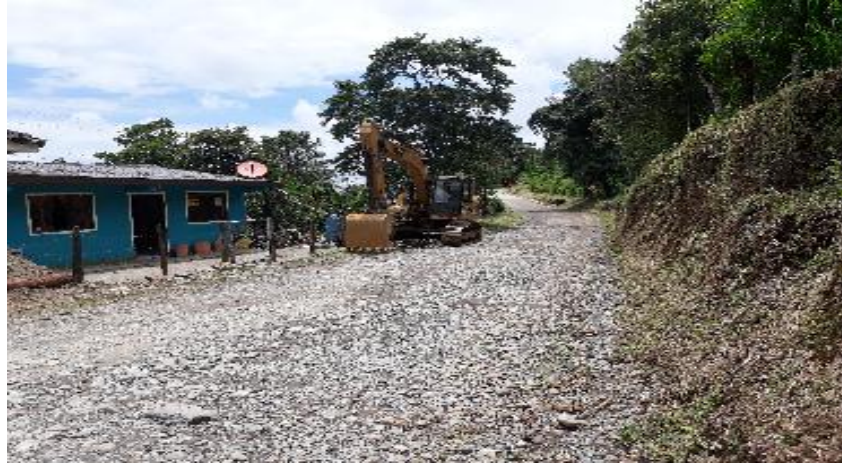
Fotografía 31. Retroexcavadora en obra
