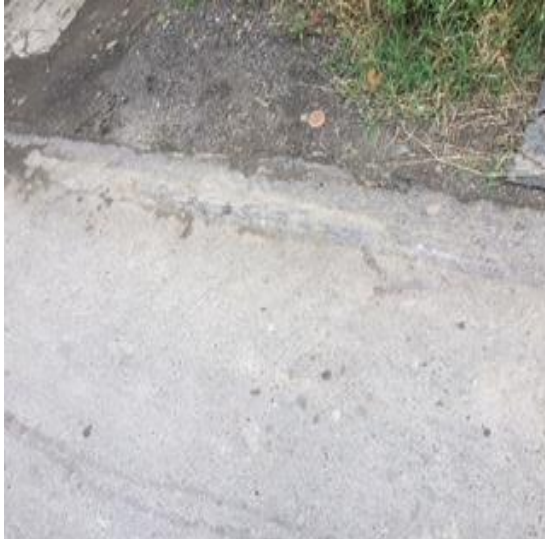
Fotografía 119. Montículo de asfalto después del fresado
