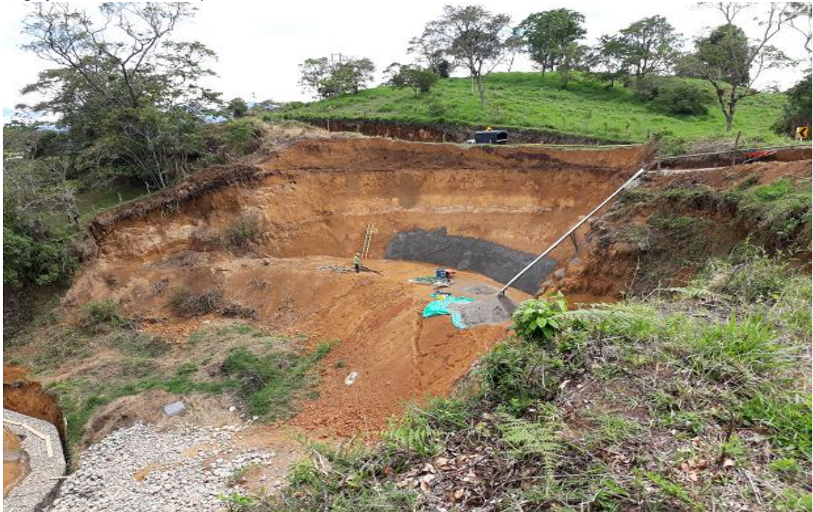
Fotografía 56. Localización de pantallas de concreto
