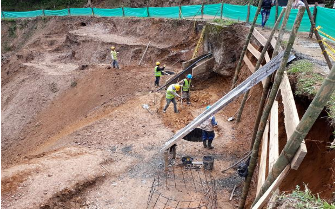
Fotografía 59. Excavación de caisson
