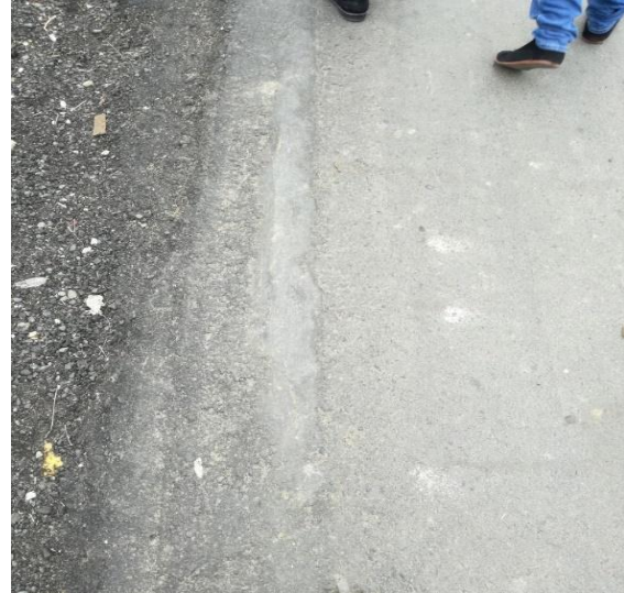
Fotografía 20. Montículo de asfalto después del fresado
