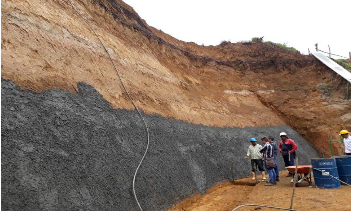
Fotografía 55. Concreto lanzado para recubrir talud
