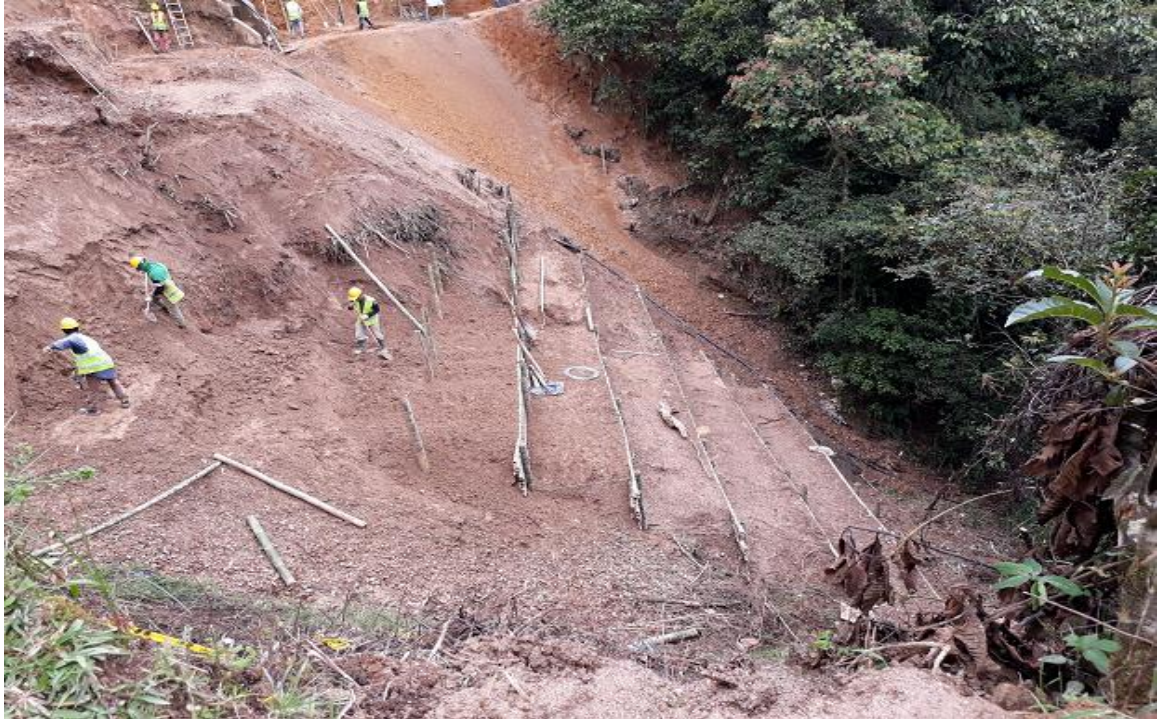
Fotografía 57. Construcción de trinchos
