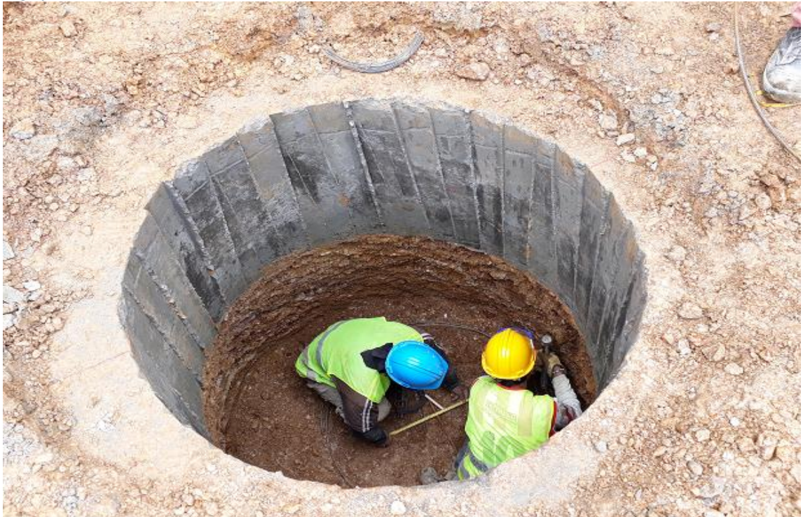
Fotografía 60. Fundición de anillos del caisson
