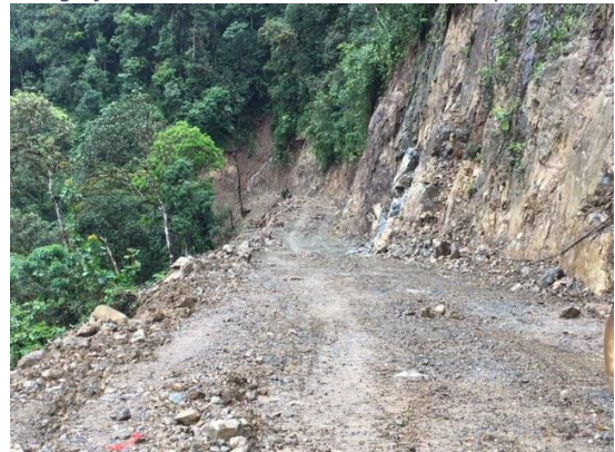
Fotografía 64. Material rocoso volado con explosivos
