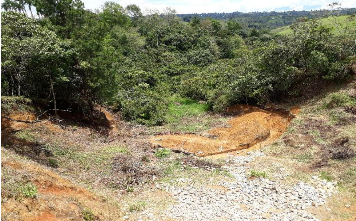
Fotografía 42. Excavación para la construcción de gaviones
