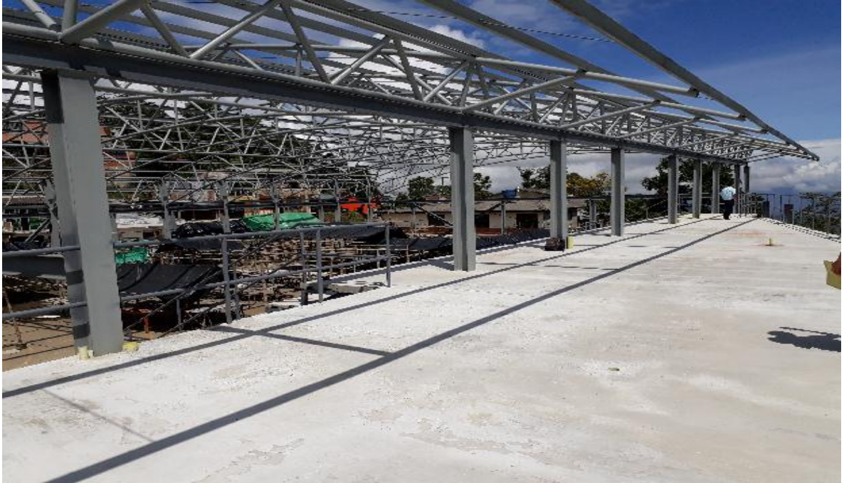
Fotografía 25. Losa metaldeck mezzanines
