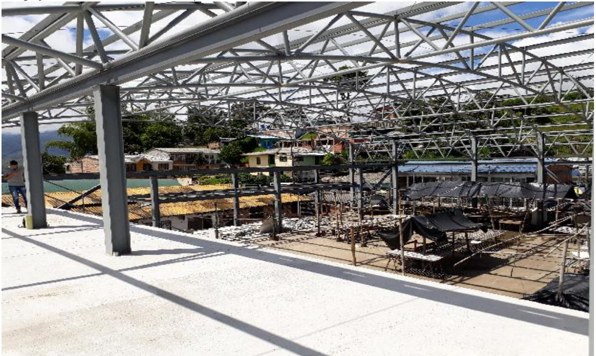
Fotografía 26. Vista de estructura de soporte de cubierta
