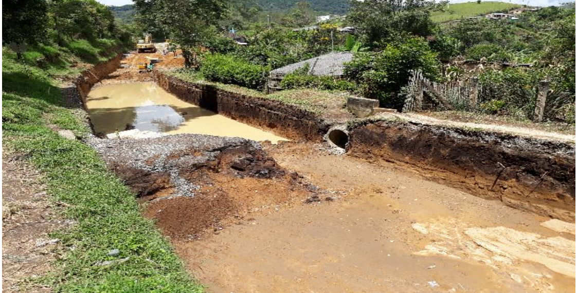
Fotografía 38. Vista general de la excavación del tramo a intervenir
