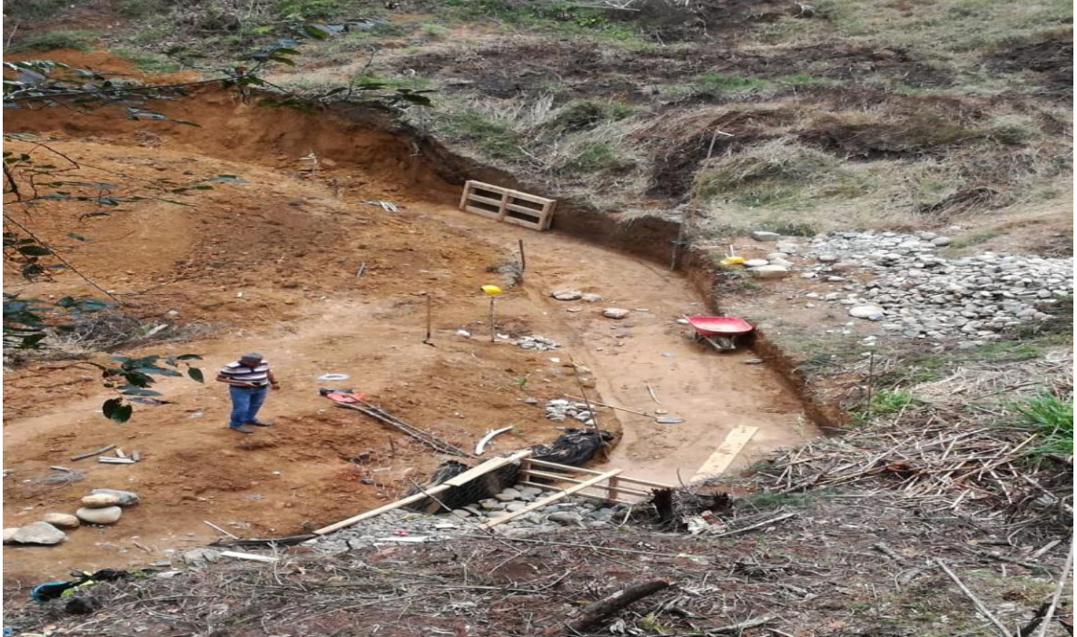
Fotografía 44. Inicio de construcción de gaviones
