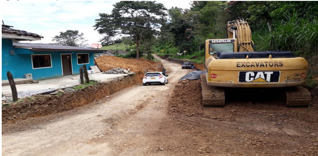
Fotografía 53. Compactación de relleno
