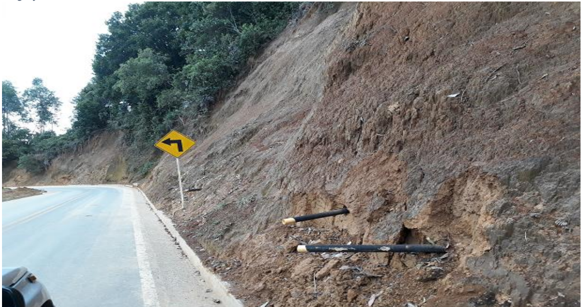
Fotografía 52. Drenes instalados
