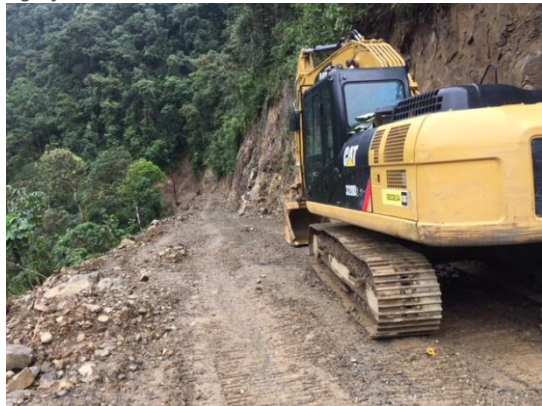
Fotografía 63. Retroexcavadora en obra
