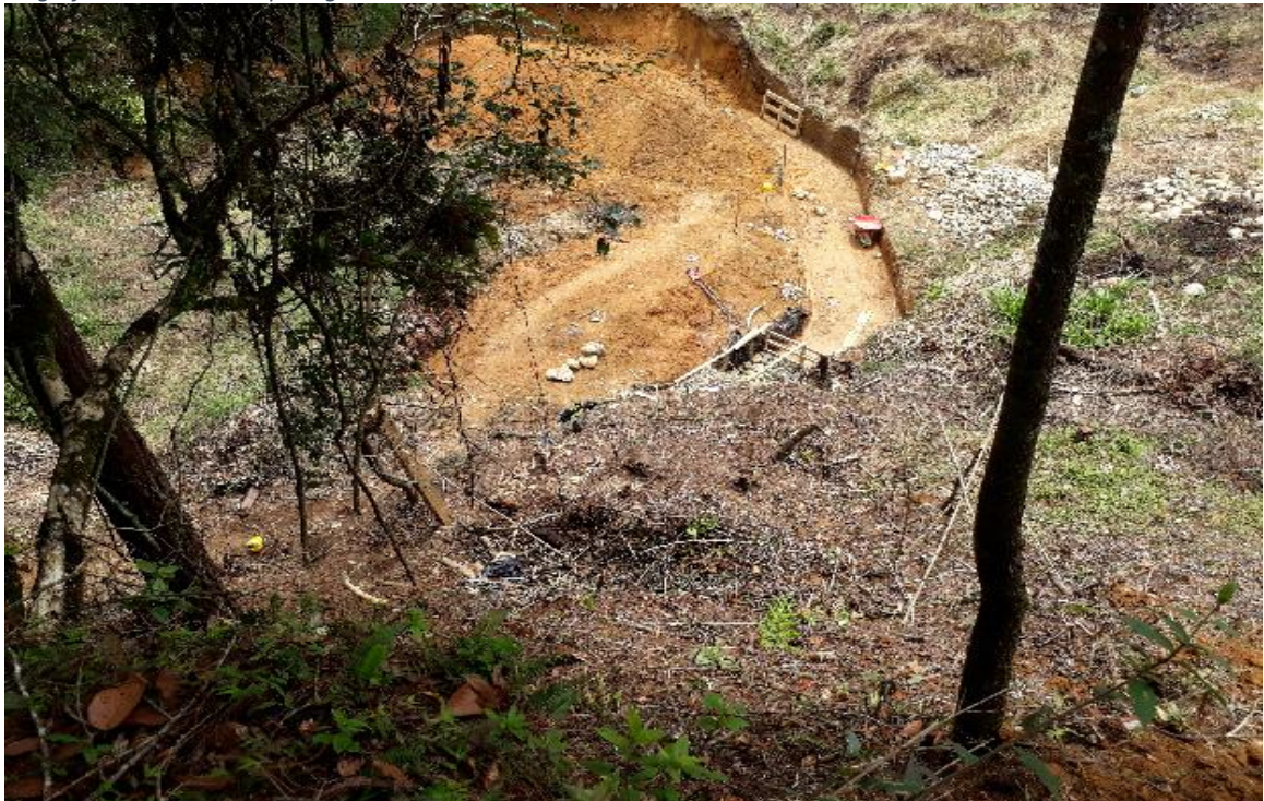
Fotografía 43. Excavación para gaviones
