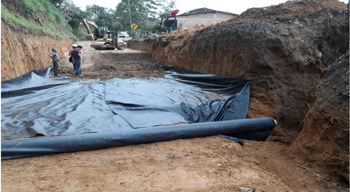
Fotografía 45. Instalación de geotextil y relleno de mejoramiento
