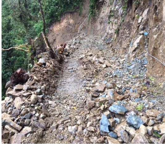
Fotografía 65. Material rocoso volado con explosivos
