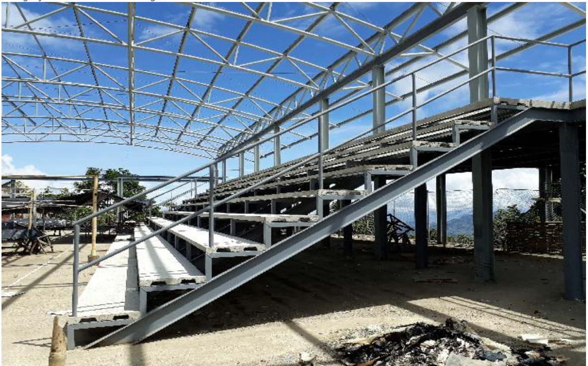
Fotografía 24. Losa metaldeck graderías
