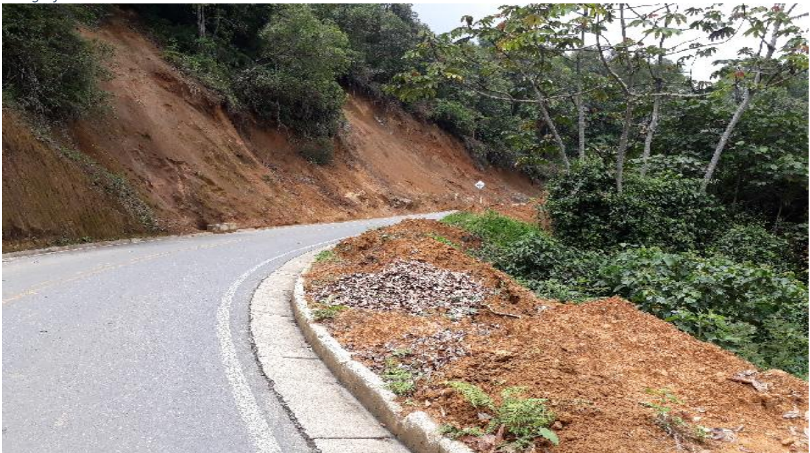
Fotografía 36. Sitio critico k3+300
