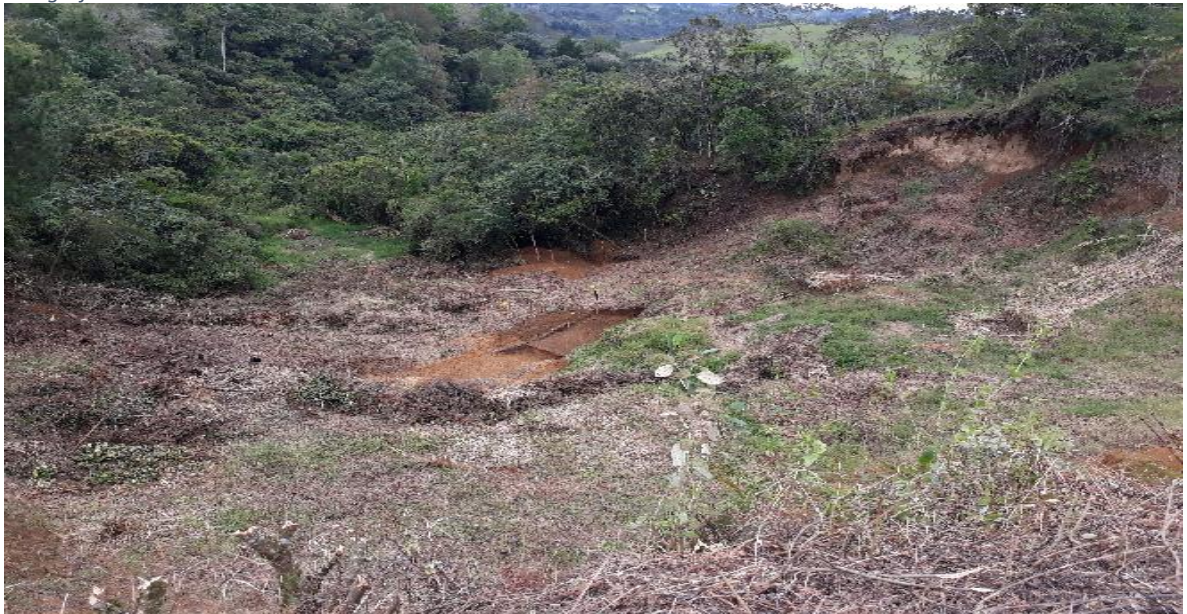
Fotografía 32. Sitio critico k1+750
