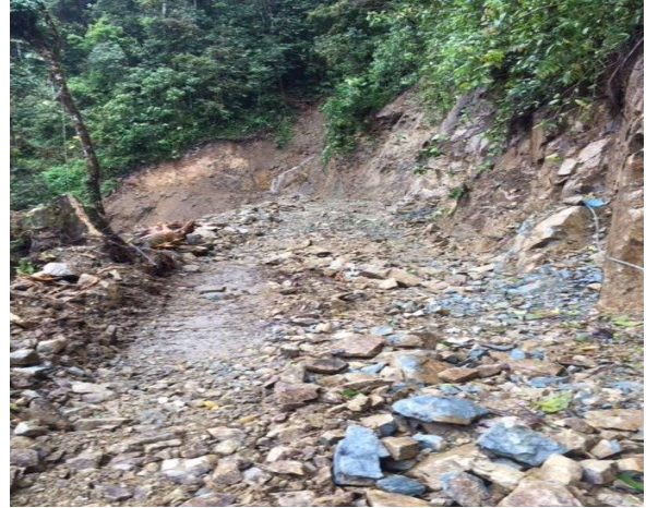
Fotografía 66. Material rocoso volado con explosivos
