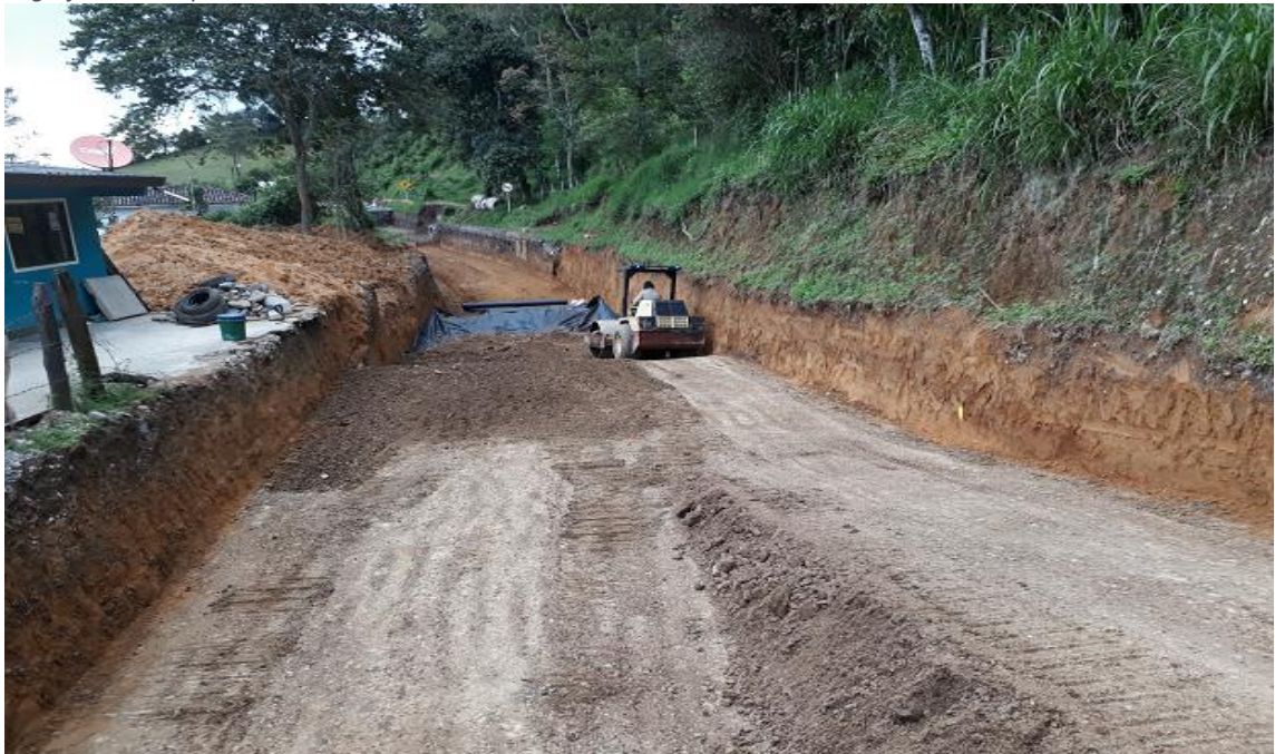
Fotografía 46. Compactación del relleno
