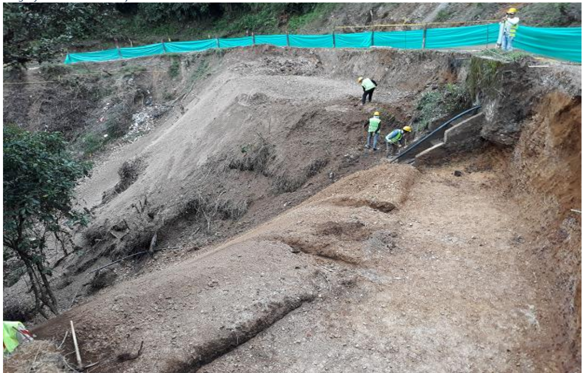
Fotografía 50. Excavación y localización de caisson
