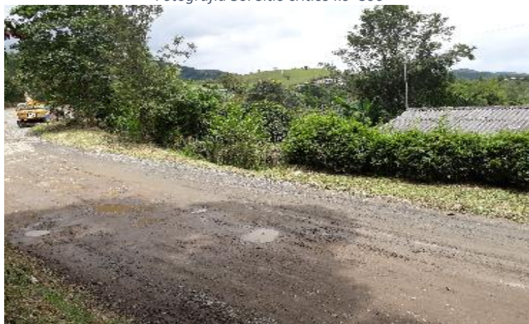
Fotografía 30. Sitio critico k0+800
