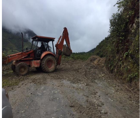
Fotografía 62. Pajarita en obra
