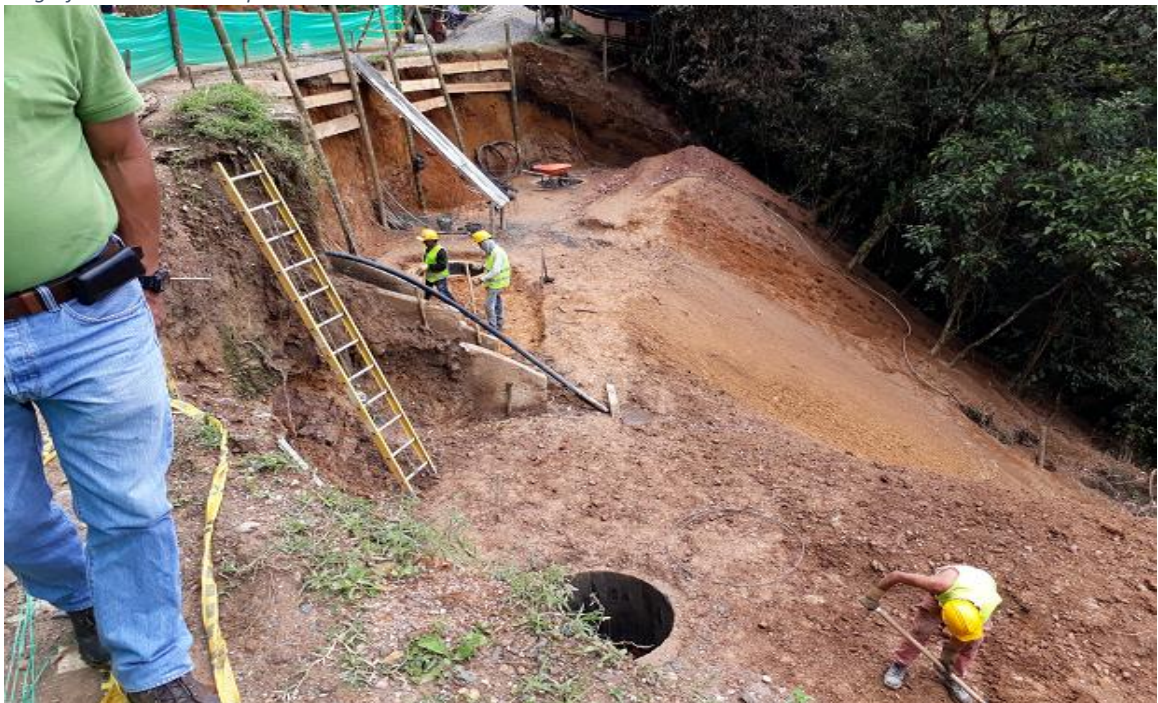
Fotografía 58. Excavación para caisson
