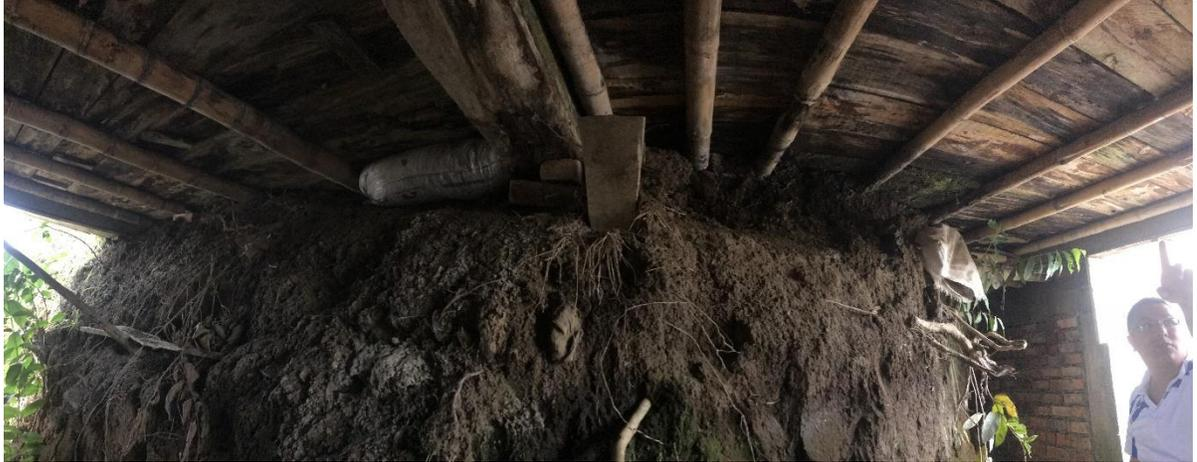
Finalmente se puede concluir que la construcción no cumple con la Norma Sismo Resistente NSR-10, ni cuenta con estudio de suelos, además está afectando gravemente a las viviendas colindantes con el vertimiento de aguas lluvias y el debilitamiento del talud que se encuentra en la parte posterior de las viviendas, lo cual es responsabilidad del propietario de la obra.
