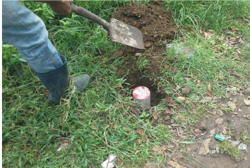
Figura 8.1 Instalación de mojones
