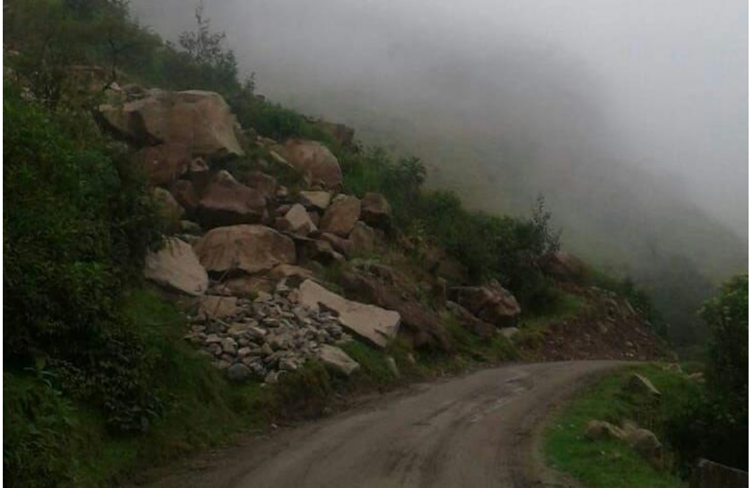
Figura 6.25 Zona afectada por deslizamientos
