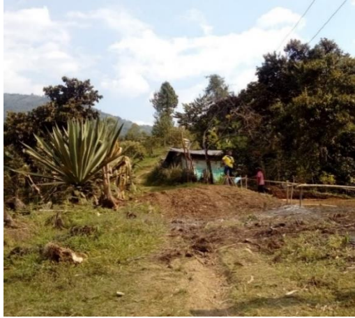
Fotografía 34. Vía Vereda Belén
