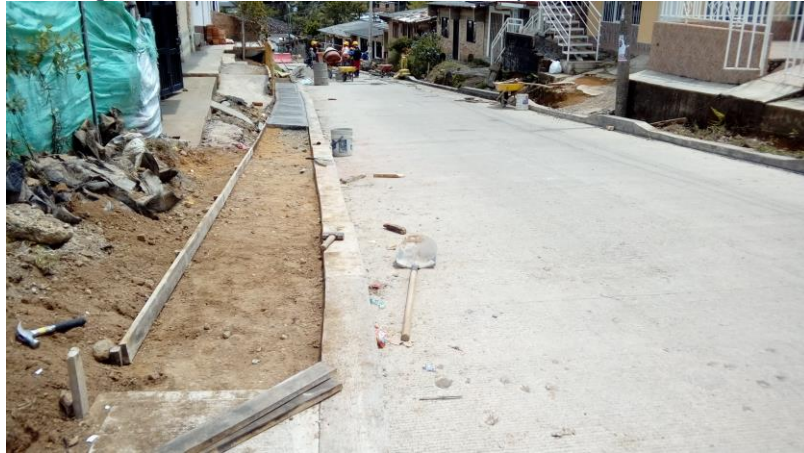
Fotografía 45. Vía Pavimentada con andén parcialmente construido
