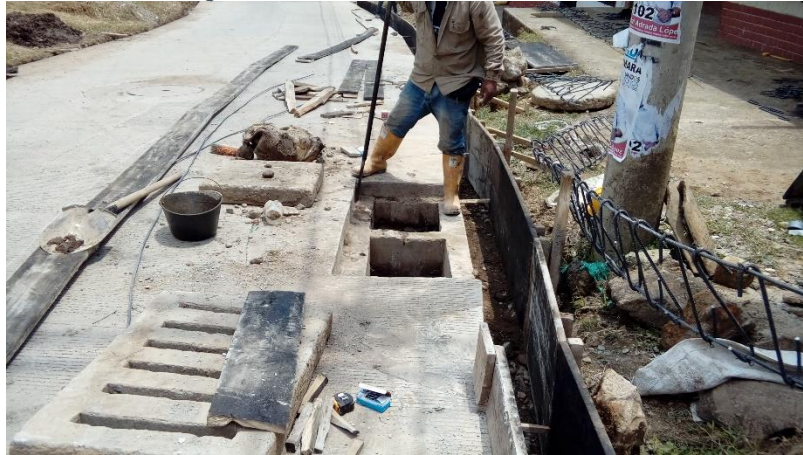
Fotografía 49. Retiro de formaleta de sumidero
