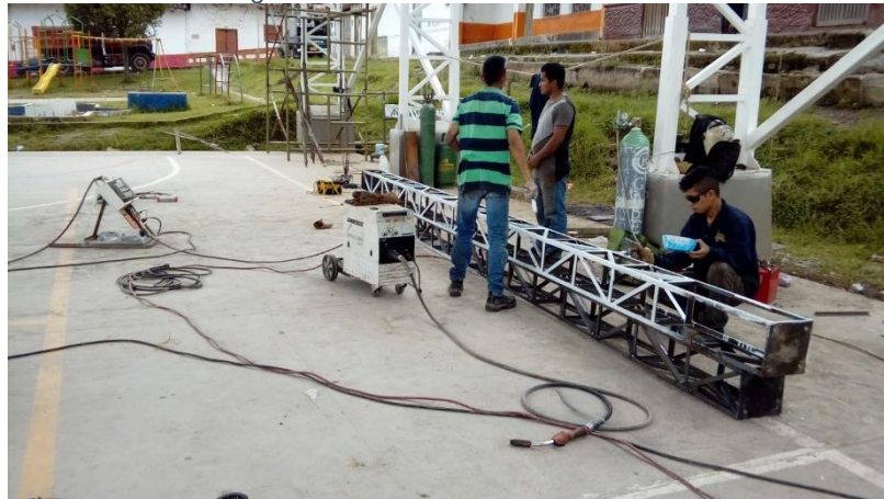
Fotografía 90. Estructura de reforzamiento
