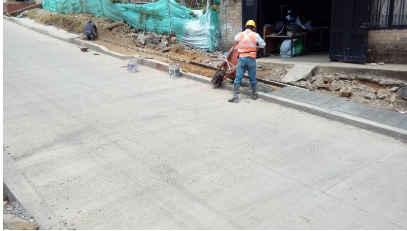
Fotografía 48. Vaciado de concreto sobre cuneta
