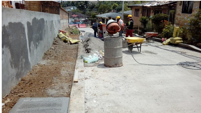
Fotografía 46. Vía pavimentada y Mezcla de concreto con mezclador
