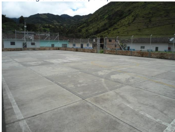
Fotografía 70. Placa polideportiva existente
