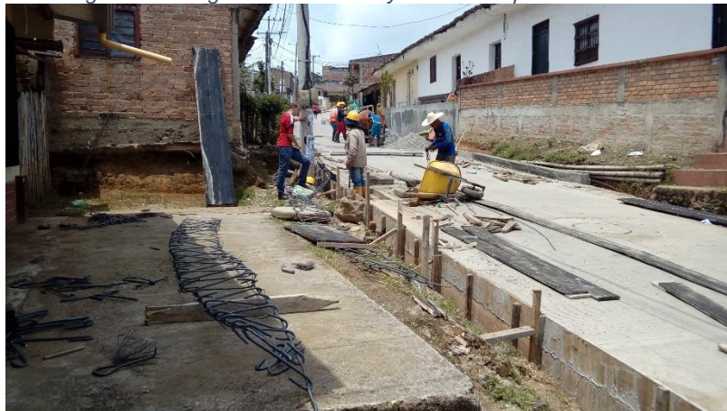
Fotografía 50. Figuración de acero y colocación para bordillo de vía
