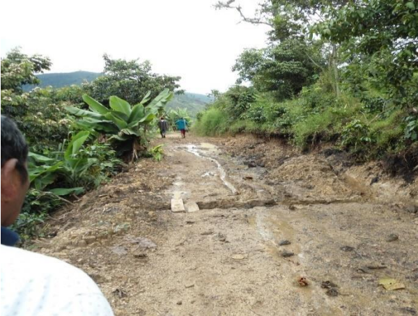
Fotografía 56. Vía Vereda La Mina
