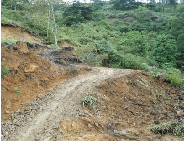
Fotografía 60. Derrumbe sobre la vía
