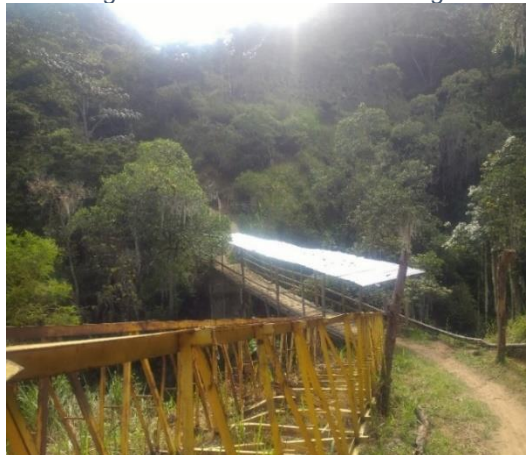
Fotografía 7. Puente Vereda La Laguna
