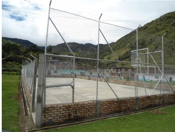
Fotografía 72. Muro con malla de la placa existente
