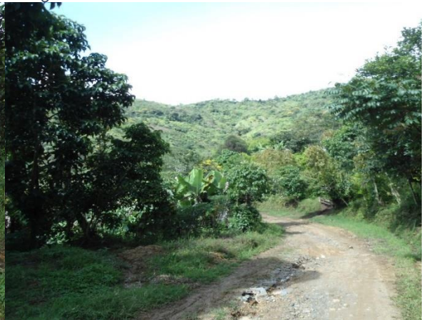
Fotografía 69. Vía Vereda Santa Rita
