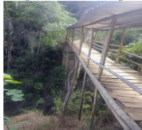
Fotografía 8. Puente Vereda La Laguna
