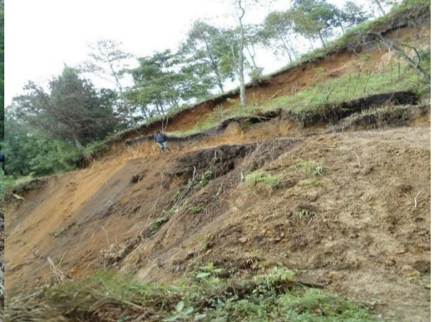
Fotografía 61. Derrumbe sobre la vía
