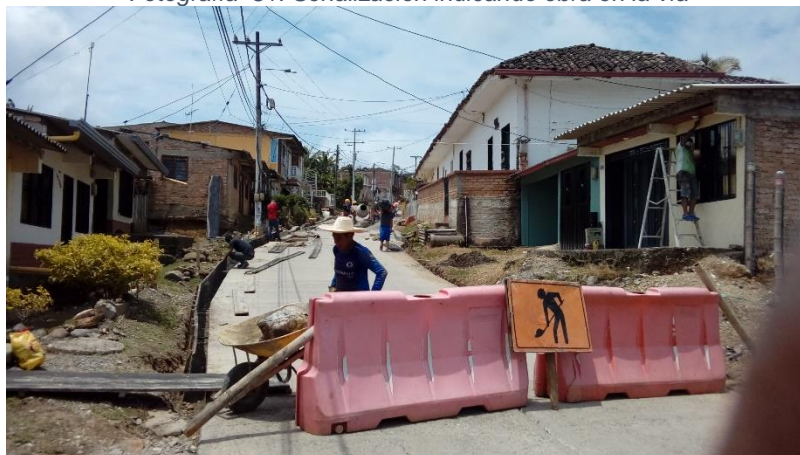
Fotografía 51. Señalización indicando obra en la vía
