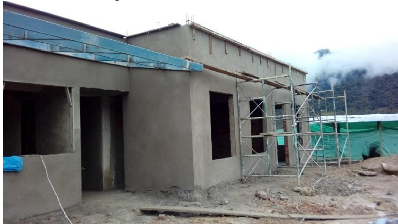
Fotografía 84. Frente del centro de salud
