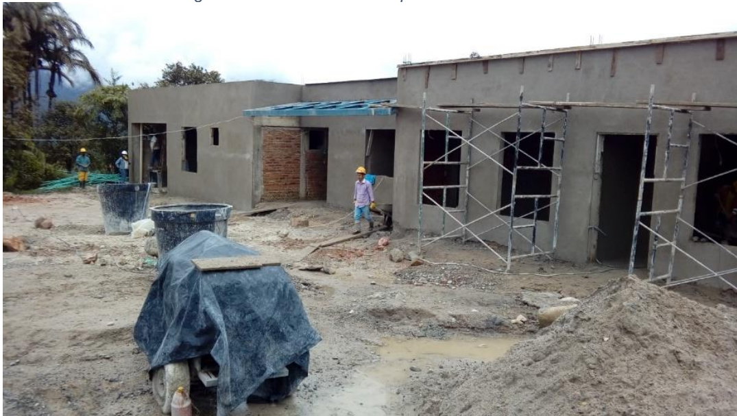
Fotografía 88. Vista Frontal completa del centro de salud
