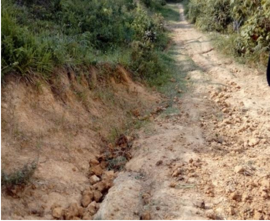
Fotografía 33. Vía Vereda Belén
