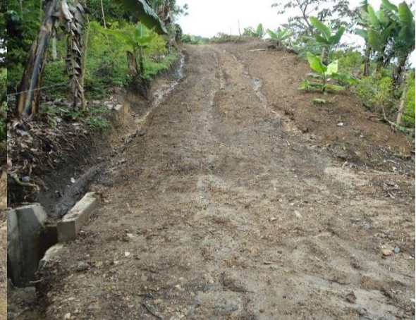
Fotografía 57. Vía Vereda La Mina
