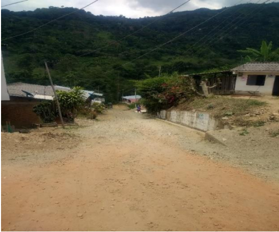
Fotografía 15. Vía Vereda Tacueyo
