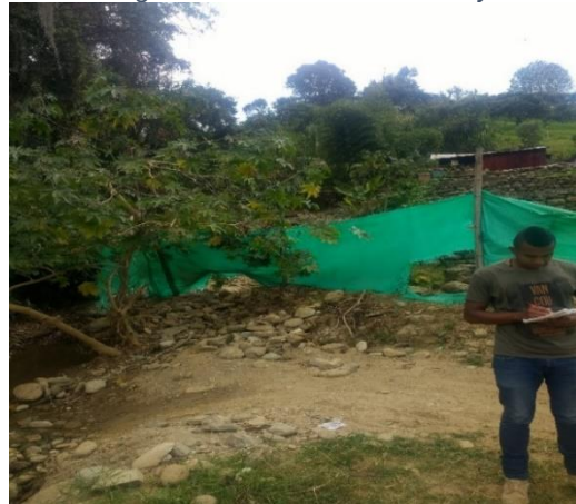
Fotografía 18. Vía Vereda Tacueyo
