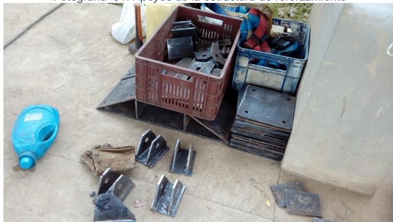
Fotografía 91. Apoyos de la estructura de reforzamiento
