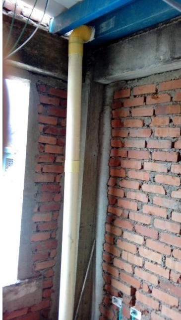
Fotografía 89. Bajante de aguas lluvias
