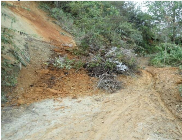
Fotografía 62. Derrumbe sobre la vía
