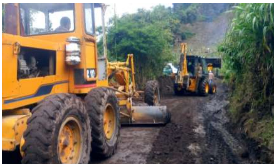
Figura 8. Excavación en obra
